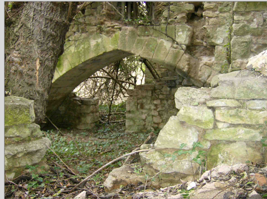
Fig. 1 Vista interior de la sala de molienda. Arco apuntado perpendicular al cup
