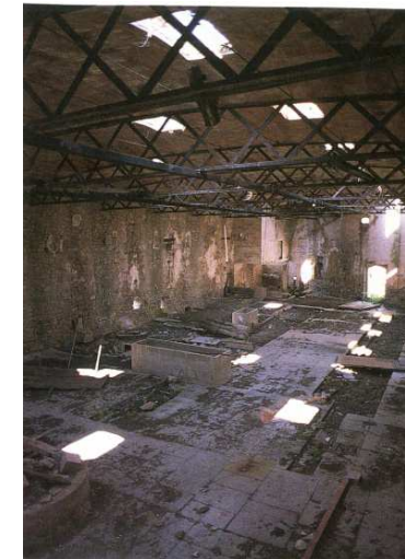
Fig. 6.1.5.1-10 Nave de escaudado de la lana. Vigas metálicas de celosía 6.1.5.1-8
