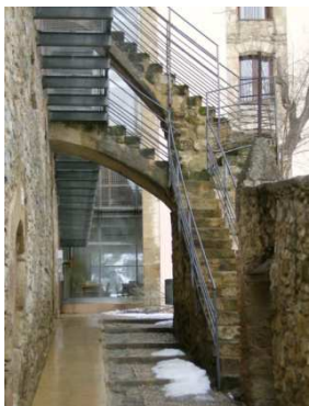
Fig. 6.1.5.1-5 Escalera de acceso a las viviendas de los trabajadores
