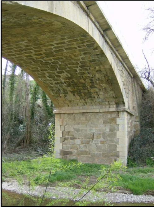
Fig. 4 Vista de la bóveda
