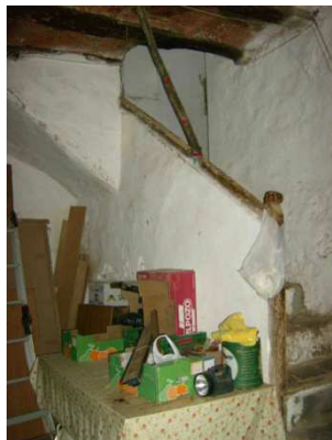
Fig. 9.4-45 Escaleras Molí Randero
