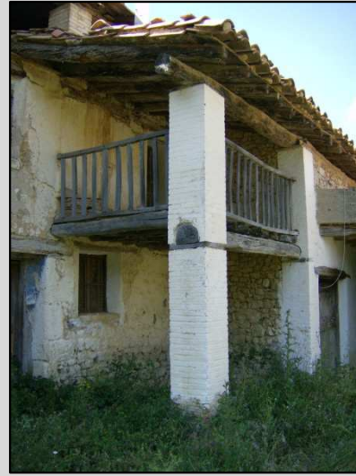
Fig. 8 Pórtico fachada acceso viviendas
