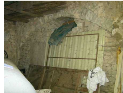
Fig. 9.4-22 Crujiás resuelta en origen con arco de medio punto Molí d'en Pi.
