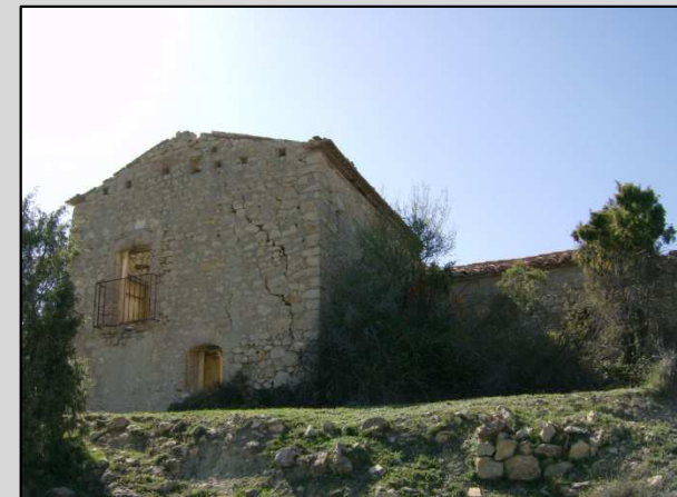
Fig. 6 Vista de la fachada principal de la vivienda y edificio destinado a almacén de material.
