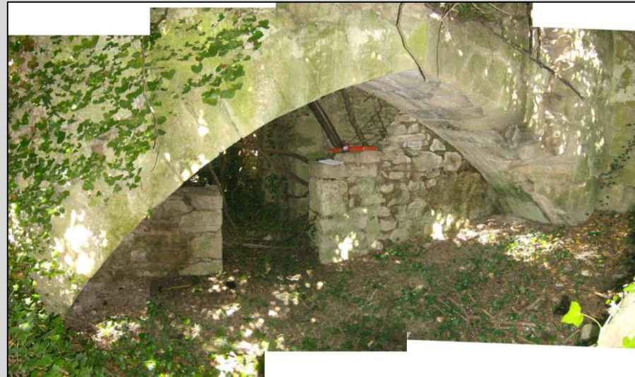
Fig. 10 Arco perpendicular al frontal del cup. Debajo del arco o en los laterales se situaría el juego de muelas. En la parte derecha de la imagen encuentro entre frontal del cup y el arco.
