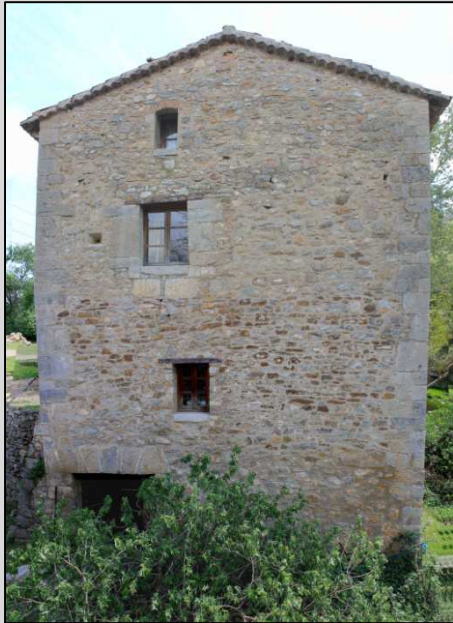
Fig. 6 Vista fachas Noroeste torre Molí la Font y acceso a planta semisótano
