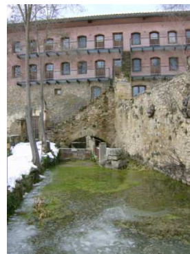
Fig. 6.1.5.1-7 Vivienda de los trabajadores estado actual
