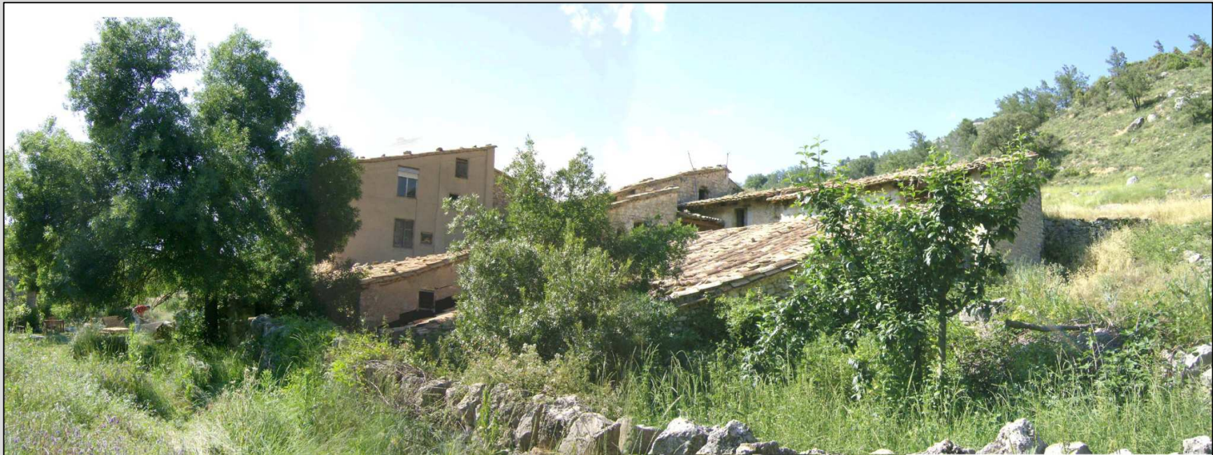
Fig. 5 Vista facha Sureste
