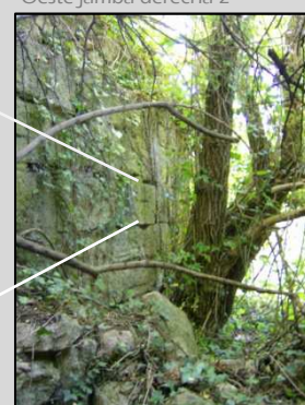
Fig. 21 Muro Este sala de molienda y estribo arco Este
