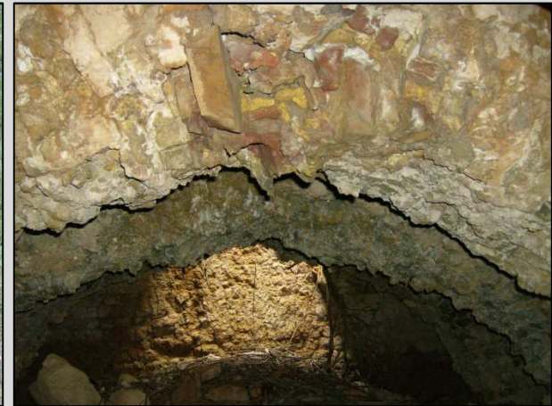
Fig. 18 Interior hogar del horno
