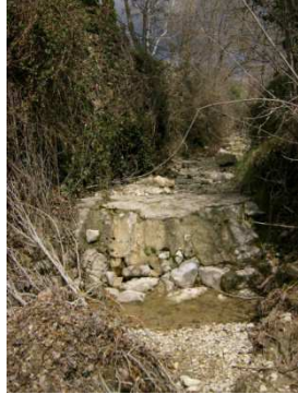
Fig. 6.1.4.4-17 Paso de la conducción horizontal soterrada por el barranco.
