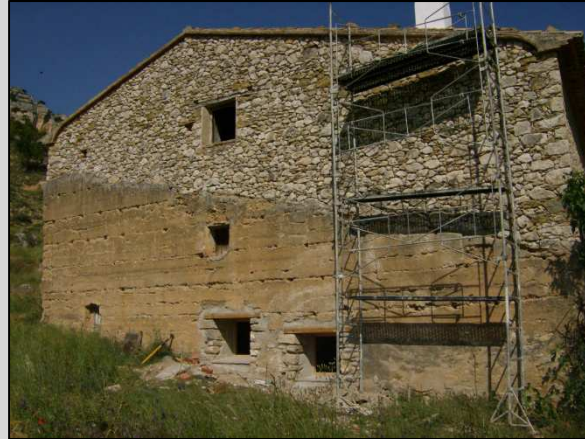
Fig. 7 Vista fachada Noroeste vivienda con muro de tapia
