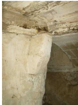
Fig. 9.4-38 Durmiende sobre canecillos
