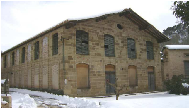
Fig. 6.1.5.1-8 Nave de telares estado actual
