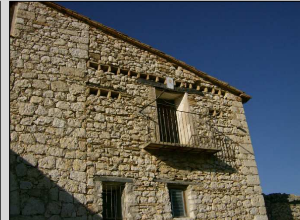
Fig. 6 Detalle huecos del palomar y junta de edificaciones
