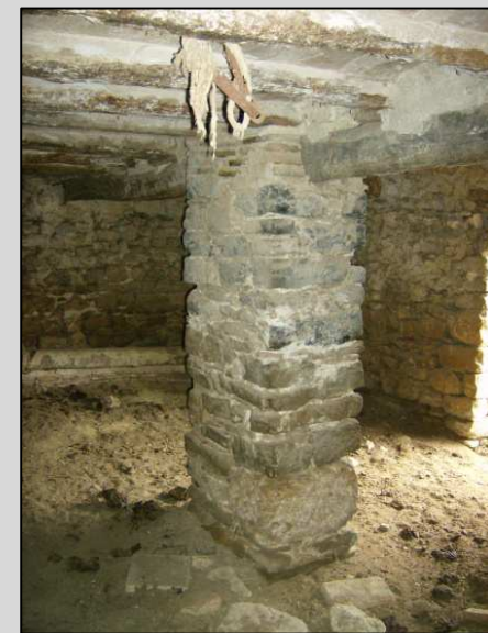
Fig. 21 Pilar corral de vivienda 2
