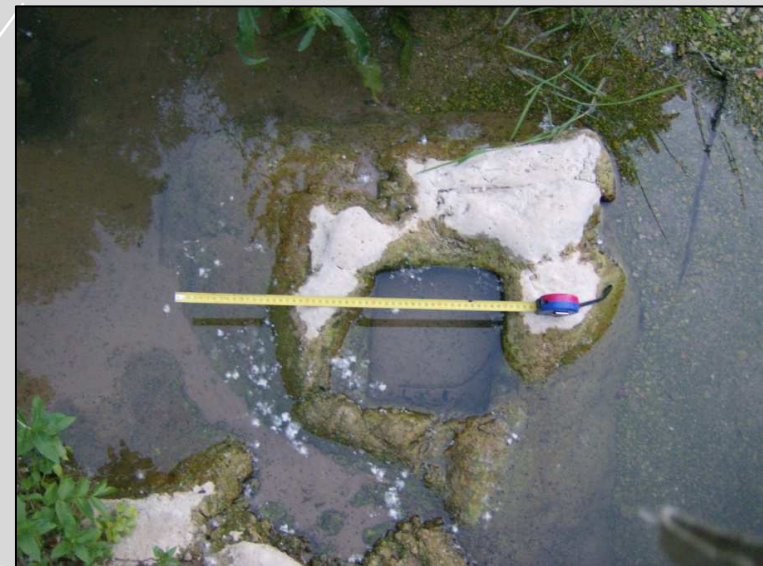
Fig. 5 detalle del hueco para la colocación de barras de antiguo assut
