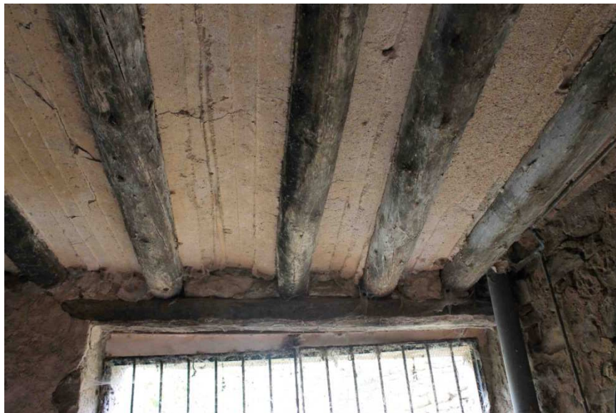
Fig. 9.4- 32 Forjado de rollizos y revoltón de yeso. Se pueden apreciar improntas de las tablas del encofrado. Moli La Font
