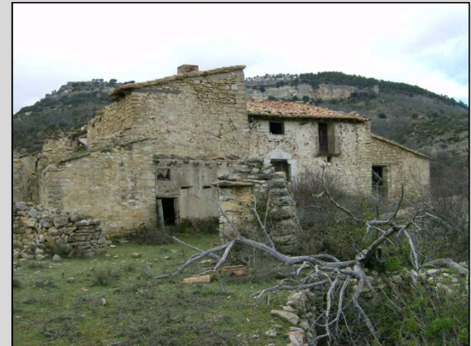
Fig. 9 Vista adiciones zona Sureste
