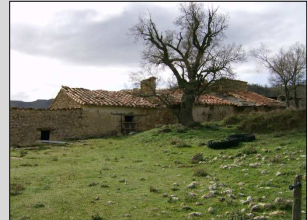
Fig. 9 Vista fachada Noroeste
