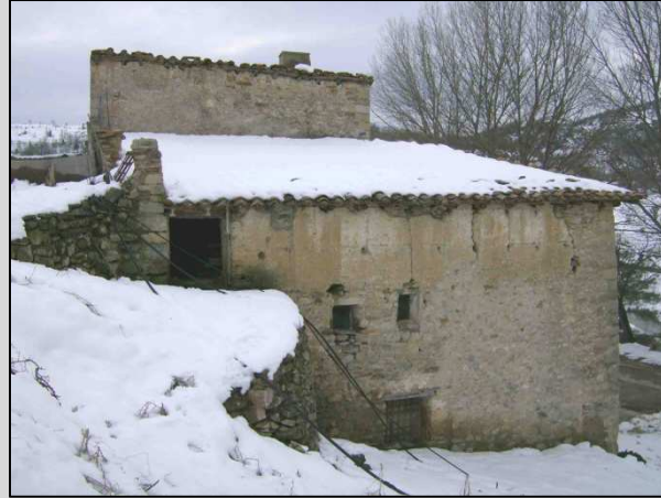
Fig. 7 Fachada Norte, acceso al desván y muro de tapia en la parte superior.
