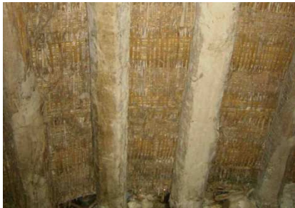
Fig. 9.4-49 Rollizos y cañizo de la cubierta del Mas de Danyal.
