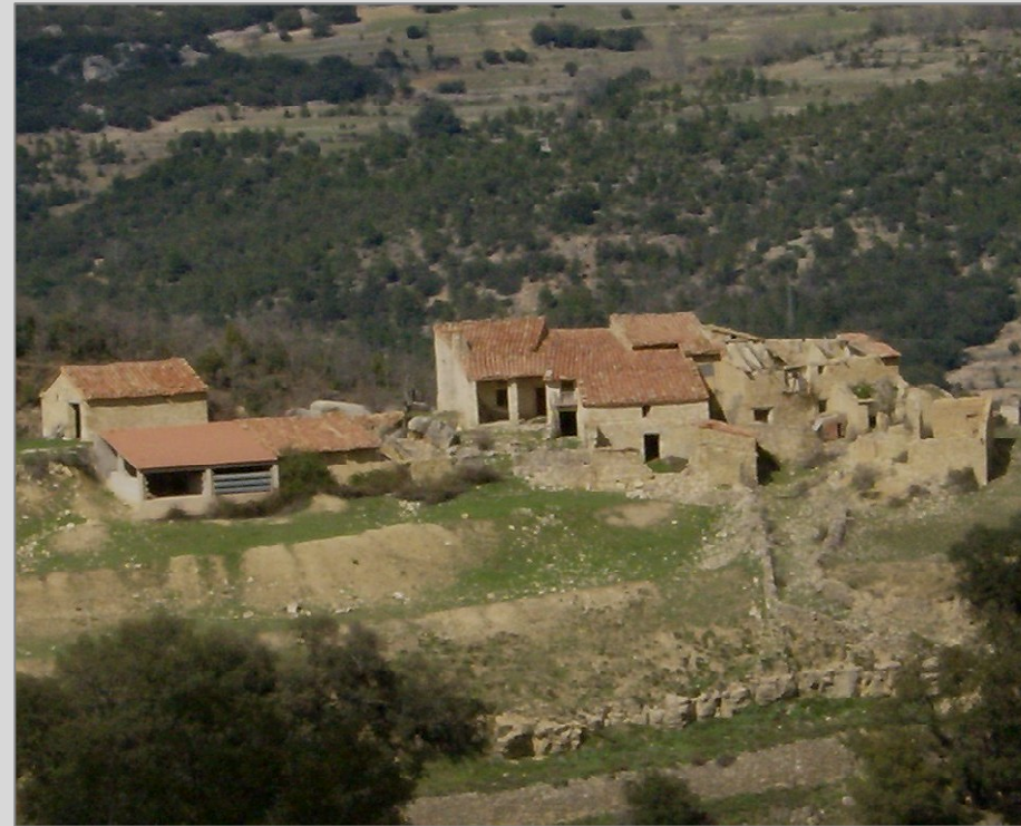
Fig. 1 Vista general del conjunto desde la orientación Sur.
