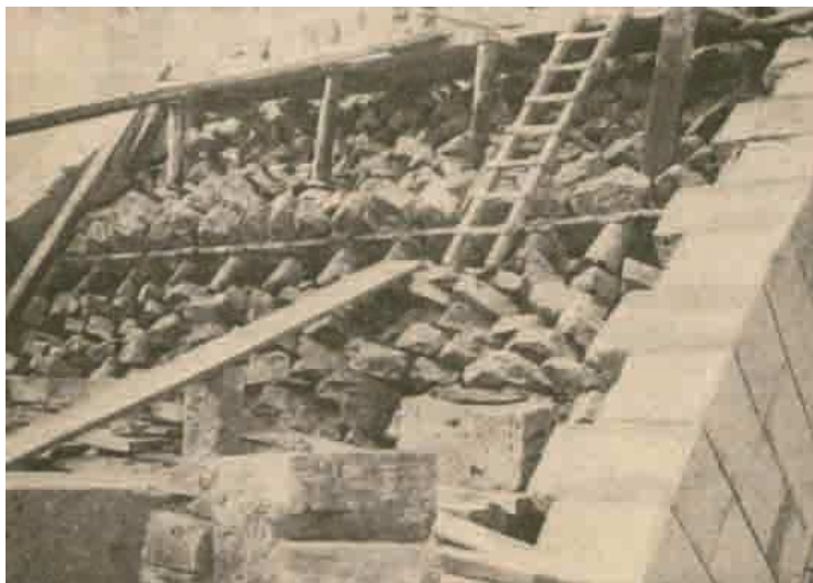
Fig. 6.1.4.1-3 Relleno bóveda de puente de sillería y mampostería principios del siglo XX 6.1.5.1.4
