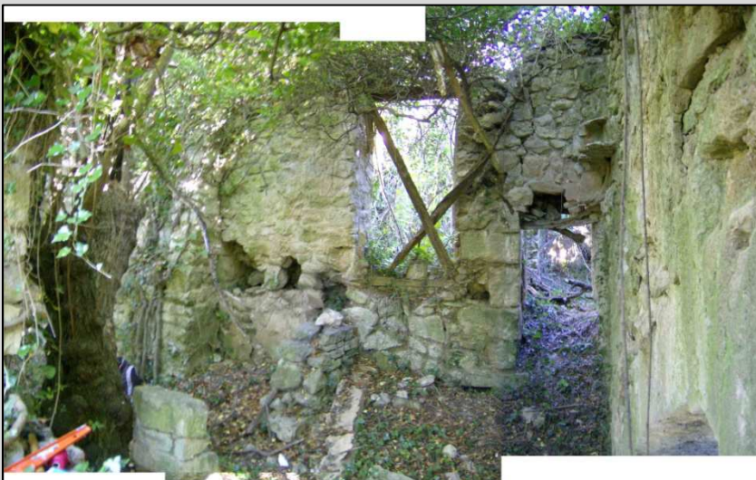
Fig. 9 Parte del muro Norte alineado con el frontal del cup. Impostas de forjados de P.1ª o desván, acceso a sala contigua por orientación Sur de la sala de molienda. A la derecha de la imagen arco y muro Oeste. A la izquierda de la imagen se situaría el frontal del cup.
