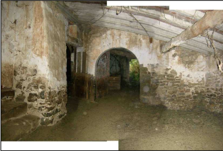
Fig. 8 Acceso primitivo a la sala de molienda fusionado con edificio de vivienda
