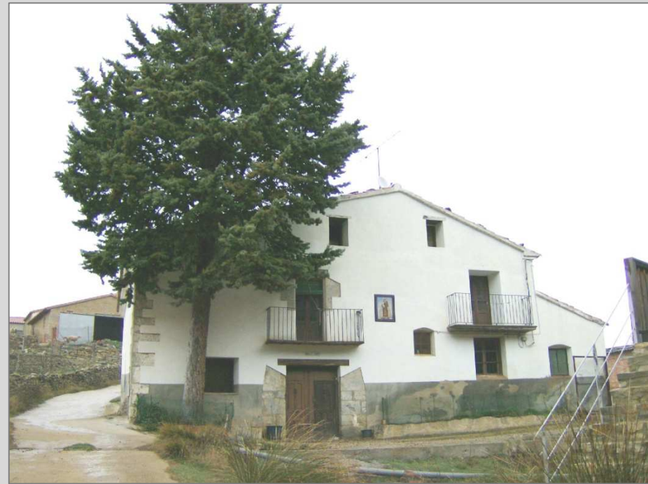
Fig. 1 Vista fachada sur Molí Nou
