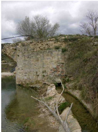
Fig. 6.1.4.4-19 Embocadura de la acequia de Moli Gamundi en el estribo de la ribera derecha del Pont Trencat construido en 1393.
