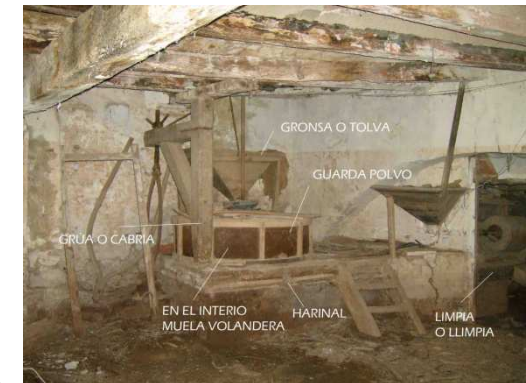
Fig. 8.2-7 Sala de molienda Molí Roio.
