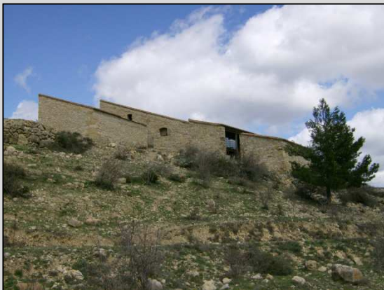
Fig. 7 Vista de la fachada Suroeste desde el camino de acceso
