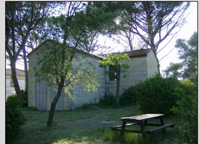
Fig. 6 Vista de escorzo Fachada principal y crucero
