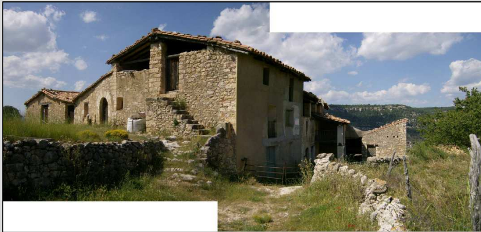
Fig. 4 Vista general y acceso a la era
