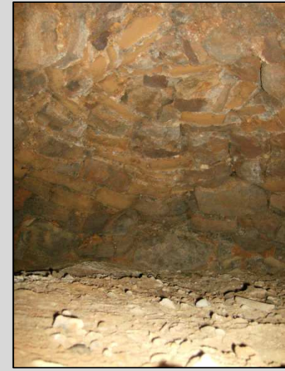
Fig. 14 Interior, bóveda del horno
