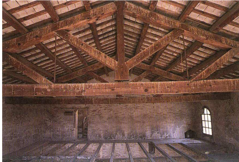
Fig. 6.1.5.1-12 Cercha de Madera y entablado cubierta 6.1.5.1-10
