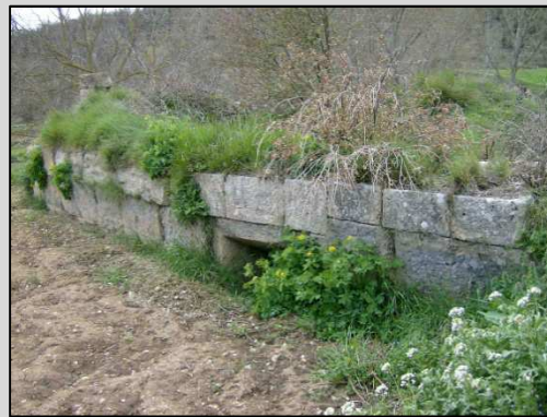
Fig. 6 Muro de contención balsa y embocadura rampa
