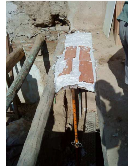
Fig. 9.4-34 Ejecución de un forjado resuelto con entrevigado de revoltón de yeso y ladrillo hueco.
