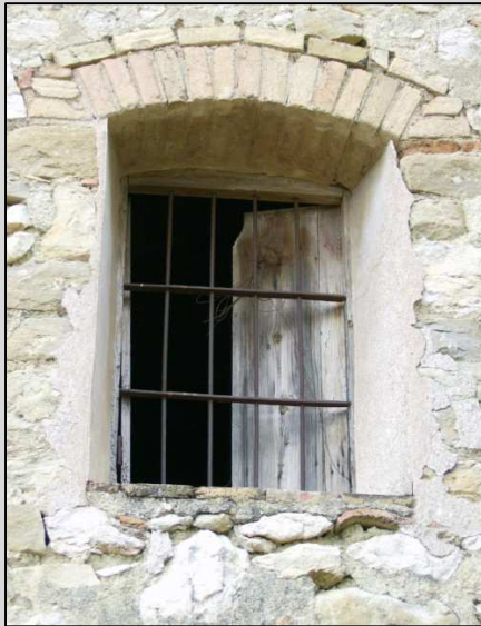
Fig. 16 Ventana con dintel de ladrillo de arcilla cocida
