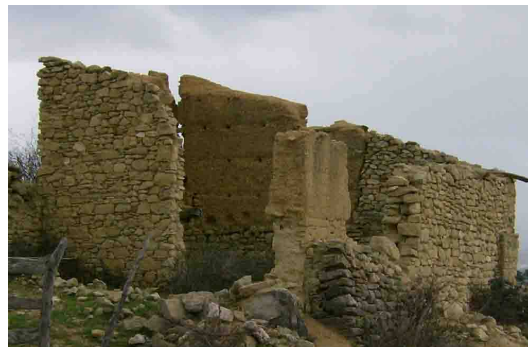
Fig. 9.4-7 Pallissa , Mas de Segureta. Mixto mampostería y tapia calicostrada en el exterior. Se observa como resiste aun estando desprotegida.
