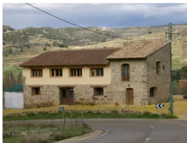
Fig. 6.1.1.2-2 Caseta de Torro
