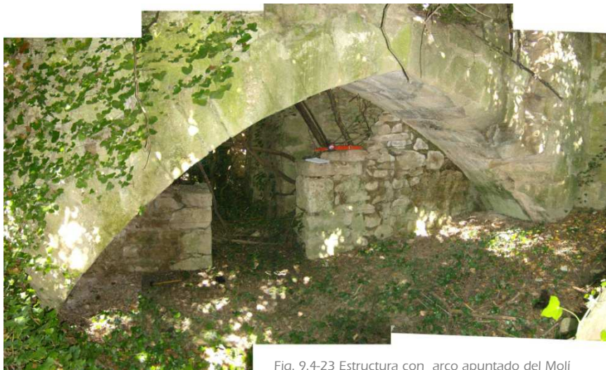
Fig. 9.4-23 Estructura con arco apuntado del Molí del Batà.
