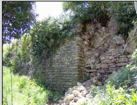
Fig. 13 Muro contención balsa
