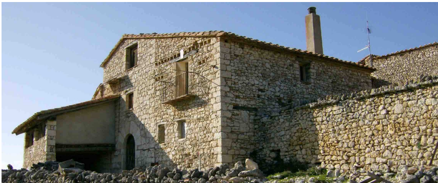
Fig. 9.4-59 Remate de fachada y alero de vertido de aguas. Mas de la Mola.
