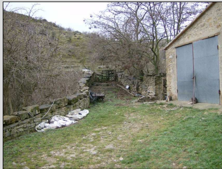
Fig. 8 Acceso al puente
