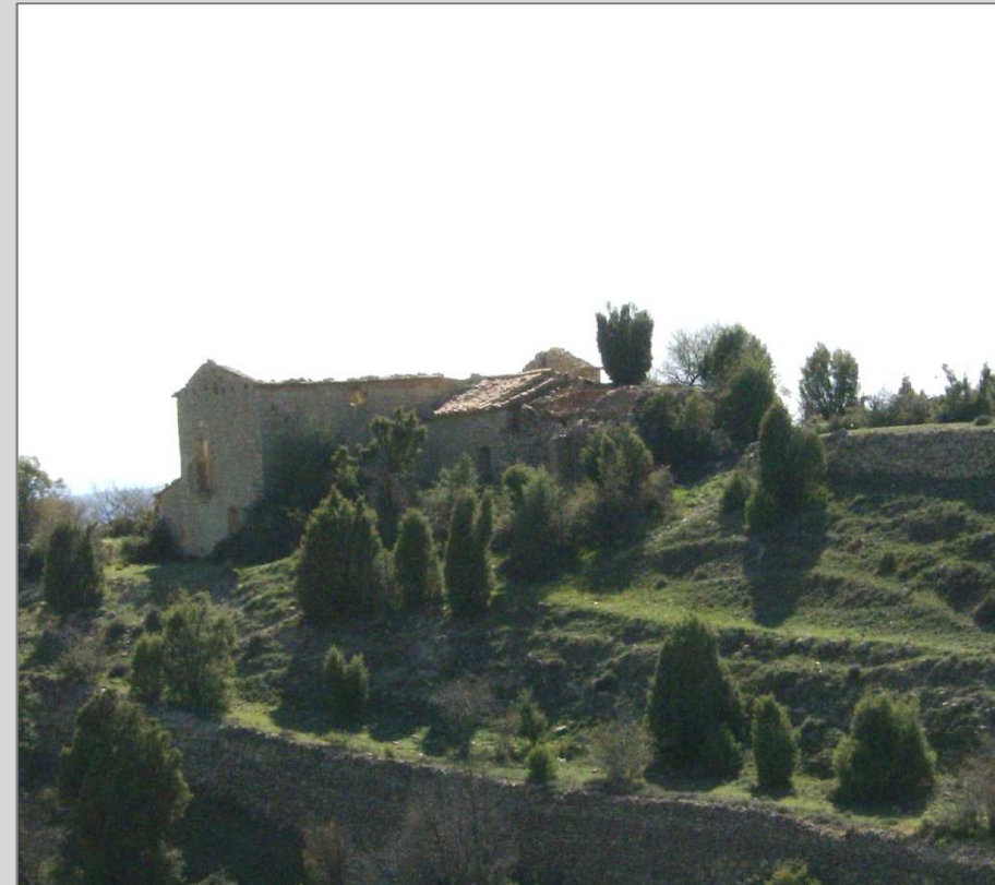
Fig. 1 Teuleria de la Mola vista desde el camino de acceso.
