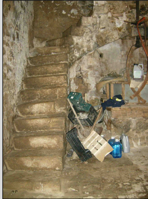
Fig. 13 Escalera de acceso a planta primera del molino.
