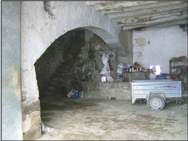
Fig. 12 Sala de molienda.
