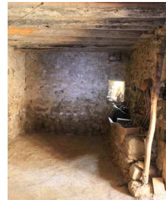
Fig. 9.4-18 Viguetas cargando sobre muros. Torre del Molí la Font
