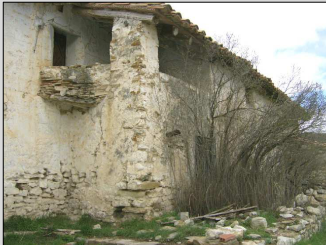
Fig. 7 Vista Adiciones fachada
