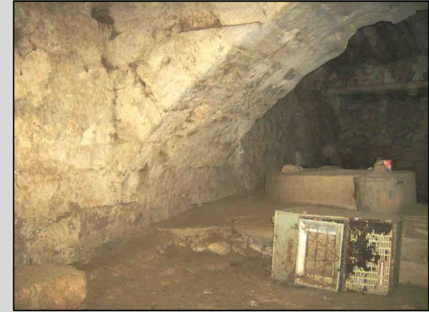
Fig. 22 Entronque arco con muro del cup
