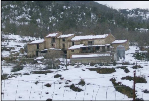
Fig. 4 Vista fachada principal Nevada de 3 de Marzo 2013
