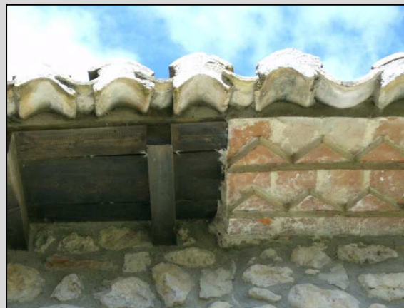
Fig. 8 Aleros de dos edificaciones
