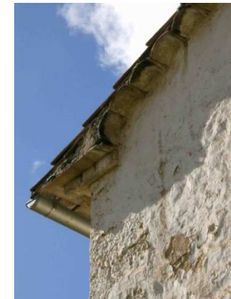
Fig. 9.4-53 Pequeño alero con tejas perpendiculares, remate lateral. La Pobleta del Riu
