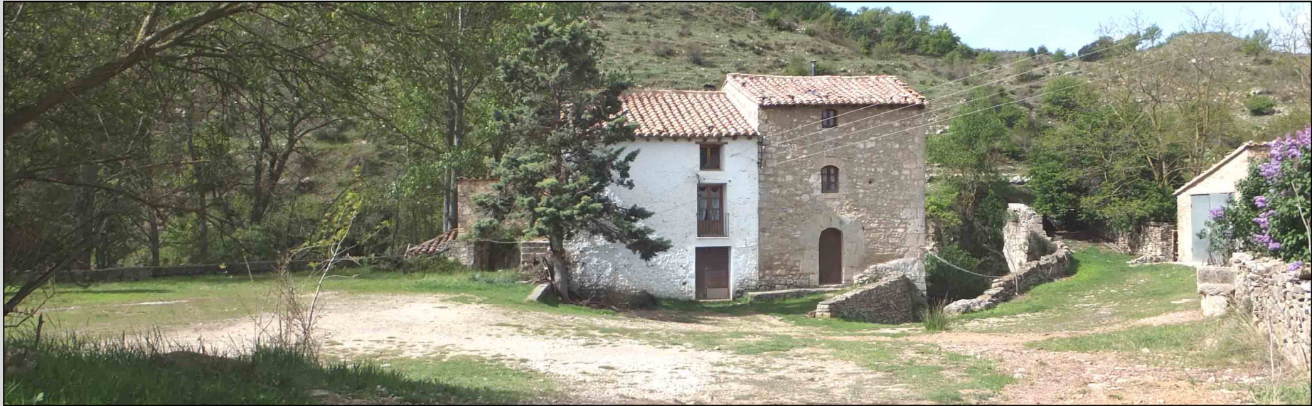
Fig. 8 Vista panorámica Antigua balsa, molino-vivienda-torre fachada Noreste y acceso al puente
