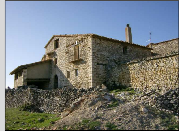
Fig. 12 Vista 2 escorzo de la fachada principal. Orientación Sur
