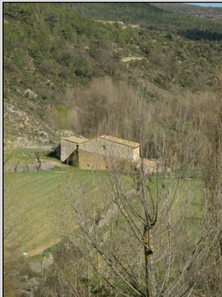
Fig. 9 Vista fachada Noroeste
