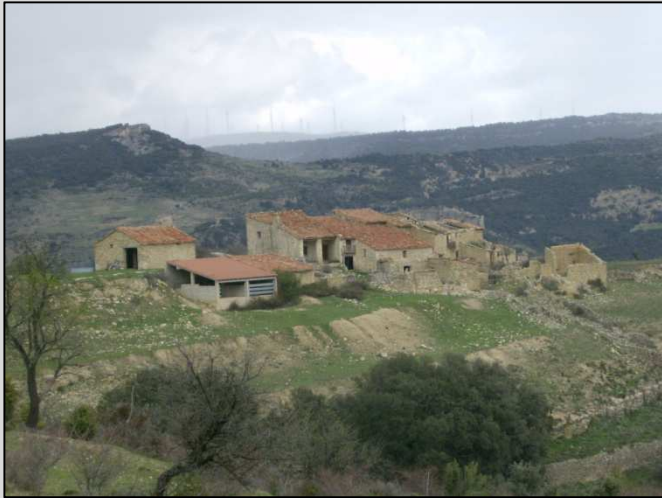
Fig. 4 Vista general del conjunto desde la orientación Suroeste.
