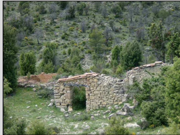
Fig. 14 Caseta destinada a almacén
