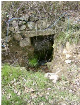
Fig. 6.1.4.4-16 Embocadura del la acequia con el conducto vertical
