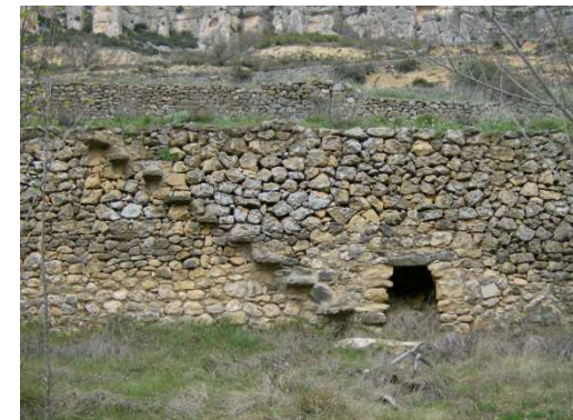
Fig. 6.1.1.4-19 Saltadora y embocadura barraca
