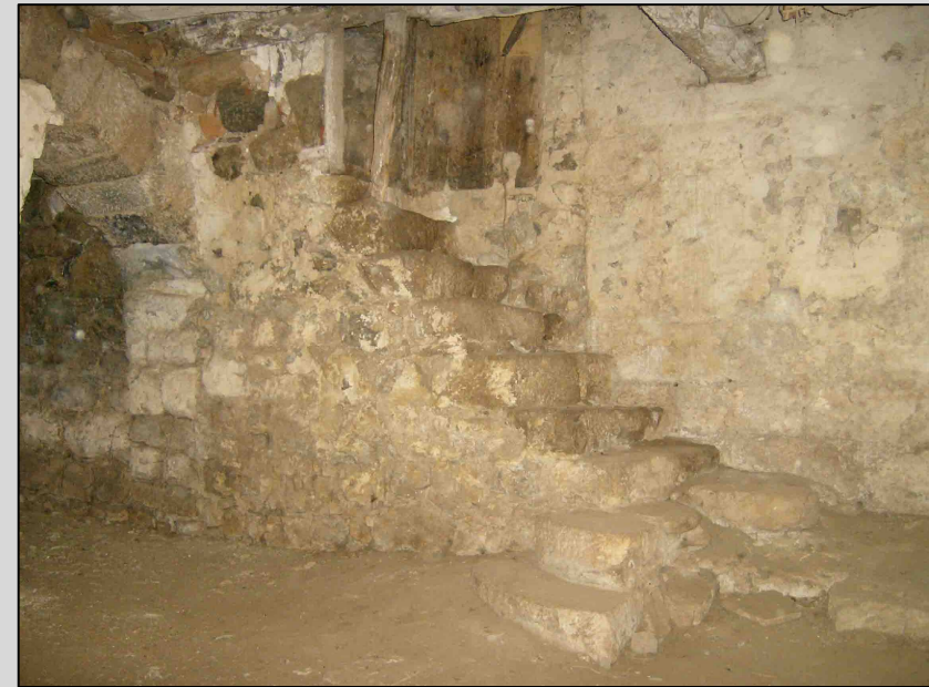
Fig. 25 Escalera de comunicación sala de molienda con distribuidor
