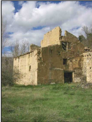
Fig. 8 Acceso planta baja
