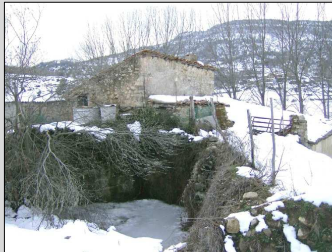
Fig. 16 Balsa, embocadura de la rampa y fachada Este.
