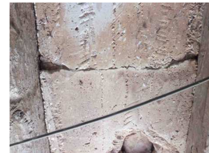
Fig. 9.4-36 Junta de encofrado. Torre del Moli la Font.
