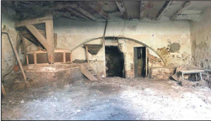
Fig. 8 Sala de molienda
