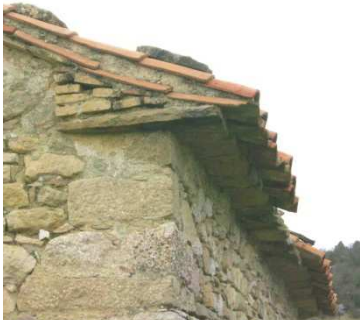
Fig. 9.4-56 Alero con losas y ladrillo Mas de Segura.
