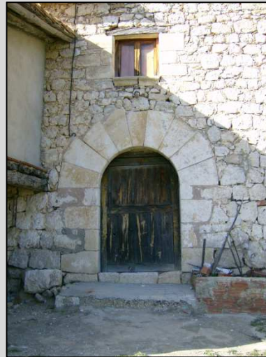
Fig. 11 Detalle puerta de acceso principal Sur
