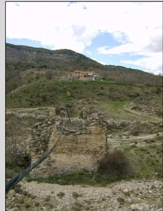
Fig. 6 Vista desde el inicio del puente ribera derecha del Bergantes
