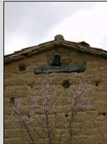
Fig. 8 Muro de tapial y durmiente jácena
