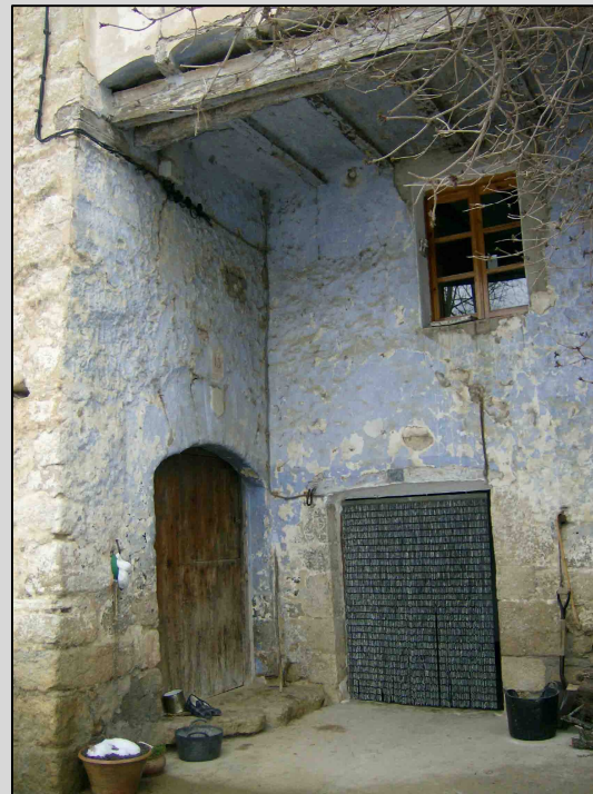
Fig. 10 Acceso primitivo al molino y acceso vivienda.
