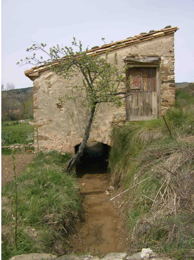
Fig. 6.1.4.4-24 Construcción de caseta de aperos sobre acequia del Molí Roio.
