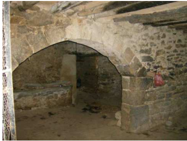
Fig. 9.4-21 Hueco con arco rebajado. Torre del Molí la Font
