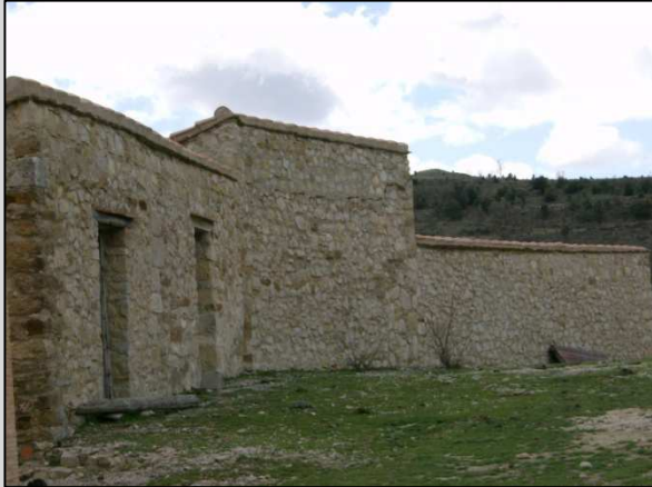
Fig. 4 Vista de la fachada Noroeste y era
