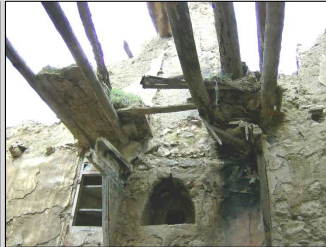
Fig. 10 Forjados, horno, chimenea
