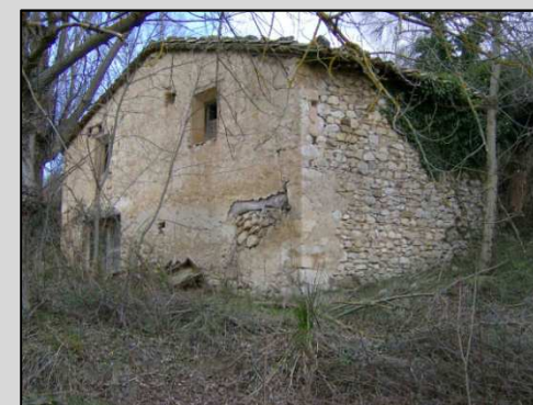
Fig. 7 Fachada Norte y Oeste
