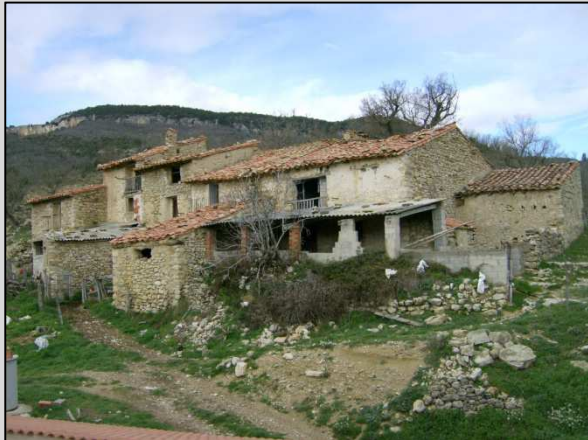
Fig. 7 Vista fachada principal y fachada Norte
