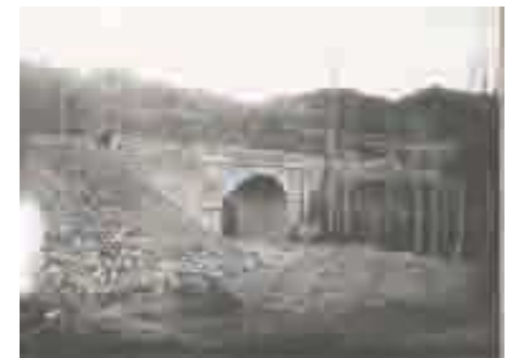
Fig. 6.1.14.1-2 Construcción del puente Mollí d'Adell. 6.1.5.1-3
