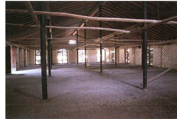
Fig. 6.1.5.1-9 Interior nave de telares. Columnas de fundición 6.1.5.1-7
