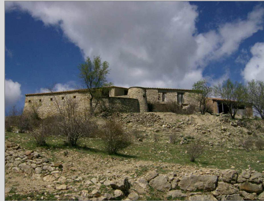
Fig. 1 Vista desde el camino de acceso. Fachada orientación Sureste
