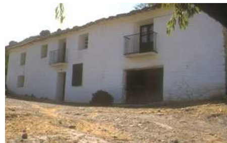
Fig. 6.1.1.2-3 Caseta de Canteret
