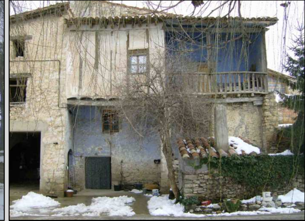
Fig. 8 Fachada Oeste vivienda y zona porticada.
