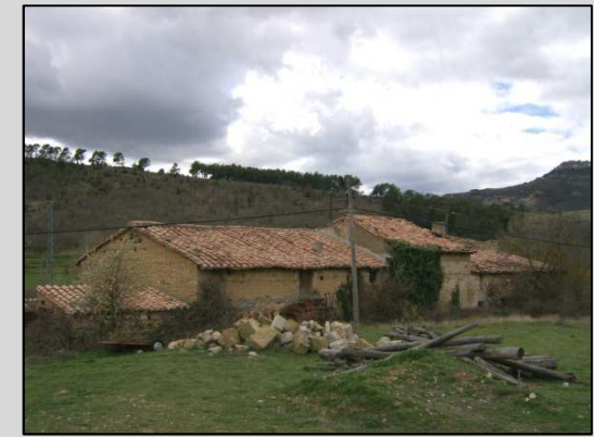
Fig. 6 Vista fachada Norte y la era
