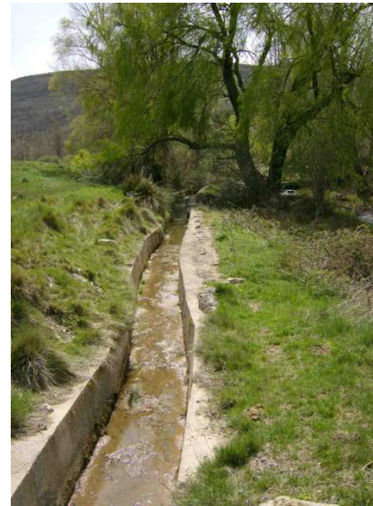
Fig. 6.1.4.4-9 Acequia Molí d'Adell reconstruida tras la avenida de 1967.
