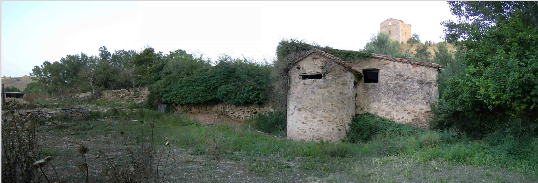
Fig. 6 Muro de la balsa y aliviadero, fachada Noroeste
