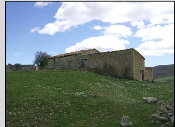
Fig. 9 Vista de la era y fachada Norte
