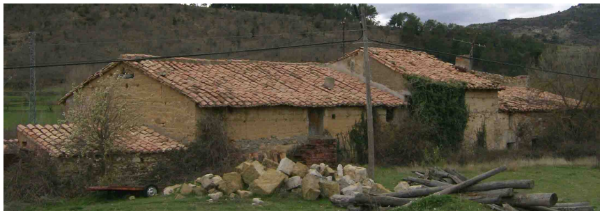
Fig. 9.4-5 Mas del Beato, muros de tapia simple
