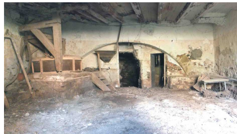
Fig. 9.4-20 Muro y arco rebajado, Molí Roio.
