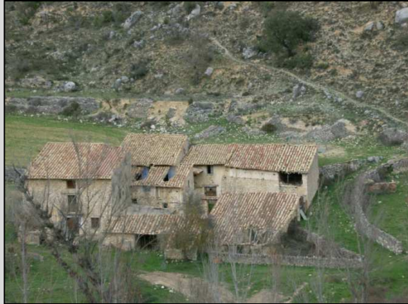
Fig. 6 Vista de patios interiores
