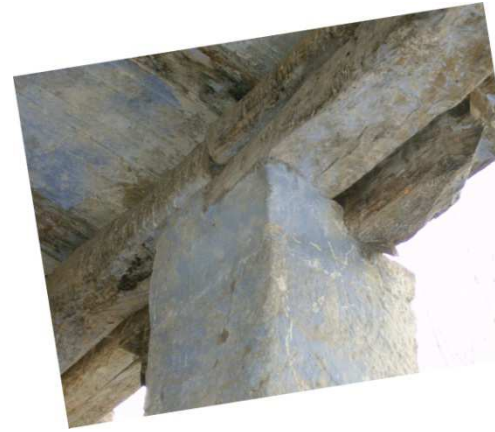
Fig. 9.4-27 Detalle asiento de jácenas en pilar, Molí la Pont
