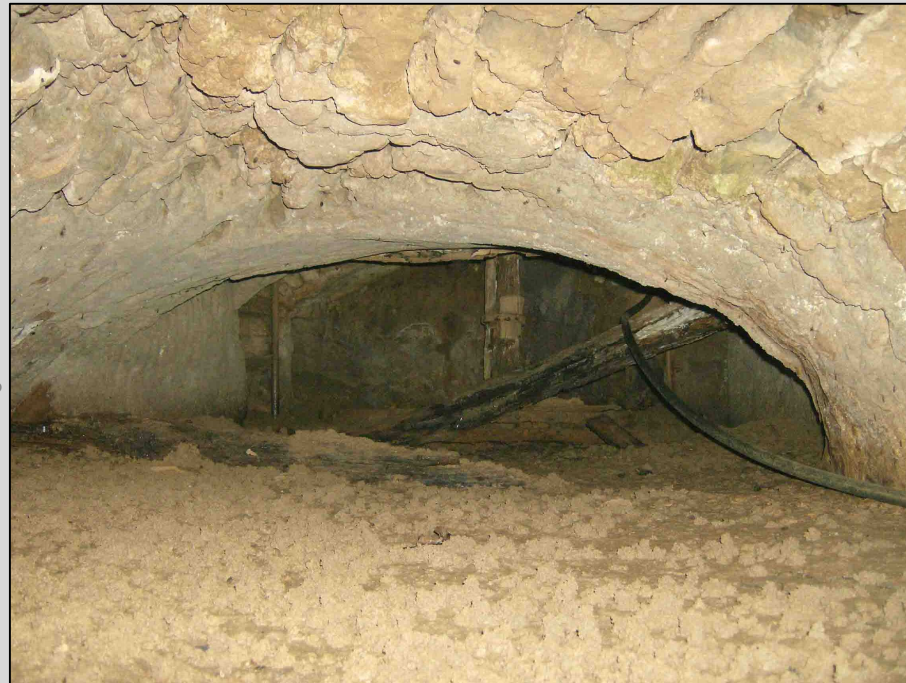
Fig. 18 Interior cárcavo, restos de rodete y el árbol
