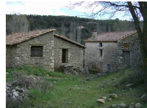
Fig. 9.4-4 Cantoneras de sillares y mampuestos Pobleta del Riu
