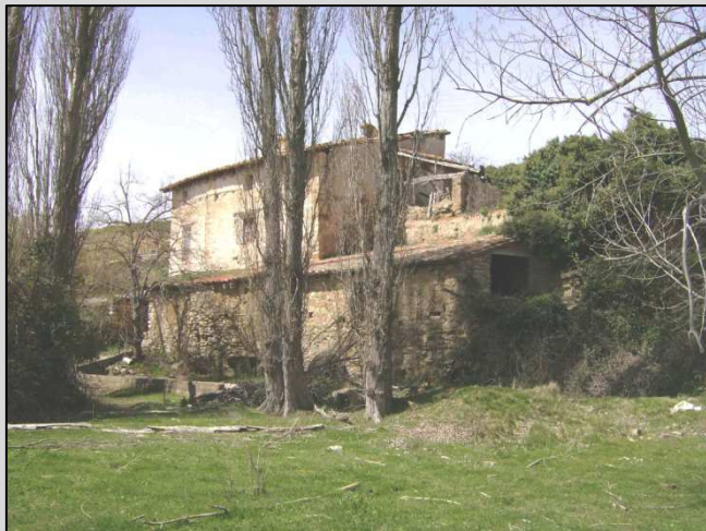
Fig. 5 Fachada Sureste y Nordeste
