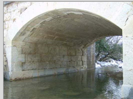
Fig. 2 Vista de la bóveda
