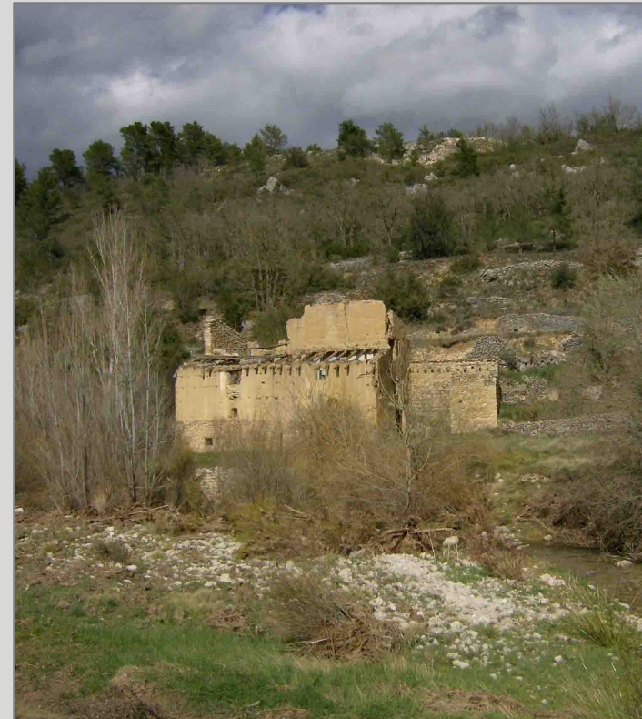
Fig. 1 vista general vivienda molinero fachada Suroeste
