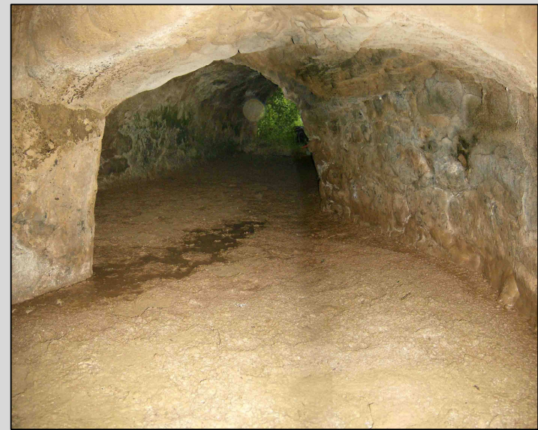
Fig. 13 Bóveda del cárcavo vista desde el interior
