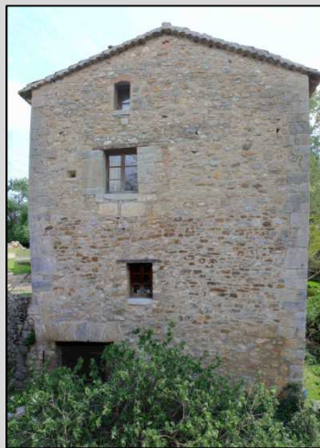
Fig. 10 Vista fachada Noroeste
