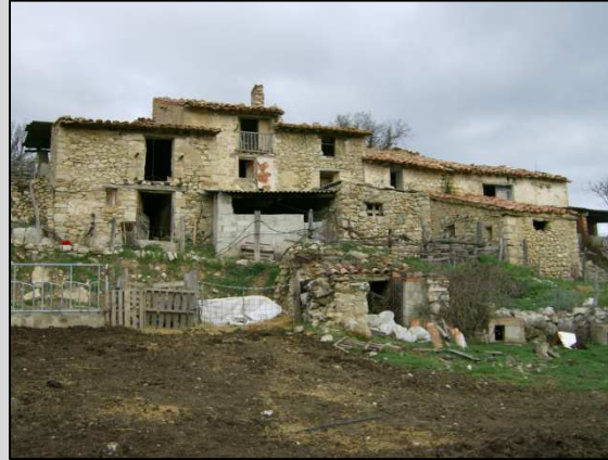
Fig. 5 Vista fachada Sureste
