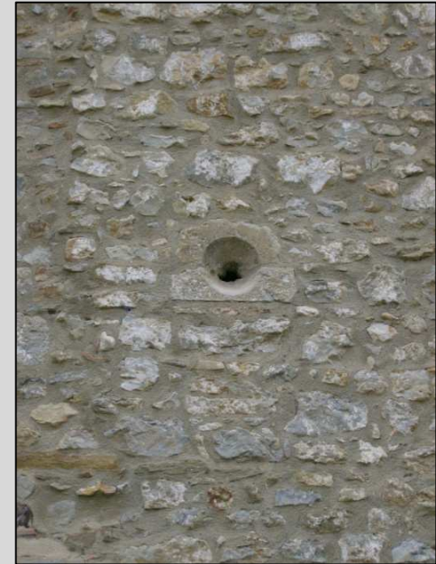
Fig. 8 Detalle aspillera fachada Noreste
