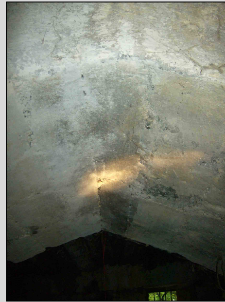
Fig. 24 Clave partida del arco
