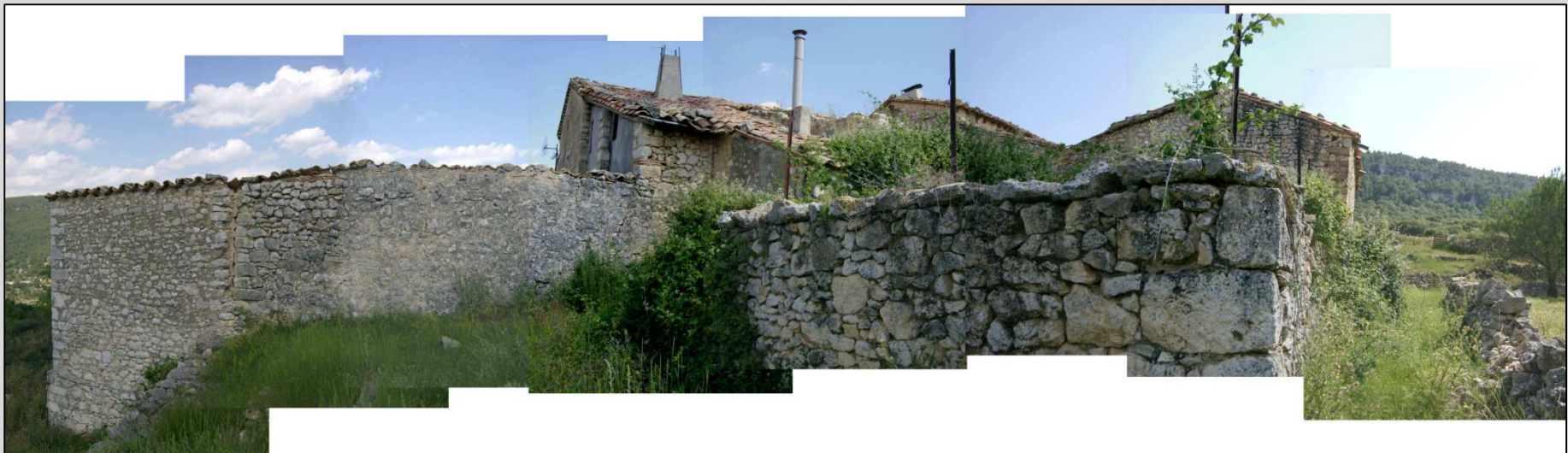
Fig. 6 Vista general desde orientación Noroeste
