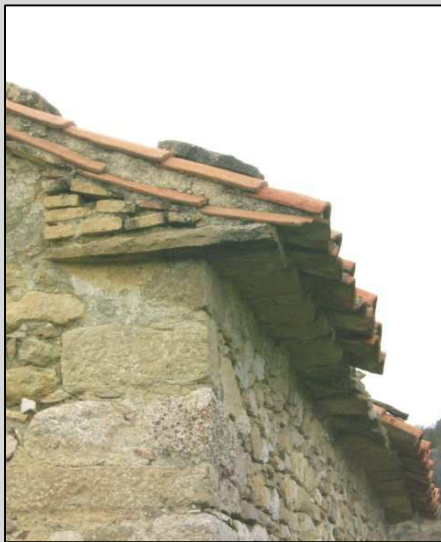
Fig. 19 Alero de losas de piedra
