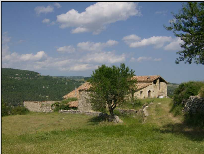
Fig. 10 Vista desde el Oeste era y parte de fachada Oeste
