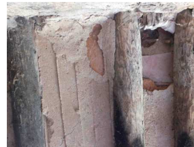
Fig. 9.4-35 Cascotes de relleno entrevigado Moli la Font.
