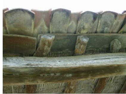
Fig. 9.4-57 Alero con tabla de madera de cobertizo Mas de Segura.
