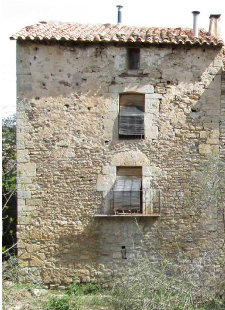
Fig. 9.4-11 Detalle de una ventanas balconadas de la torre del Molí la Font y cantoneras de sillares
