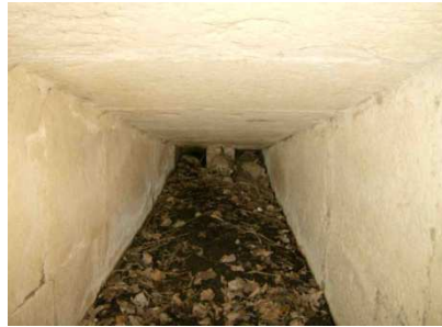
Fig. 8.1-7 Interior rampa del Molí els Capellans.
