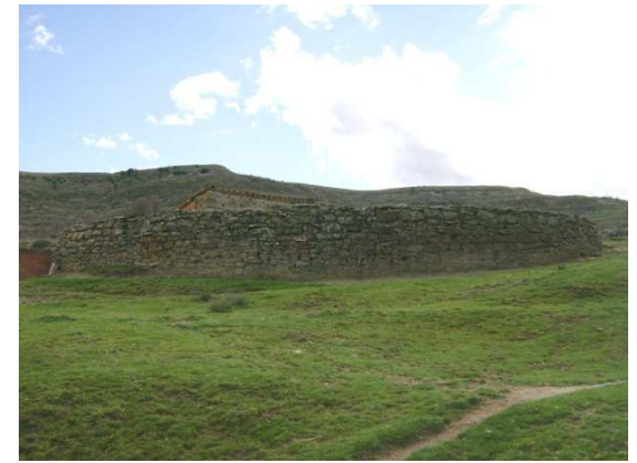
Fig. 6.1.1.4-25 Muro de la era de la Casseta de Peguesa
