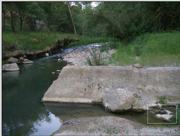
Fig. 4 Vista frontal, en el recuadro hueco para las barras del antigua assut
