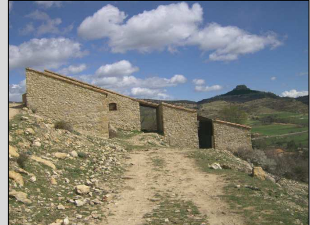
Fig. 6 Vista de la fachada suroeste
