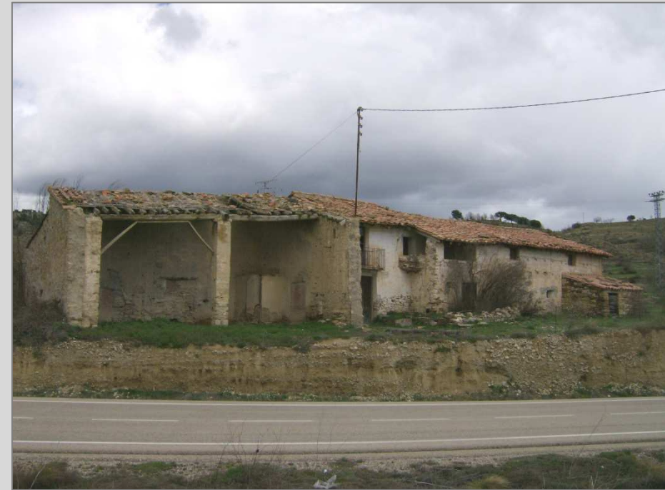
Fig. 1 Vista general estado actual fachada Sur, principal
