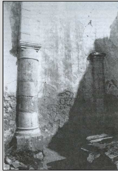
Fig. 11 Pilastra de la nave 4
