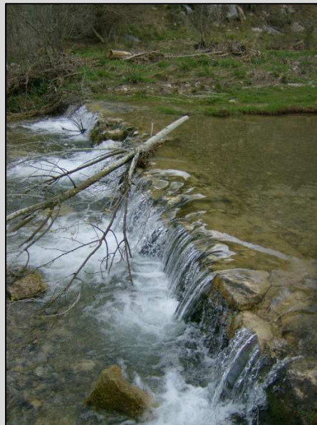
Fig. 4 Detalle ancho muro de assut
