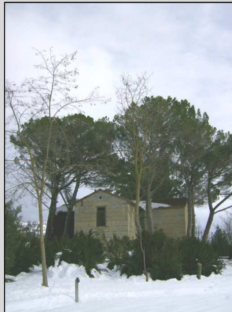
Fig. 5 Fachada cabecera orientación Noroeste
