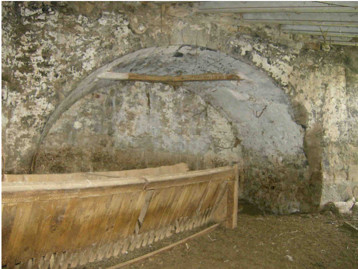
Fig. 9.4-29 Bóveda de la sala de molienda del Molí dels Capellans
