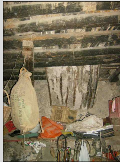
Fig. 9 Correa de escalera. Zona de acceso vivienda
