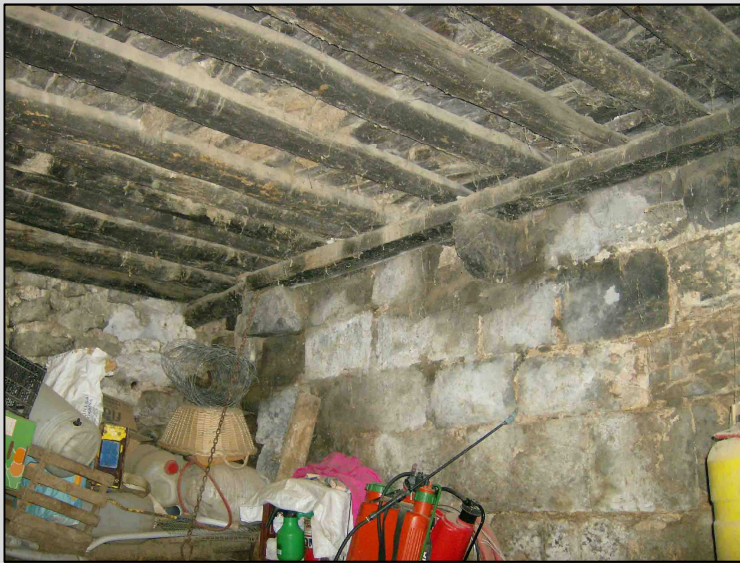
Fig. 8 Muro lateral cup, canecillos forjado P. 2. Zona de acceso vivienda
