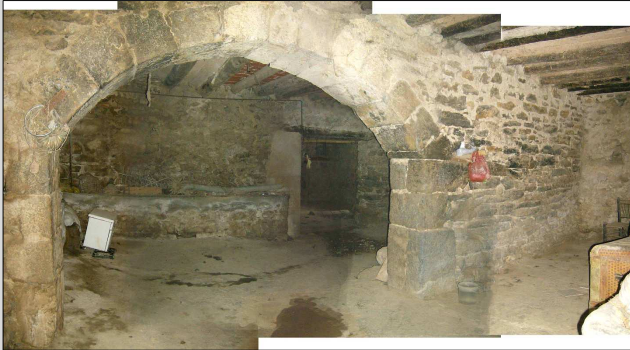
Fig. 12 Montaje arco semisótano torre Visto desde el acceso
