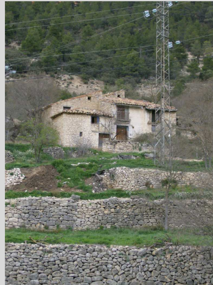
Fig. 1 Vista general desde la carretera CV-14
