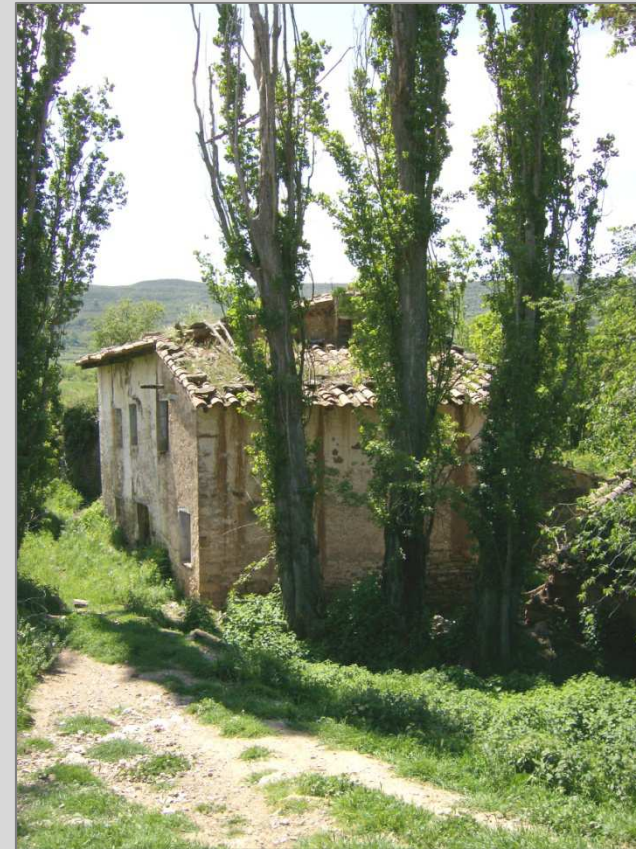
Fig. 1 Vista desde orientación Norte de Fachada principal y adiciones de la vivienda del molinero
