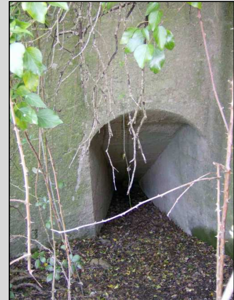
Fig. 16 Embocadura de la rampa
