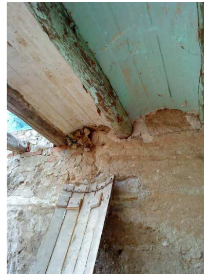
Fig. 9.4-33 Encofrado y forjado de viguetas y revoltón.
