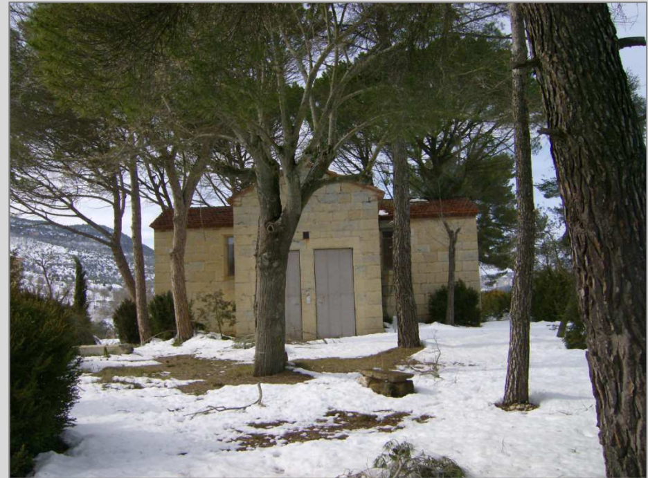
Fig. 1 Vista fachada principal, orientación Sureste
