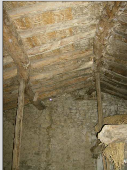
Fig. 14 Detalle jácenas apeadas y cañizos
