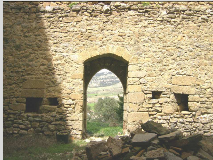
Fig. 12 Puerta de acceso desde el interior
