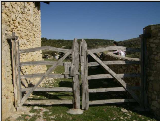
Fig. 13 Portera de acceso al recinto de la fachada Sur
