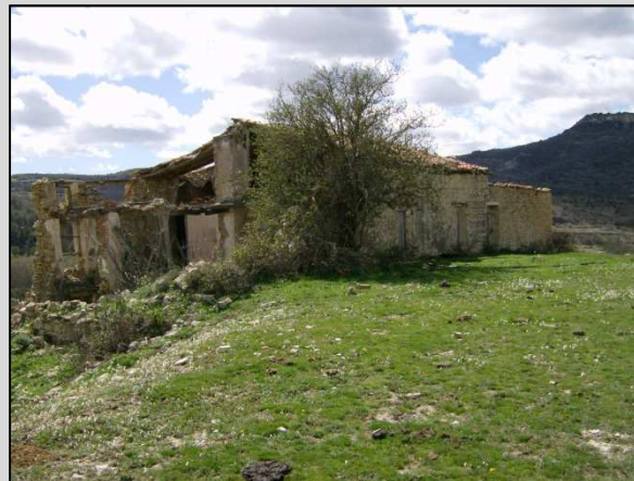
Fig. 8 Vista desde de la era y restos fachada Este
