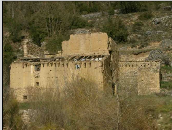
Fig. 6 Fachada Suroeste estado actual
