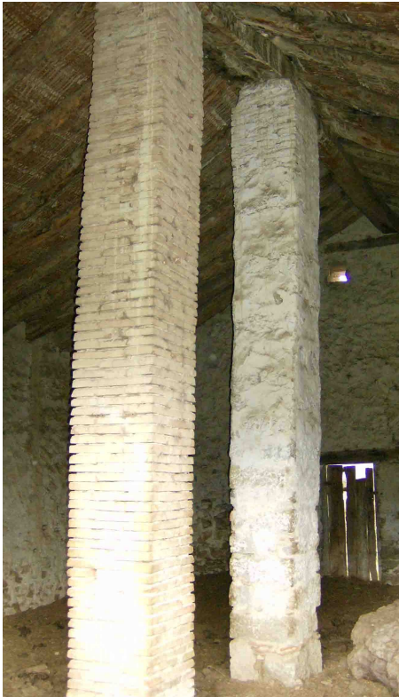
Fig. 9.4-25 Pilares de ladrillo y mampostería en granero del Mas de Segura.
