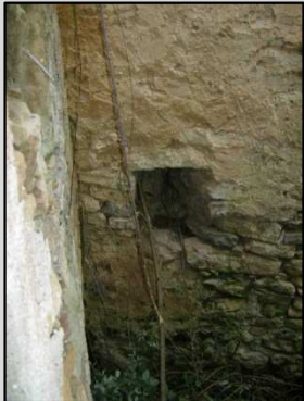
Fig. 16 Aspillera desembocadura cárcavo
