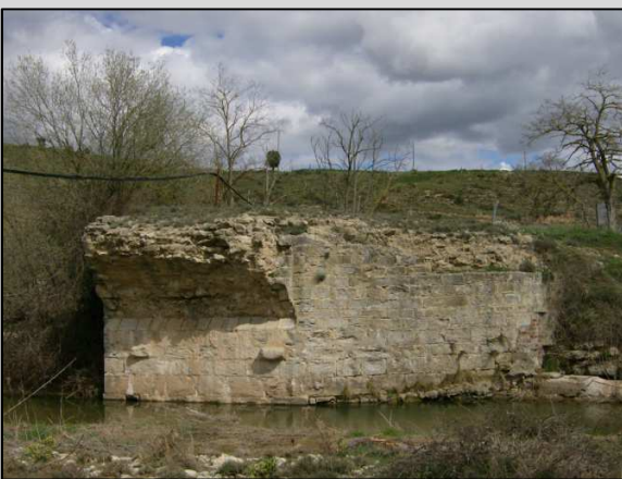
Fig. 7 Estribo ribera derecha del Bergantes
