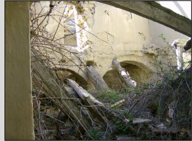
Fig. 9 Arcos de ladrillo, interior vivienda.
