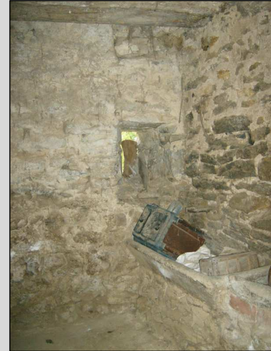
Fig. 13 Ventana aspillada semisótano torre
