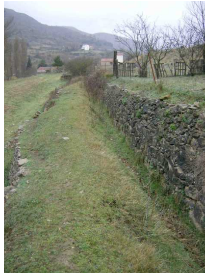
Fig. 6.1.4.4-6 Acequia Molí Nou, creación de terraza para conseguir la pendiente necesaria.
