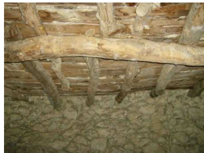
Fig. 9.4-40 Forjado de rollizos y entablado de madera en dependencias secundarias Mas de Danyal.
