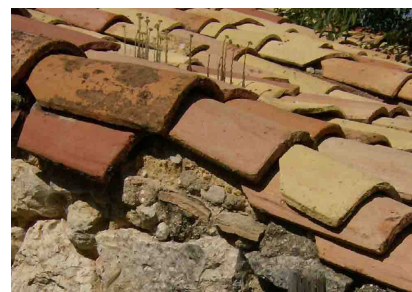
Fig. 9.4-50 Cubierta teja árabe y mortero pobre de cal y tierra. Mas de Carlos.
