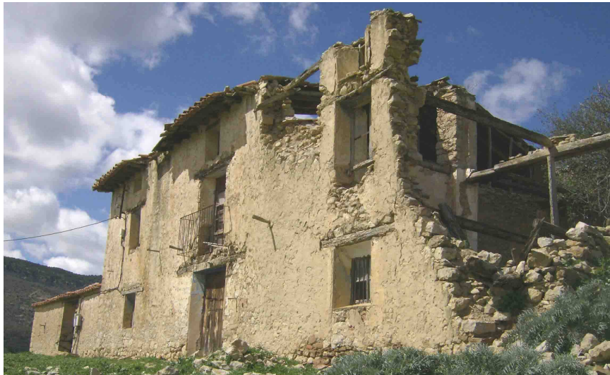
Fig. 9.4-8 Mas de la Castilla. Se pueden observar todos los huecos resueltos con jambas de mampostería y dintel de madera.
