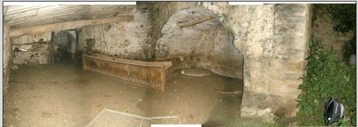
Fig. 11 Sala de molienda, bóveda de refuerzo muro de la balsa, piedra voladera y dos sotanas
