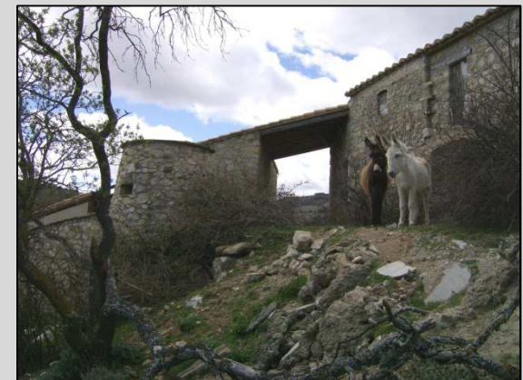
Fig. 10 Vista de la fachada desde orientación Noreste
