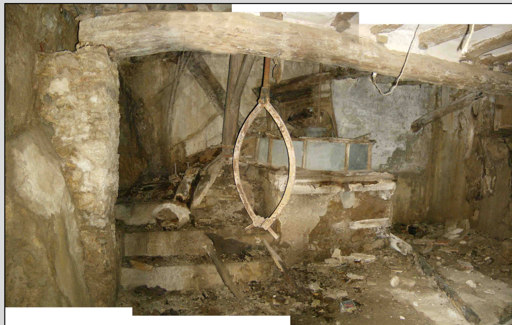
Fig. 9 Zona molienda planta baja
