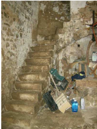
Fig. 9.4-43 Escaleras sala de molinera Molí del Pont.
