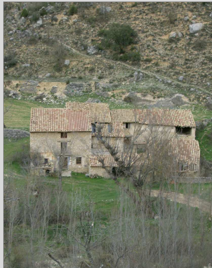
Fig. 1 Vista frontal fachada principal, orientación Suroeste
