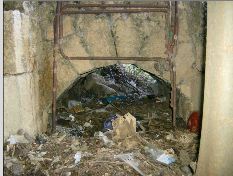
Fig. 15 Arco paso de la acequia
