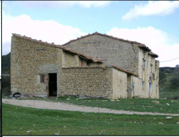
Fig. 5 Vista fachada Oeste
