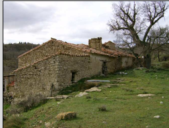
Fig. 8 Vista fachada Norte y parcial de la era
