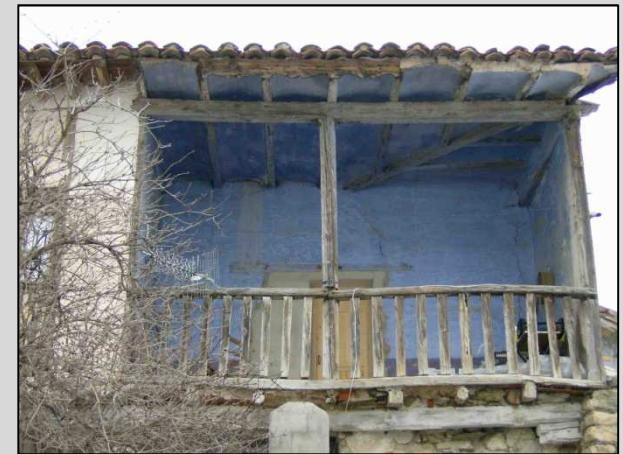
Fig. 11 balcón zona porticada y estructura de ésta.
