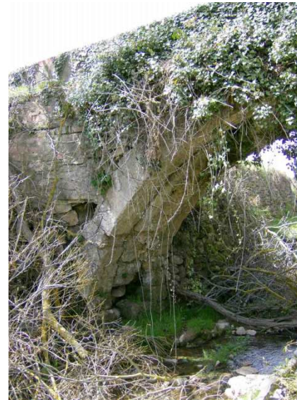
Fig. 6.1.4.4-14 Arranque de la parte izquierda acueducto. Visto desde aguas arriba del acueducto.
