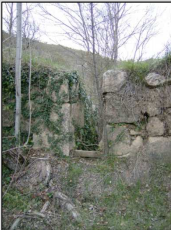
Fig. 19 Aliviadero balsa (Testellador)
