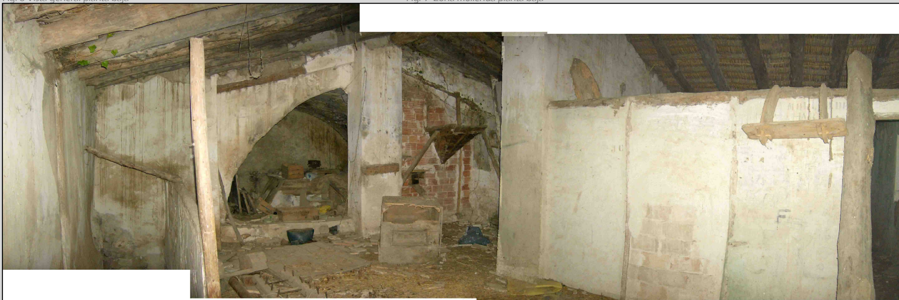
Fig. 10 Vista general planta primera
