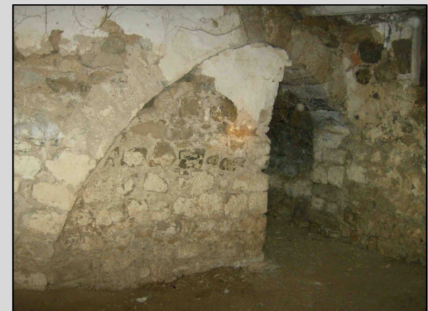
Fig. 19 Arco acceso establos
