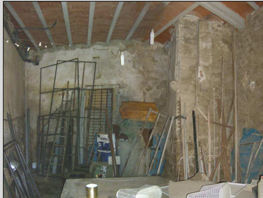
Fig. 10 Montaje fotográfico, sala de molineta al fondo arco de medio punto y al fondo a la derecha refuerzo del cup.
