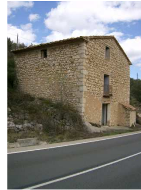
Fig. 6.1.1.2-10 Caseta de les Calçades
