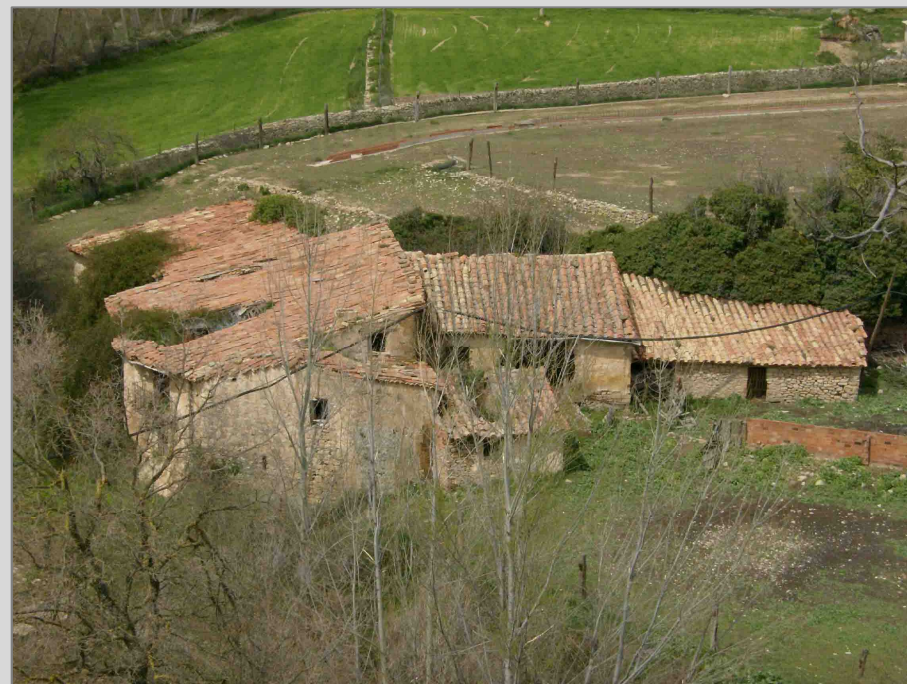
Figura 1. Vista general desde el Sureste
