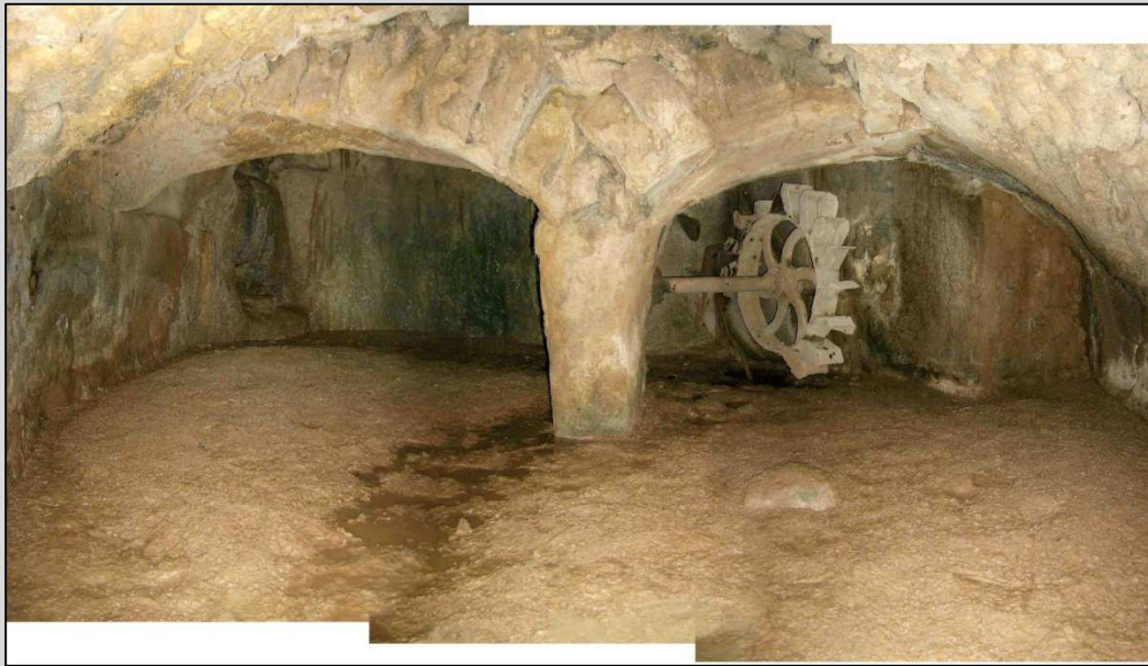
Fig. 12 Interior de cárcavo, rueda de eje horizontal, de la reforma para fábrica de tejidos. Huecos para dos rodetes, de concepción original
