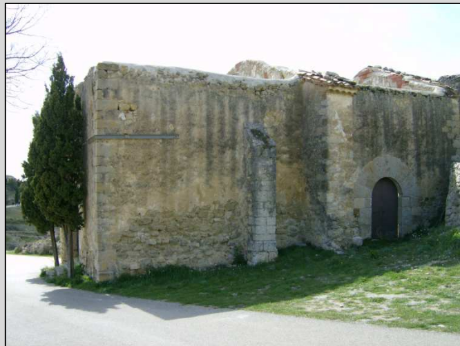
Fig. 4 Fachada principal orientación Noreste
