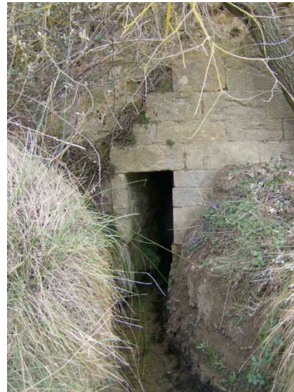
Fig. 6.1.4.4-20 Desembocadura de la acequia de Moli Gamundi en el estribo de la ribera derecha del Pont Trencat construido en 1393.
