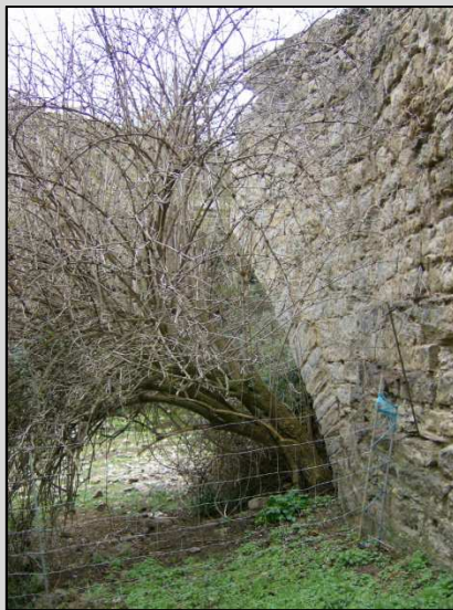
Fig. 7 Arranque del bóveda del puente 2
