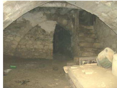
Fig. 9.4-21 Paso entre crujiás resuelto con arcos. Molí Randero
