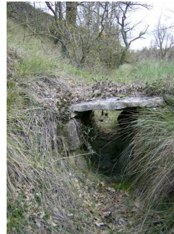
Fig. 6.1.4.4-21 Paso de camino mediante losa de piedra, acequia Moli Lluch
