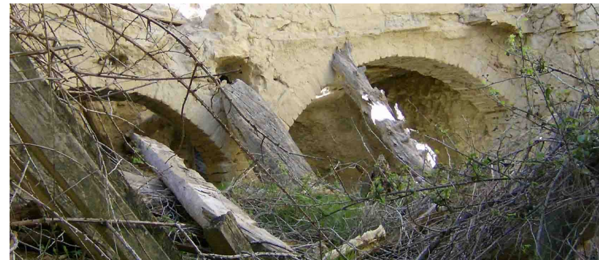
Fig. 9.4-24 Estructura formado por arcos rebajados de ladrillo cocido de arcilla. Teuleria de la Mola.
