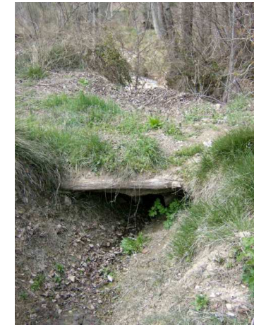
Fig. 6.1.4.4-22 Paso de camino mediante troncos, acequia Moli Gamuni
