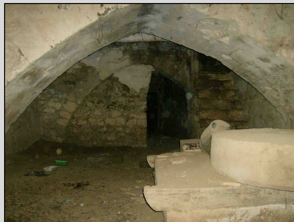
Fig. 18 Vista de los dos arcos de la sala de molienda
