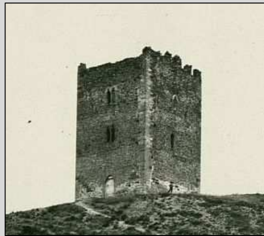
Fig. 5 Detalle Torre Grossa 1916-19. 2
