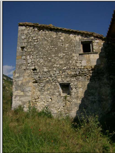
Fig. 10 Parte de la estructura más antigua, Posiblemente torreada
