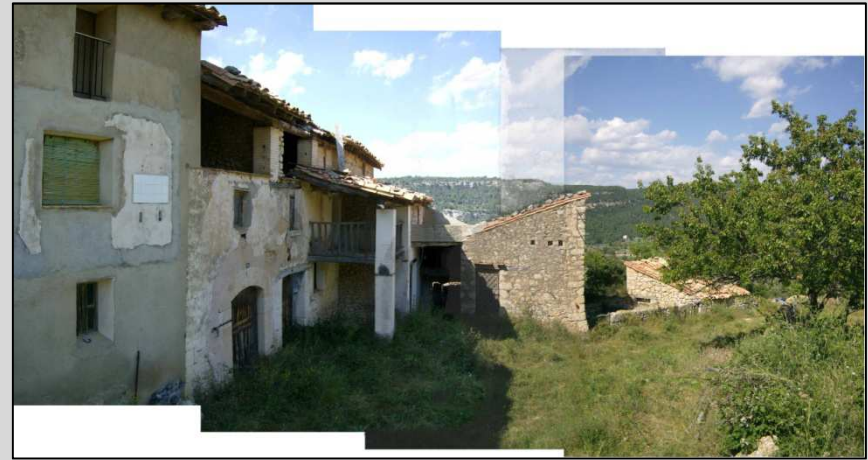
Fig. 5 Fachada Este acceso vivienda
