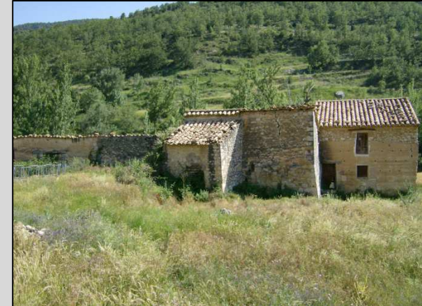
Fig. 8 Vista fachada Noreste y parte de la era
