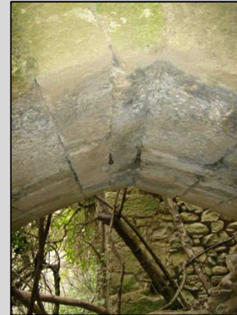
Fig. 14 Clave partida de arco Este
