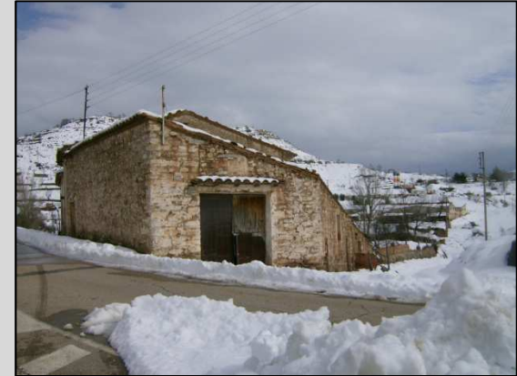
Fig. 6 Edificio de uso agrícola-ganadero
