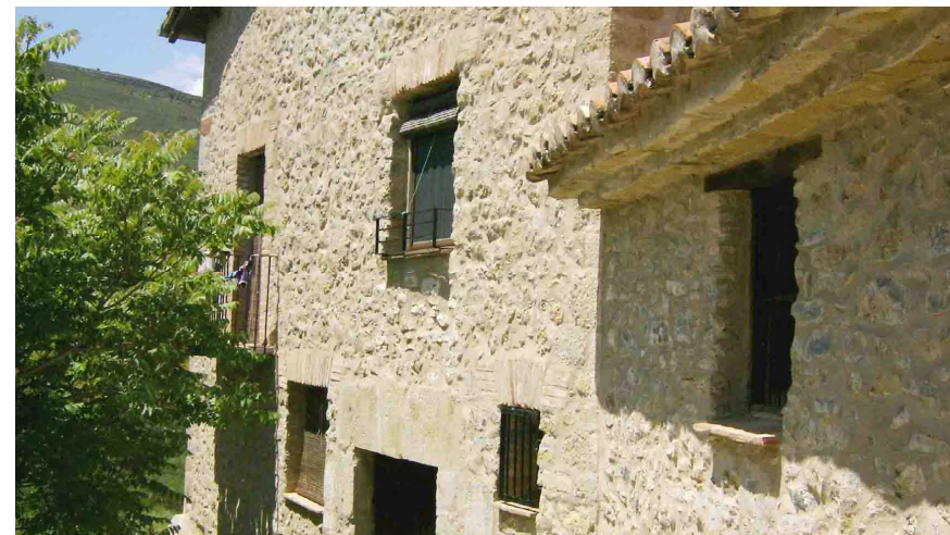
Fig. 9.4-15 Detalle Fachada Molí d'en Pi, jambas de ladrillo y dinteles a sardinel. En el inferior dintel de sillares de piedra caliza de la zona.
