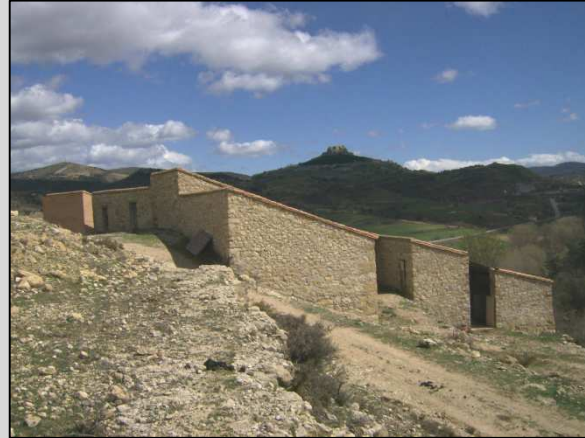
Fig. 5 Vista de la fachada Suroeste y Noroeste
