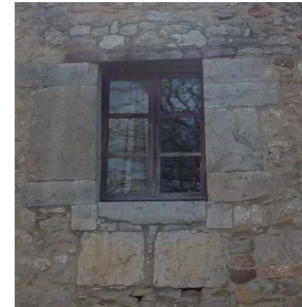
Fig. 9.4-10 Detalle de una ventana de la torre del Molí la Font
