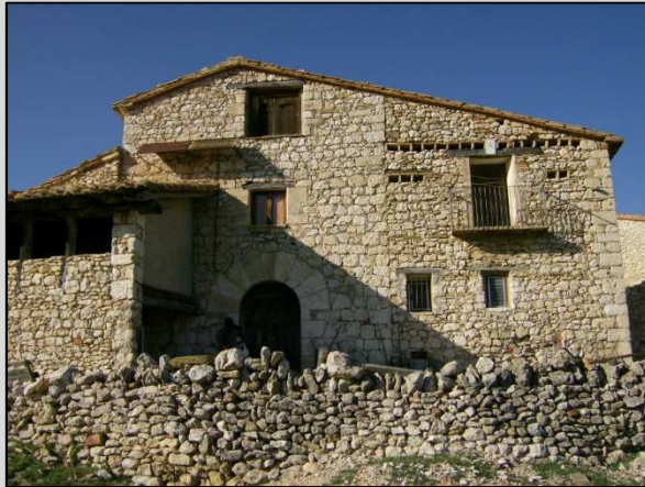
Fig. 4 Vista frontal de la fachada principal. Orientación Sur
