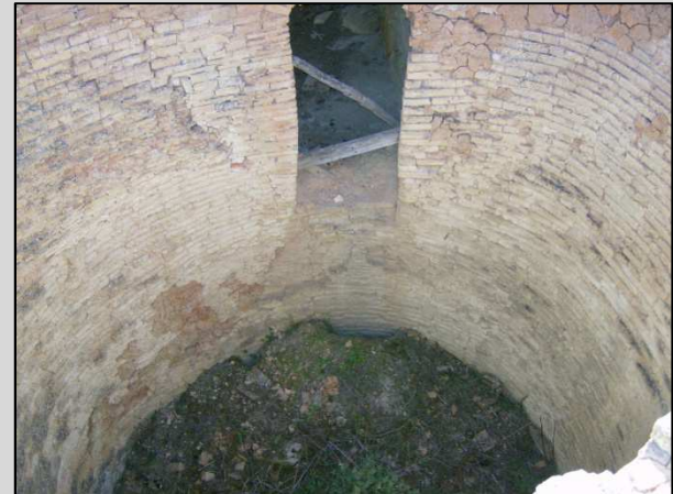
Fig. 12 Acceso para encañar el horno
