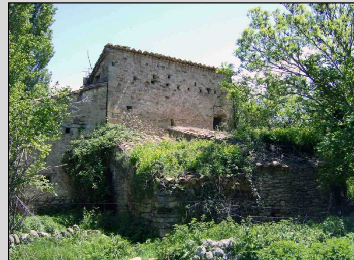
Fig. 7 Fachada Oeste y adiciones en fachada Oeste y Norte
