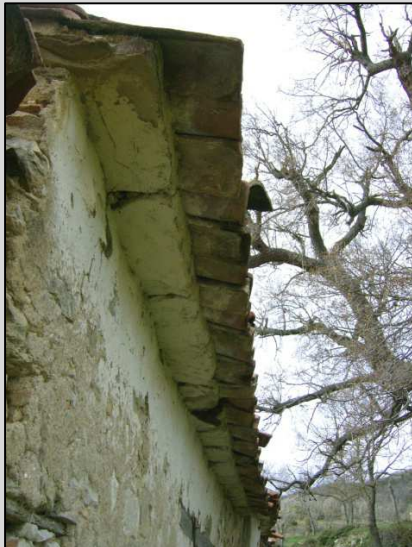
Fig. 13 Alero de losas zona de la era
