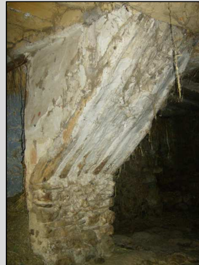
Fig. 15 Detalle corea de escalera
