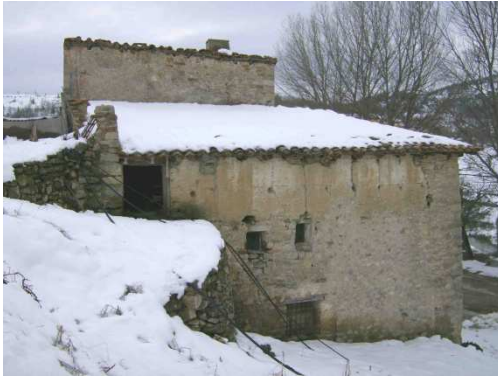
Fig. 7.1-3 Moli del Pont edificio a un agua. Tapial en las últimas hiladas
