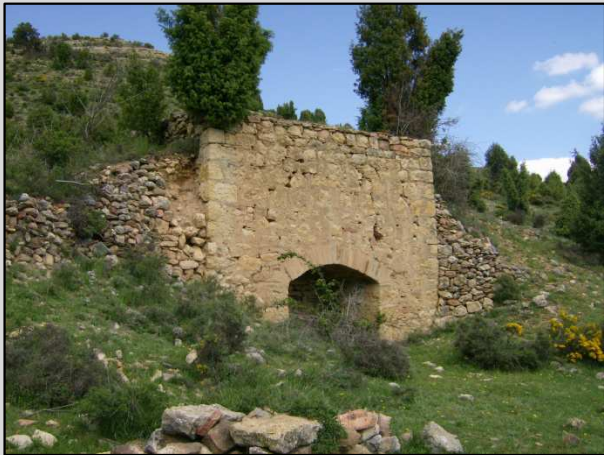
Fig. 16 Boca de la caldera
