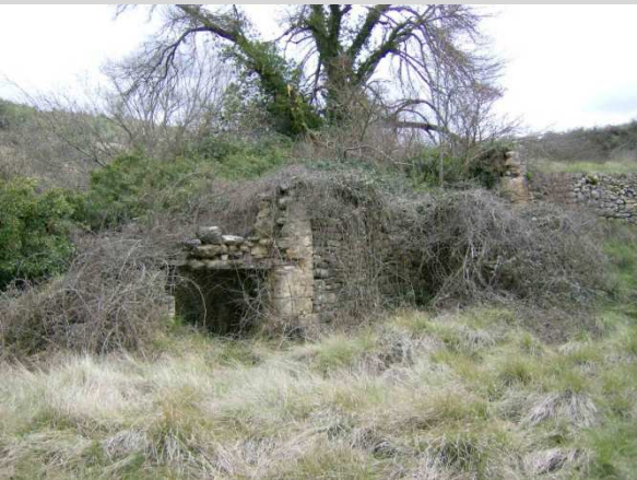
Fig. 5 Acceso Oeste al conjunto de edificios en Marzo
