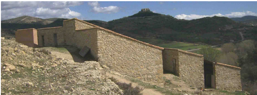
Fig. 9.4-58 Aleros posteriores y remates laterales Mas del Collet
