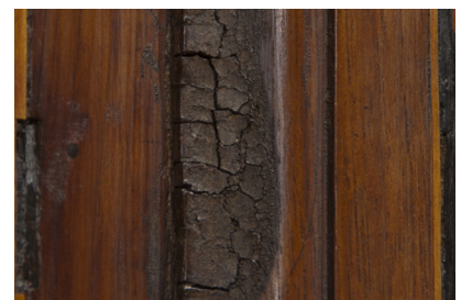
Fig. 37. Quemadura de tamaño bastante considerable (5-6 cm) (sitial alto n° 12)
