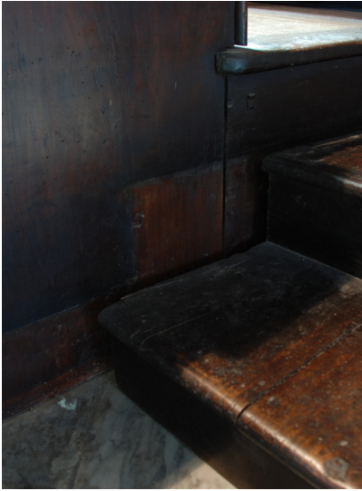
Fig. 64. Cambio tonalidad del barniz en la zona de contacto de la escalera con la plataforma. Se puede apreciar la diferencia de tono del barniz entre la parte tapada y destapada.
