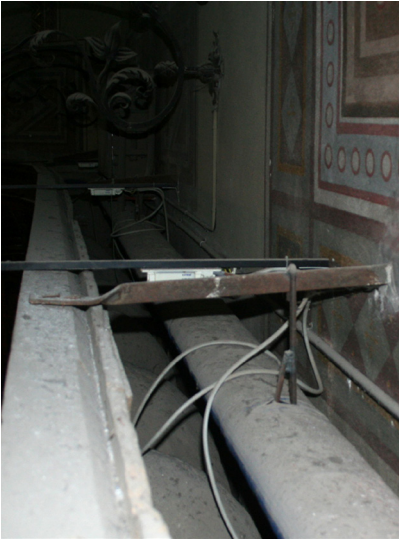
Fig. 59. Sistema de anclaje del coro
