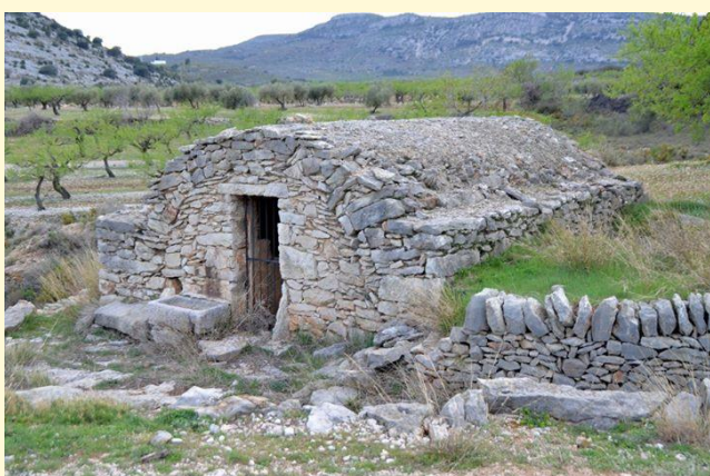
Figura 152. Imagen Pozo de agua con caseta de volta. Catí. 2013.
