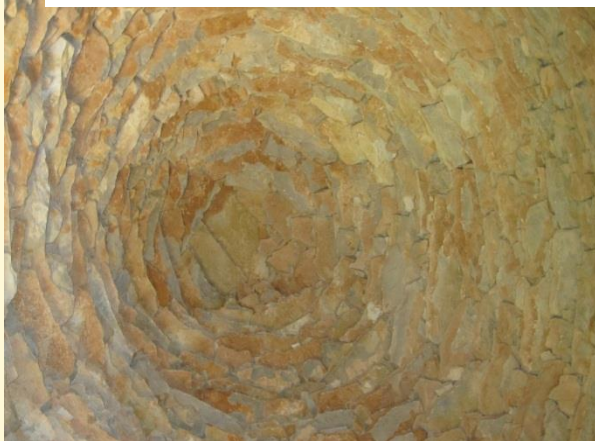
Figura 137. Interior de una cúpula de piedra en seco. 2013.
