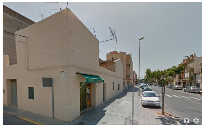
Ilustración 2.4 Fachada 1 del local en el cruce de la calle les torres con la calle Santa Bárbara. Fuente: Google Maps (Fecha de consulta: 05/10/2014)
