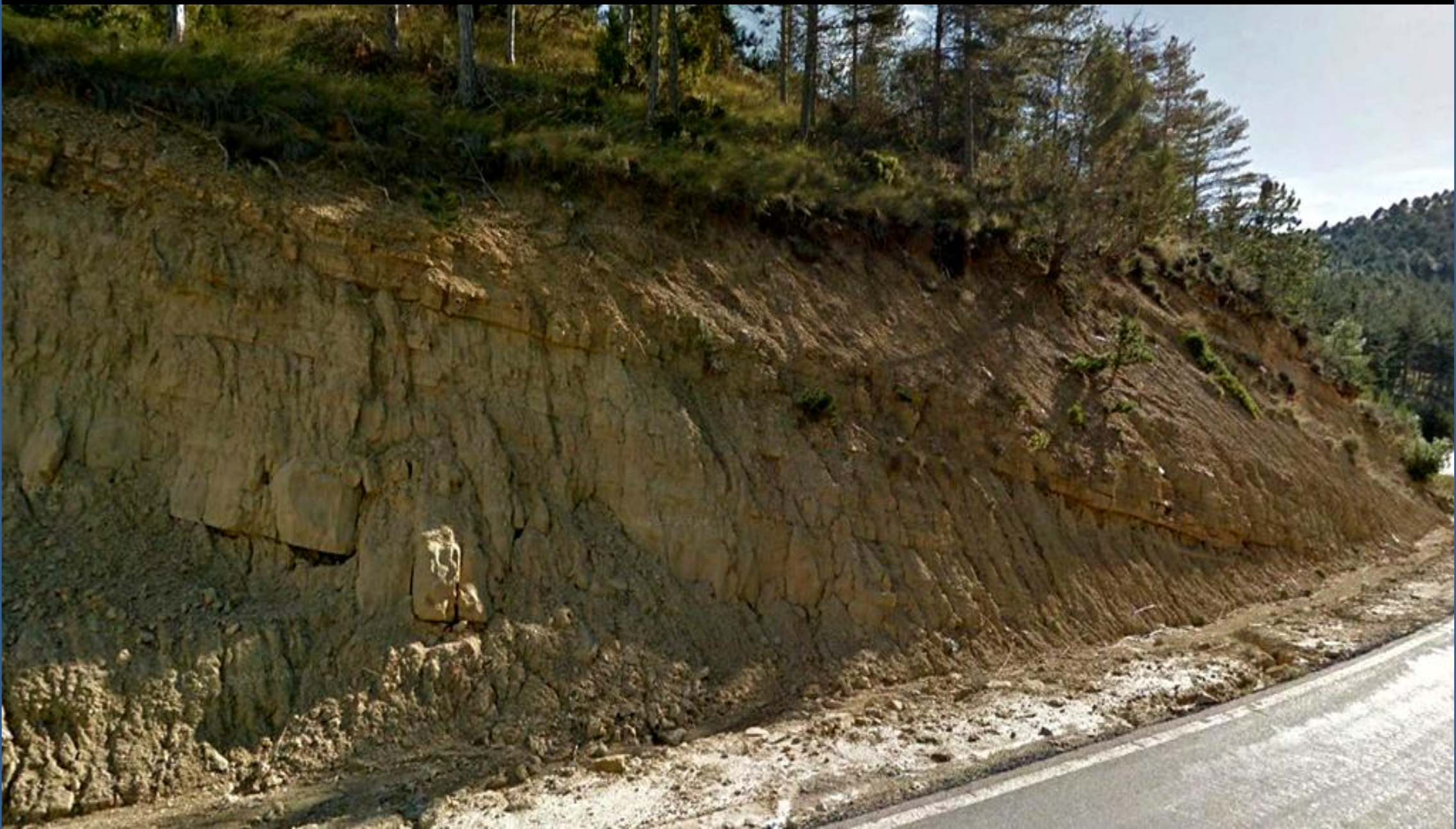
Arcillas y areniscas del Chatiense- Aquitaniense. Oligoceno-Mioceno, Terciario. Zona de Valvediana, S de Sos del Rey Católico, Zaragoza. NE Hoja de Sos.
