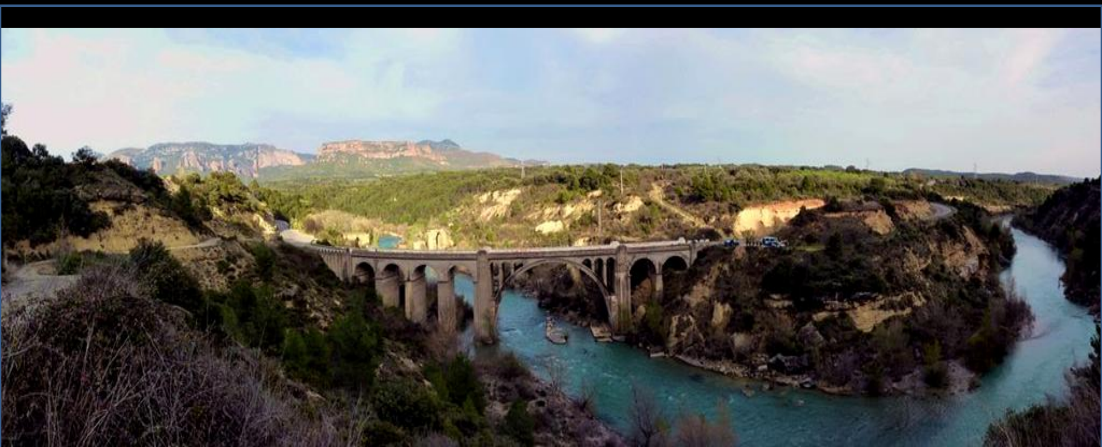
Puente sobre el Río Gállego. Murillo de Gállego, Zaragoza. Terciarios. NW Hoja de Ayerbe. (por macp-google)
