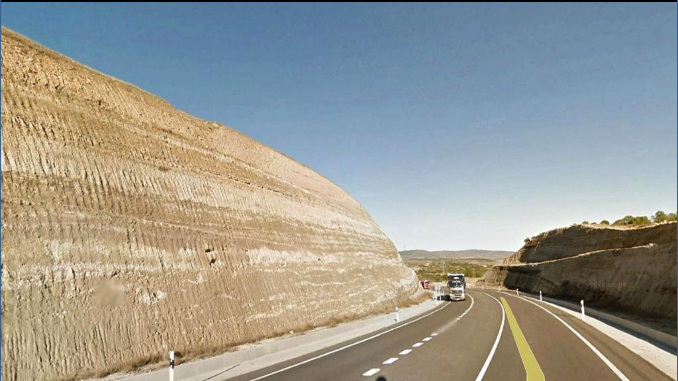
Junto a la anterior: Taludes en las arcillas, arenas y calizas arcillosas del Aquitaniense, Mioceno, Terciario. SE de Grisel, Zaragoza. SW Hoja de Tarazona de Aragón.
