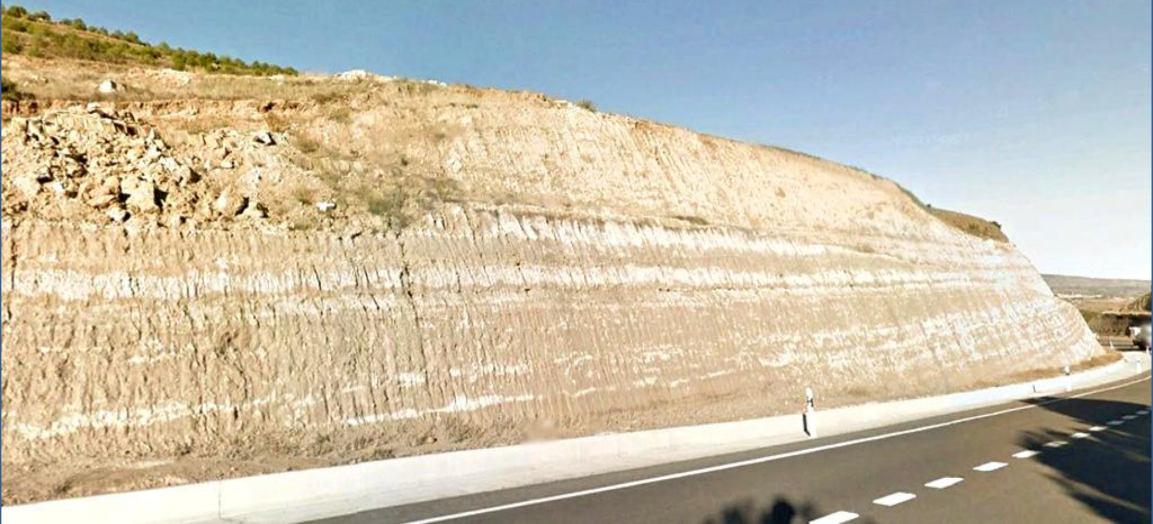
Talud en las arcillas, arenas y calizas arcillosas del Aquitaniense, Mioceno, Terciario. SE de Grisel, Zaragoza. SW Hoja de Tarazona de Aragón.
