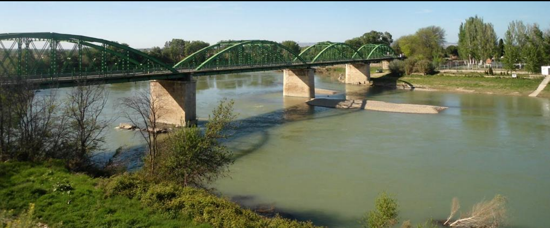
Río Ebro por Garrur, Zaragoza. La vega, Cuaternaria, y el pueblo en los yesos, arcillas y limos del Vindoboniense, Mioceno, Terciario./ Detalle del puente. SE Hoja de Tauste. (por Javier Piris/ Carles ebrenc-Google)
