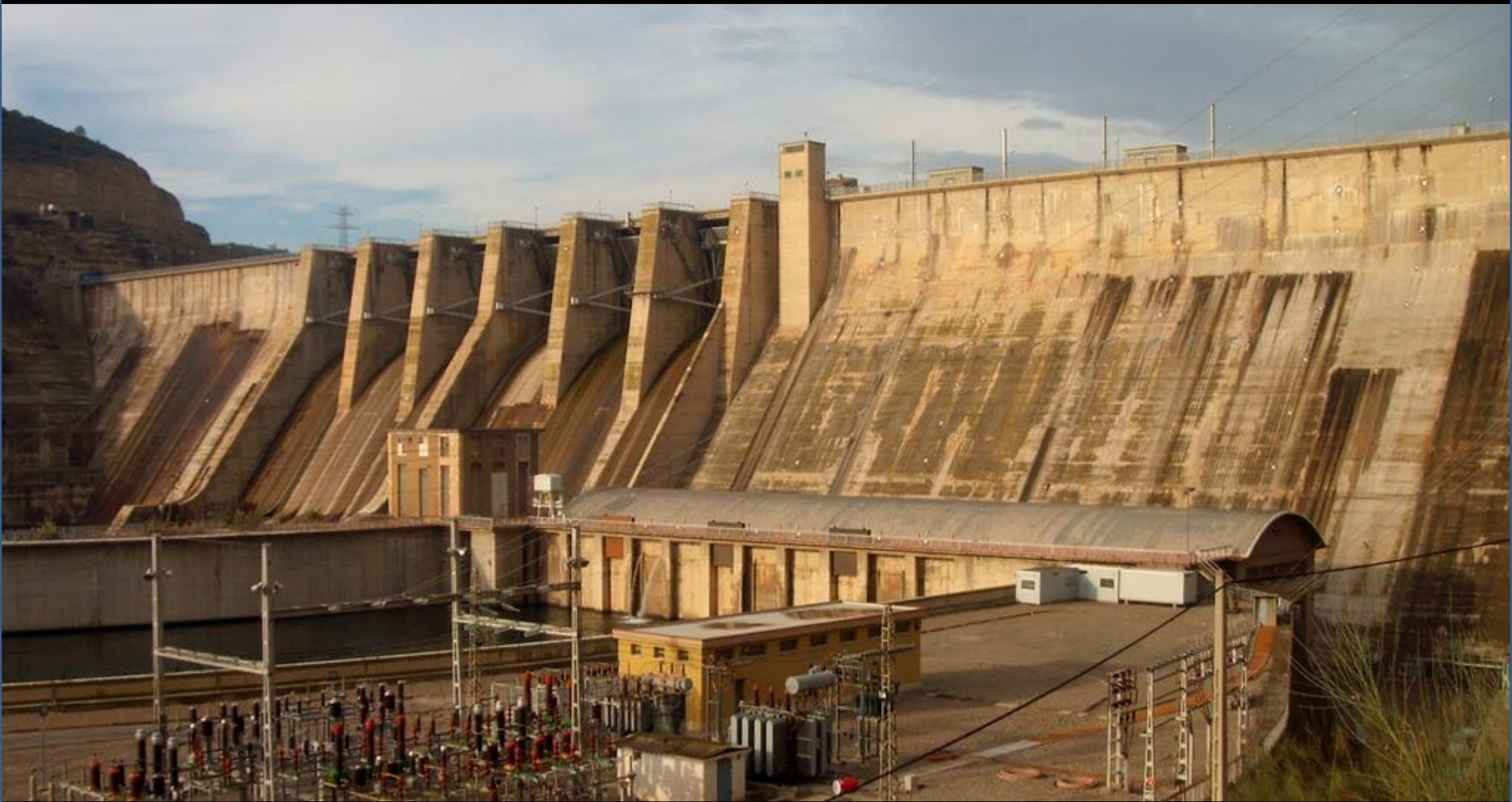
Cerrada del Embalse de Mequinenza sobre el Río Ebro. Terciarios. SW Hoja.
