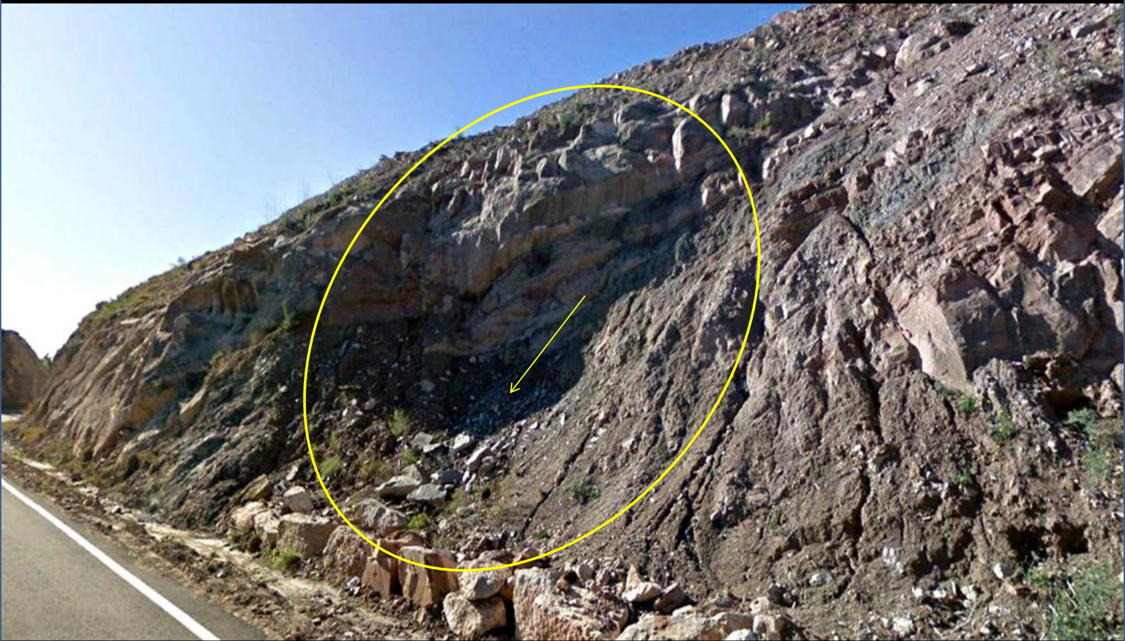
Adecuación de la carretera tras el deslizamiento en las arenas del Albiense, Cretácico Inf. NW del Embalse de La Tranquera, S de Carenas, Zaragoza. E Hoja de Ateca.
