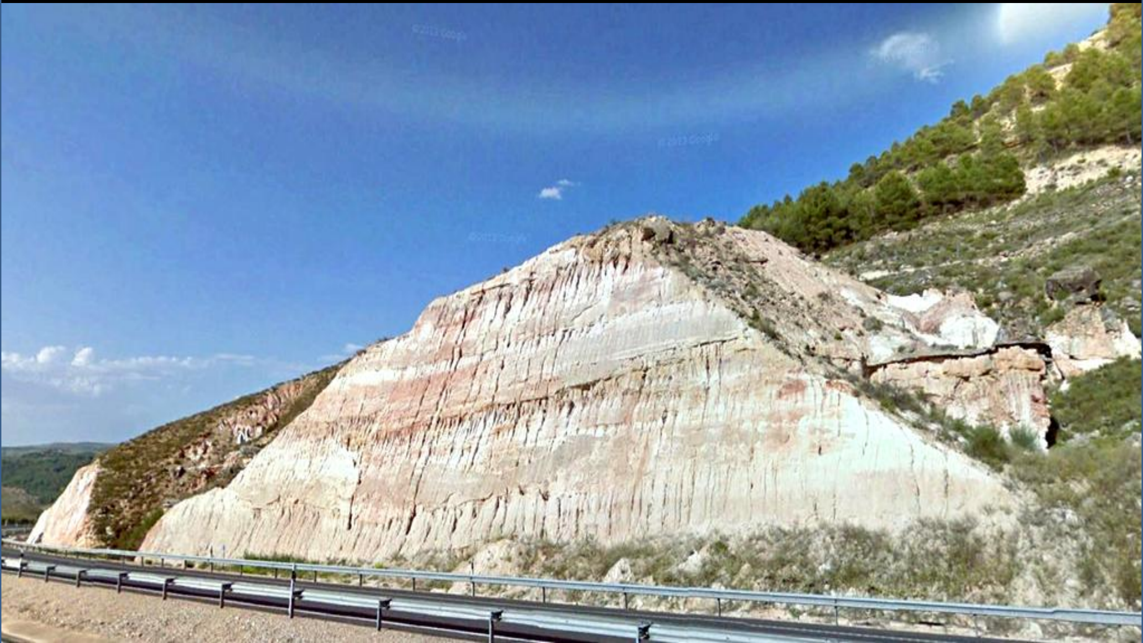
Talud en la E90. Areniscas del Cretácico Inf., al NNW de Alhama de Aragón, Zaragoza. NE Hoja.
