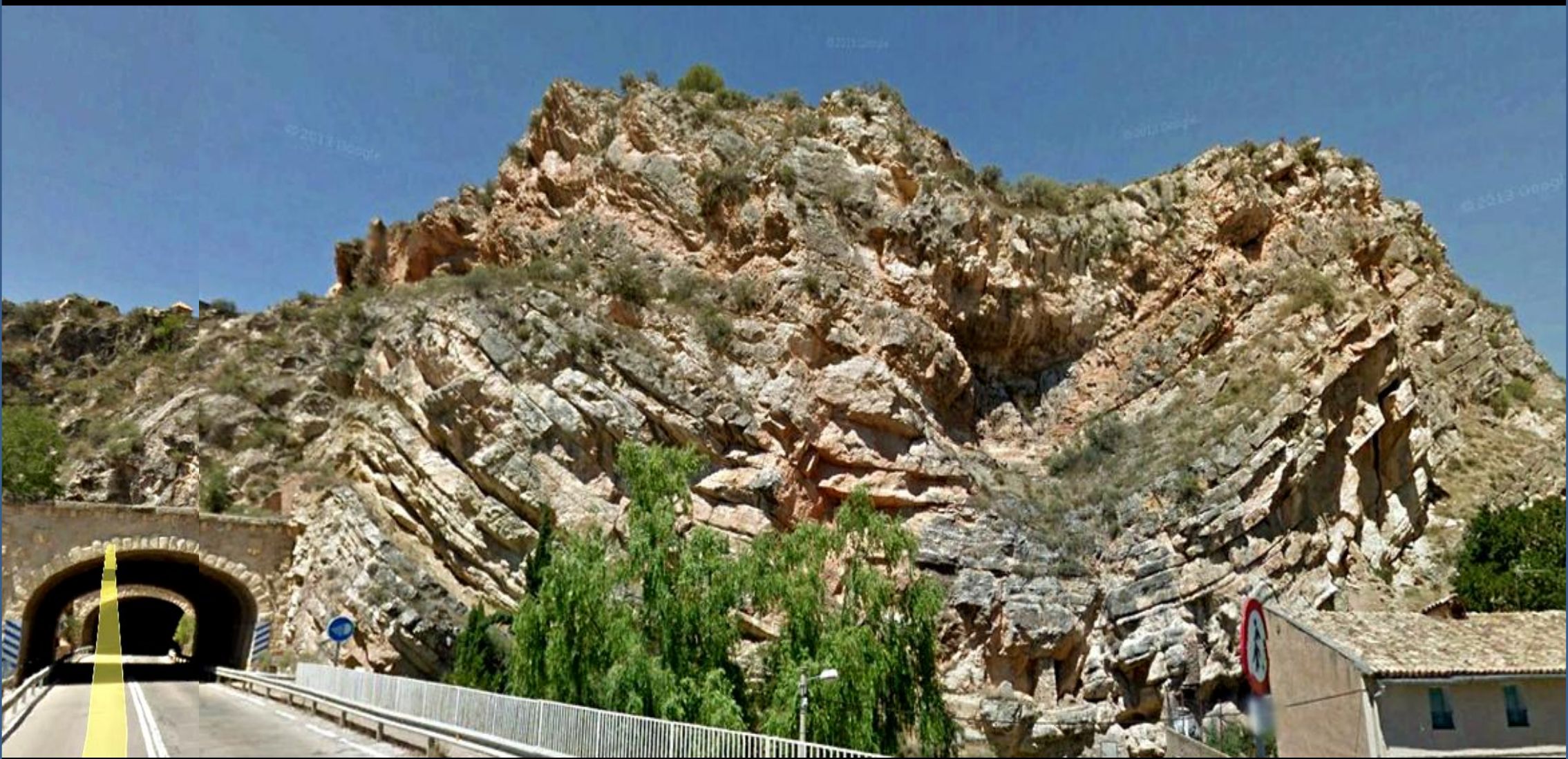
Pliegues y fallas en las calizas del Cretácico en Alhama de Aragón, Zaragoza. NE Hoja.
