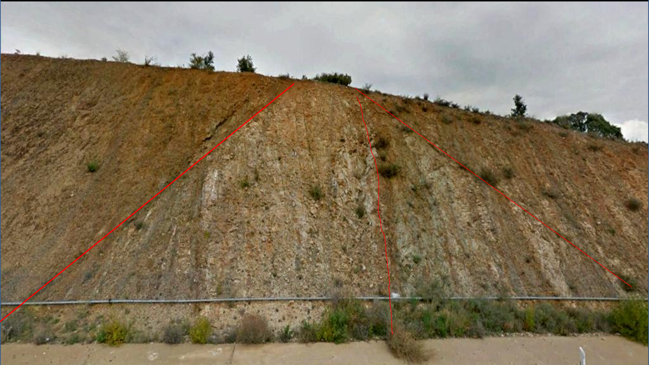
Frente a la anterior: Mallazo y bulones en las Cuarcitas y pizarras, tectonizadas, del Tremadociense, Ordovícico Inf. A23, W de Cerveruela, Zaragoza. SE Hoja de Paniza.
