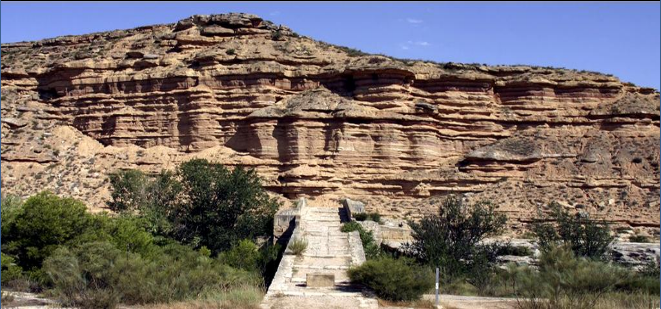
Arcillas, areniscas y calizas del Chattiense, Oligoceno, Terciario. Puente de Masatrigos sobre el Río Guadalupe. Zaragoza. SE Hoja de Caspe. (por jose roca-google)
