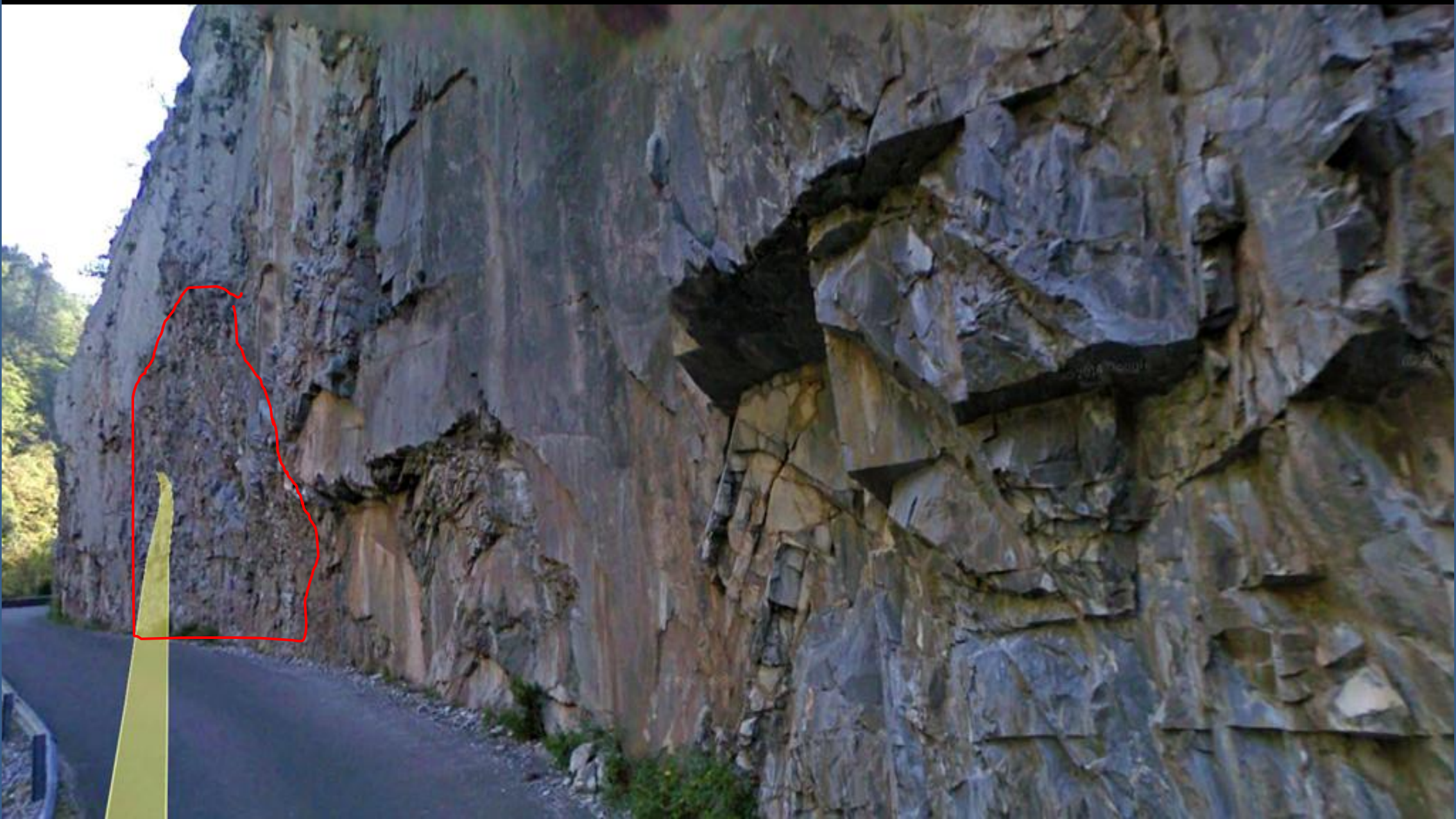
Detalle en anterior: Peligrosidad de caída de bloques en las calizas, falladas, del Paleógeno, Terciario. Boca del Infierno. NW Hoja de Ansó. Huesca.
