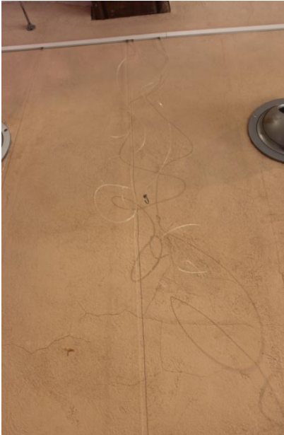
Fotografía de una de las paredes con rieles.
