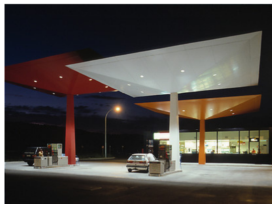
Iluminación exterior Downlights empotrados en cubiertas inclinadas
