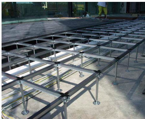
Montaje de suelo técnico
