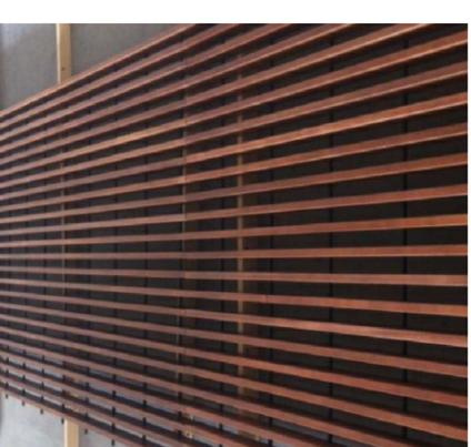
Se utilizan varios tipos de falsos techos, así pues tenemos en planta baja un de GRC y en planta primera un techo de laminas de madera. Las zonas húmedas tendrán un falso techo tipo placur o similar.
