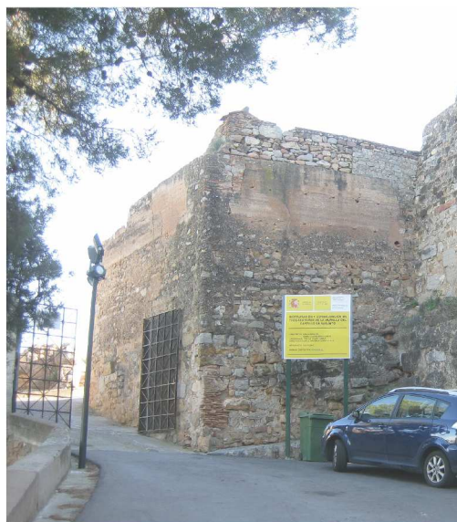
02. ACCESO PRINCIPAL A LA FORTALEZA
