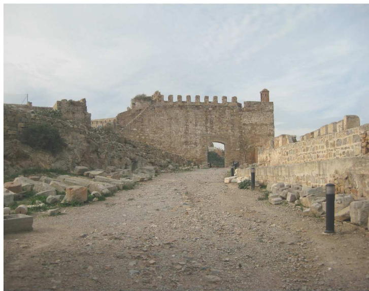
07. PUERTA DE SAN FERNANDO / 08. RAMPA DE ACCESO A LA COTA SUPERIOR
