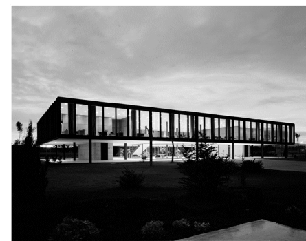
Oficinas Bacardi en Mexico - Mies Van Der Rohe
