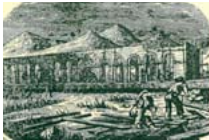
Trabajadores construyendo la estación de ferrocarril de Xàtiva que se inauguró en 1854 con el primer tren que llegó de Valencia.
