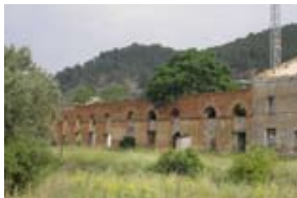
Estado ruinoso de la misma estación en 2008.
