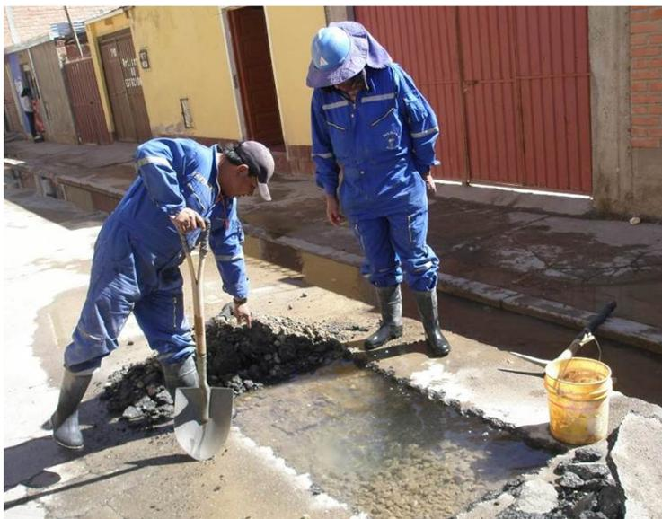
*Fotografía 2.9.1. Reparación de una fuga reportada o visible*
