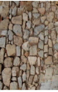
MURO RESTO HERENCIA FRANCESA.
