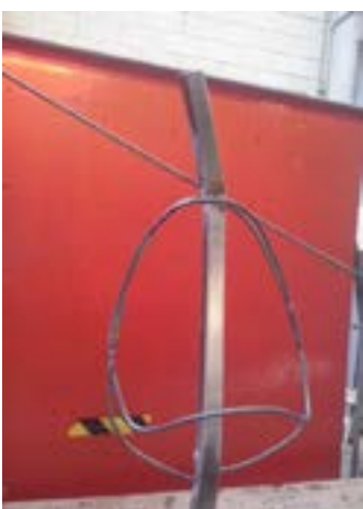
Comienzo Obra, Estructura
