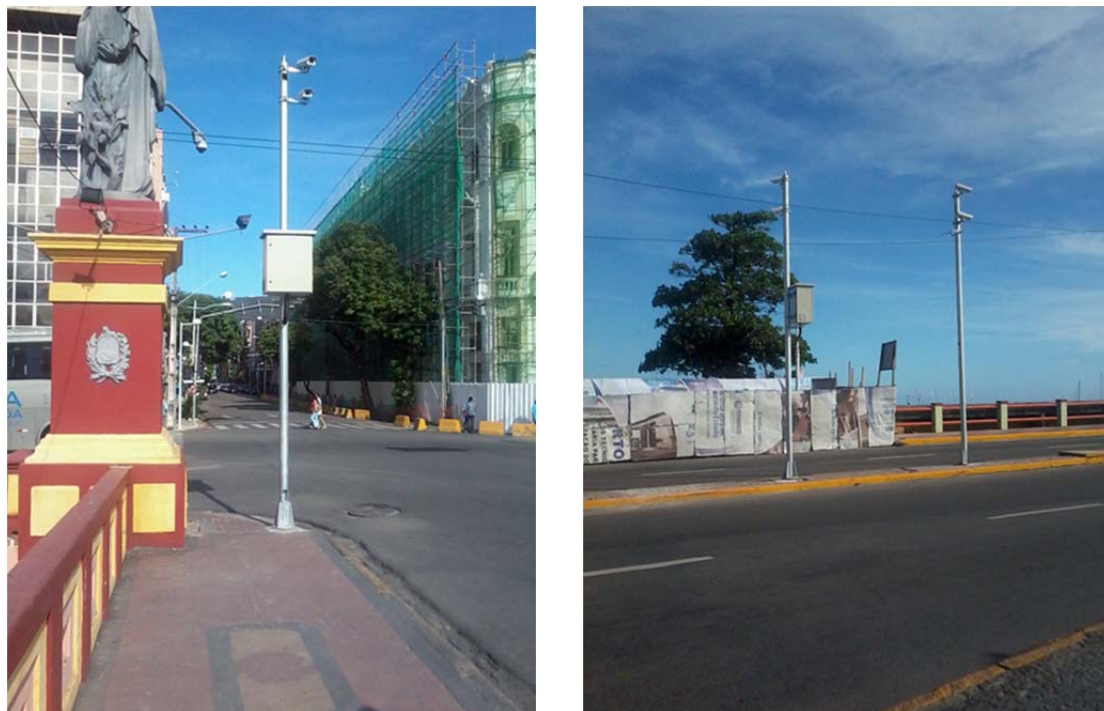
Figura 23. Ejemplo de cámaras OCR instaladas en los puentes de acceso y salida del barrio de Recife. Recife (Pernambuco)
