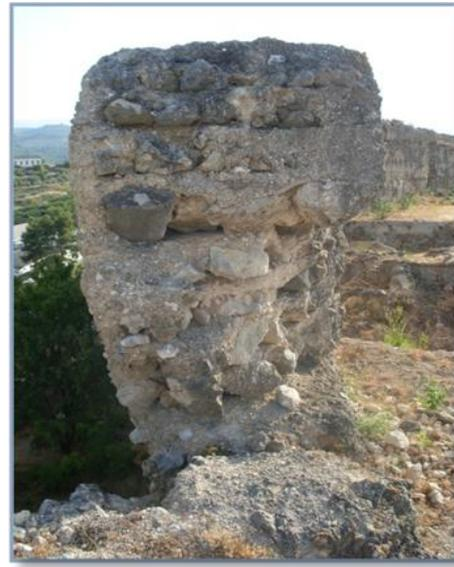
Fotografía 116 y 117. Muralla ejecutada con la técnica de tapial a calicanto y acabado superficial enlucido en el primer caso y con acabado calicostrado en el segundo. En la sección se aprecian perfectamente las tongadas de mampuestos y las de mortero rico en cal.
