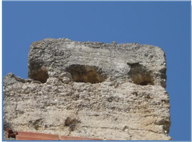
Fotografías 83 y 84. Restos del único tramo de parapeto almenado y aspillero conservado, con inclinación de aspilleras hacia el exterior y tapiadas por la cara interior.
