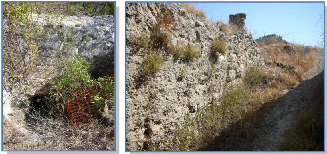
Fotografía 157 y 158. Entrada a la torre norte muy por debajo del nivel de rellenos actual. Posible cota del nivel de la plataforma castral original.
