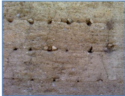
Fotografías 79 y 80. Detalle de la zona de muralla de la que se extrajo el elemento de madera. Detalle de distribución de agujas en los muros.
