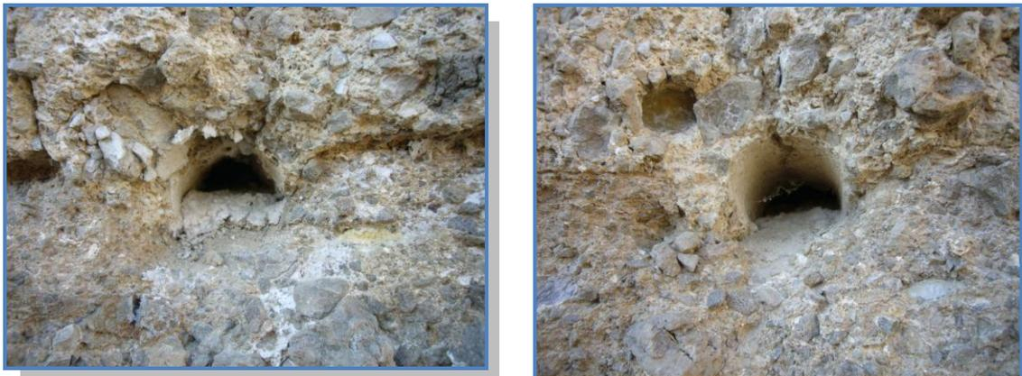
Fotografía 75 y 76. Huecos de las agujas del sistema de tapial, con presencia de sales.
