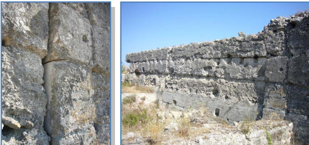
Fotografía 145 y 146. Desplome interior del muro con separación entre torre y lienzo.
