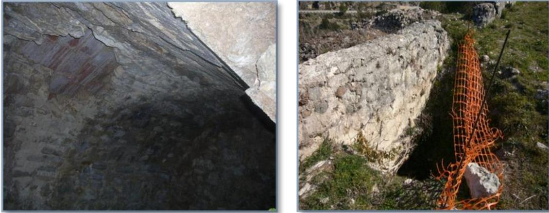
Fotografía 99. Resto de una de las únicas bóvedas de cañón que se mantienen situada en la llamada torre del homenaje. Fotografía 100. Entrada a la misma situada a un nivel inferior casi inaccesible de la torre maestra.
