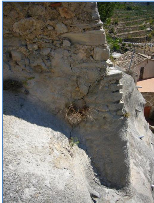
Fotografía 152 y 152. Desplome en la torre este. Ligeros movimientos diferenciales y fisuras en la torre junto a la zona de ladera gunitada.
