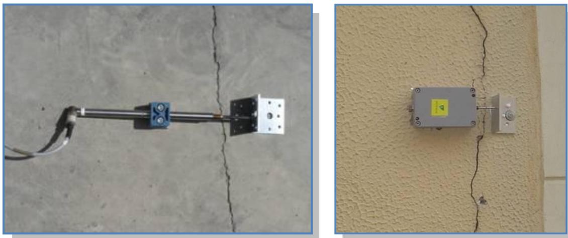
Fotografía 172 y 173. Fotografías de la empresa Intemac para el seguimiento de control de grietas.
