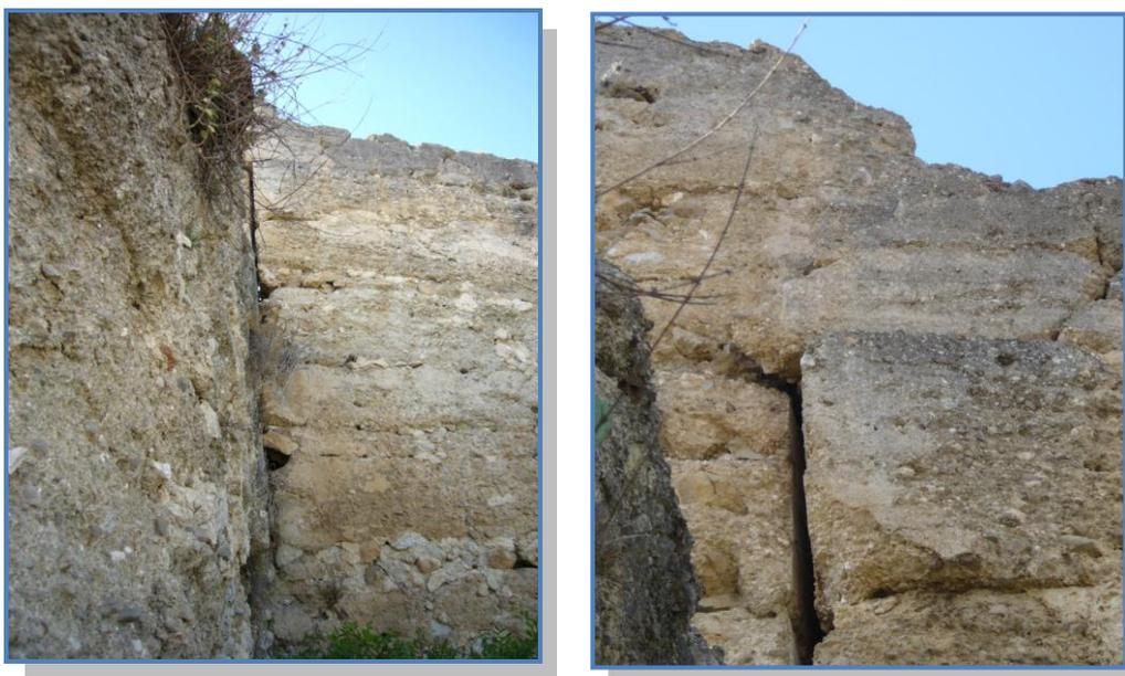
Fotografía 139 y 140. Grieta de desunión entre tapiadas. Detalle de la grieta superior de separación entre lienzo y torre.
