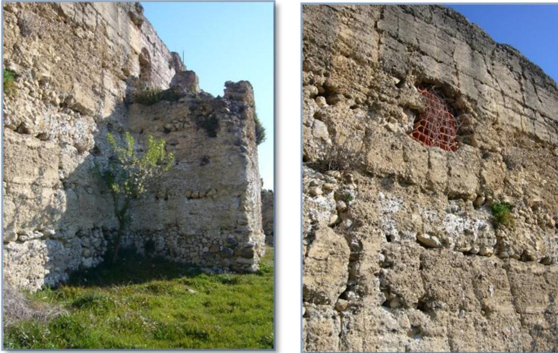
Fotografías 64 y 65. Detalle de la muralla y parte de una torre, donde se aprecia la construcción del tapial mediante cajonadas de tapia.
