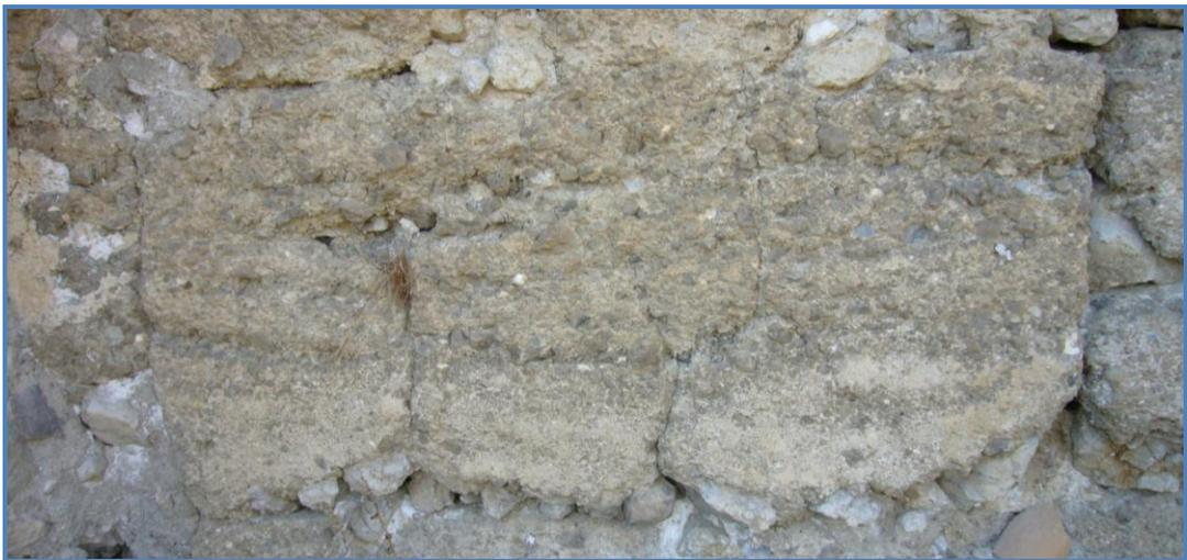
Fotografía 71. Detalle de los bordes de una tapiada completa en el exterior del recinto.
