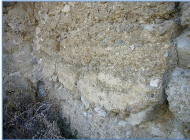
Fotografías 72 y 73. Detalle de los límites de la tapiada acotada tomados en el exterior.
