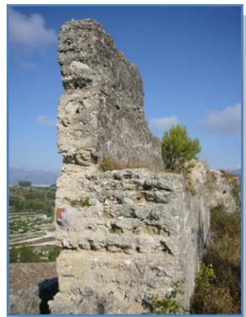
Fotografías 81 y 82. Detalle del único tramo de muralla donde se conserva la totalidad del parapeto almenado.
