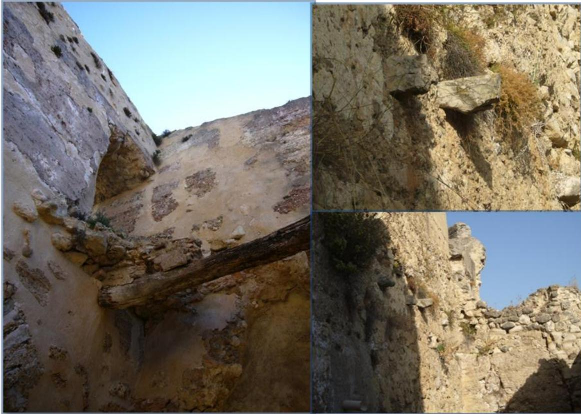
Fotografías 106, 107 y 108. Resto de una de las únicas zonas, donde quedan restos de forjado y vigería. Las siguientes fotos representan las lajas de mampostería de unión de la capa de compresión del forjado.
