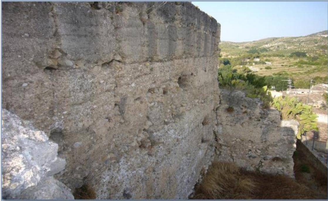
Fotografía 165. Vista lateral de la muralla sur-este, donde se aprecia, erosión y pérdida de material en la coronación, en la masa interior y en el revestimiento exterior de los muros.
