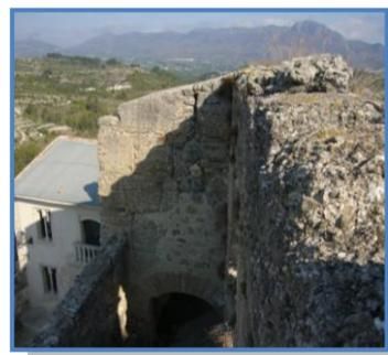
Fotografías 87 y 88. Restos de los huecos en el parapeto dejados por las huellas de almenas y aspilleras practicadas.
