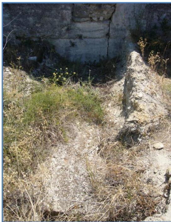
Fotografía 135 y 136. Zona de las fotografías anteriores en la actualidad, donde se observa el corrimiento de las tierras sobre las zonas excavadas y la caída de algunos muros excavados por el propio empuje del terreno.
