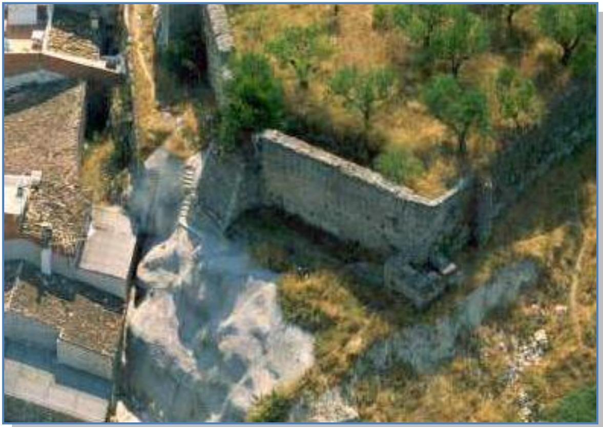
Fotografía 133. Imagen donde se ve el tramo de ladera desprendida y que motivó el encargo del estudio geotécnico.
