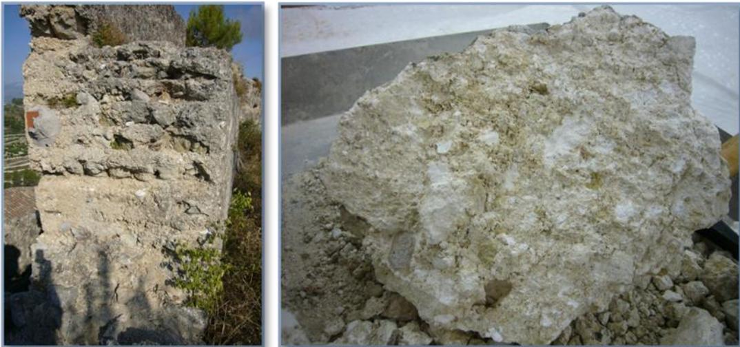
Fotografía 123 y 124. Vista de la sección de unos de los muros de tapia erosionados. Vista seccionada de la muestra para la elaboración del ensayo de granulometría donde se aprecia la gran compacidad del conjunto y la gran cantidad de nódulos de cal presentes en la mezcla.
