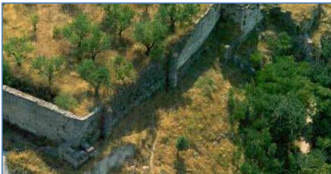
Fotografía 42. Torre caída y muro norte reconstruido y reforzado mediante contrafuertes.
