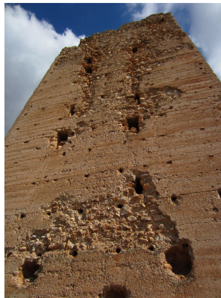
Fig. 8.38 - 8.40. Detalles de la pérdida de masa en el alzado Sur y Este.
