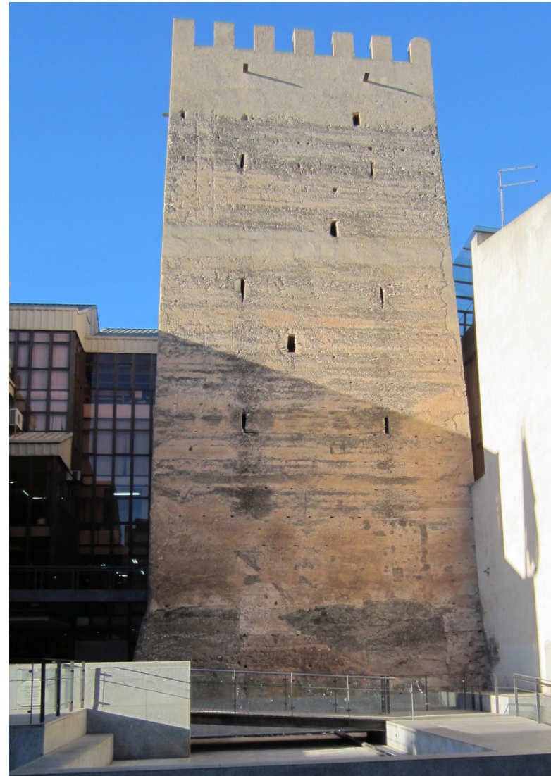
Fig. 4.111 - 4.112. Estado anterior y posterior a la intervención.
