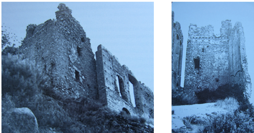
Fig. 4.144 - 4.145. Diferentes vistas del castillo de Beselga previas a la restauración.
