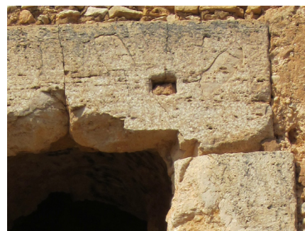
Fig. 8.7 - 8.10. Fisuras en el arco del muro diafragmático del nivel 1 y de los elementos pétreos del acceso.
