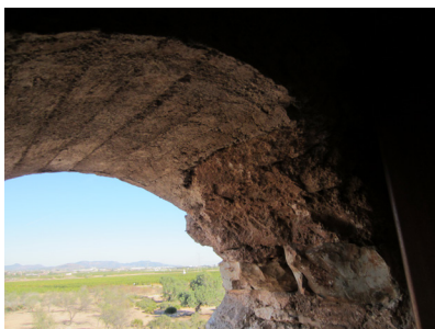
Fig. 4.205 - 4.206. Detalle de las dovelas del dintel de acceso. Acceso mediante escalera de mano metálica anclada a la torre.
