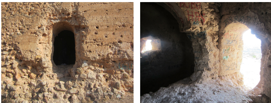
Fig. 5.14 - 5.15. Vista del acceso a la torre desde el exterior y del interior.
