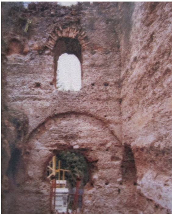
Fig. 4.116 - 4.117. Plantas de la torre (Según Vicente Torregrosa). Vista interior del estado previo, se muestra las trazas de las bóvedas.
