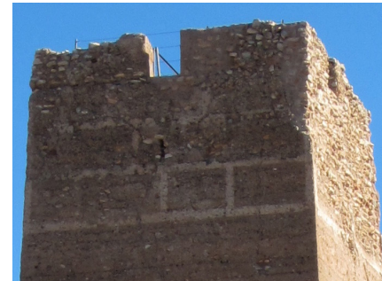
Fig. 3.24 - 3.25. Coronación torre Bofilla. Detalle almena original y reconstruida de la torre de la Plaza de Benifaió.
