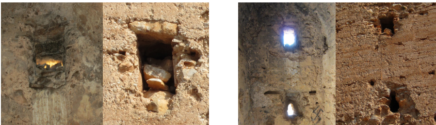
Fig. 6.90 - 6.93. Saeteras del nivel 1 en el alzado Sur
