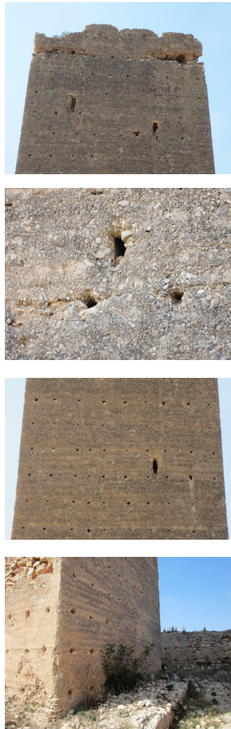
Fig. 6.17 - 6.20. Coronación fachada Norte. Detalle saetera nivel 3. Vista del nivel 2. Cimentación.
