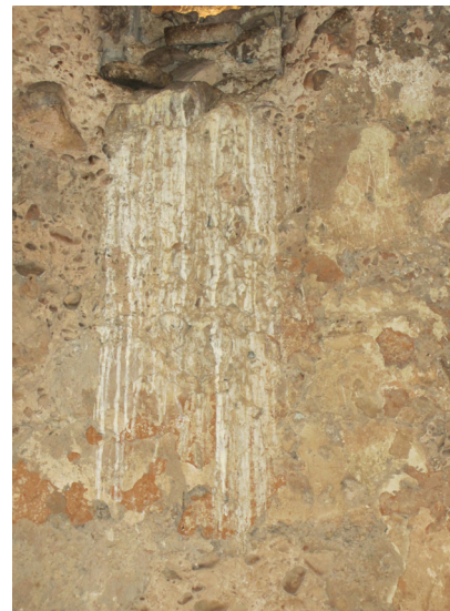
Fig. 8.32 - 8.33. Saetera intradós Sur del nivel 1. Detalle del chorretón de la saetera.
