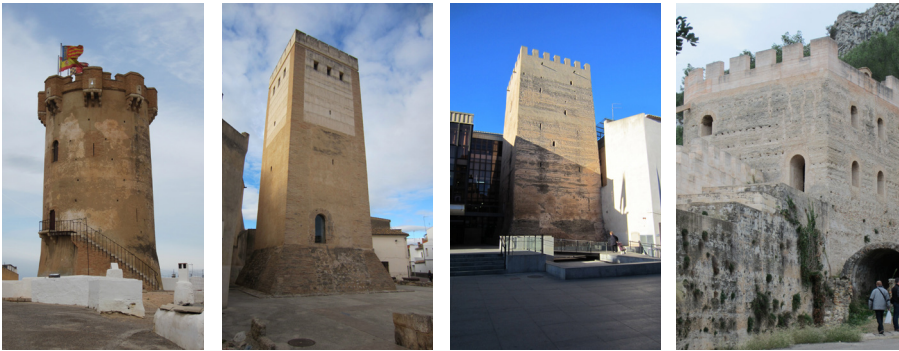
Fig. 2.1- 2.4. Torres de Paterna, Canals, Benifaió y del Sol.
