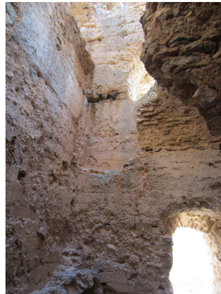
Fig. 8.60 - 8.62. Vista de los forjados 2, 3 y cubierta. Vistas de la bóveda derrumbada nivel 2.
