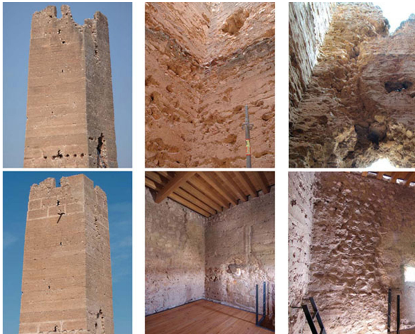
Fig. 4.207 - 4.212. Comparativa del estado anterior y actual del exterior e interior de la torre.
