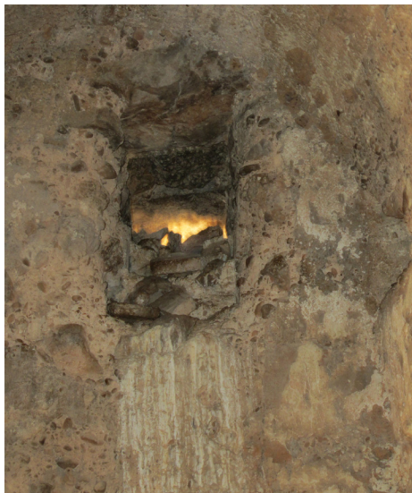
Fig. 8.32 - 8.33. Saetera intradós Sur del nivel 1. Detalle del chorretón de la saetera.
