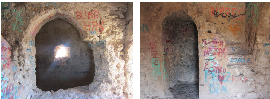
Fig. 5.16 - 5.17. Vista del muro diafragmático que separa la planta en el nivel 1. Arranque de las escaleras del nivel 1 al nivel 2.
