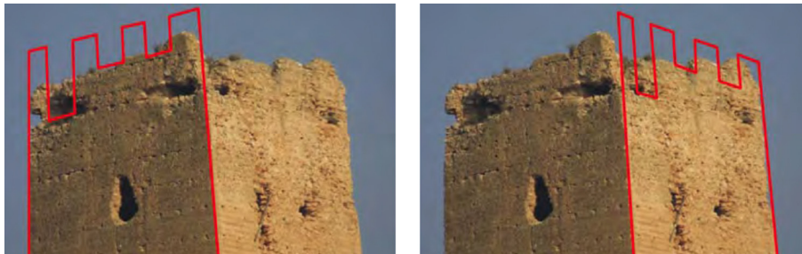
Fig. 6.94 - 6.95. Reconstrucción crestería fachada Oeste y fachada Sur. (Según Rodríguez Navarro)
