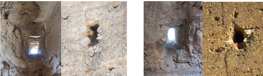
Fig. 6.86 - 6.89. Saetera intradós oeste, nivel 1. Saetera interior- exterior alzado Oeste, nivel 2.
