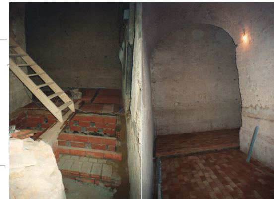
Fig. 4.100. Colocación del pavimento.
