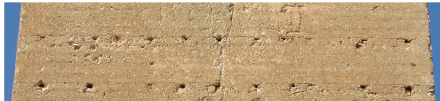
Fig. 6.48 - 6.52. Detalle de los muros de tapia en el que se observan hoy día las tapialadas, las tongadas y las marcas de las agujas. En el interior todavía quedan restos de las agujas de madera.
