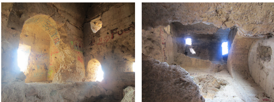
Fig. 5.18 - 5.19. Vista del nivel 2 y vista cenital de la torre desde el nivel 1.
