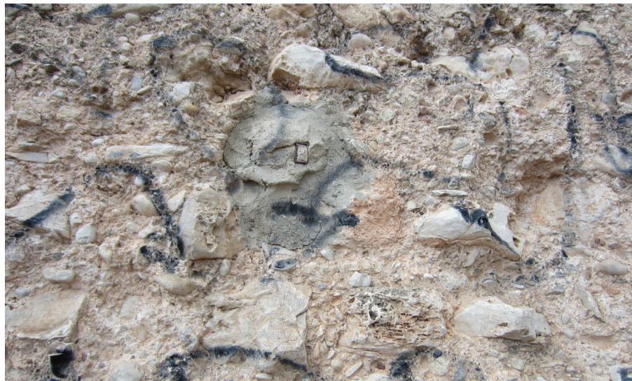
Fig. 8.28. Vista del perfil metálico incrustado en la fachada Este.
