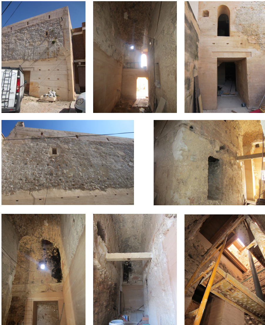
Fig. 5.25 - 5.32. Diferentes vistas exteriores e interiores de la torre de Alfarp.
