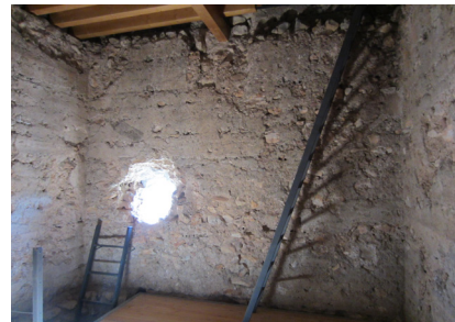
Fig. 4.203 - 4.204. Detalle del anclaje del forjado a la torre. Vista de la comunicación interior.
