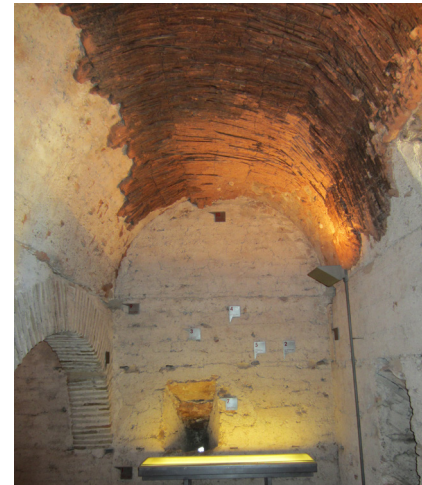
Fig. 4.107 - 4.110. Superior: Recuperación de las aspilleras y de la crestería. Inferior: Detalle de las cañas de la bóveda.
