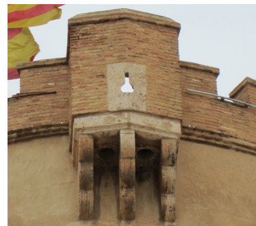
Fig. 4.22 - 4.25. Vista de la terraza, del desembarco de la escalera y detalle de los matacanes.
