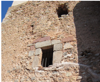
Fig. 4.157 - 4.158. Detalle del dintel del hueco del nivel 1 de la torre y de la entrada al palacio.
