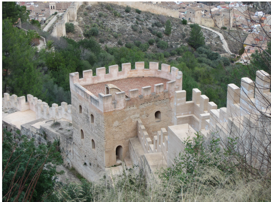
Fig. 4.113. Vista general de la torre del Sol en la actualidad.
