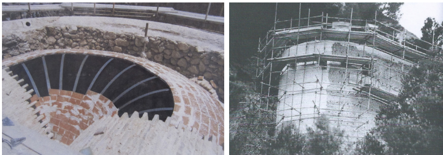
Fig. 4.119 - 4.123. Construcción de la bóveda anular. Modelización de la bóveda. (Según Vicente Torregrosa)
