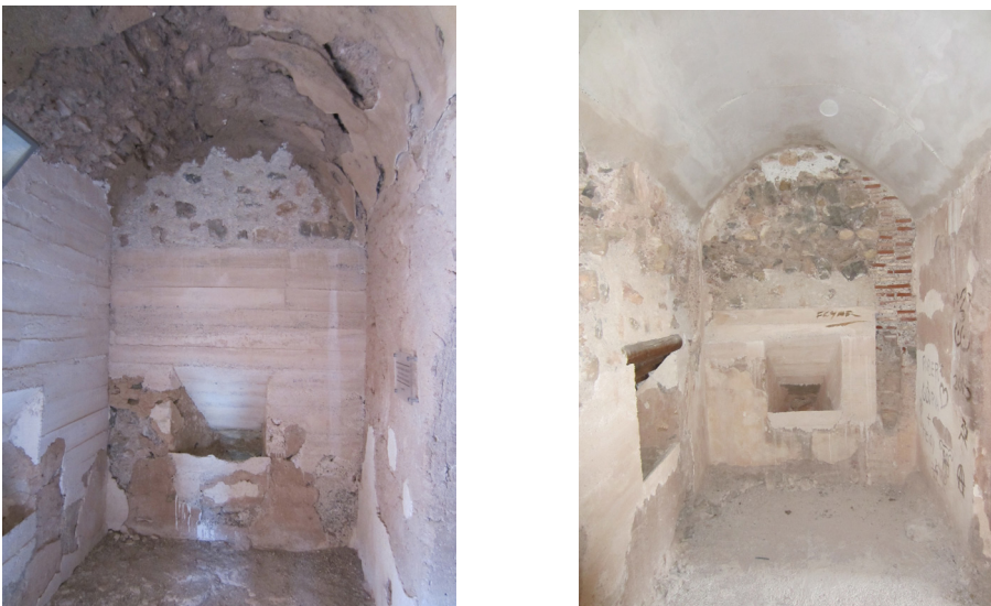
Fig. 4.163 - 4.164. Estado actual de las bóvedas de los nivel 1 y 2.
