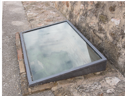
Fig. 4.47. Claraboya actual de los túneles del subsuelo de la plaza.
