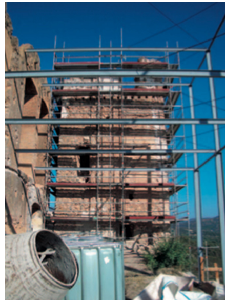
Fig. 4.146 - 4.148. Estado previo de la torre y vistas de la torre con los andamios colocados para su intervención.
