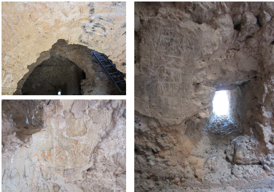
Fig. 8.25 - 8.27. Rascaduras del hueco de acceso y del interior del muro en el nivel 2.
