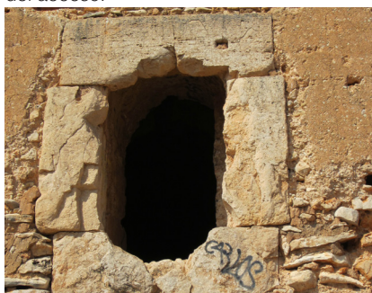
Fig. 8.7 - 8.10. Fisuras en el arco del muro diafragmático del nivel 1 y de los elementos pétreos del acceso.
