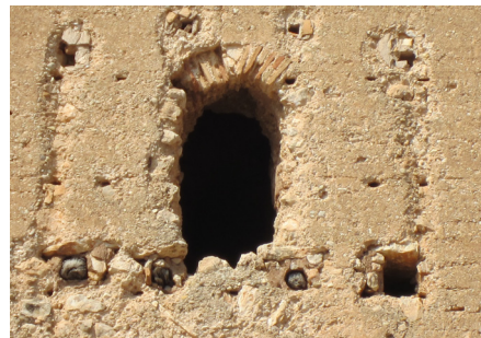
Fig. 3.20 - 3.21. Matacán situado encima del acceso de la torre de Montroi y de la torre Alédúa.
