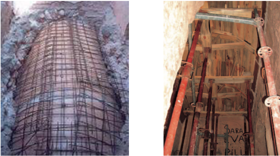
Fig. 4.161 - 4.162. Restauración y recuperación de las bóvedas.
