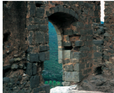
Fig. 4.157 - 4.158. Detalle del dintel del hueco del nivel 1 de la torre y de la entrada al palacio.
