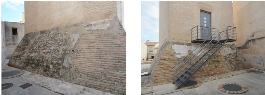
Fig. 4.56 - 4.57. Talud de cimentación actual. Escalera de acceso a la Torre.
