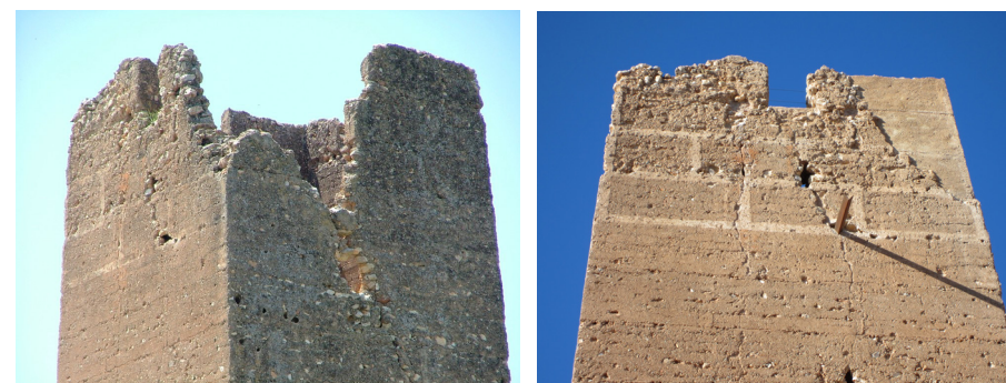
Fig. 4.198 - 4.199. Comparativa del relleno de la esquina de la torre antes y después de la restauración.
