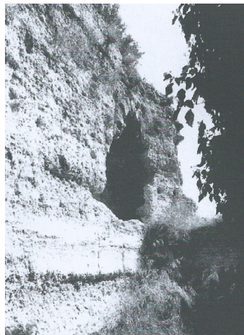
Fig. 4.114 - 4.115. Estado inicial con la bóveda derrumbada. Vista del alzado Sur antes de la restauración.
