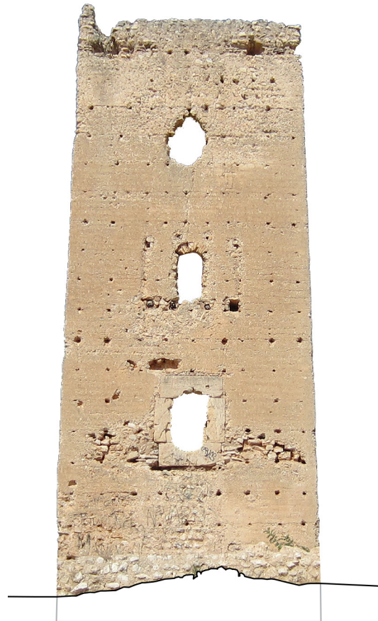
Fig. 6.16. Levantamiento ortofotogramétrico del alzado Este. (Elaboración propia)
