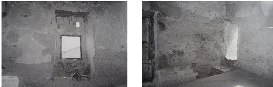
Fig. 4.41 - 4.42. Hueco del nivel 2 del muro Sureste con festejadores. Desembarco de la escalera en el nivel 2 y puerta de salida a la terraza de la vivienda adosada.
