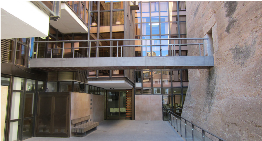
Re-urbanización de la plaza en que se encontraba la torre.
