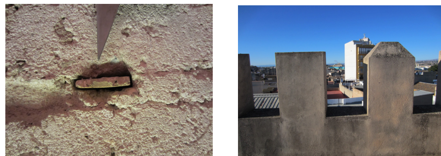
Fig. 5.53 - 5.54. Restos de madera de las agujas. Detalle de la reconstrucción de las almenas, de las originales solo quedaban siete.
