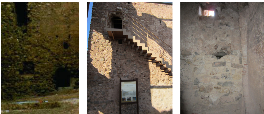
Fig. 4.166 - 4.168. De izquierda a derecha: Estado anterior del acceso. Acceso a la torre por el nivel 1. Vista interior actual del hueco cegado del nivel 0.
