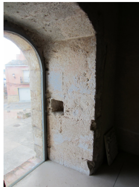
Fig. 4.69 - 4.70 .Saetera anterior a la restauración, en el muro noroeste del nivel 2. Saetera restaurada del nivel 2, protegida por una lámina de vidrio.
