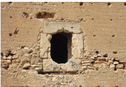
Fig. 8.38 - 8.40. Detalles de la pérdida de masa en el alzado Sur y Este.
