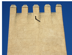
Fig. 5.69 - 5.71. Detalle del enfoscado de la tapia, coronación de la torre con la crestería recuperada y acceso original en el nivel 1.
