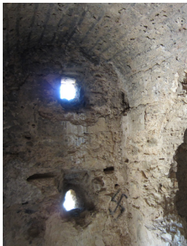
Fig. 6.34 - 6.36. Vista del muro diafragmático que separa la planta. Primer cuerpo abovedado. Segundo cuerpo abovedado.
