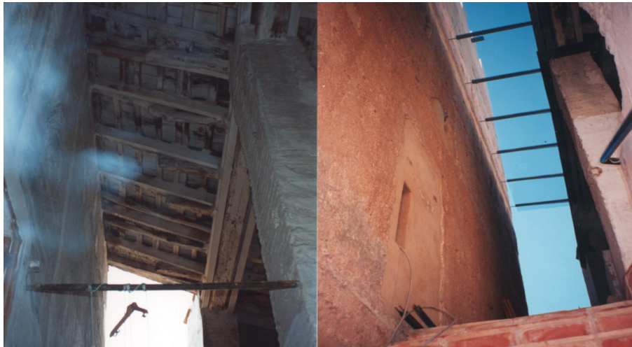
Fig. 4.101. Estado previo y estado actual del encuentro de la casa palacio y la torre.
