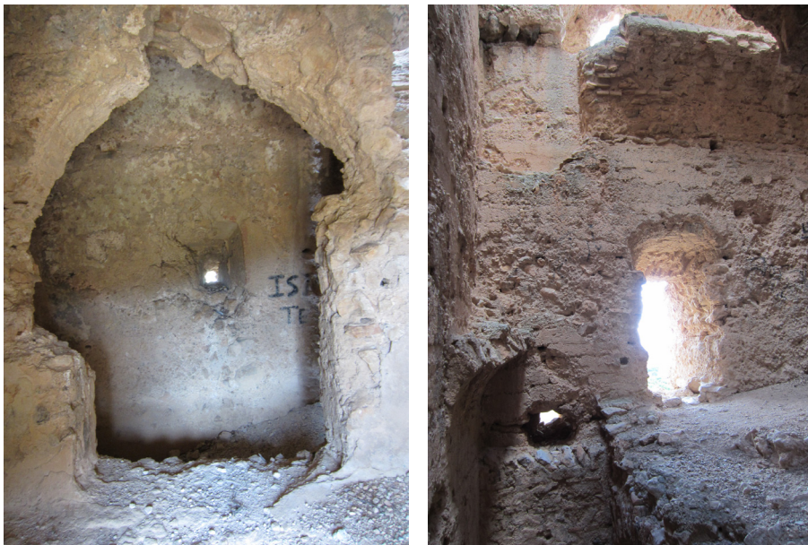
Fig. 8.58 - 8.59. Vista interior del nivel 1 y 2 .
