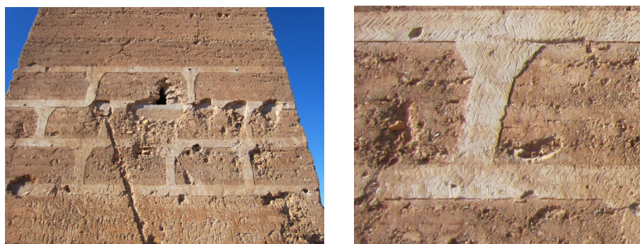
Fig. 4.196- 4.197. Detalle del sellado de las bandas decorativas.
