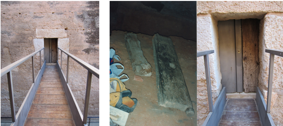
Fig. 4.103 - 4.106. Acceso a la torre desde el Ayuntamiento. Conserva parte de la puerta original.
