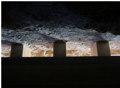
Fig. 4.203 - 4.204. Detalle del anclaje del forjado a la torre. Vista de la comunicación interior.
