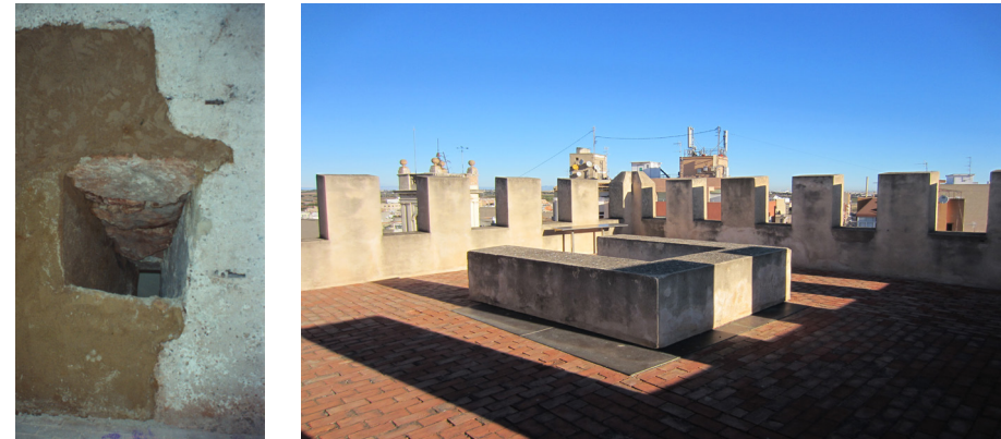
Fig. 4.107 - 4.110. Superior: Recuperación de las aspilleras y de la crestería. Inferior: Detalle de las cañas de la bóveda.
