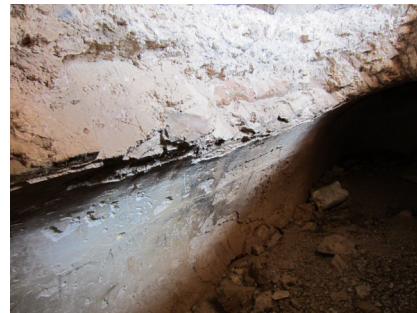
Fig. 8.65 - 8.67. Vista de los escombros depositados en el nivel 0. Derrumbe del nivel 1. Bóveda del aljibe
