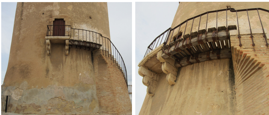
Fig. 4.9 - 4.10. Vista del acceso y de la escalera.
