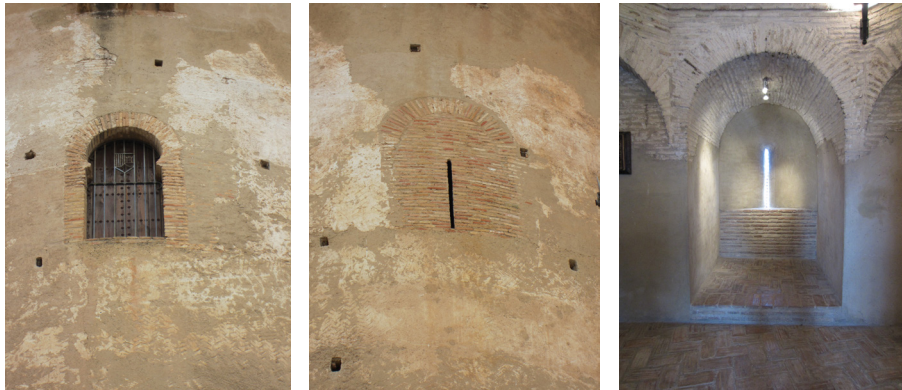
Fig. 4.11 - 4.13. Vistas exteriores e interiores de los huecos de la torre.
