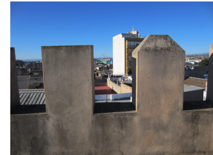
Fig. 3.24 - 3.25. Coronación torre Bofilla. Detalle almena original y reconstruida de la torre de la Plaza de Benifaió.
