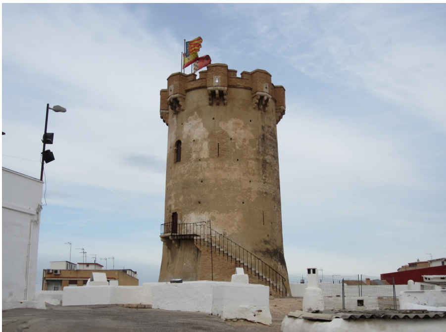
Fig. 4.1. Vista actual de la torre de Paterna.
