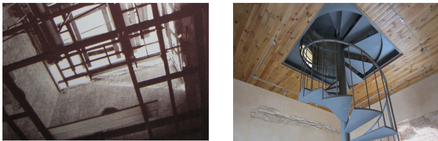
Fig. 4.58 - 4.59. Construcción de los forjados de la torre. Vista actual de los forjados.
