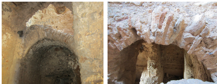
Fig. 6.65 - 6.66. Detalle de la bóveda de la escalera del nivel 1 al nivel 2.
