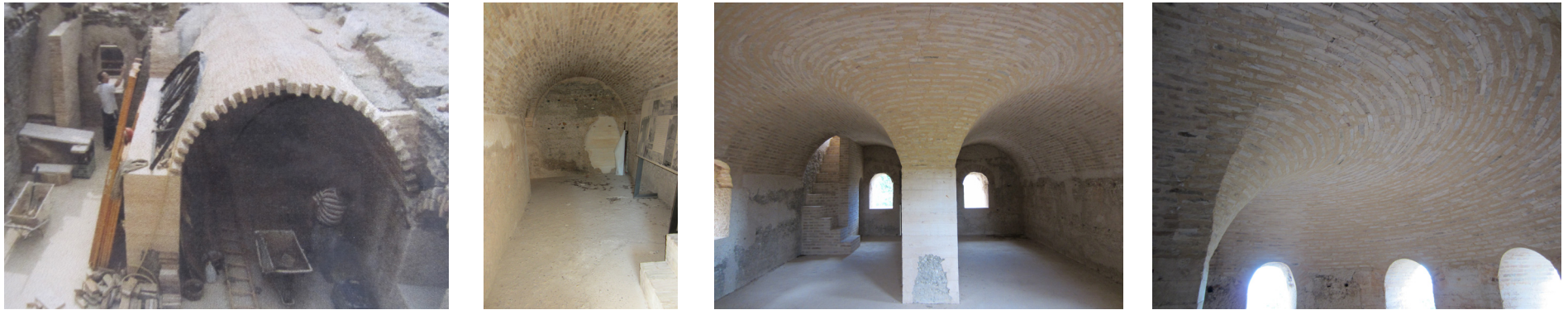
Fig. 4.124 - 4.127. Construcción de una de las bóvedas del nivel inferior y vista actual de la bóveda. Vista de la bóveda anular del nivel superior. Detalle de la bóveda.
