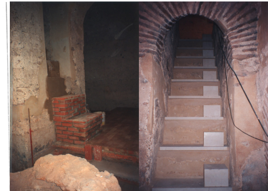
Fig. 4.99. Proceso de intervención de la comunicación vertical.
