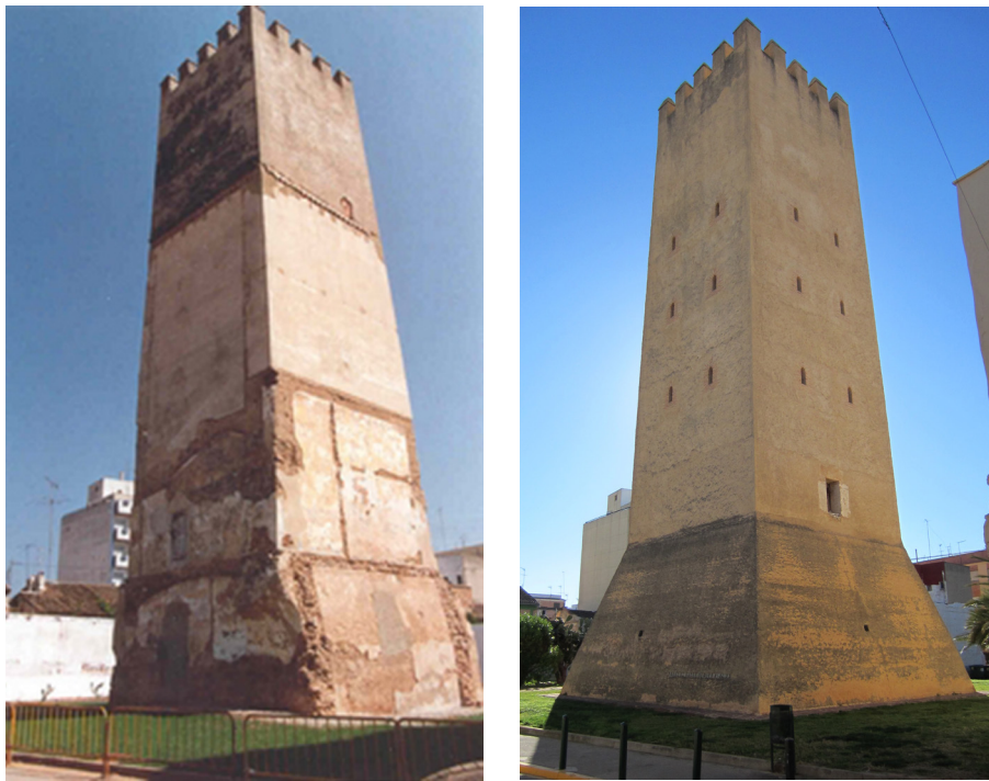
Fig. 5.62 - 5.63. Estado anterior y posterior a la intervención de la torre Racef.
