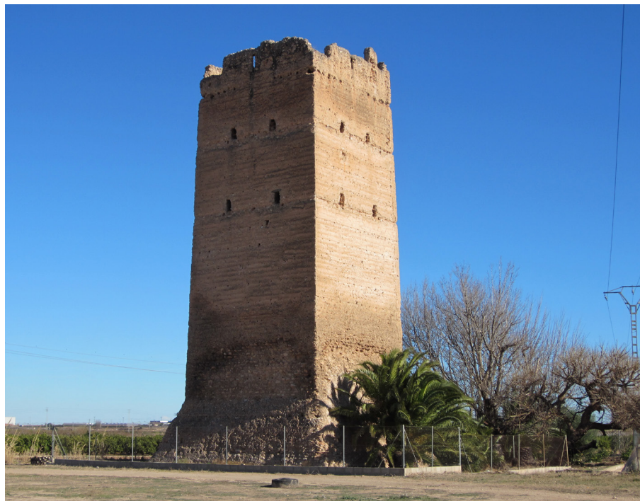
Fig. 5.33. Panorámica de la torre Muza.
