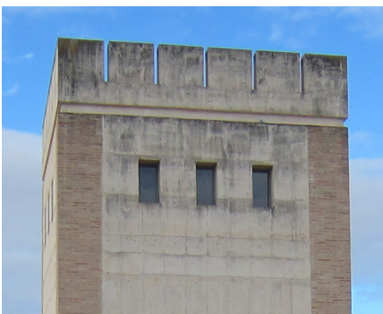
Fig. 4.78 - 4.79. Vista de la coronación, con los huecos del último nivel y el re-almenado.
