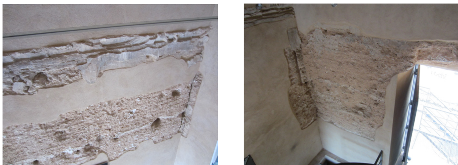
Fig. 4.60 - 4.61. Huellas de los forjados primitivos en el nivel 1. Restos de marcas de la tapia en el nivel 1.
