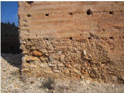
Fig. 6.44 - 6.45. Cimentación en el alzado Sur.
