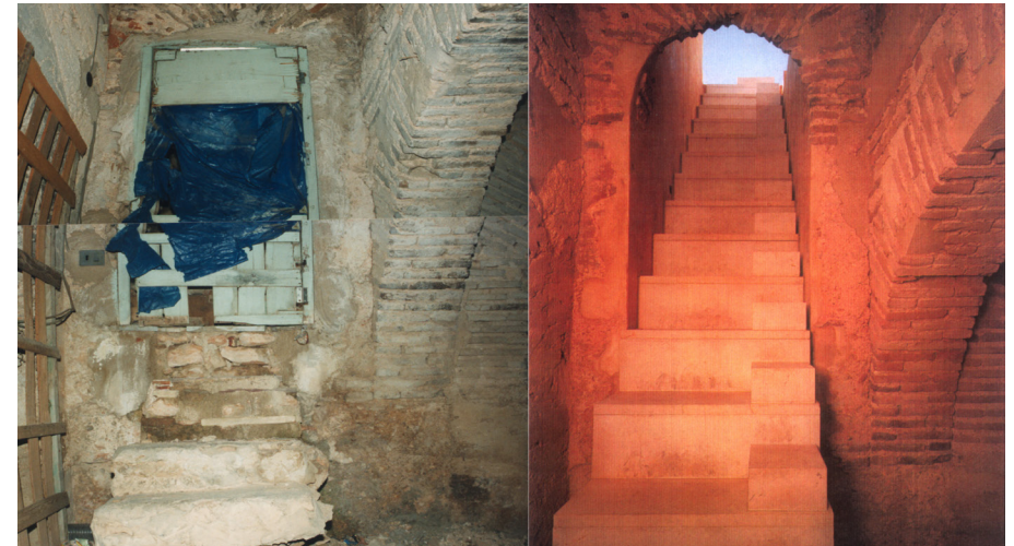
Fig. 4.102. Estado previo y estado actual de la escalera interior.
