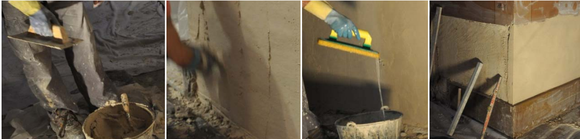
6.722,6.723 Aplicación dos capas de mortero.
