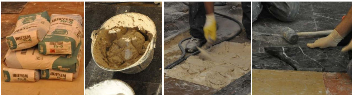
6.751,6.752,6.753 Colocación de mortero de agarre.
