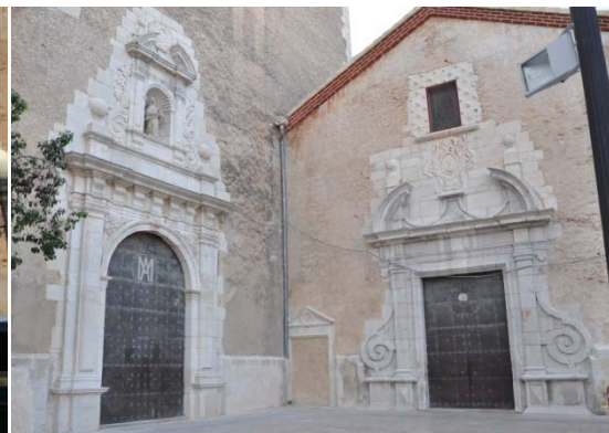
6.648 Estado posterior a la intervención.
