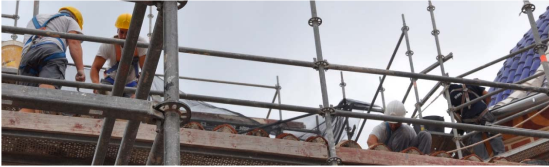
6.446 Trabajos de retejado en los faldones del crucero.
