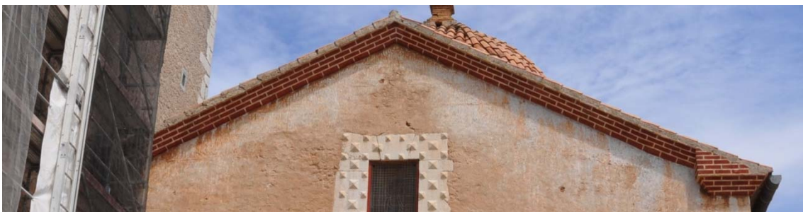
6.270 Estado posterior a la intervención.
