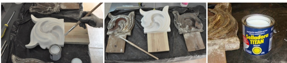
Grupo de imágenes 6.839 Aplicación de selladora a la talla de madera del ángel de la cúpula.
