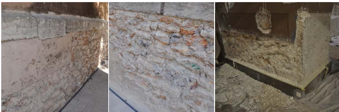
Grupo de imágenes 3.59 Zócalo de mampostería.
