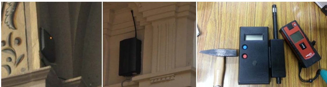
Grupo de imágenes 6.712 Colocación de elementos electroósmosis.
