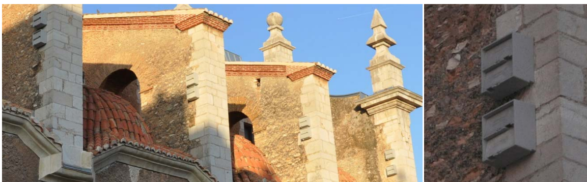
Grupo de imágenes 8.1 Colocación de 8 nidos dobles en los contrafuertes de la fachada suroeste.
