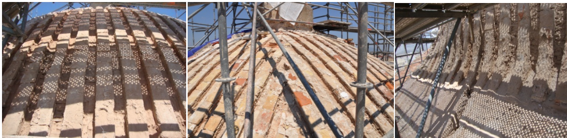
Grupo de imágenes 6.381 Parte superior de la cúpula donde se aprecian las partes que la forman.
