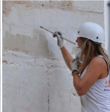
6.157, 6.158 Aplicación detergente desincrustante.
