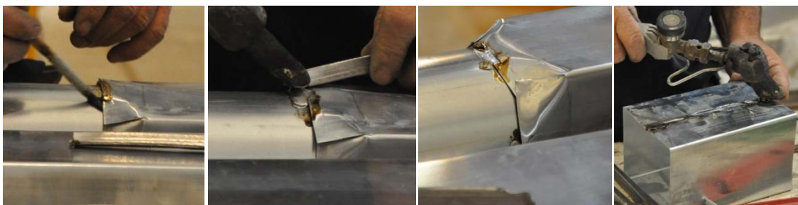
Grupo de imágenes 6.320 Proceso de soldado de las piezas de las bajantes.
