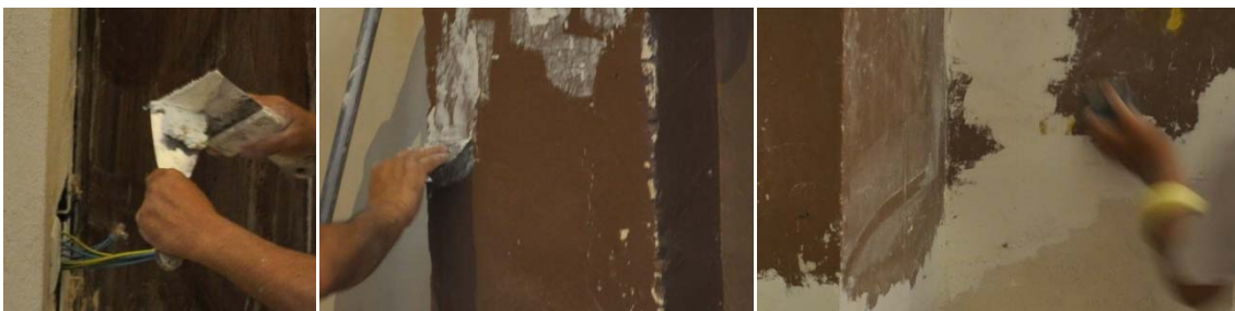
Grupo de imágenes 6.726 Masillado y refinado de zócalo antes de pintarse.
