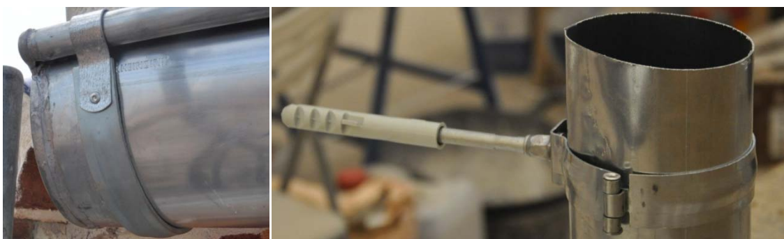
Grupo de imágenes 6.614 Elemento de sujeción del canalón y la bajante.
