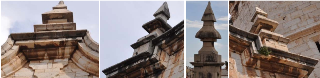
Grupo de imágenes 6.216 Estado inicial.
