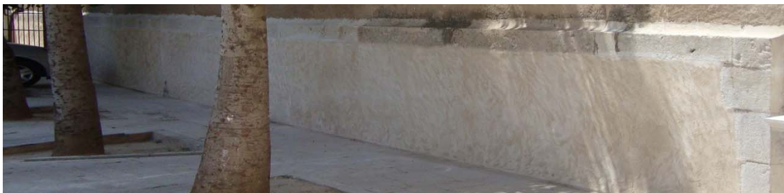
6.340 Estado posterior a la intervención.
