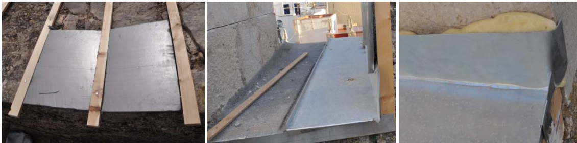
Grupo de imágenes 6.260 Material aislante colocado para un mejor apoyo de las láminas de zinc.
