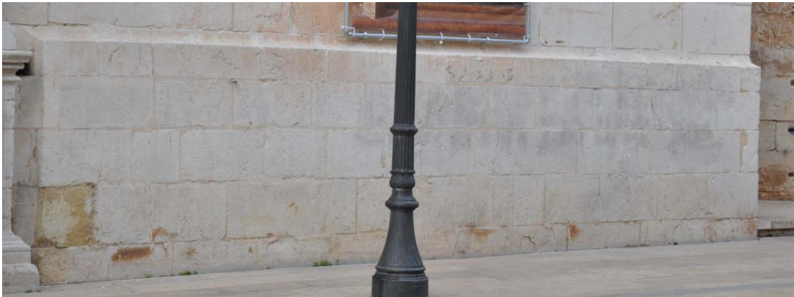
6.145 Estado posterior a la intervención.
