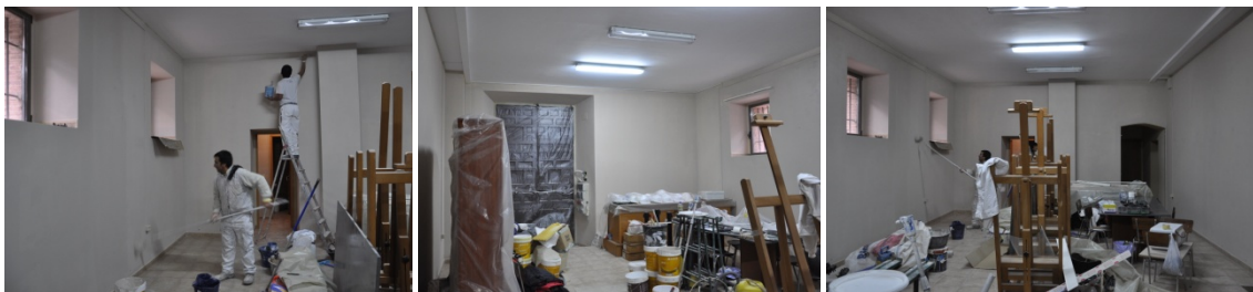
Grupo de imágenes 6.899 Trabajos de pintura del salón parroquial.
