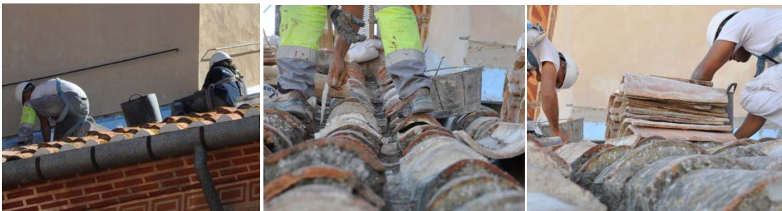
Grupo de imágenes 6.448 Trabajos de colocación de nuevas tejas.
