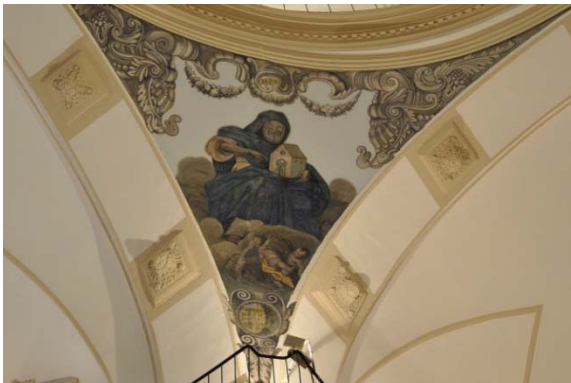
6.913 Estado posterior a la intervención.
