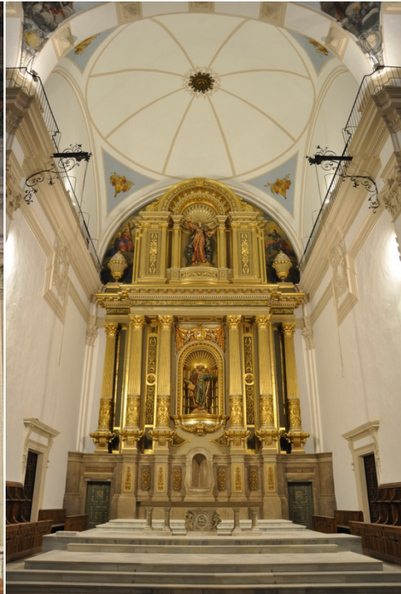
6.908 Estado posterior a la intervención.
