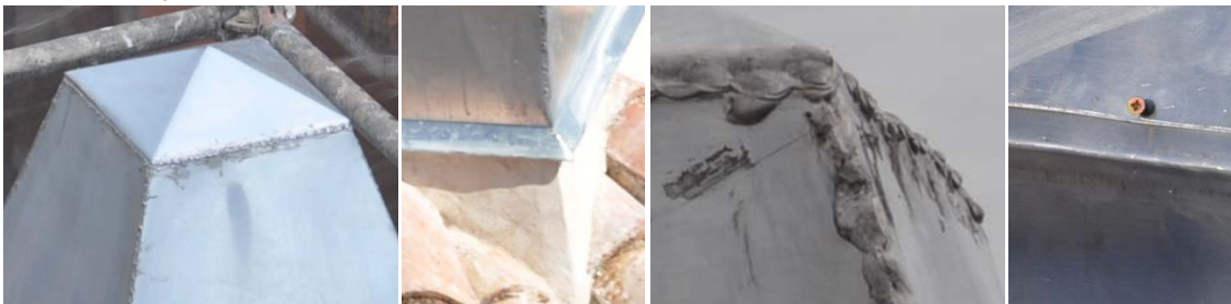
Grupo de imágenes 6.507 Resultado de las uniones entre láminas de zinc y atornillado.
