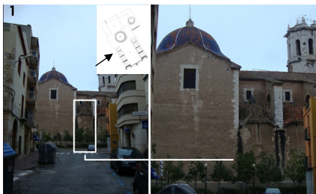
Imagen 4.22 Puerta vista desde la C/ Alcalá de Xivert
