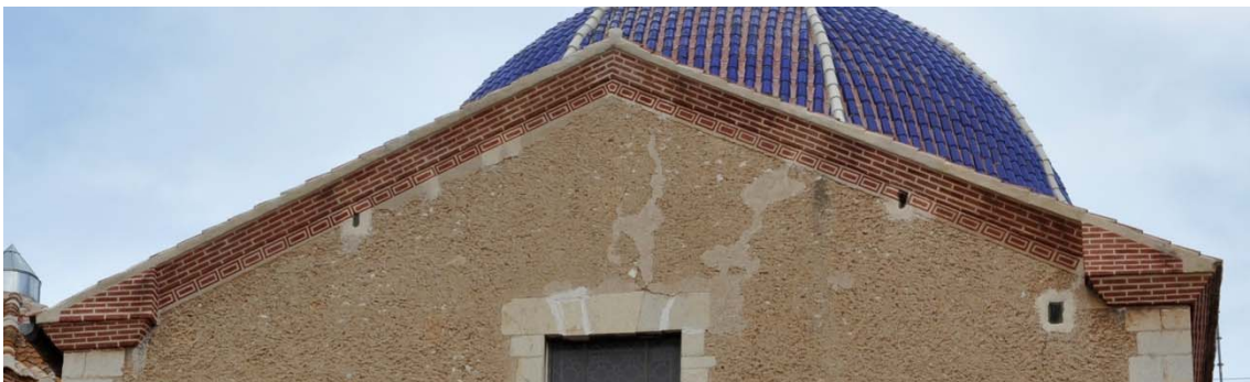
6.268 Estado posterior a la intervención.
