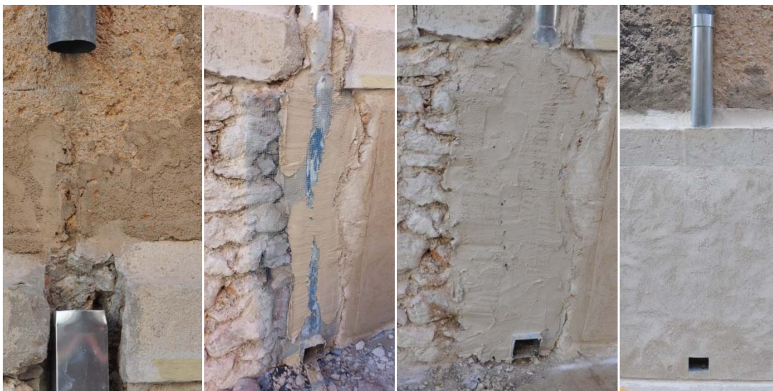
Grupo de imágenes 6.326 Proceso de colocación de las nuevas bajantes.
