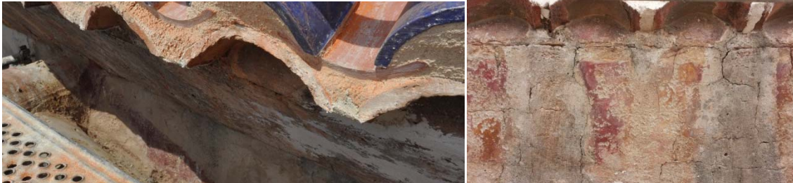
Grupo de imágenes 6.240 Estado inicial.
