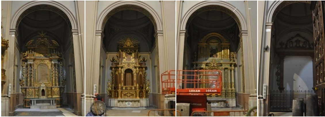
6.919 Estado anterior a la intervención. Capillas del lado de la Epístola de la 4ª a la 1ª.
