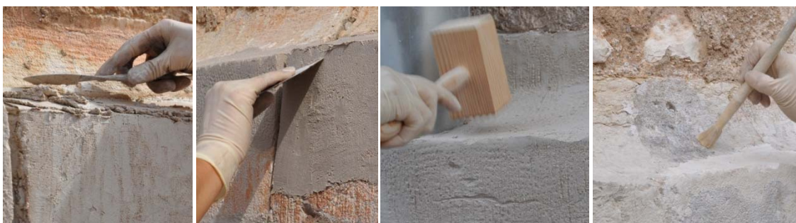
6.310, 6.311, 6.312 Acabado de reintegraciones con bujarda o maza.
