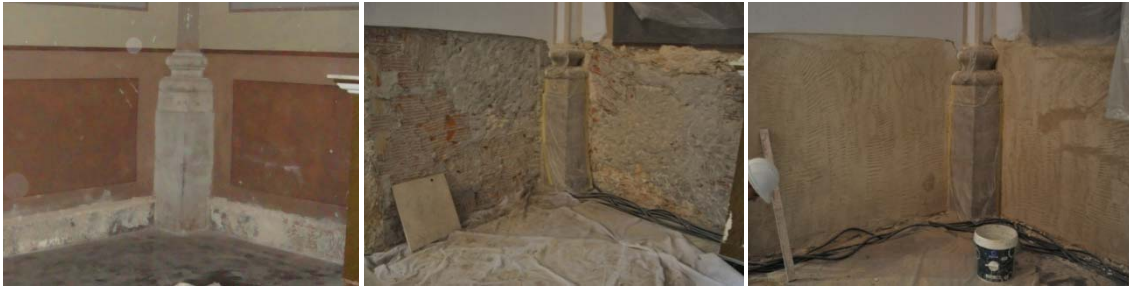
Grupo se imágenes 6.728 Proceso de restauración de zócalo interior en uno de los paramentos.
