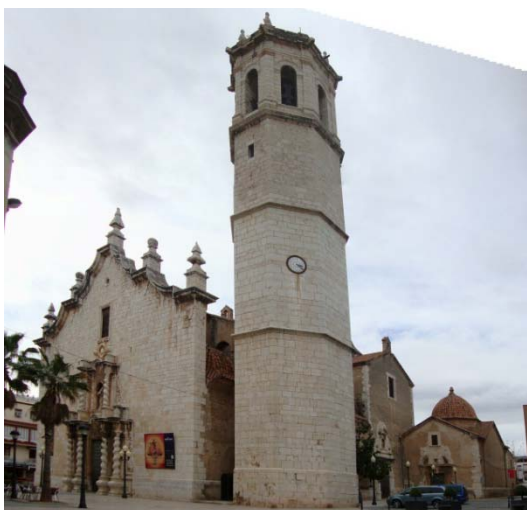
Imagen 3.42 Vista general iglesia
