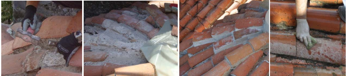
6.438 Retirada de tejas.
