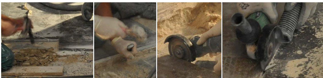
Grupo de imágenes 6.746 Refinado del canto de las baldosas de las regatas para que encajen con las nuevas.
