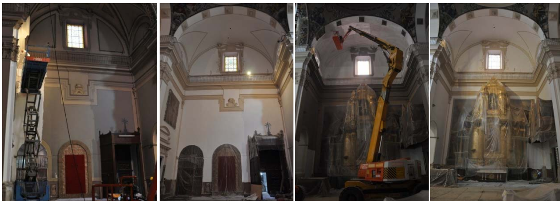
Grupo de imágenes 6.830 Proceso de pintado de los paramentos y bóvedas del crucero.
