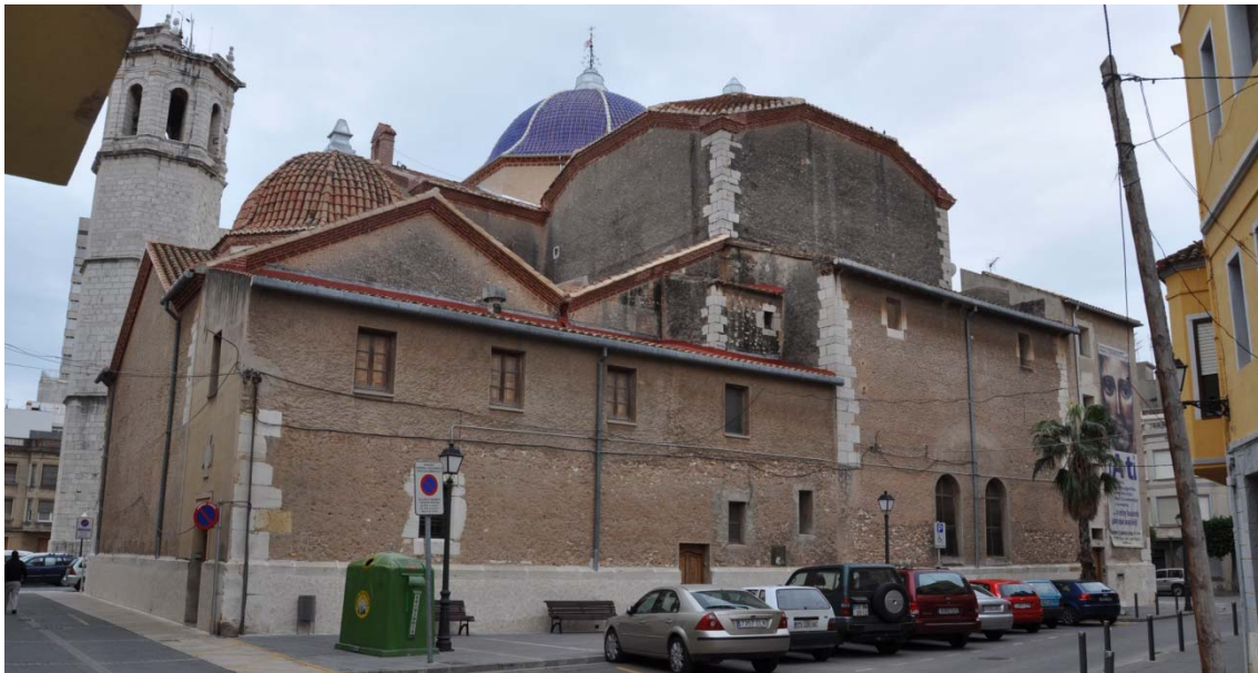
6.650 Estado posterior a la intervención.
