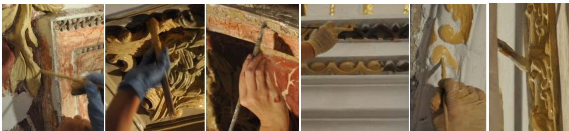
Grupo de imágenes 6.884 Aplicación de barniz acrylic y adhesivo mixtion.
