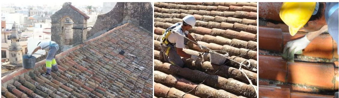
6.442 Retirada de tejas.
