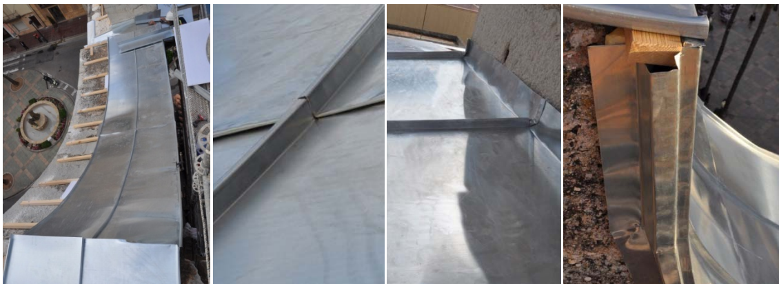
Grupo de imágenes 6.262 Solape y engatillado de piezas de zinc.
