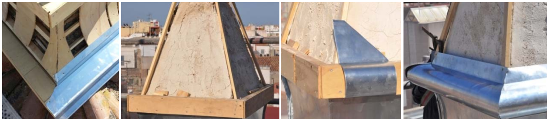
Grupo de imágenes 6.500 Atornillado de la estructura al pináculo.
