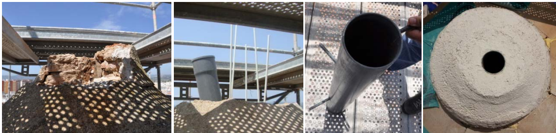
6.591,6.592 Hormigonado remate del pináculo.
