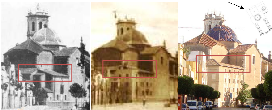
Grupo de imágenes 4.33 Proceso de cambio de cubierta de la Casa Abadía.
