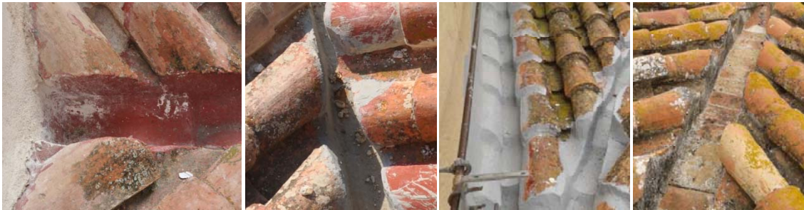
Grupo de imágenes 6.612 Canalones en cubierta.
