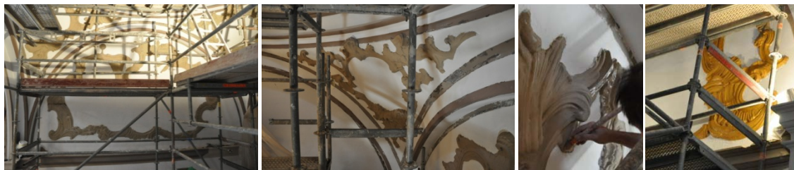
Grupo de imágenes 6.860 Aplicación de consolidante polaroid.
