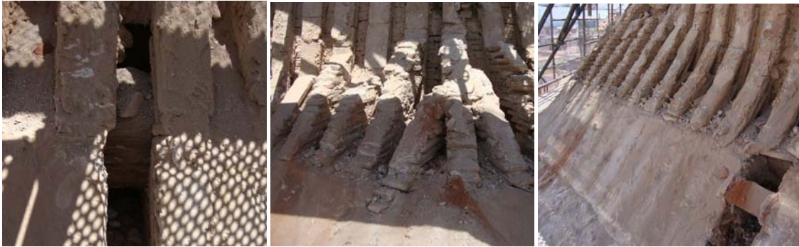
3.78 Anillo perimetral de madera Imagen 3.79 y 3.80 Muretes de fábrica de ladrillo para colocar las tejas
