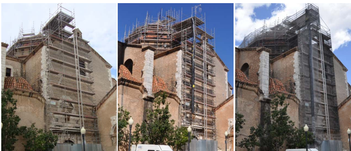
Grupo de imágenes 6.371 Montaje de andamios.
