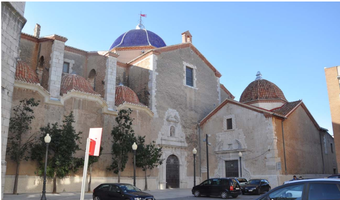
6.646 Estado posterior a la intervención.
