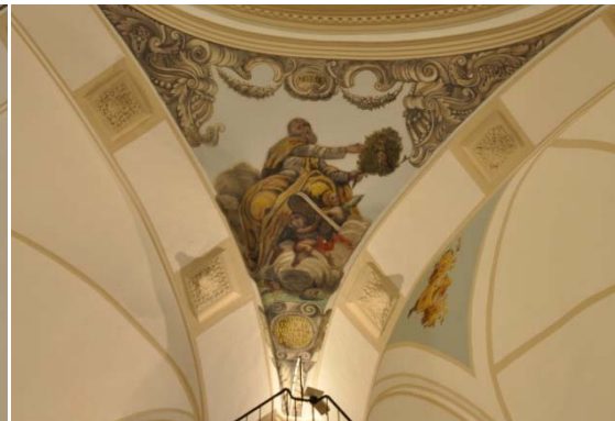
6.914 Estado posterior a la intervención.
