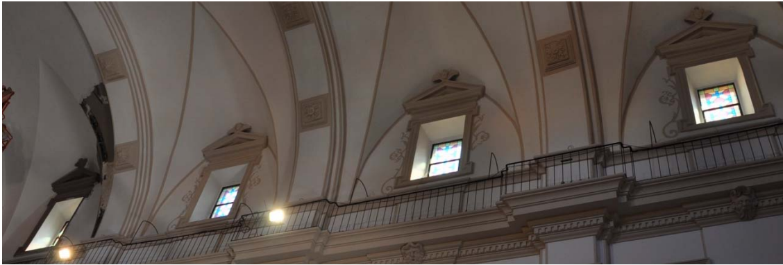
Grupo de imágenes 6.779 Estado anterior a la intervención.
