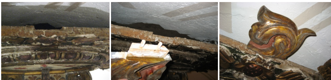
Grupo de imágenes 6.848 Colocación talla de madera en el remate de la cúpula.
