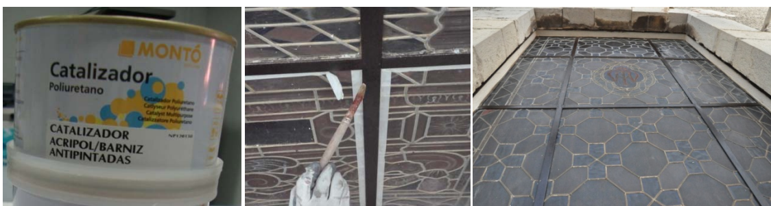
Grupo de imágenes 6.350 Aplicación de una capa de barniz de protección de poliuretano para exteriores.
