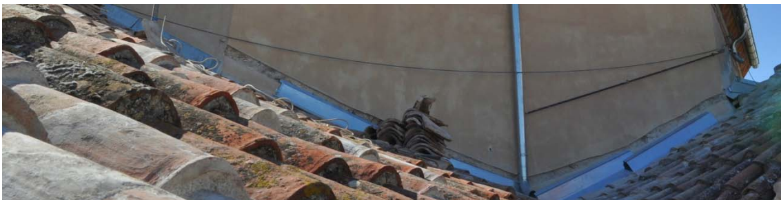
6.640 Estado posterior a la intervención.
