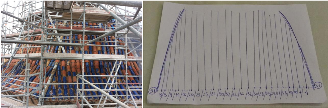
Grupo de imágenes 6.375 Contabilización de tejas de la cúpula.
