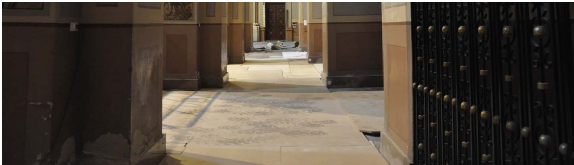
6.732 Estado anterior a la intervención.
