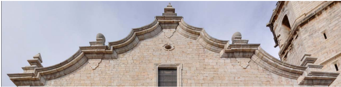
6.284 Estado posterior a la intervención.
