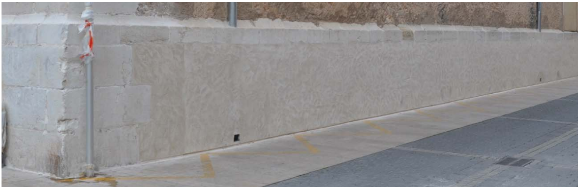
6.337 Estado posterior a la intervención.
