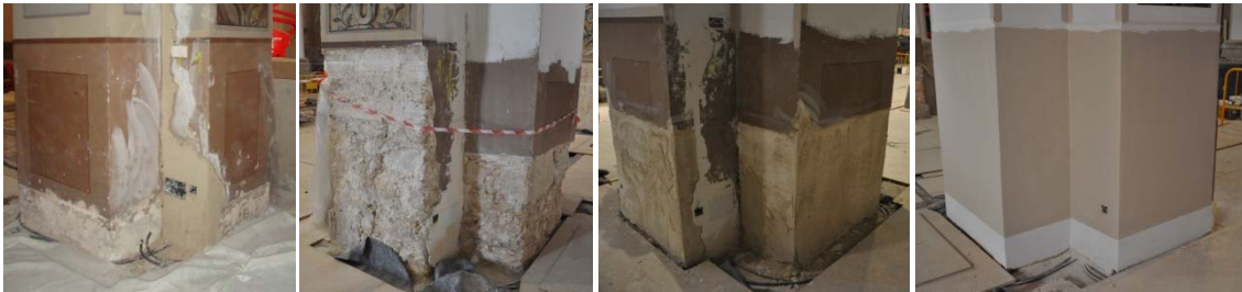
Grupo se imágenes 6.729 Proceso de restauración de zócalo interior en una de las columnas.
