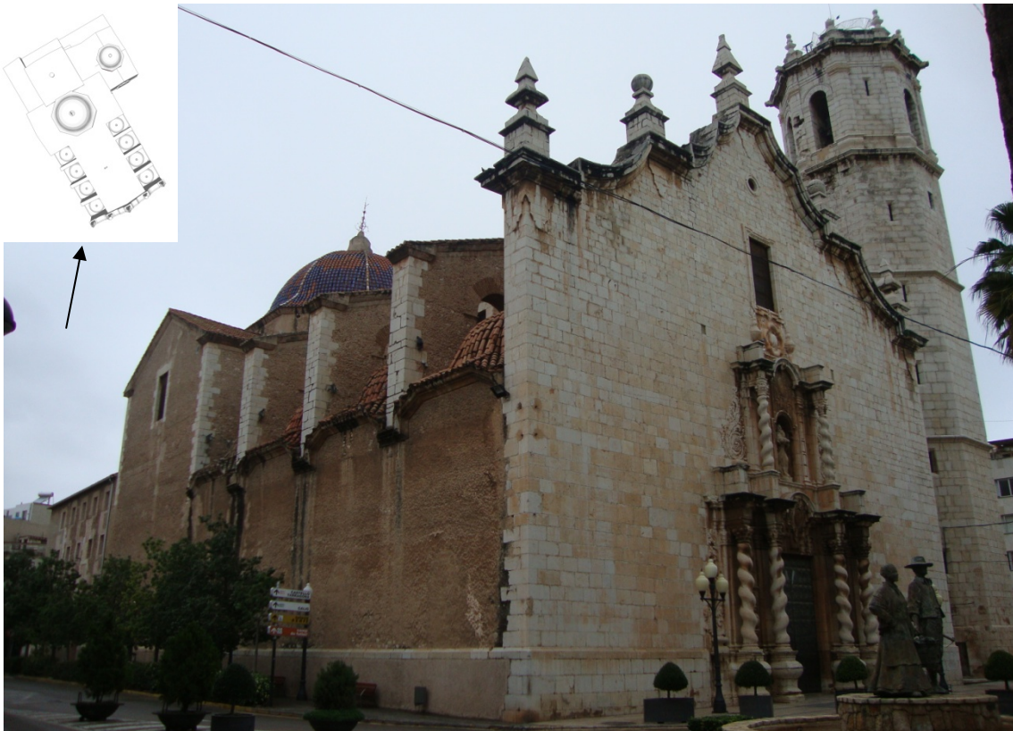
6.641 Estado anterior a la intervención.
