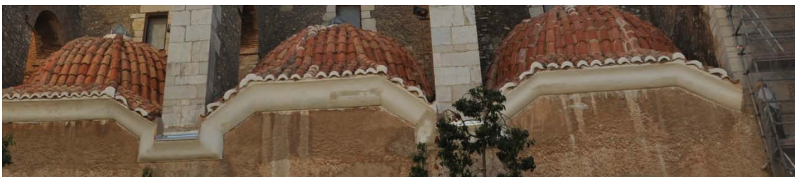
6.282 Estado posterior a la intervención.
