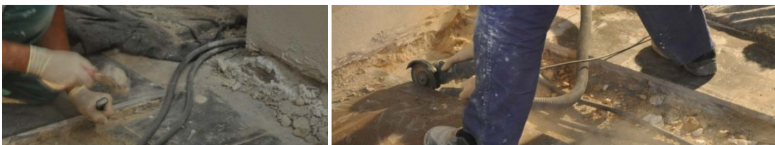
Grupo de imágenes 6.663 Picado y corte de pavimento con radial.
