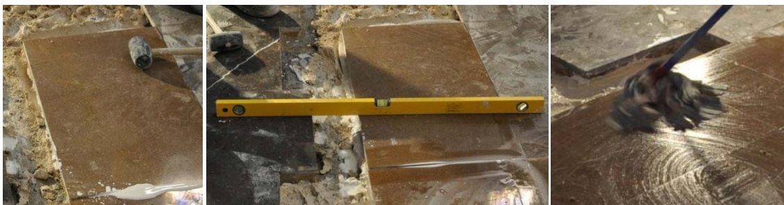
6.755,6.756 Encaje y nivelado de las baldosas.
