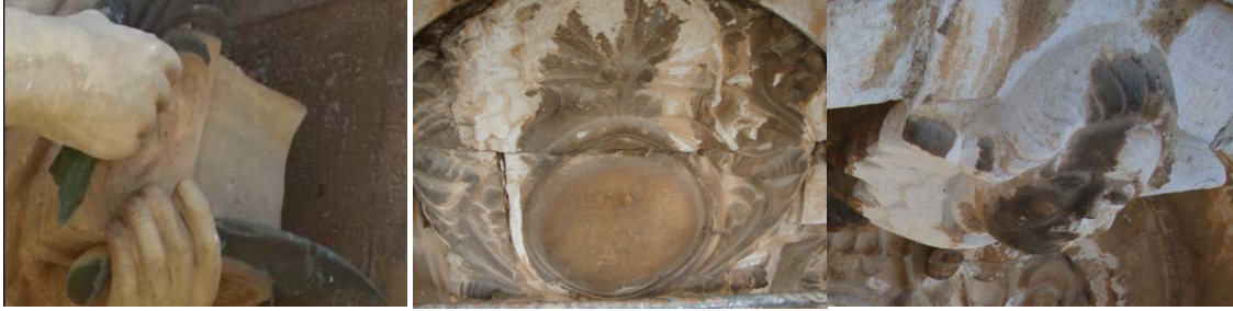
Grupo imágenes 6.38 Estado inicial.
