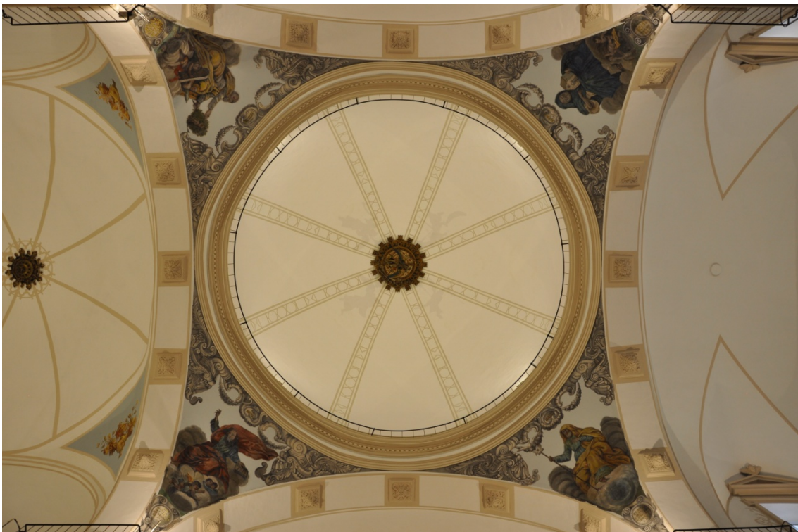
6.910 Estado posterior a la intervención.
