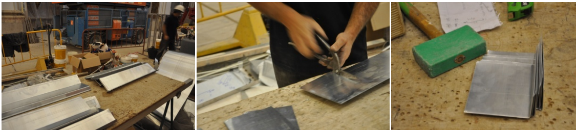
Grupo de imágenes 6.774 Realización de Piezas de zinc a modo de vierteaguas para los marcos de acero inoxidable.
