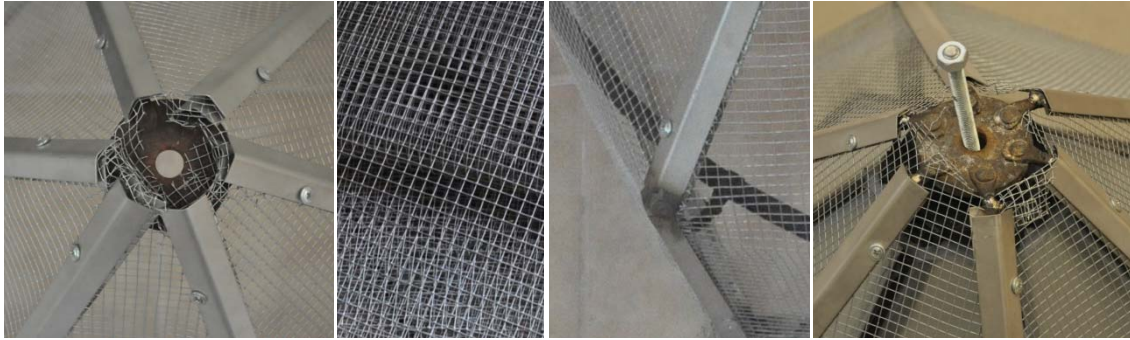
Grupo de imágenes 6.547 Detalle de acabado del armazón de protección con su correspondiente malla.
