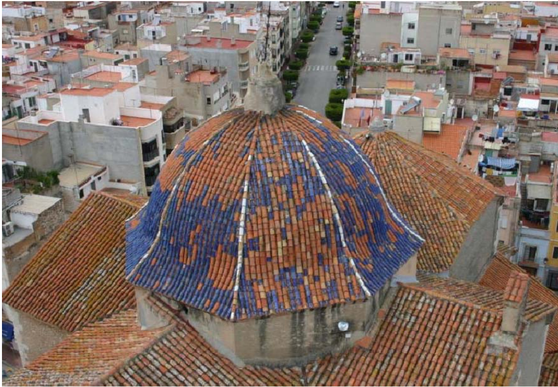
Grupo de imágenes 6.401 Estado anterior a la intervención.
