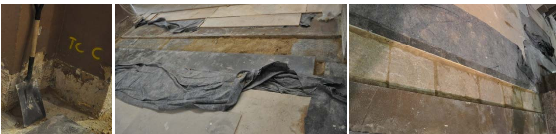
Grupo de imágenes 6.664 Regatas en el pavimento.
