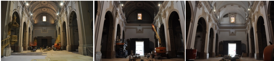
Grupo de imágenes 6.823 Proceso de pintado de los paramentos de la nave central.
