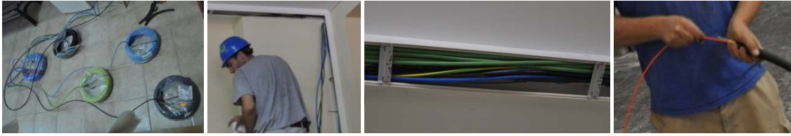
Grupo de imágenes 6.668 Paso de cableado por paredes del salón parroquial.
