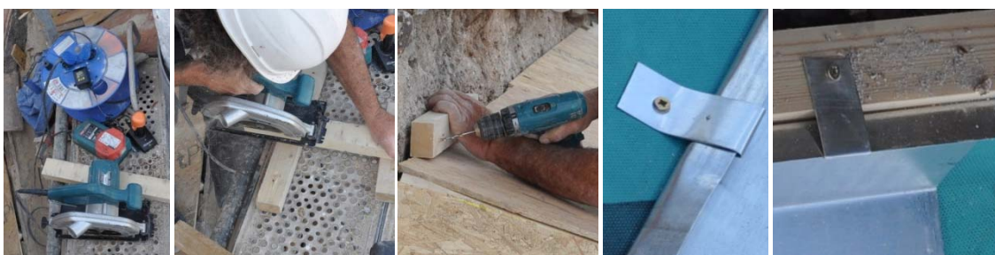
6.451, 6.452, 6.453 Colocación de rastreles y tablas.
