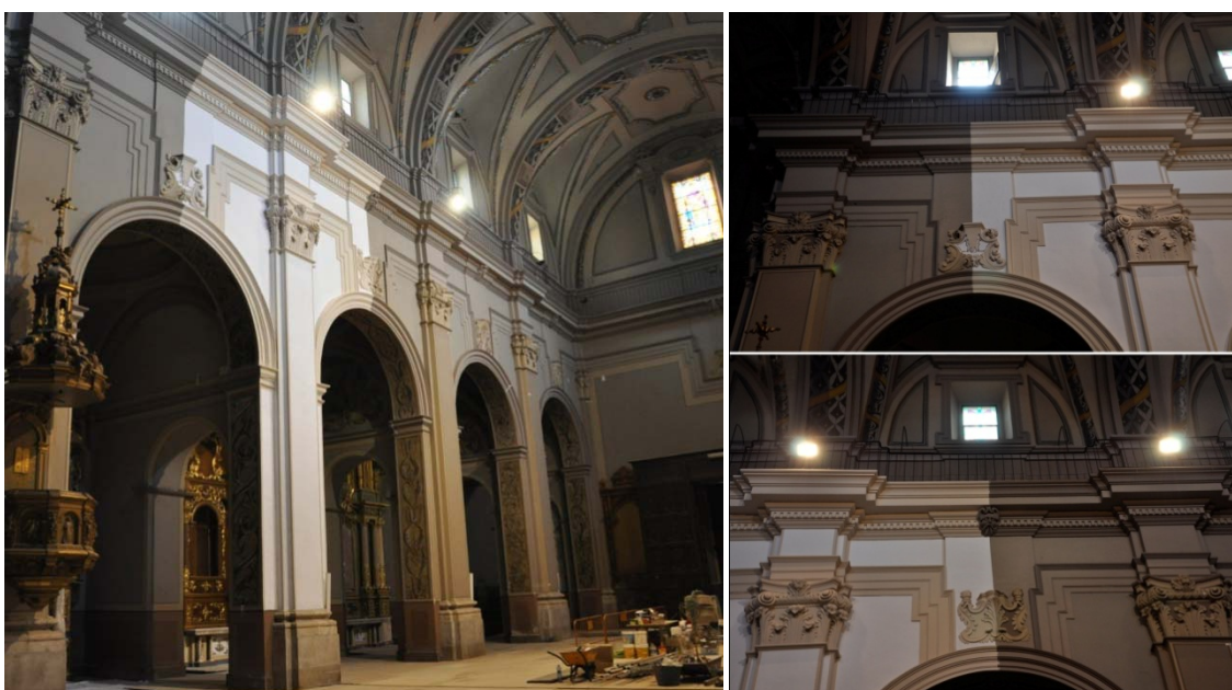
Grupo de imágenes 6.821 Prueba de pintura en paramentos y cornisas.
