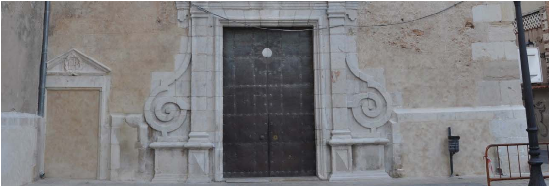
6.174 Estado posterior a la intervención.
