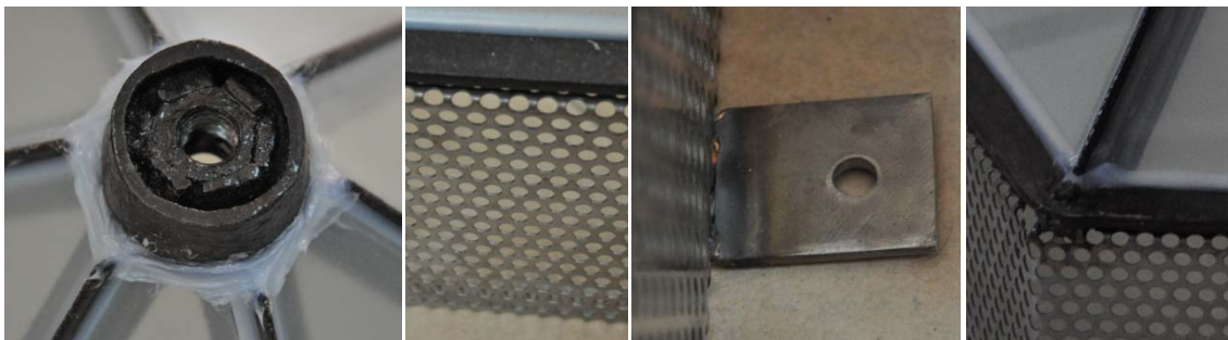
Grupo de imágenes 6.546 Detalle de los acabados y formas de unión del lucernario
