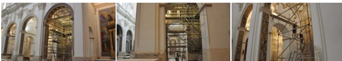
Grupo de imágenes 6.854 Montaje de andamio para las capillas 2ª y 4ª del lado del Evangelio.
