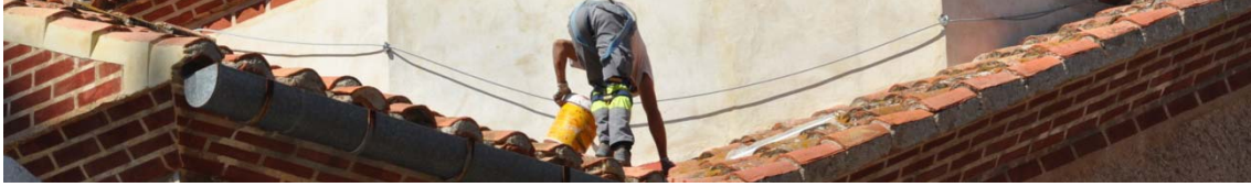
6.635 Estado antes de la intervención.
