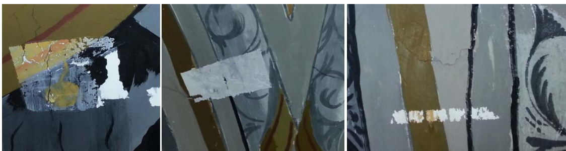
Grupo de imágenes 6.816 Catas en bóveda de la nave central.
