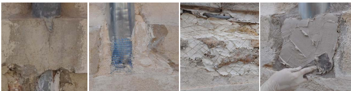
Grupo de imágenes 6.309 Reintegración volumétrica a base de capas de mortero.
