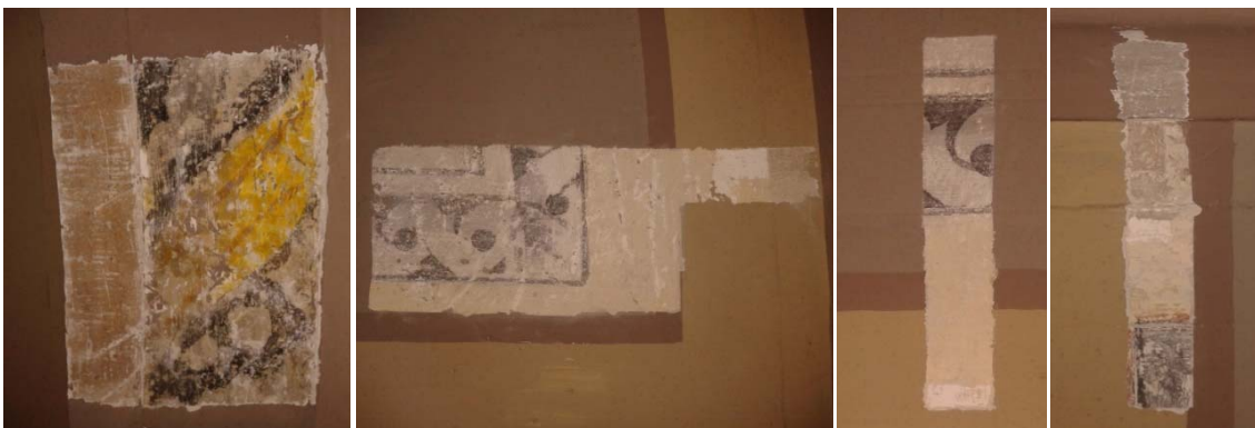
Grupo de imágenes 6.811 Catas en capilla 4 lado del Evangelio.
