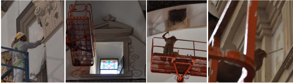
Grupo de imágenes 6.822 Trabajos de pintura en las partes de la nave central.
