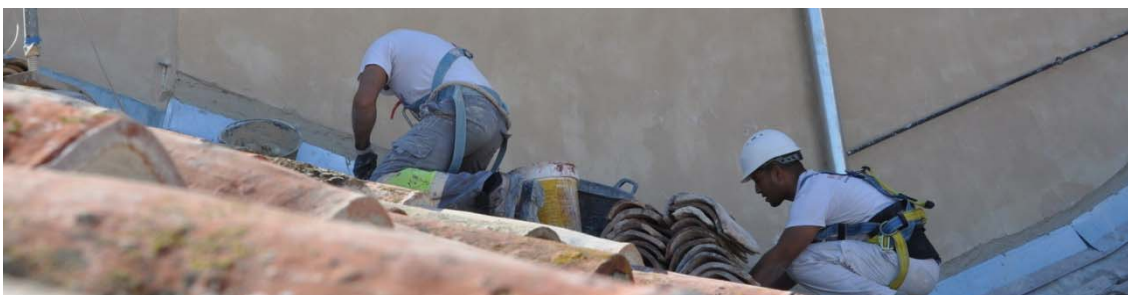
6.449 Colocación de nuevas tejas y limpieza.
