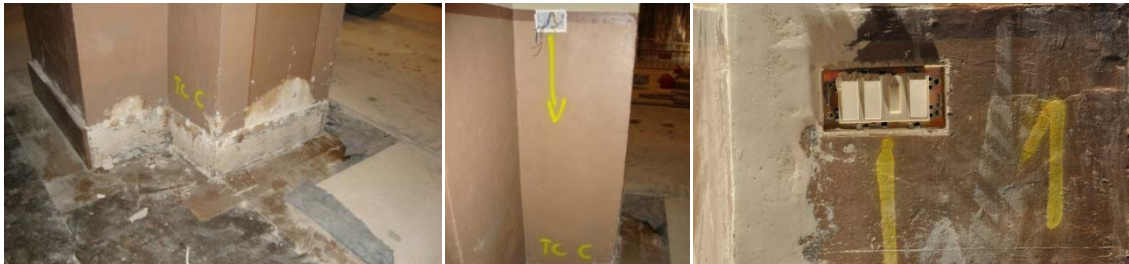
Grupo de imágenes 6.658 Trabajos de picado de zócalo y replanteo de la instalación.
