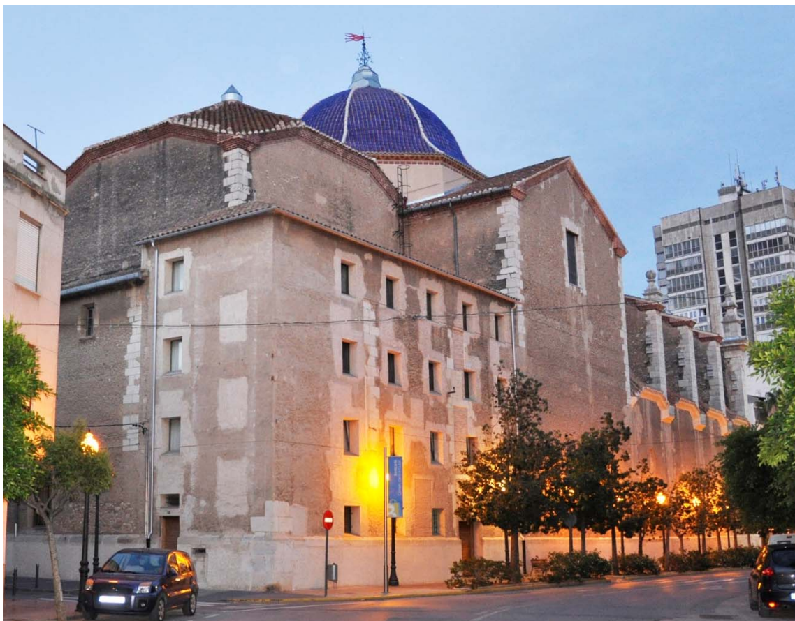
6.652 Estado posterior a la intervención.
