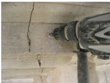
6.86 Perforación con taladro.
