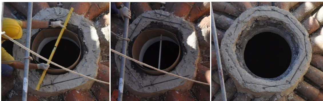
6.549 Encofrado y hormigonado. 6.550,6.551 Colocación varillas de fibra de vidrio.
