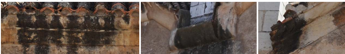
Grupo de imágenes 6.218 Estado inicial.
