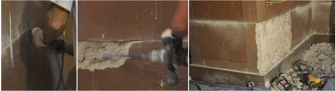
6.714 Corte con radial 6.715,6.716 Picado del revestimiento con martillo eléctrico.
