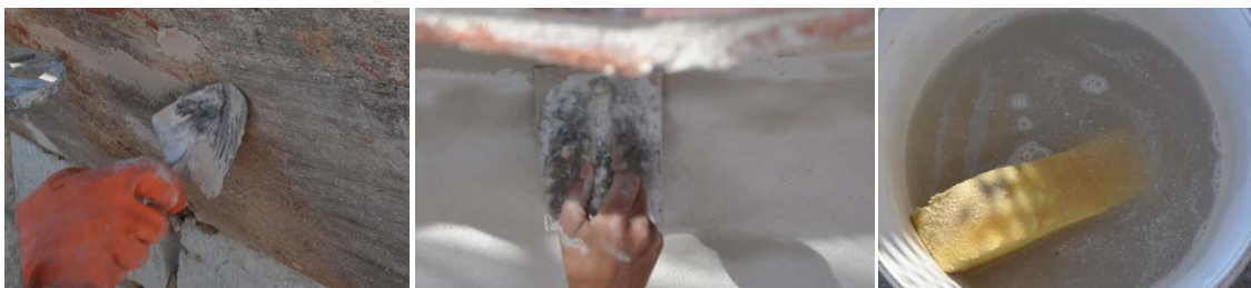
6.227, 6.228 Aplicación mortero con paletilla y llana.
