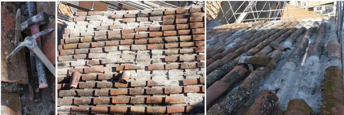
Grupo de imágenes 6.447 Trabajos de retirada de tejas en mal estado.
