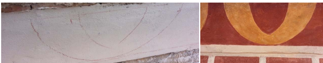
Grupo de imágenes 6.251 Realización líneas maestras y pintura grecas.
