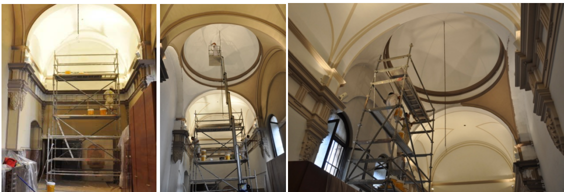
Grupo de imágenes 6.897 Proceso de pintado de paramentos, cúpula y bóvedas de la sacristía.
