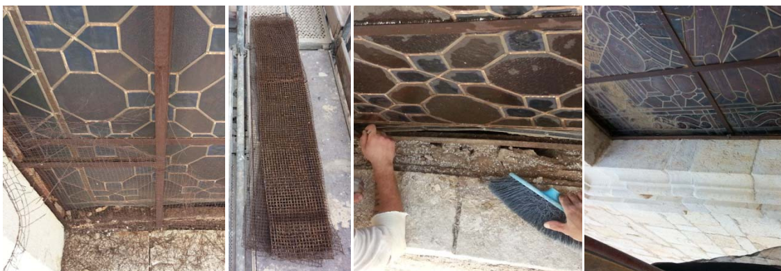
6.345,6.346 Retirada de malla.
