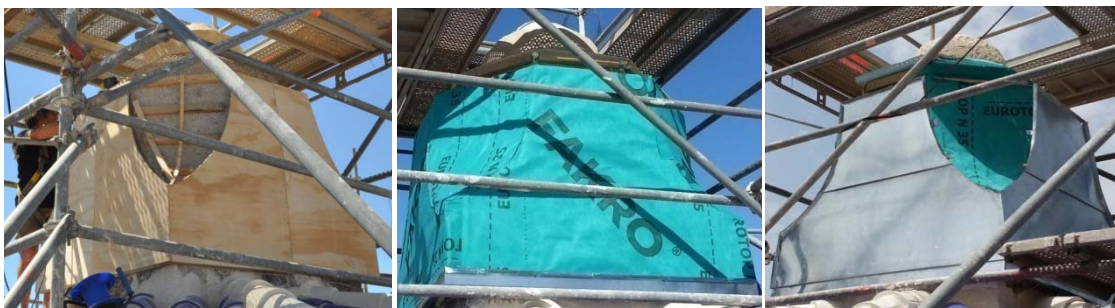
Grupo de imágenes 6.501 Colocación tela impermeable transpirante.
