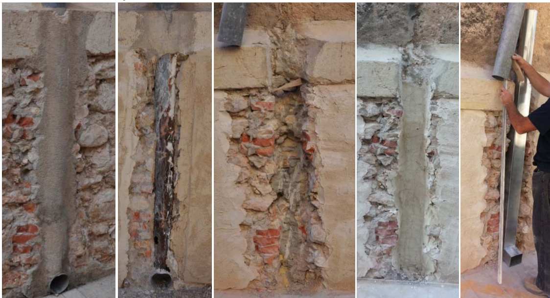
Grupo de imágenes 6.325 Proceso de retirada de las bajantes.
