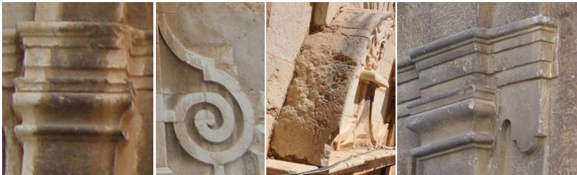
Grupo imágenes 6.36 Estado inicial.
