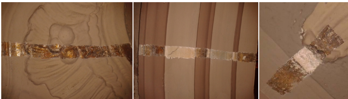
Grupo de imágenes 6.806 Catas en capilla 2 lado del Evangelio.
