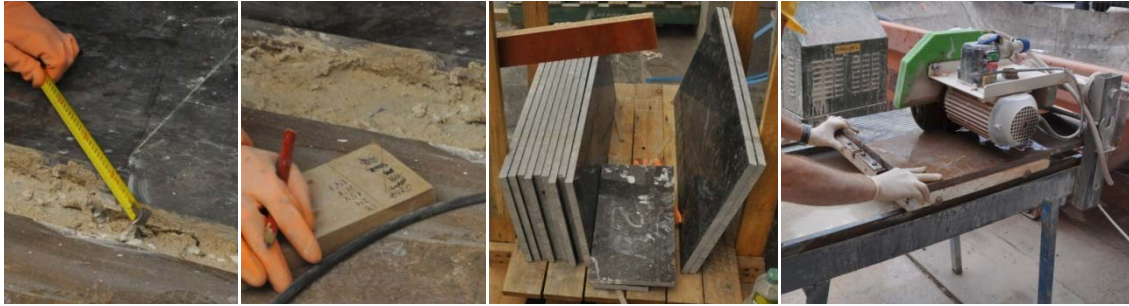
6.747,6.748,6.749 Toma de medidas para cortar las nuevas baldosas. 6.750 Corte de las piezas a medida.
