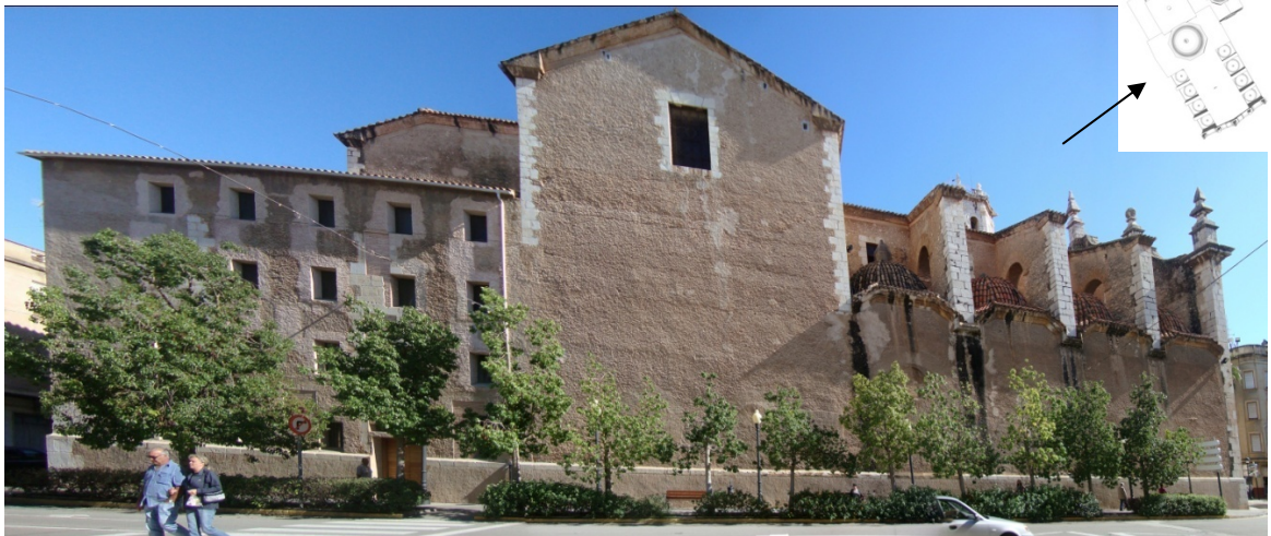
Imagen 3.48 Fachada lateral suroeste
