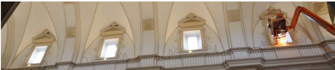
Grupo de imágenes 6.777 Piezas de alabastro colocadas.
