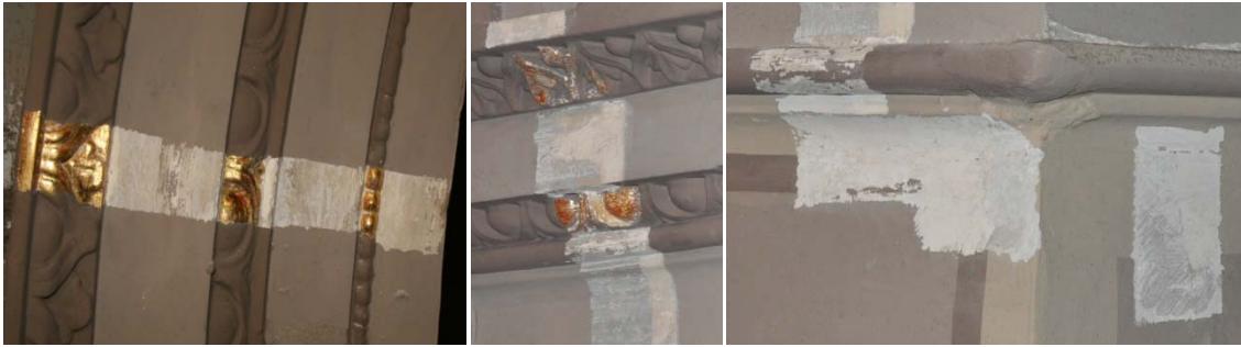
Grupo de imágenes 6.808 Catas en capilla 4 lado del Evangelio.
