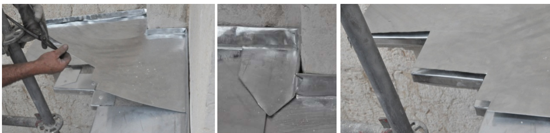
Grupo de imágenes 6.111 Proceso de corte y colocación piezas.
