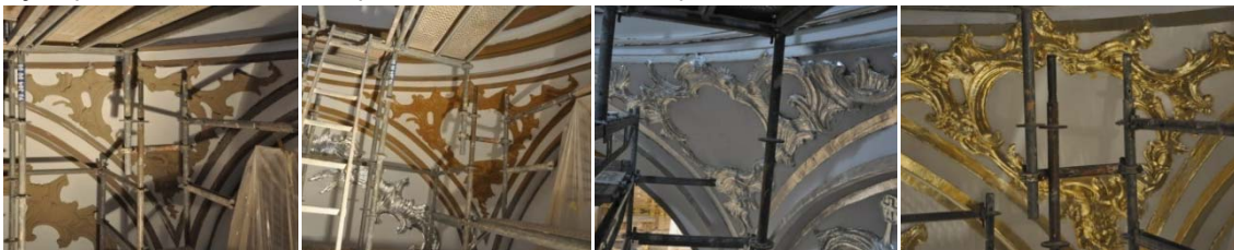
Grupo de imágenes 6.867 Proceso de realización de la plata corlada en una de las pechinas de la capilla.
