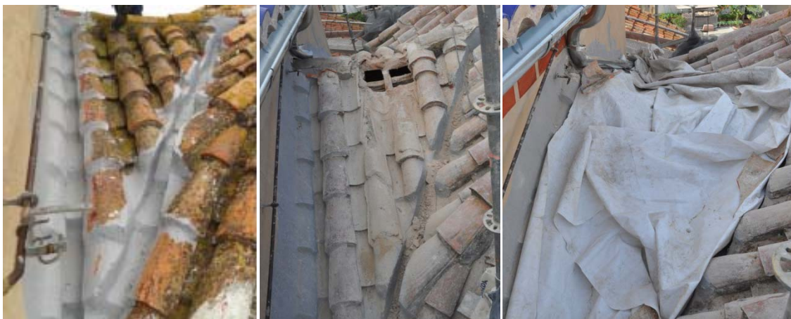
Grupo de imágenes 6.450 Retirada de tejas del encuentro conflictivo.
