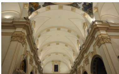
6.687 Bóveda nave central.
