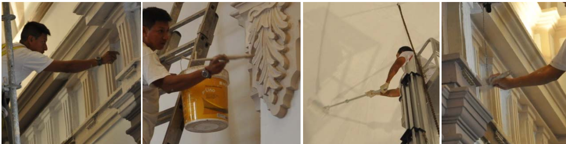
Grupo de imágenes 6.896 Trabajos de pintura en sacristía.
