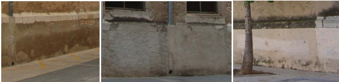
Grupo de imágenes 6.306 Estado inicial.
