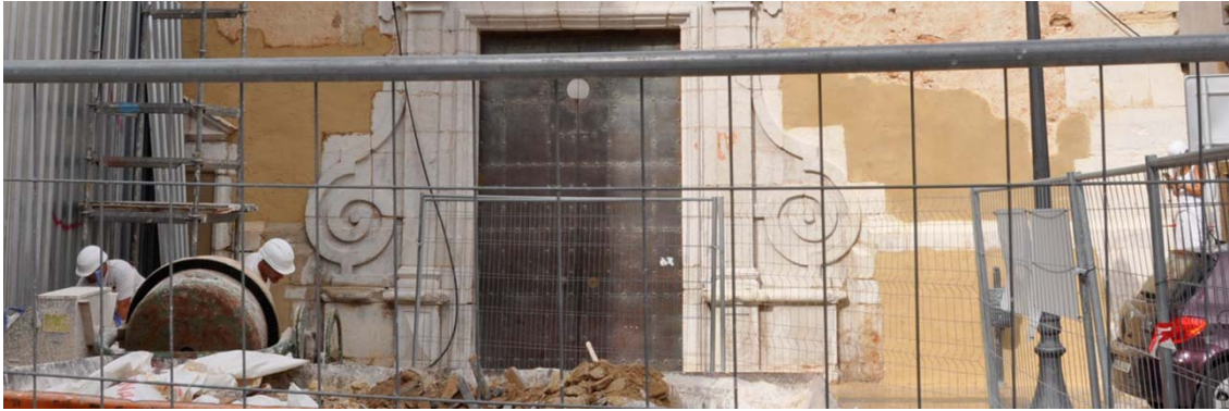
6.164 Mortero de cal colocado y listo para su secado.
