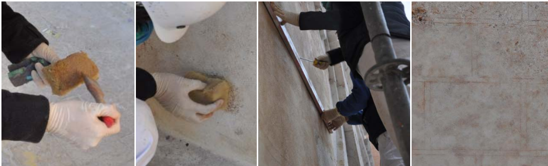
Grupo de imágenes 6.171 Realización del fingido del almohadillado con incisión.
