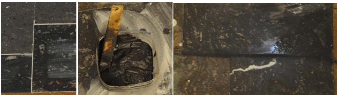
Grupo de imágenes 6.758 Pintado de las juntas del mismo color que las baldosas.
