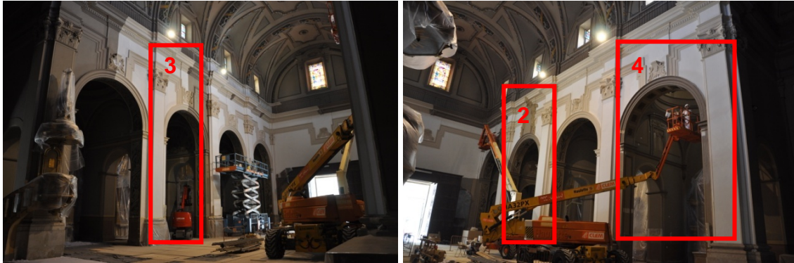
Grupo de imágenes 6.812 Las tres capillas mencionadas como las de más interés pictórico, (2) y (4) en el lado del Evangelio y (3) en el lado de la Epístola.
