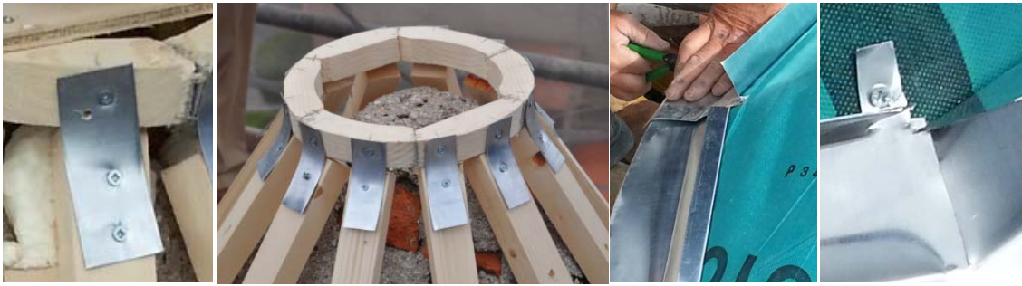
Grupo de imágenes 6.505 Atornillado de las láminas de zinc a la estructura de madera.
