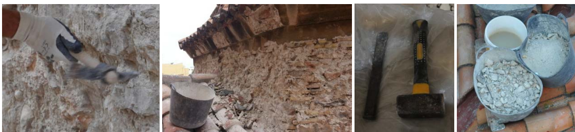
Grupo de imágenes 6.470 Picado de revestimiento.
