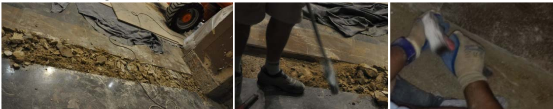
Grupo de imágenes 6.662 Proceso de picado de pavimento para regatas.
