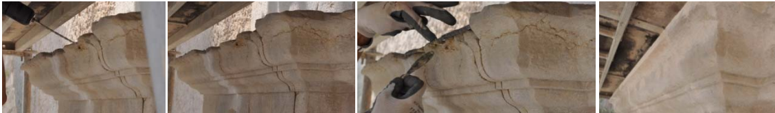
Grupo de imágenes 6.95 Proceso de reintegración volumétrica.
