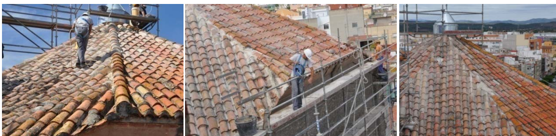
Grupo de imágenes 6.434 Trabajos de retejado en el ábside.
