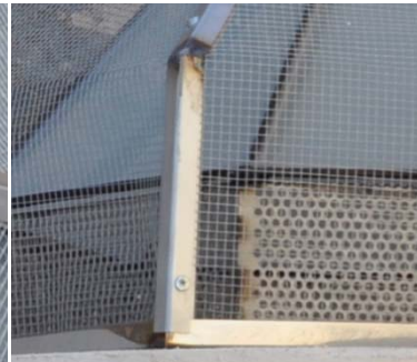
6.556, 6.557 Anclaje de la estructura de protección atornillada al lucernario.
