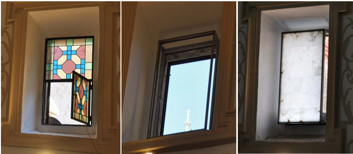
Grupo de imágenes 6.778 Proceso de sustitución de vidrieras.
