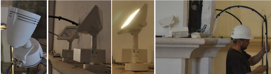
Grupo de imágenes 6.683 Trabajos de colocación de luminarias.
