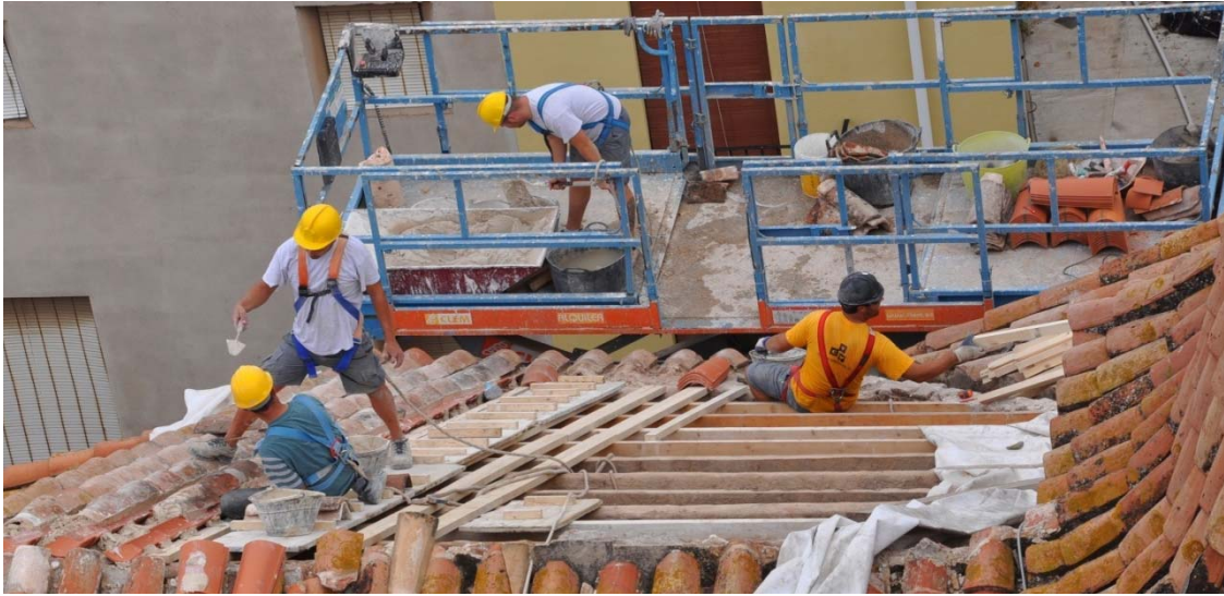
6.421 Trabajos de retejado.
