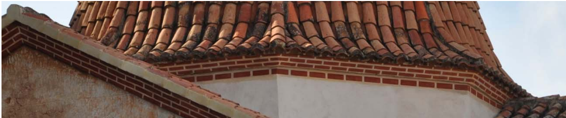
6.278 Estado posterior a la intervención.
