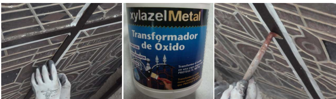
Grupo de imágenes 6.349 Aplicación del transformador del óxido por impregnación.
