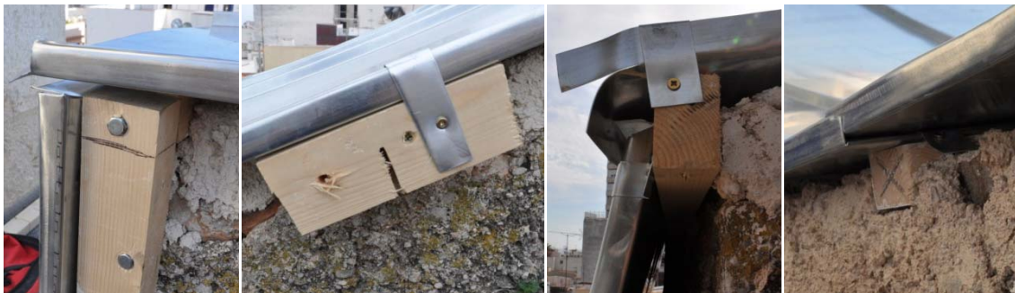
Grupo de imágenes 6.261 Atornillado de las piezas de zinc a la estructura de madera.
