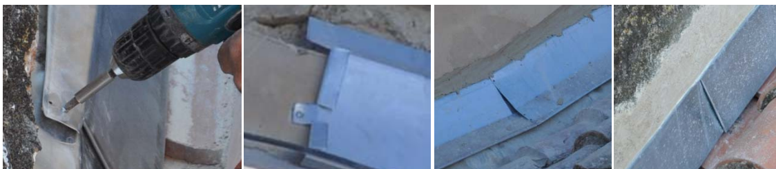
Grupo de imágenes 6.624 Atornillado y sujeción con mortero de las piezas de zinc.
