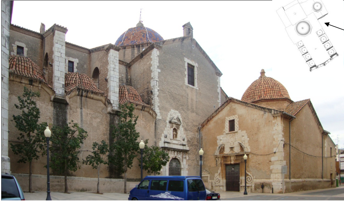
6.645 Estado anterior a la intervención.
