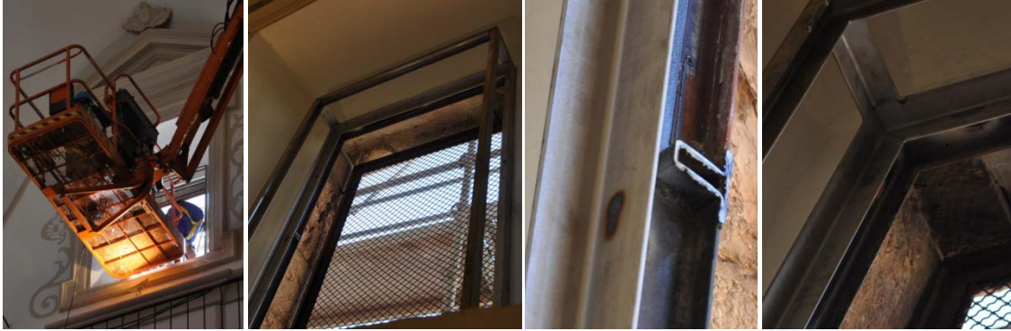
Grupo de imágenes 6.773 Colocación de los marcos metálicos anclados al marco de las vidrieras.
