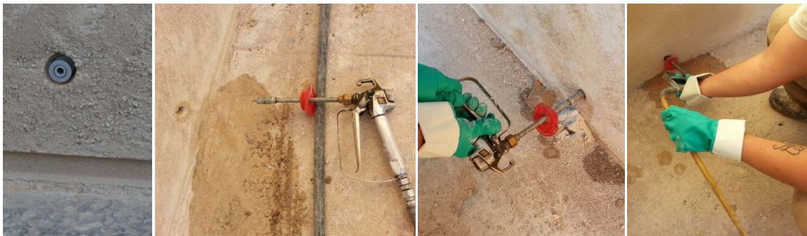
6.788 Inyector 6.789, 6.790, 6.791 Inyección del tratamiento antitermitas a presión con un pistón manual.
