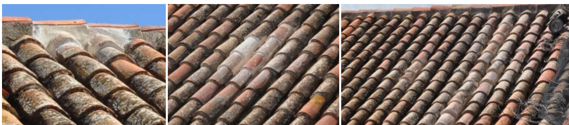
Grupo de imágenes 6.445 Nuevas tejas colocadas.
