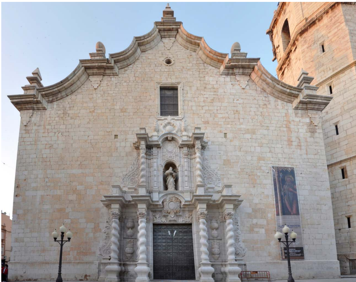
6.644 Estado posterior a la intervención.
