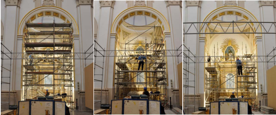
Grupo de imágenes 6.895 Retirada de andamios de las capillas.
