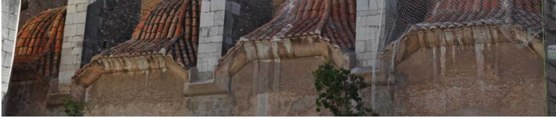
Grupo de imágenes 6.238 Estado inicial.
