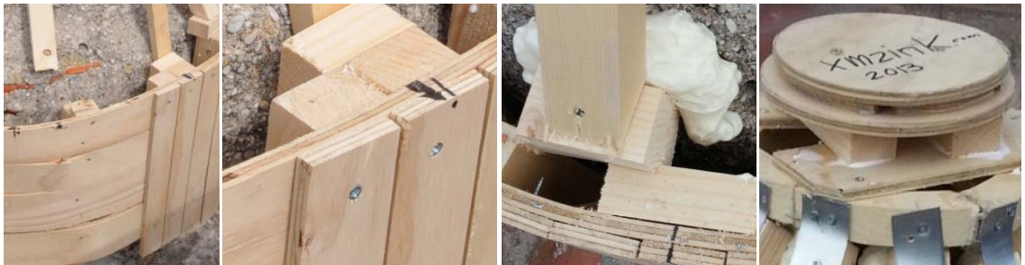
Grupo de imágenes 6.499 Atornillado de la estructura de madera y fijación con poliuretano.
