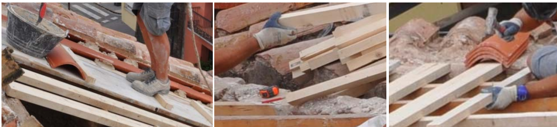
6.422 Tableros para deslizamiento.
