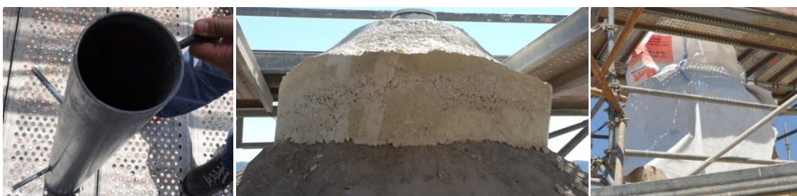
Grupo de imágenes 6.496 Encofrado del remate del pináculo de la cúpula central.
