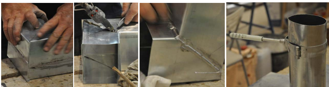
6.321, 6.322, 6.323 Trabajos de soldado de las bajantes.
