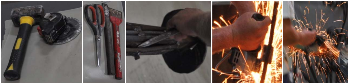
Grupo de imágenes 6.567 Corte de las barras del anclaje de la veleta.
