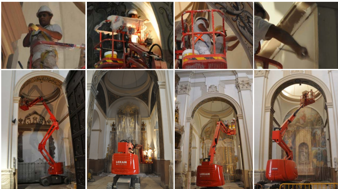
Grupo de imágenes 6.851 Trabajos de pintura en las capillas laterales.
