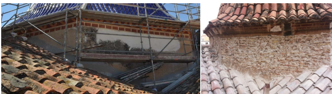
Grupo de imágenes 6.471 Tambores tras el picado de elementos impropios.
