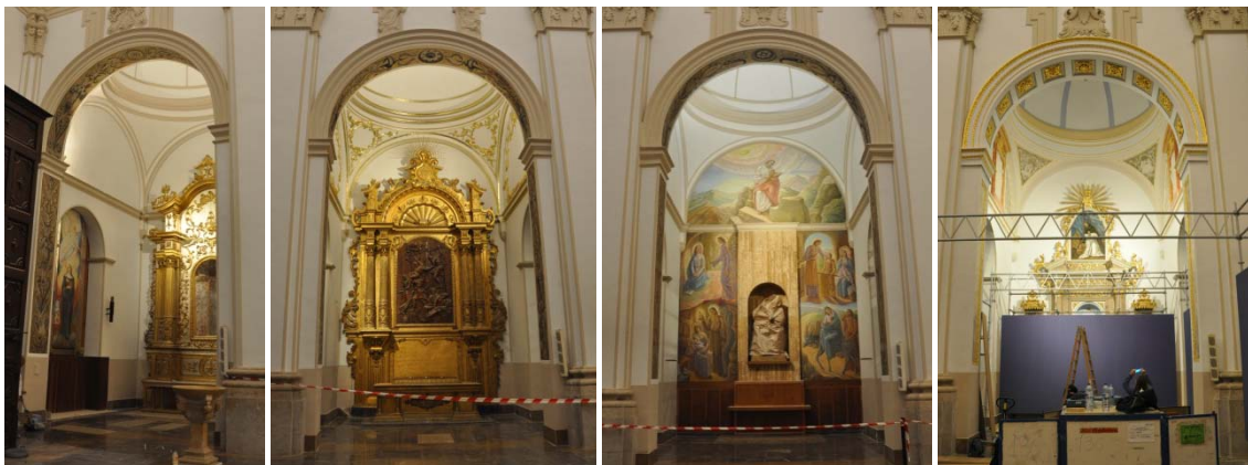
6.922 Estado posterior a la intervención. Capillas lado del Evangelio de la 1ª a la 4ª.
