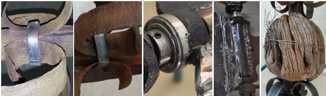
Grupo de imágenes 6.574 Sujeción de cada una de las partes de la veleta a la estructura principal.
