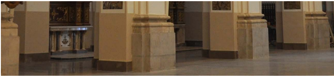
6.731 Estado posterior a la intervención.
