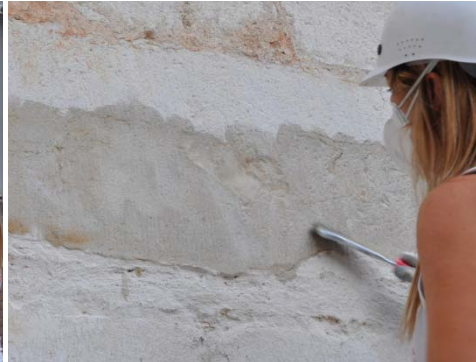
6.157, 6.158 Aplicación detergente desincrustante.
