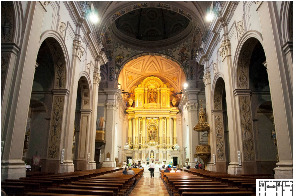
6.930 Estado anterior a la intervención.
