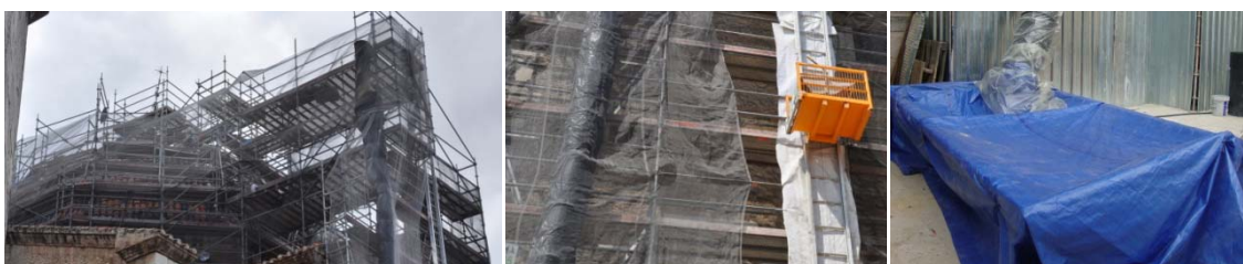
Grupo de imágenes 6.372 Colocación de redes, maquinillo, tubo para escombros y contenedor.
