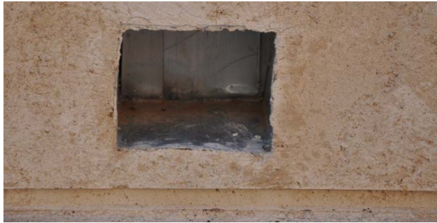
6.334 Estado inicial_ 6.335 Estado final.
