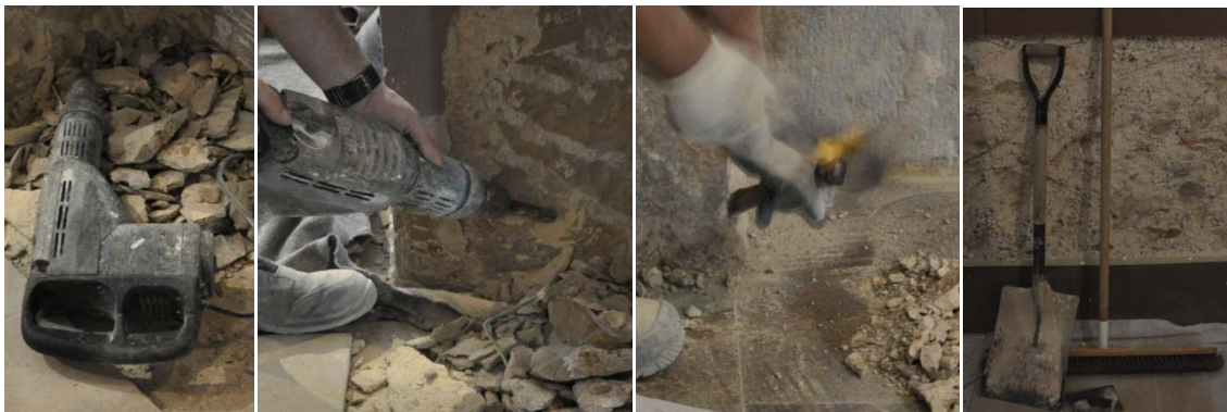
6.717,6.718 Picado con martillo neumático.
