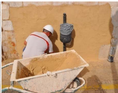
Grupo de imágenes 6.163 Realización revestimiento con mortero de cal.
