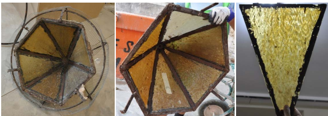
Grupo de imágenes 6.540 Lucernarios a modo de pirámide hexagonal con vidrios triangulares translúcido.
