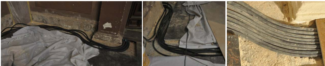
Grupo de imágenes 6.666 Paso de cableado por pavimento del crucero.
