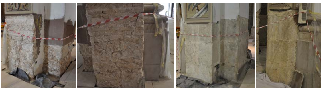
Imágenes 3.61 y 3.62 Pilares.
