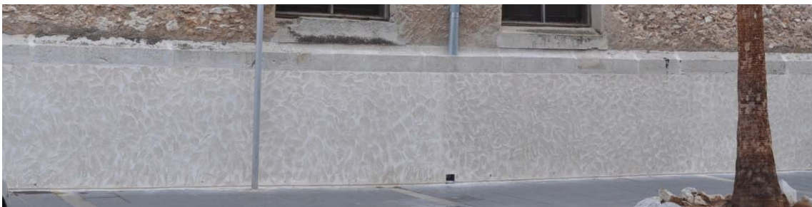
6.339 Estado posterior a la intervención.
