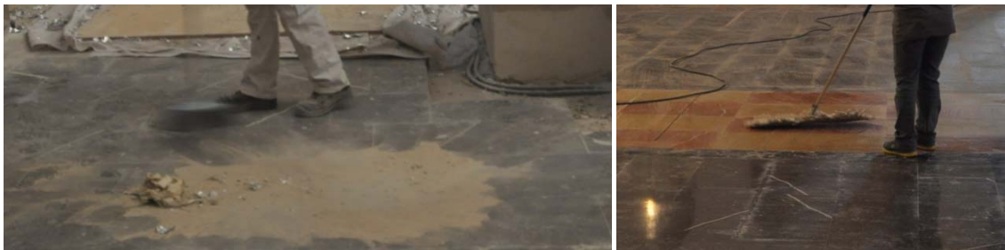
Grupo de imágenes 6.760 Limpieza del polvo de obra.
