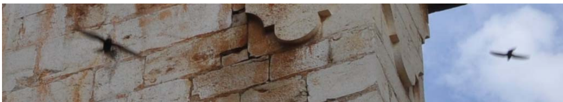
Imagen 8.2 Vencejos alrededor de la iglesia antes de la limpieza de la cornisa.
