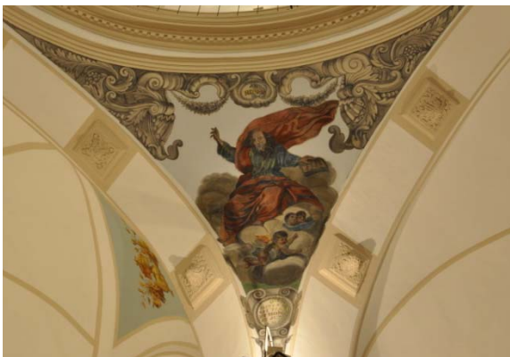
6.917 Estado posterior a la intervención.
