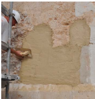
Grupo de imágenes 6.163 Realización revestimiento con mortero de cal.
