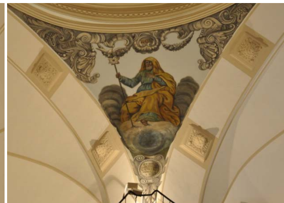
6.918 Estado posterior a la intervención.
