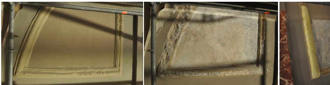
Grupo de imágenes 6.876 Elaboración de moldes de piezas perdidas para su reposición.
