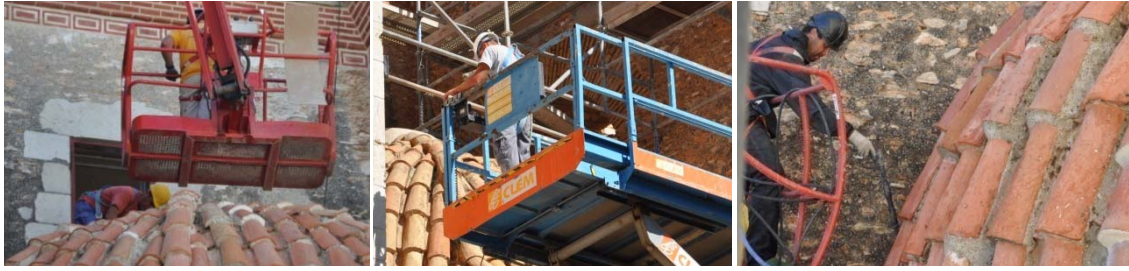
6.437 Trabajos en capillas laterales.
