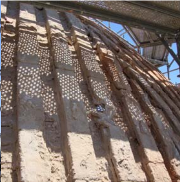
Imagen 3.86 Rastreles de ladrillos
