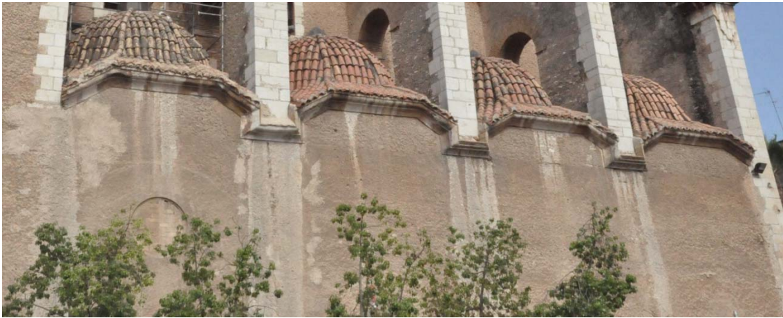
6.186 Estado posterior a la intervención.
