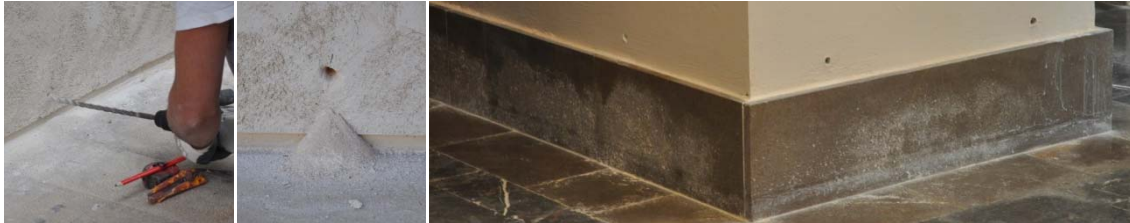
Grupo de imágenes 6.787 Realización de agujeros para el tratamiento antitermitas.
