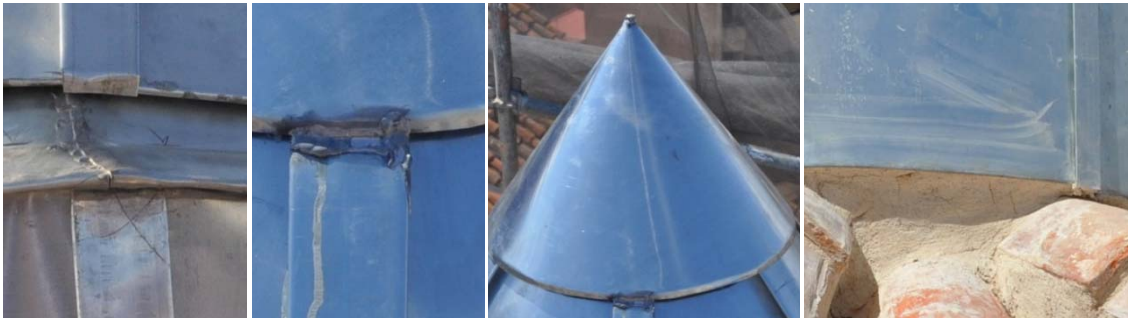
Grupo de imágenes 6.506 Resultado de la soldadura de las láminas de zinc.
