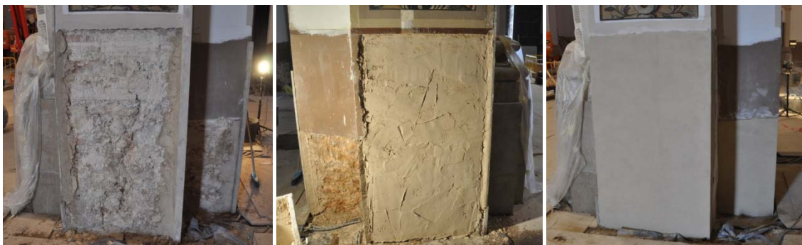
Grupo de imágenes 6.721 Capa de revestimiento y pintado de prueba.
