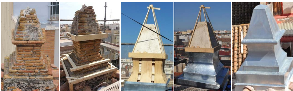
6.518, 6.519, 6.520 Reintegración y estructura de madera.
