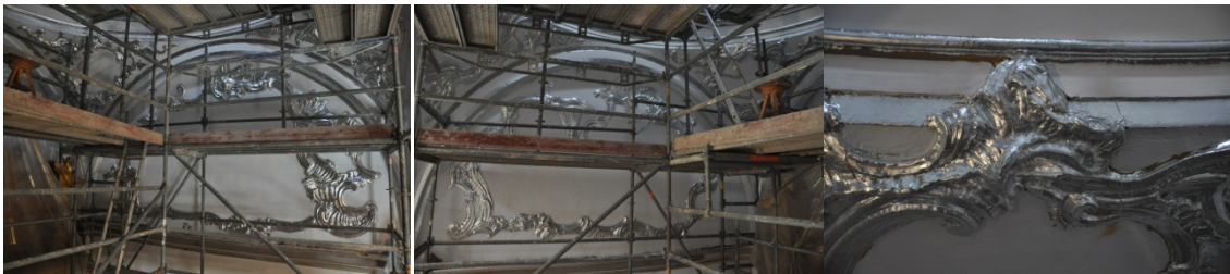
Grupo de imágenes 6.864 Láminas de plata colocadas.
