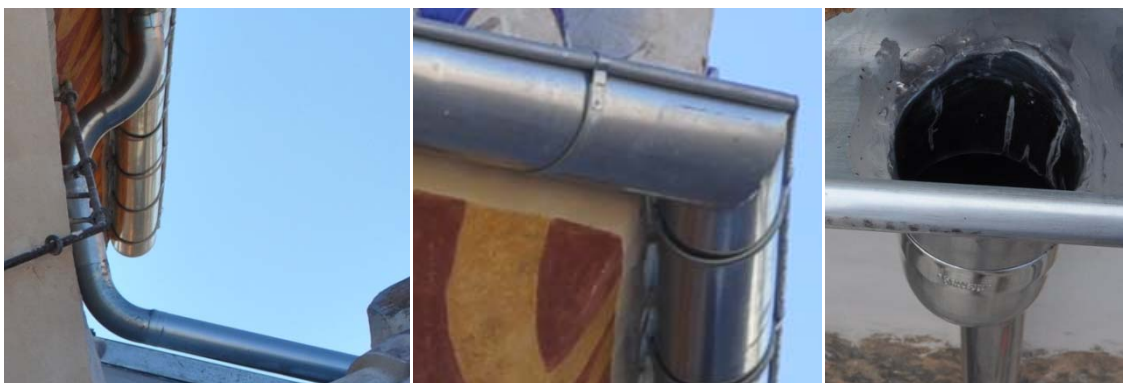
Grupo de imágenes 6.613 Canalón y bajante de zinc de recogida de aguas de la cúpula central.
