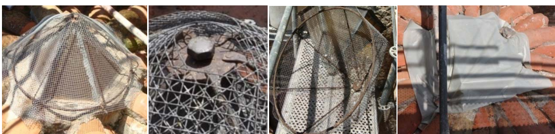
6.533, 6.534, 6.535 Retirada lucernarios deteriorados.
