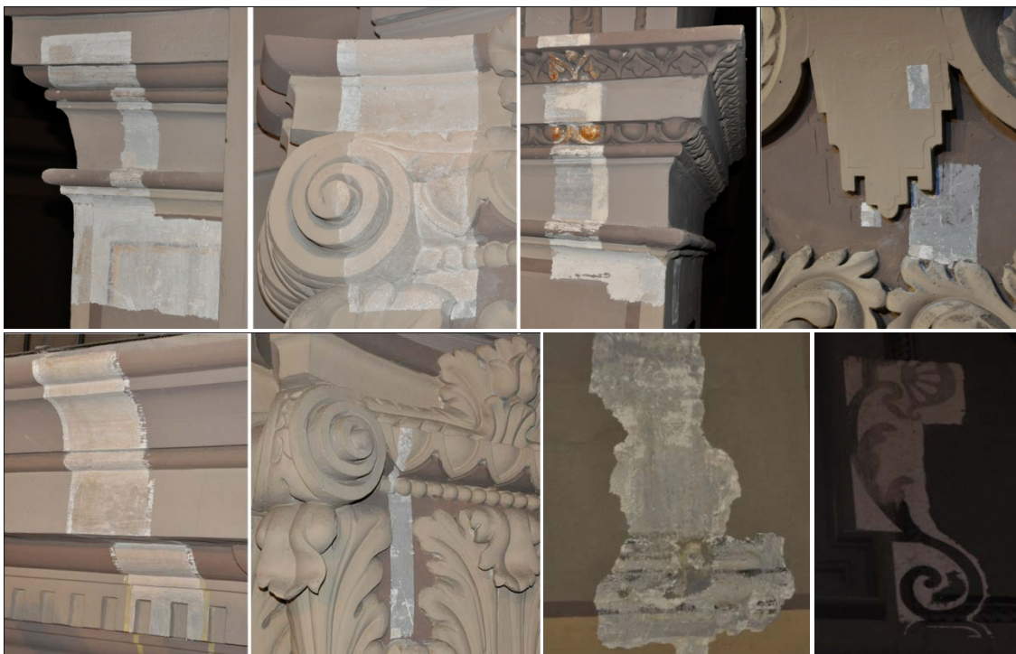
Grupo de imágenes 6.815 Catas en volutas, cornisas, pilares y pilastras.
