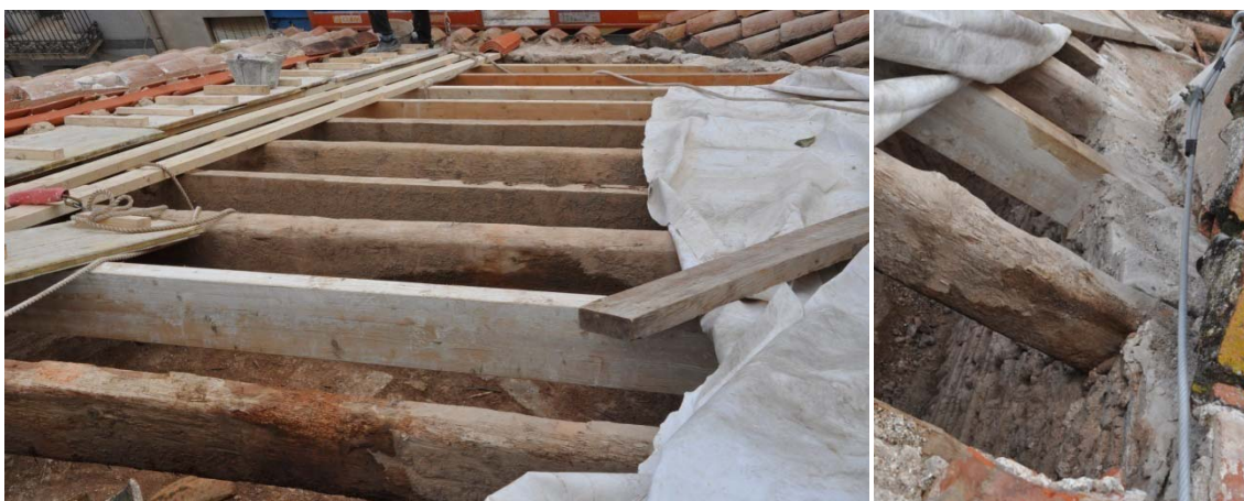
Grupo de imágenes 6.420 Nuevas vigas colocadas y comienzo de retejado.
