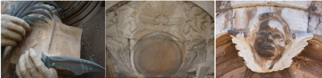
Grupo imágenes 6.39 Limpieza con proyección de agua.
