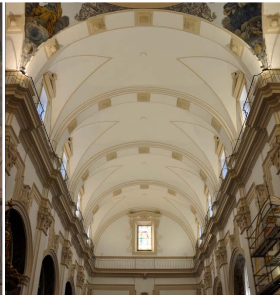
6.904 Estado posterior a la intervención.
