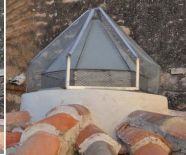
6.554 Armazón sujeto a la linterna.
