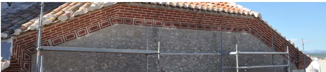
6.276 Estado posterior a la intervención.
