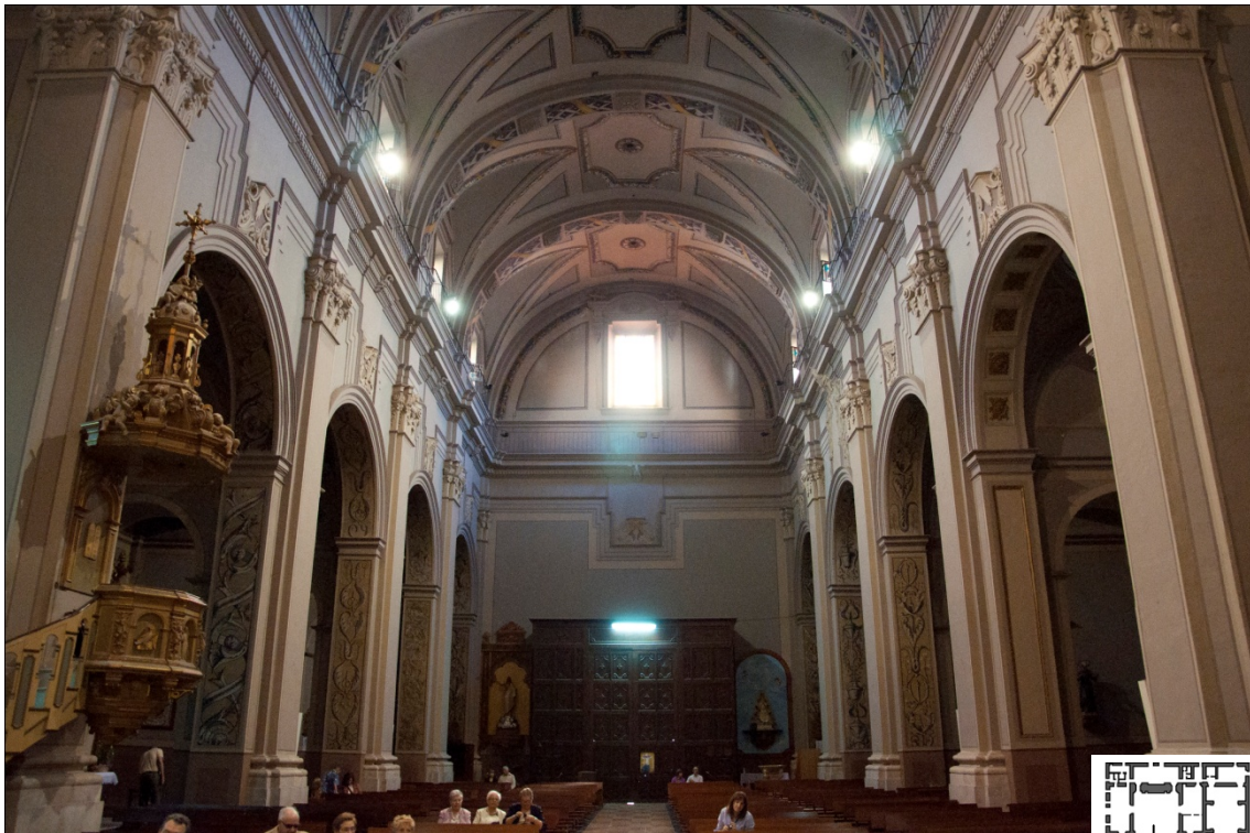
6.932 Estado anterior a la intervención.
