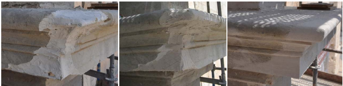
Grupo de imágenes 6.61 Proceso aplicación mortero y resultado final.
