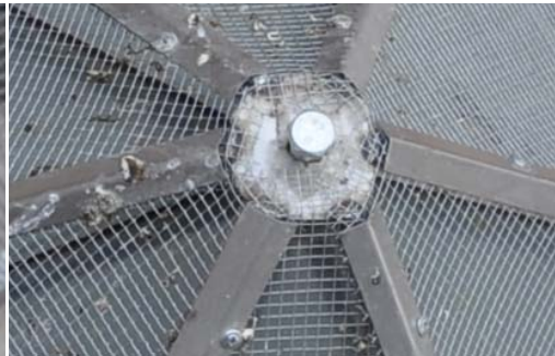
6.556, 6.557 Anclaje de la estructura de protección atornillada al lucernario.
