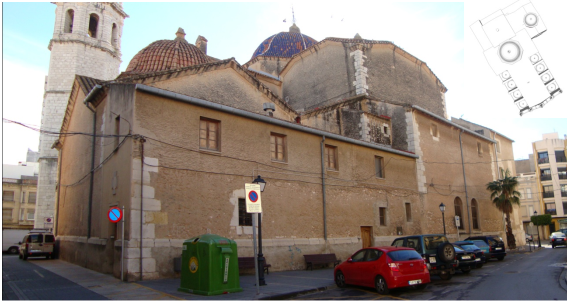
6.649 Estado anterior a la intervención.
