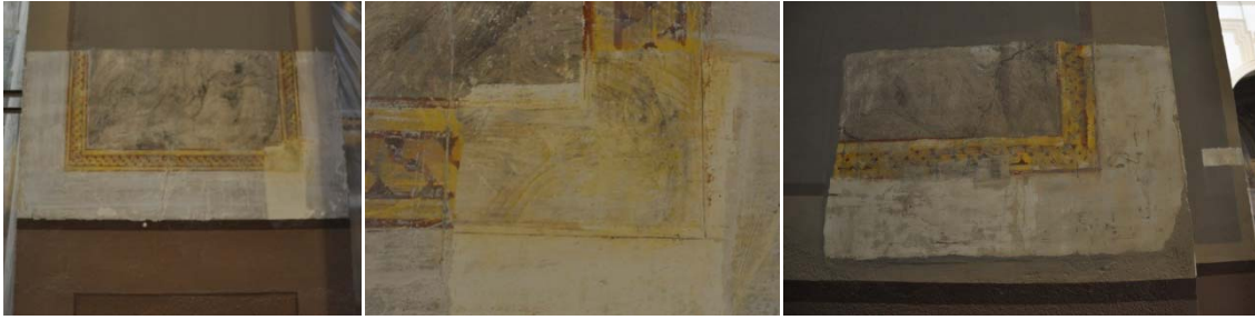
Grupo de imágenes 6.807 Catas en capilla 3 lado del Evangelio.
