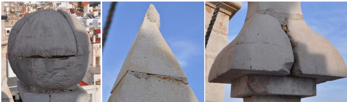
Grupo de imágenes 6.236 Estado inicial.
