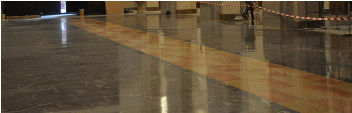
6.770 Estado posterior a la intervención.
