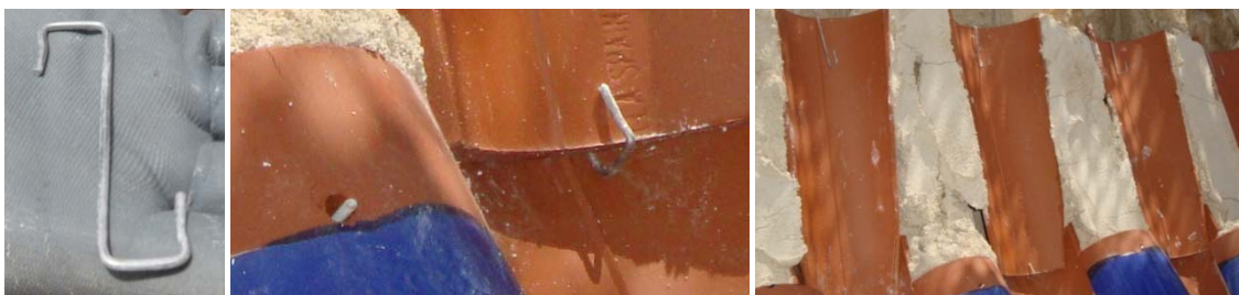
6.389 Gancho. 6.390,6.391 Colocación ganchos y tetón de fibra.
