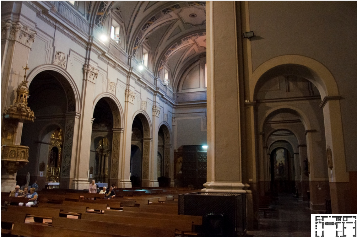
6.934 Estado anterior a la intervención.
