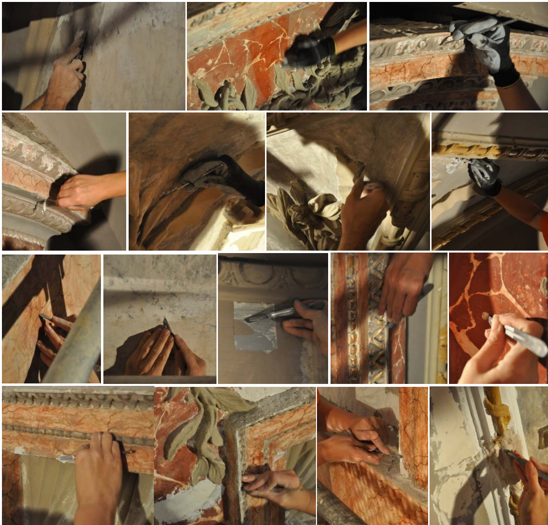
Grupo de imágenes 6.875 Trabajos de limpieza de estucos y molduras con algodón y bisturí.
