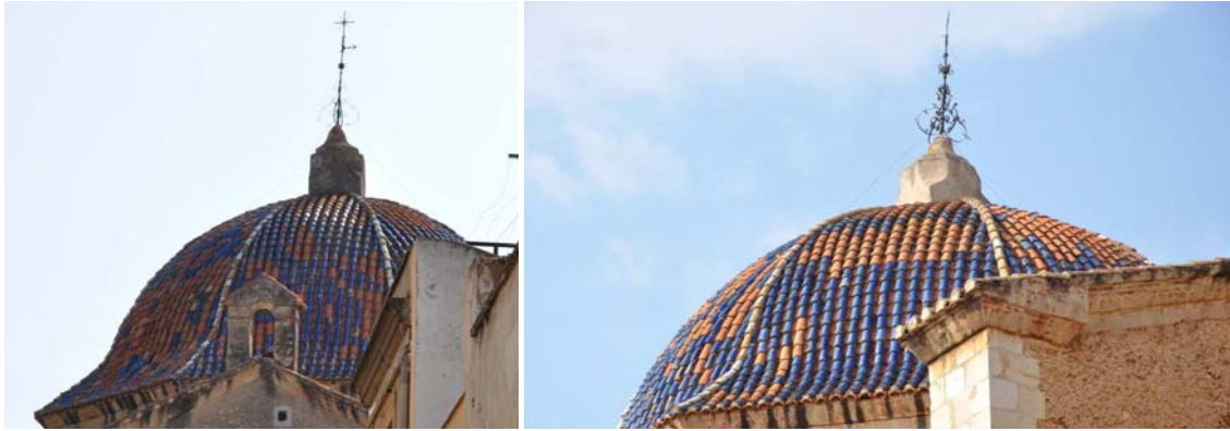
Grupo de imágenes 6.403 Estado anterior a la intervención.
