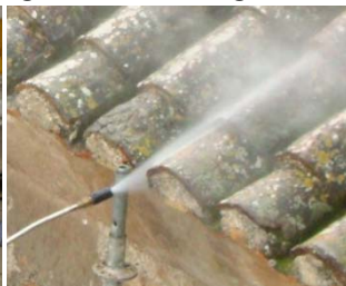
6.207 Hidrolimpiadora "Kärcher". 6.208, 6.209 Proceso de limpieza.
