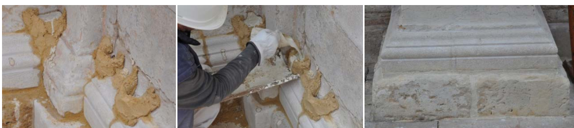
6.80, 6.81 Relleno de mortero.
