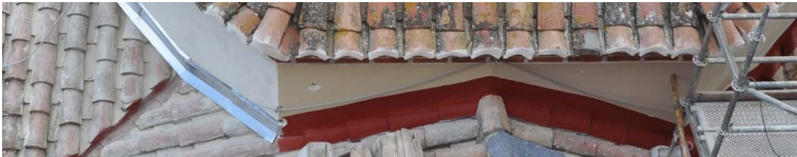
6.638 Estado posterior a la intervención.
