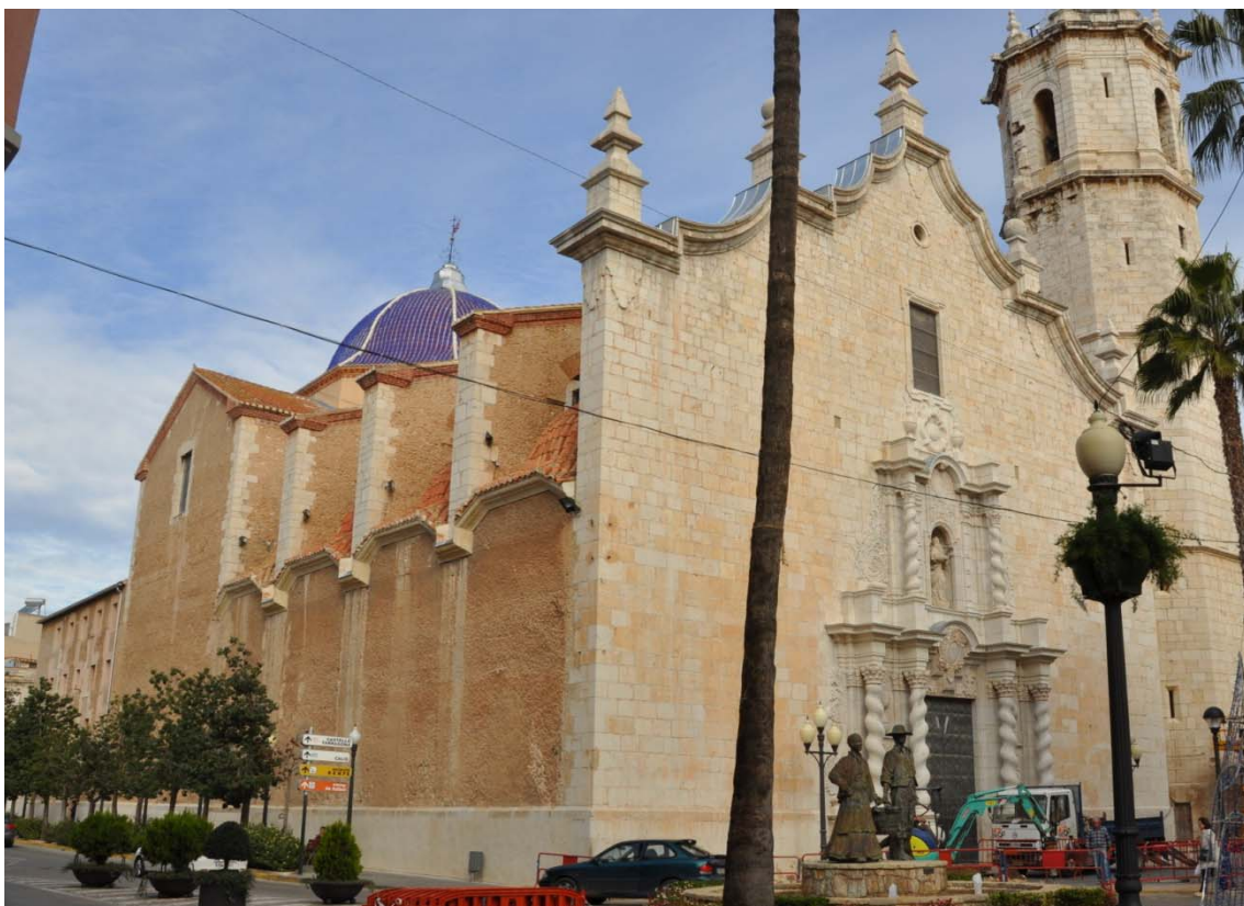
6.642 Estado posterior a la intervención.
