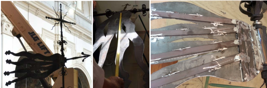
6.568, 6.569 Marcado de líneas para colocación pletinas.
