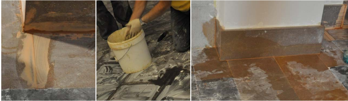
Grupo de imágenes 6.759 Pintado de las juntas entre baldosas.
