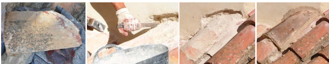
6.430, 6.431 Retirada de tejas.
