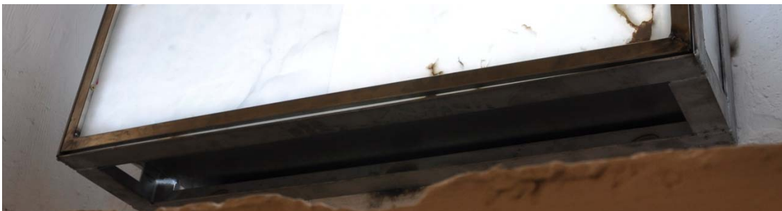
6.775 Baberos de zinc colocados en los marcos que sujetan el alabastro.
