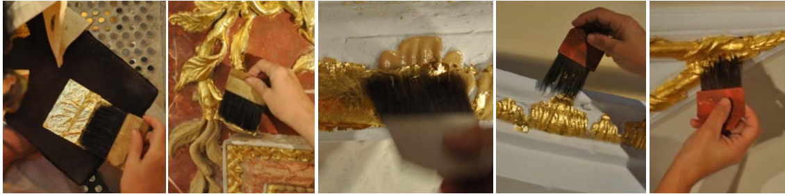
Grupo de imágenes 6.885 Colocación de las láminas de pan de oro.
