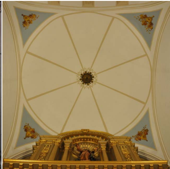
6.906 Estado posterior a la intervención.
