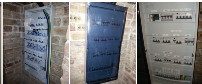
6.673, 6.674, 6.675 Nuevo cuadro eléctrico.
