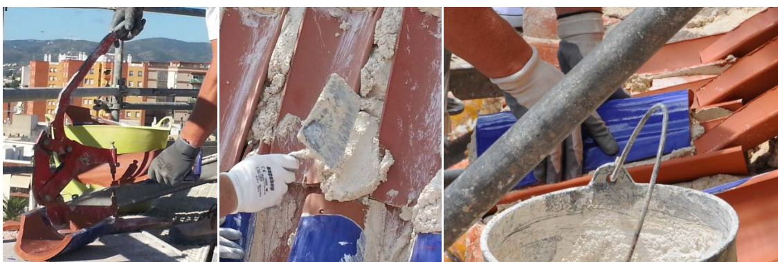
6.392 Corte de tejas. 6.393,6.394 Colocación tejas cobija.
