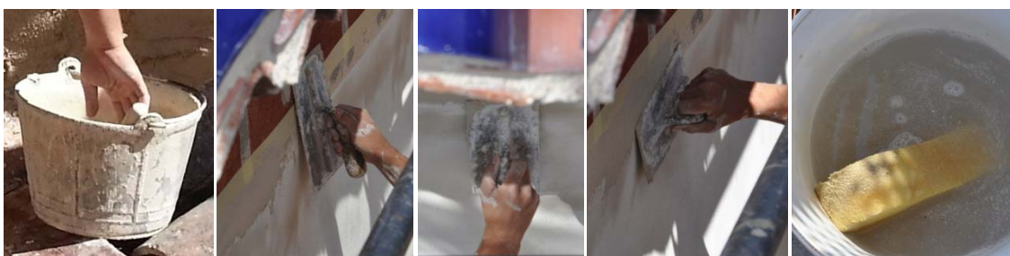
Grupo de imágenes 6.472 Realización del nuevo revestimiento con mortero de cal.
