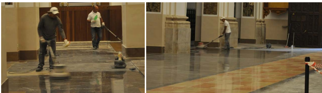
Grupo de imágenes 6.764 Trabajos de pulido.
