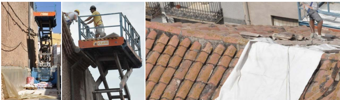
6.413, 6.414 Trabajos de retirada de tejas.
