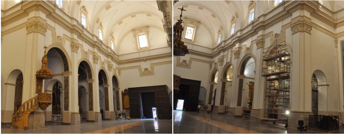
6.902 Estado posterior a la intervención.
