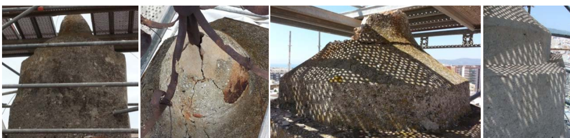
Grupo de imágenes 6.494 Retirada de la veleta y limpieza pináculo de la cúpula central.
