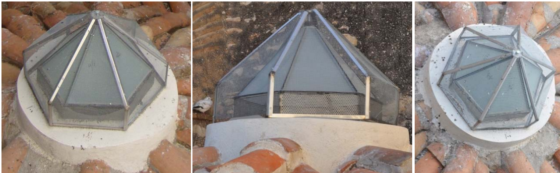
Grupo de imágenes 6.559 Estado de los lucernarios después de la intervención.
