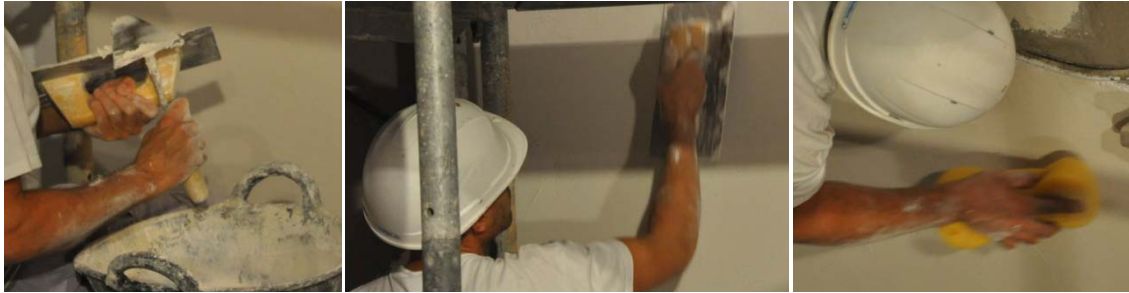
Grupo de imágenes 6.891 Trabajos de enlucido en los paramentos de la capilla.
