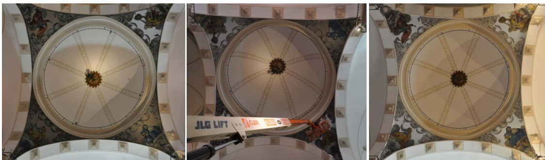
Grupo de imágenes 6.833 Proceso de pintado de las pechinas de la cúpula central.
