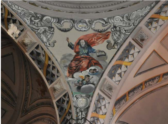
6.915 Estado anterior a la intervención.
