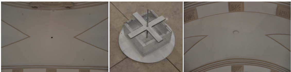
Grupo de imágenes 6.900 Colocación de tapas en los agujeros de las bóvedas.
