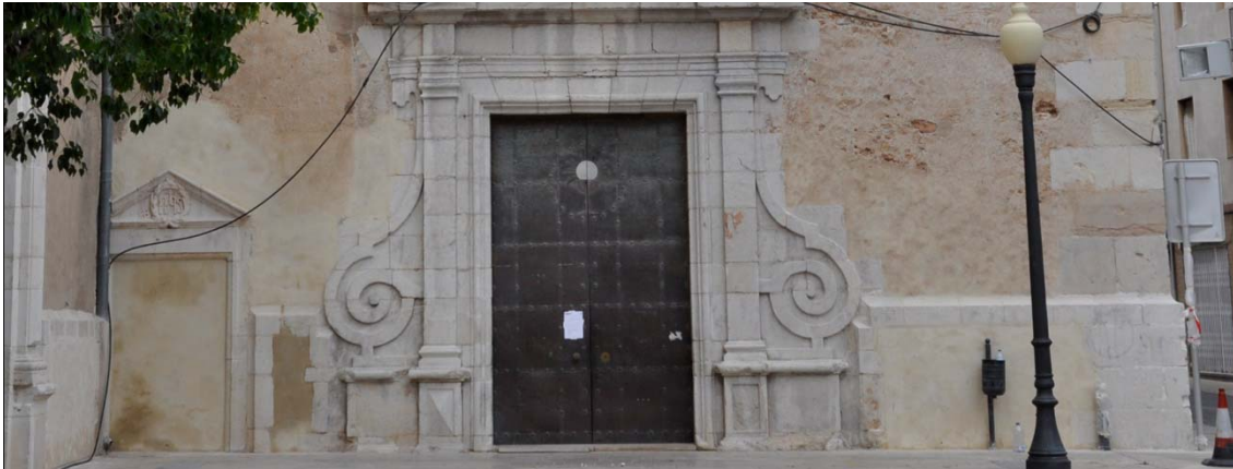
6.170 Parte de la fachada con la pátina realizada.
