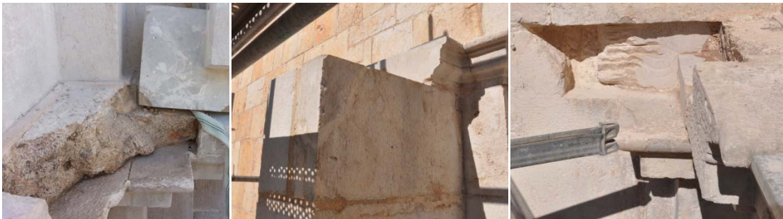
Grupo de imágenes 6.65 Retirada de piezas en mal estado.
