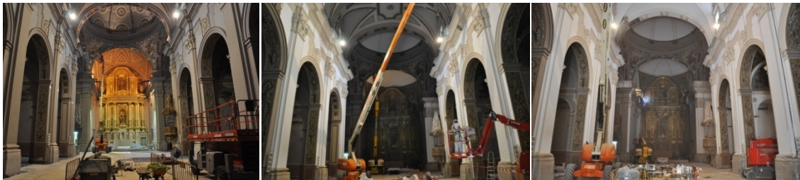
Grupo de imágenes 6.824 Proceso de pintado de los paramentos de la nave central.
