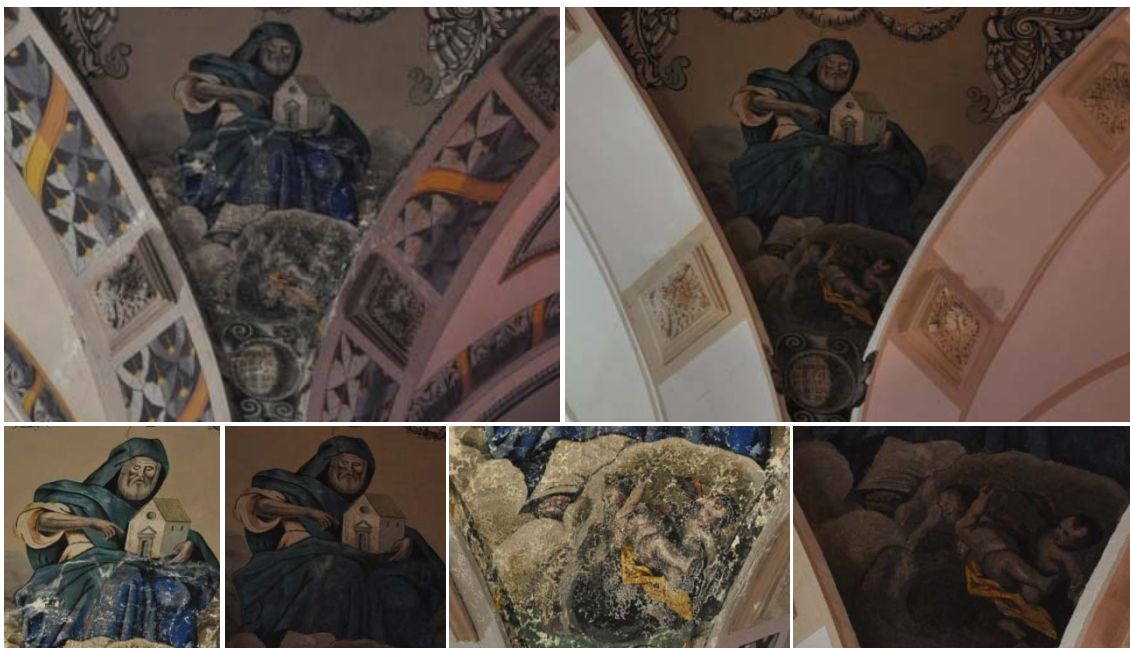
Grupo de imágenes 6.835 Recuperación de la pechina afectada por las humedades.
