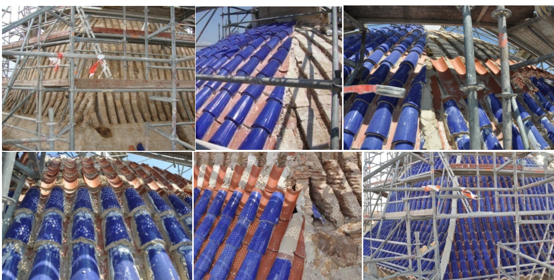
Grupo de imágenes 6.395 Proceso de montaje de tejas de la cúpula.
