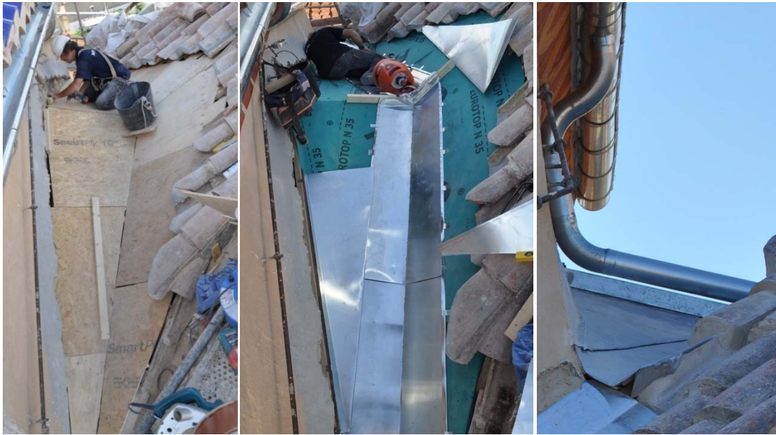
6.456 Estructura de madera. 6.457 Colocación tela impermeable y zinc. 6.458 Encuentro finalizado.
