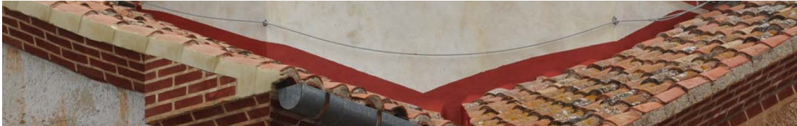
6.636 Estado posterior a la intervención.
