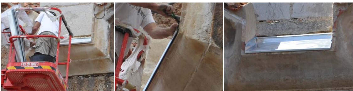
Grupo de imágenes 6.626 Trabajos de colocación de las bandejas de zinc.
