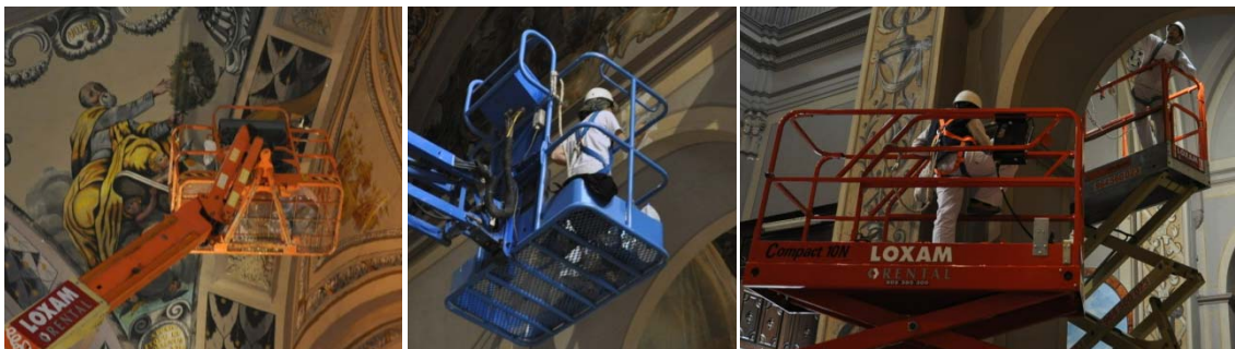
Grupo de imágenes 6.804 Trabajos de realización de catas.
