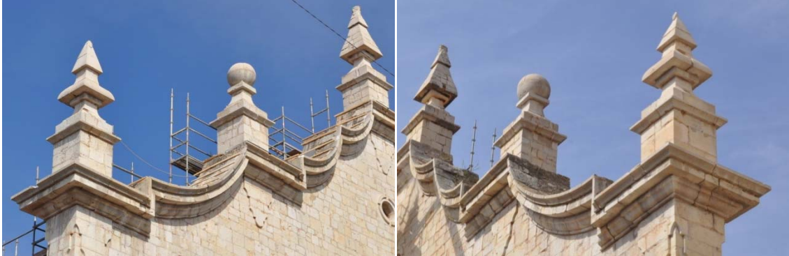
Grupo de imágenes 6.265 Estado inicial.
