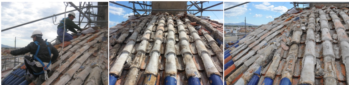
Grupo de imágenes 6.376 Retirada de tejas por gajos, desde pináculo a faldón.
