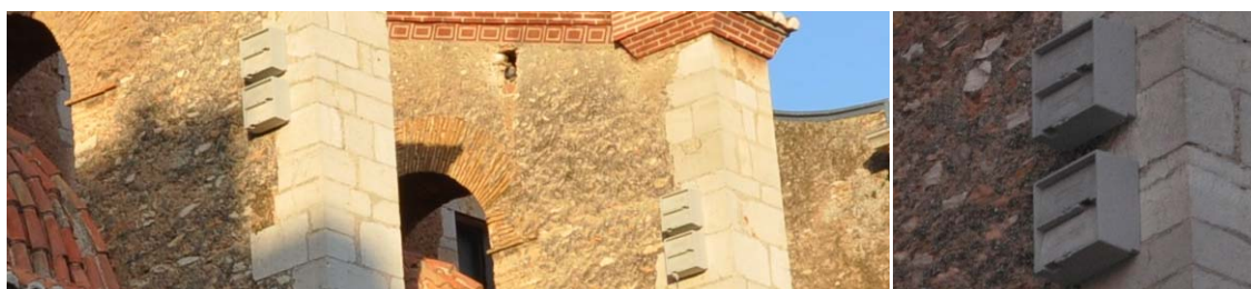
Grupo de imágenes 6.213 Colocación de 8 nidos dobles en los contrafuertes de la fachada suroeste.
