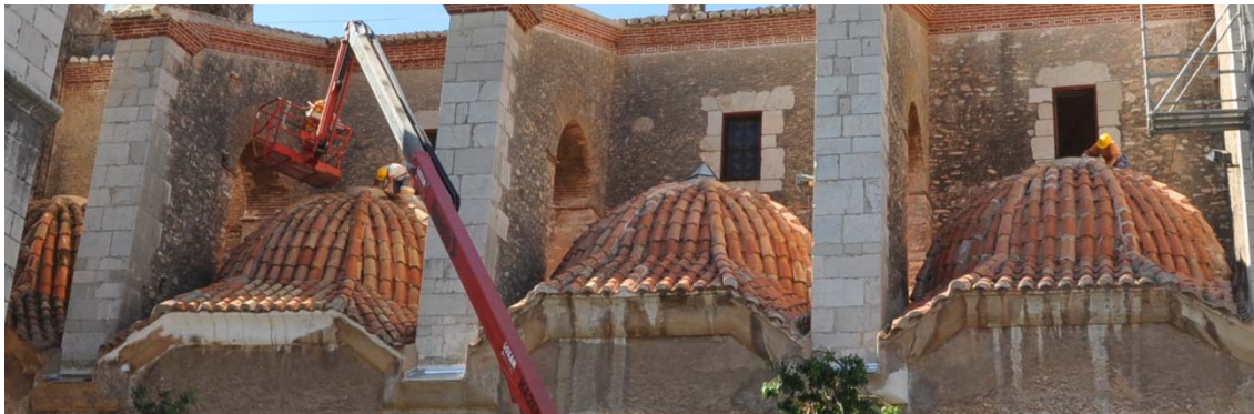
6.548 Trabajos en las linternas de las capillas laterales.
