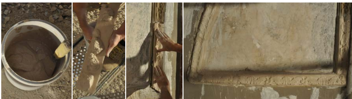
Grupo de imágenes 6.883 Colocación de molduras con mortero.
