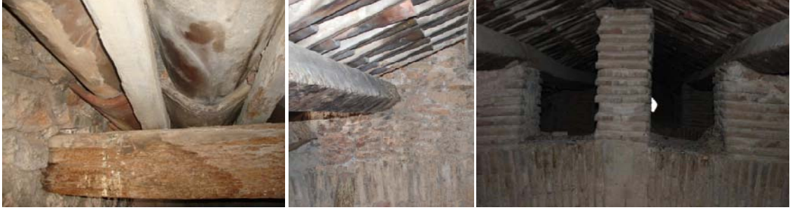
Grupo de imágenes 3.71 Espacio entre la bóveda y la cubierta.
