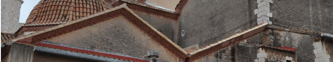
6.272 Estado posterior a la intervención.
