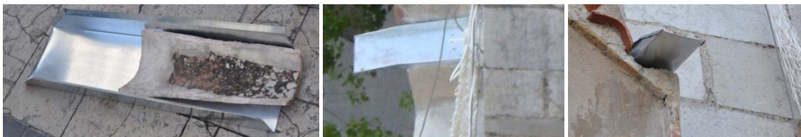
Grupo de imágenes 6.625 Prueba canalón zinc.
