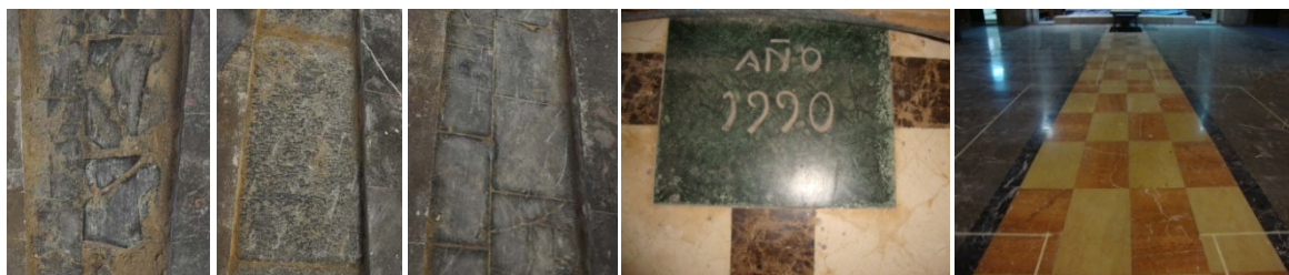
Grupo de imágenes 4.35 Antiguo pavimento en catas Grupo de imágenes 4.36 Actual pavimento
