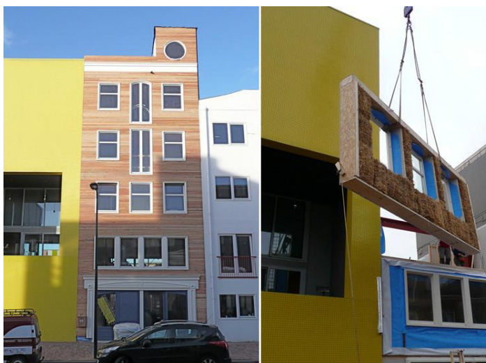
Fig. 77 Edificio realizado con sistemas modulares prefabricados en Ámsterdam (2009), fuente: presentación "Use of Straw in Dutch architecture".
