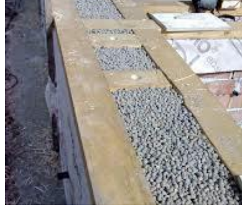
Fig. 56 Sobrecimentación de bloque de hormigón.
