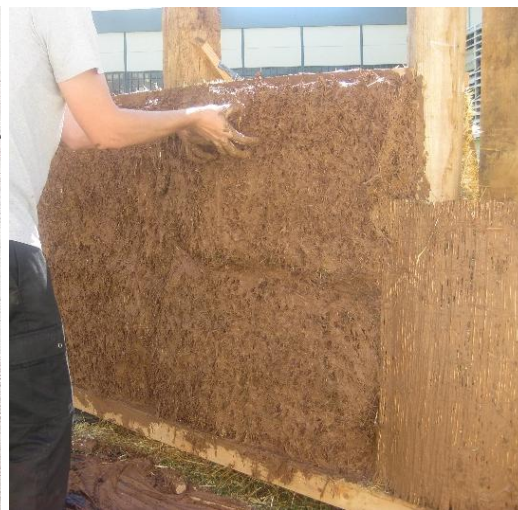
Fig. 42 Aplicación de la barbotina sobre el muro de paja.
