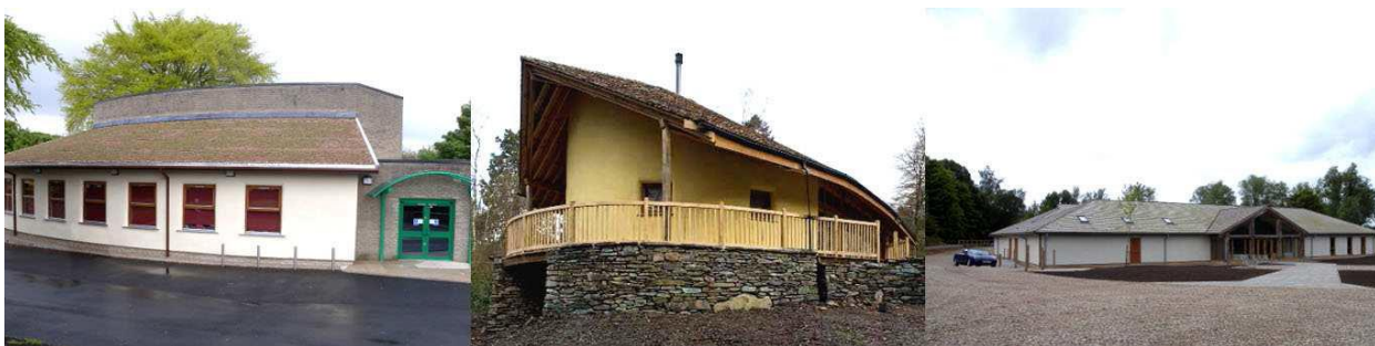
Fig. 51 Edificaciones auto portantes por Amazon Nails en el Reino Unido.
