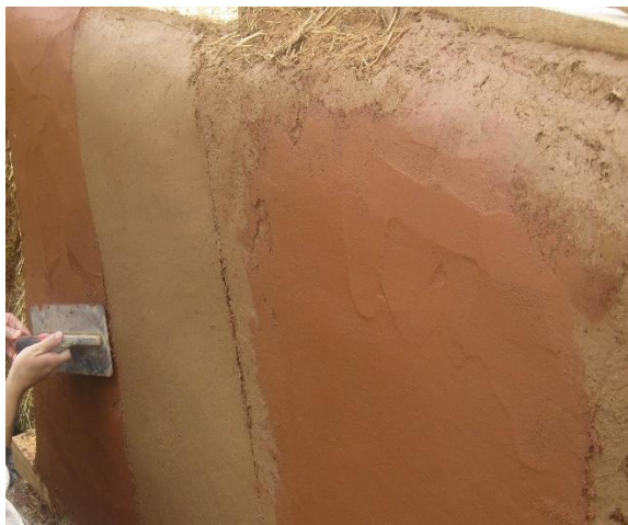
Fig. 47 Aplicación de capa de acabados con distintos
