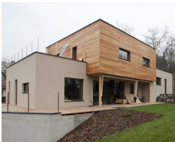
Fig. 79 Vivienda realizada con prefabricados de paja en Stupava, Eslovaquia, diseñada por el arquitecto Bjork Kierulf. - www.erikbjorkarchitect.net
