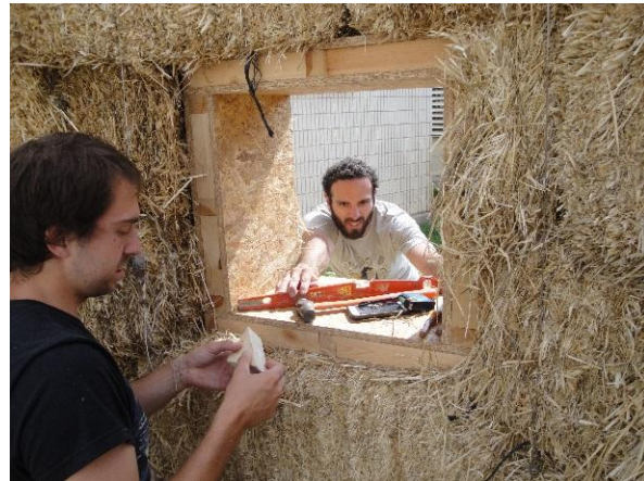
Fig. 63 Nivelado de ventana en sistema Nebraska.
