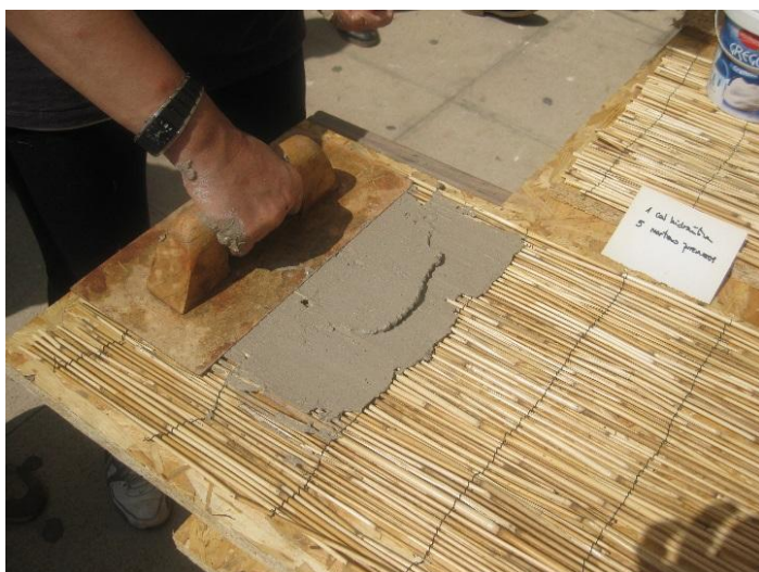
Fig. 50 Aplicación de revocos de acabados para muestras.
