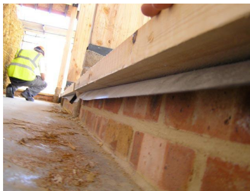
Fig. 54 Sobrecimentación ladrillo - www.casadepaja.es
