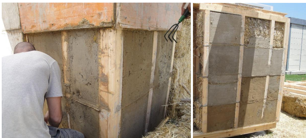
Fig. 76 Proceso de construcción muro GREB
