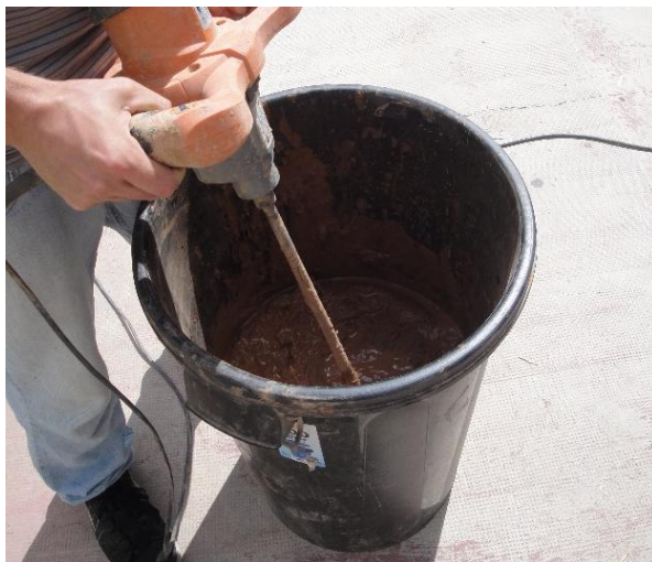
Fig. 41 Mortero para capa de imprimación (barbotina).
