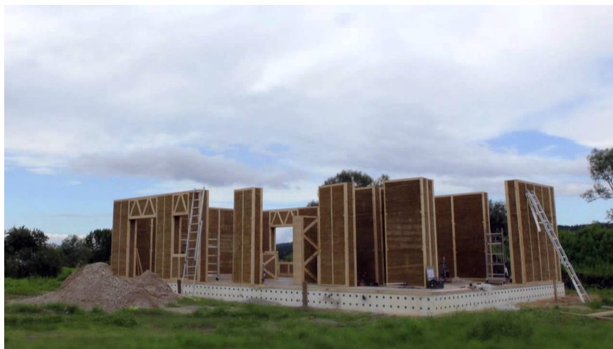
Fig. 81 Montaje de sistemas modulares, fuente: www.ecococon.it
