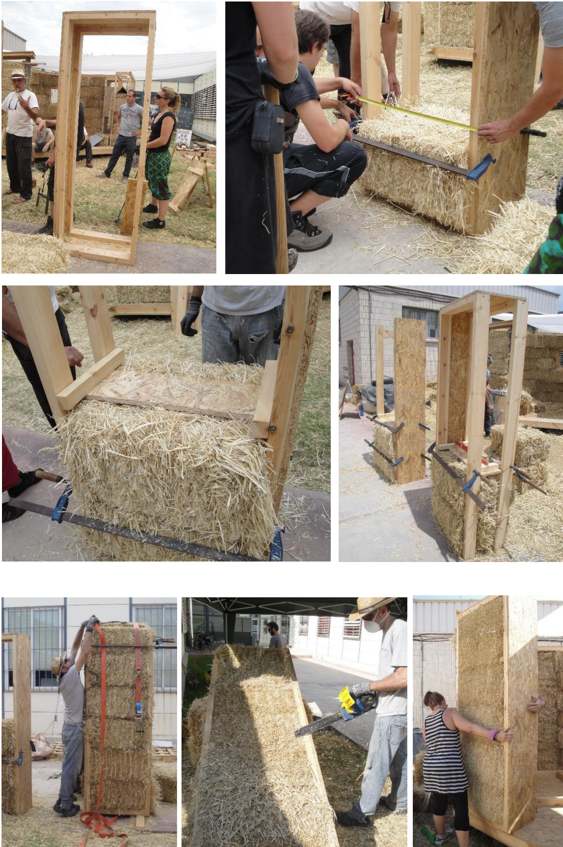
Fig.82 Proceso de construcción de módulos prefabricados.
