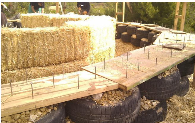
Fig. 58 Marco inferior con clavos para agarre – www.casadepaja.es
