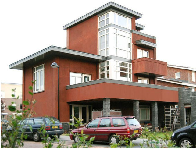
Fig. 78 Edificio realizado con sistemas modulares prefabricados en Kampen (2011), fuente: presentación "Use of Straw in Dutch architecture".
