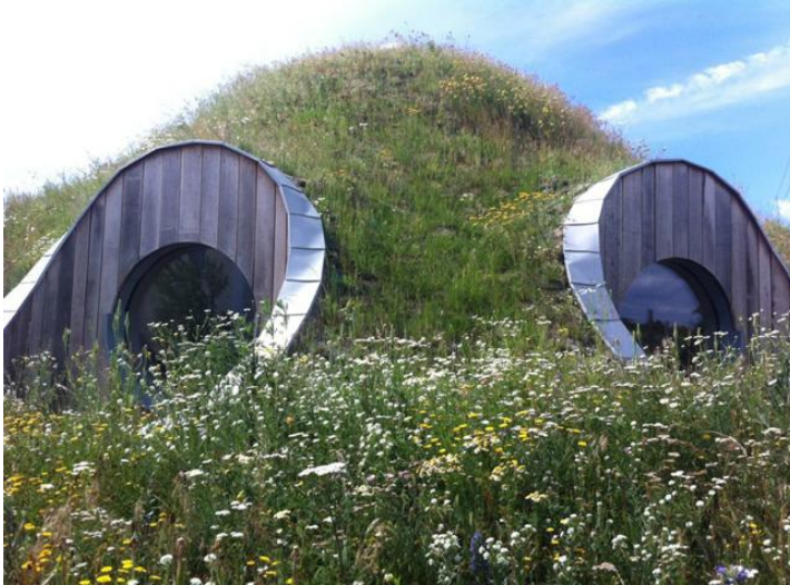
Fig. 52 Domo de balas de paja del arquitecto G. Minke en Eslovaquia.
