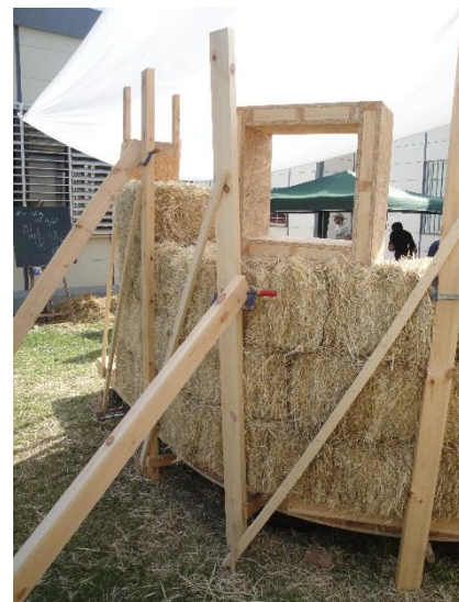
Fig. 65 Guías para mantener el plomo.
