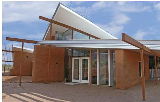
Fig. 5 casa de paja del arquitecto Tom Hahn – ebsteam.com.au
