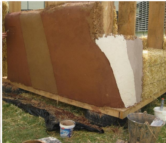
Fig. 48 Resultado de diferentes morteros de acabado.
