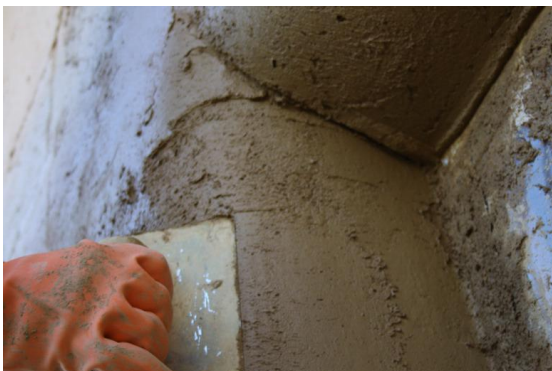
Fig. 34 Revoco de arcilla en esquina – www.casadepaja.es
