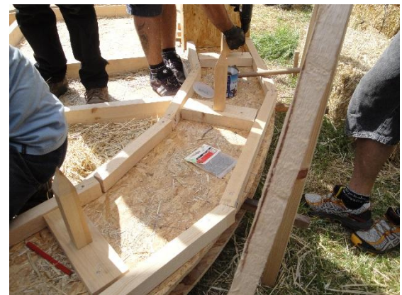
Fig. 59 Marco inferior con estacas de agarre.
