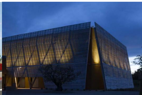
Fig.11 Auditorio construido con balas de paja, en Mazan, Francia por el arquitecto Olivier Gaujard (2012)
