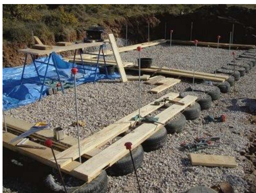
Fig. 53 Sobrecimentación neumáticos - www.casadepaja.es
