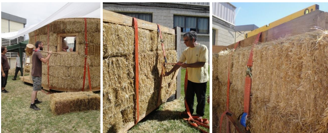
Fig. 67 Compresión de muro Nebraska con cinchas de camión.
