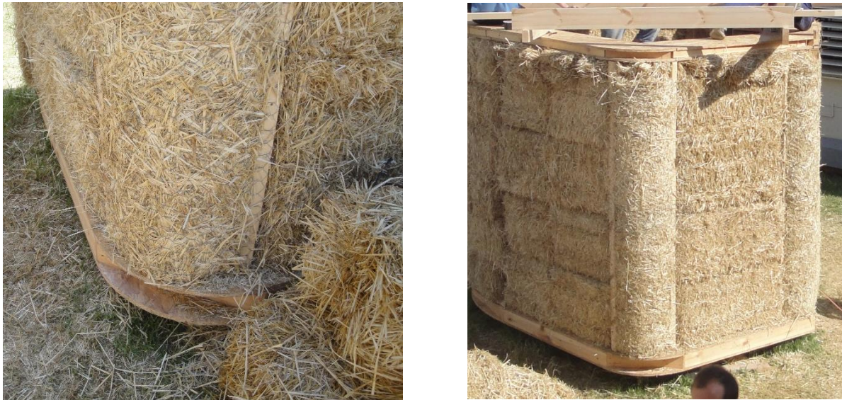
Fig. 86 Proceso de construcción muro CUT
