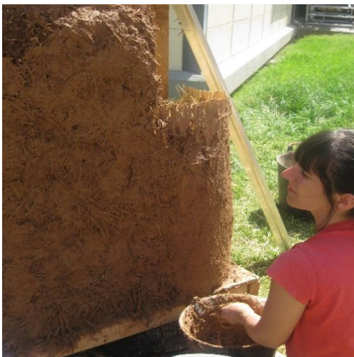
Fig. 45 Aplicación de la capa de cuerpo.
