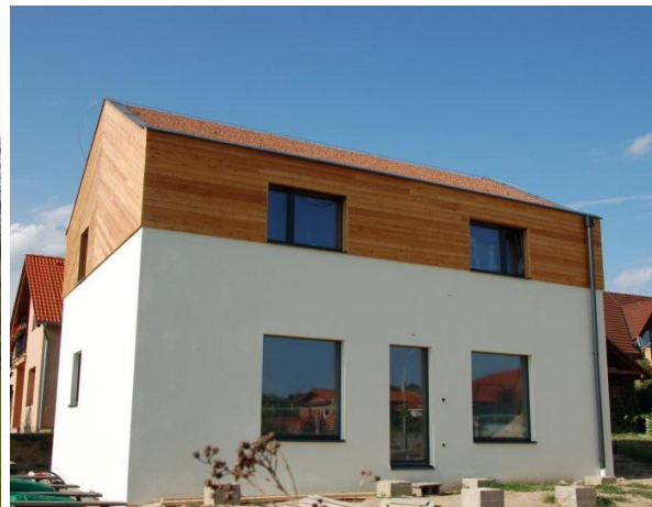
Fig. 80 Vivienda realizada con prefabricados de paja en Altenburg, Alemania, diseñada por el arquitecto Bjork Kierulf.
