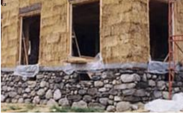
Fig. 55 sobrecimentación de piedra . presentación Okambuva
