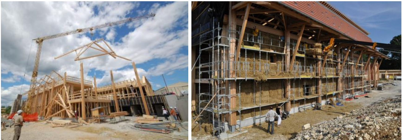
Fig. 73 Proceso de montaje de una casa de paja con postes y vigas estructurales – www.compaillons.eu
