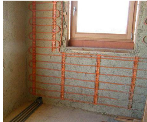
fig. 89 Muro radiante – www.casadepaja.es
