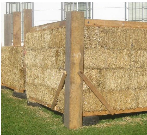
Fig. 64 Esquina de Nebraska con junta de madera para mantener el plomo.
