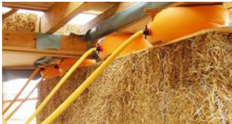
Fig. 72 Sistemas de compresión de muros en métodos donde la paja es relleno. Presentación Okamvuva.
