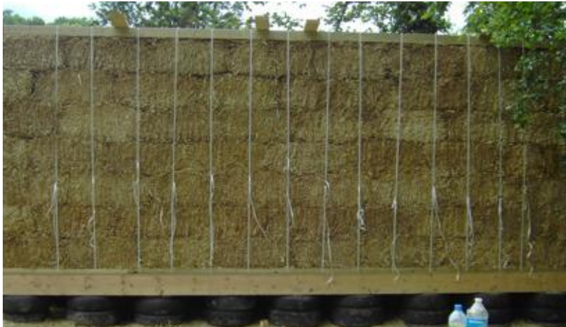
Fig. 68 Atado de muro comprimido con cables – www.casadepaja.es
