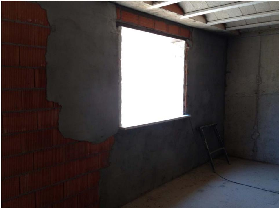
*Fig. 2.14 - Hoja exterior – Enfoscado cara interior*
