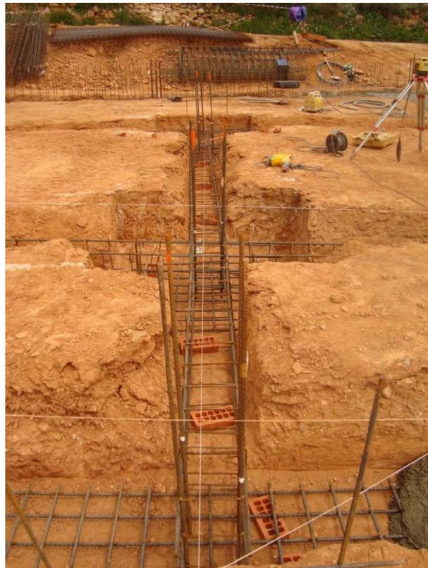
*Fig. 2.05 – Zapatas aisladas arriostradas*
