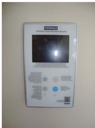
*Fig. 2.51 – Placa base videoportero planta baja*
