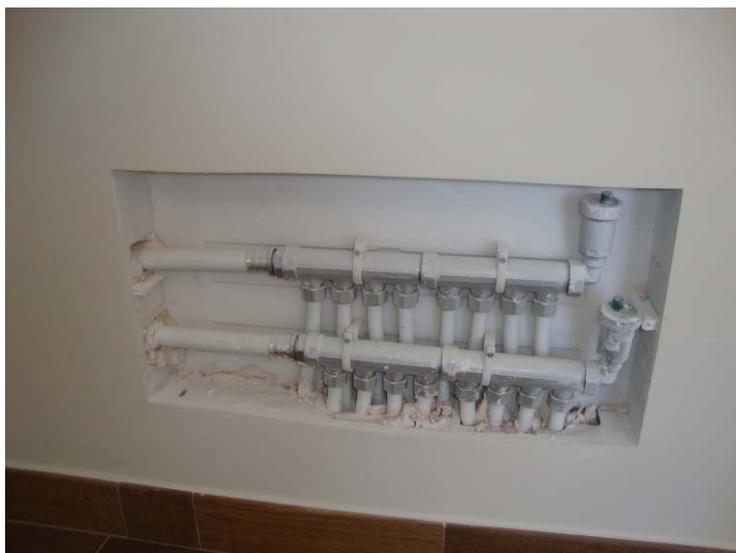
*Fig. 2.44 – Registro purgadores calefacción planta baja*
