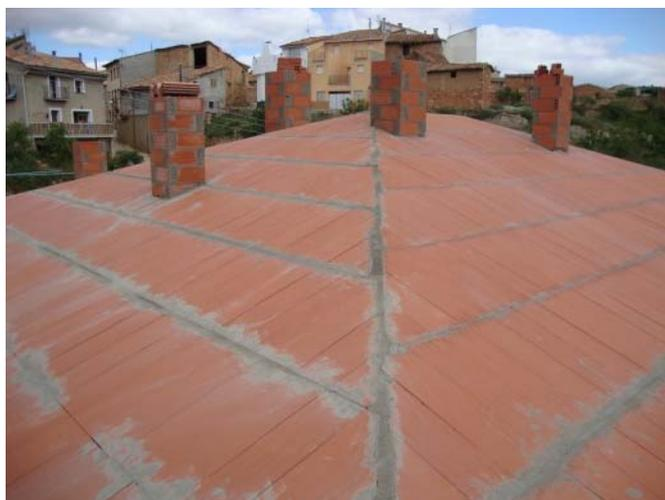
*Fig. 2.22 – Tablero machihembrado*
