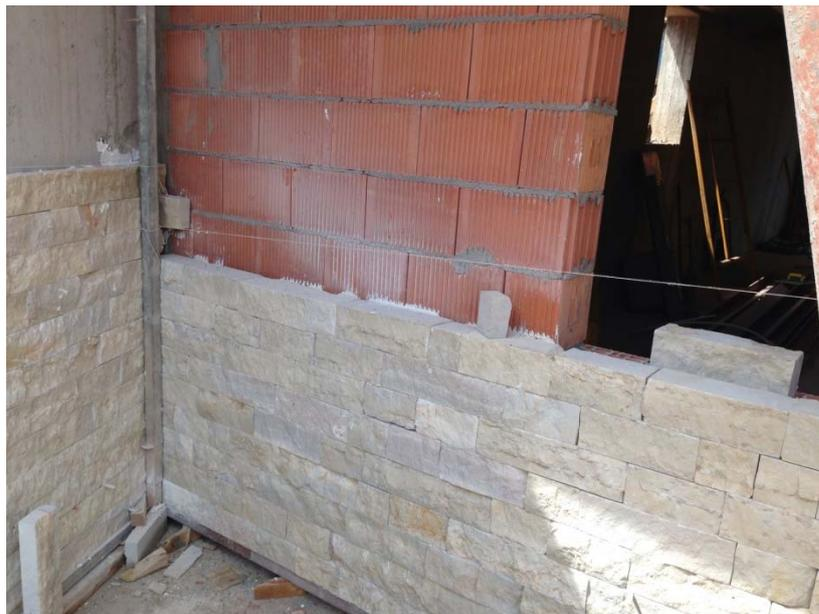
*Fig. 2.13 – Colocación revestimiento piedra natural*
