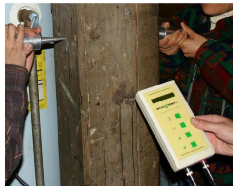
Figura 1.6: Ensayo de ultrasonidos sobre pilar de madera (Bobadilla, I.)
