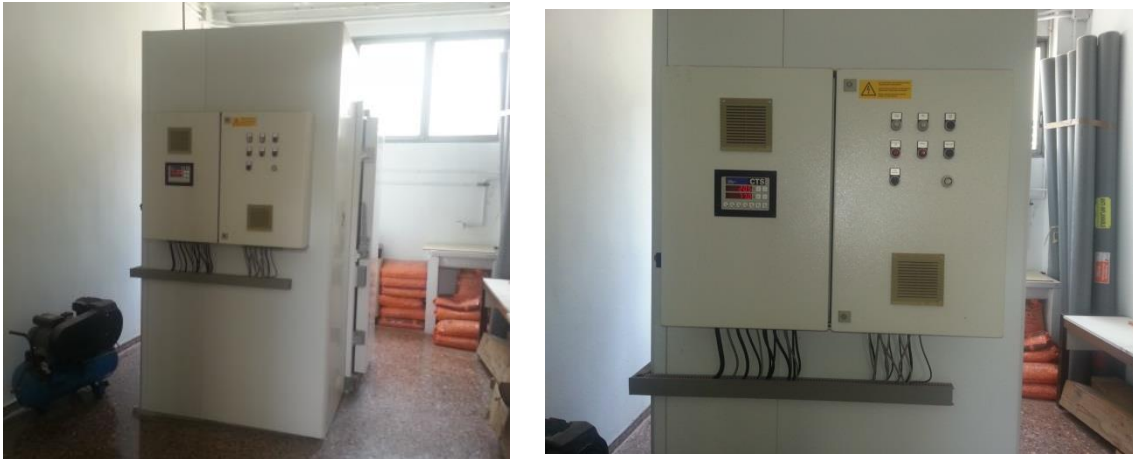
Figura 2.18: Cámara climática utilizada para los ensayos.
