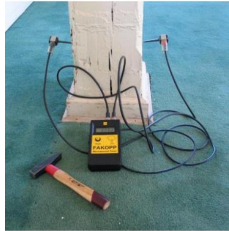
Figura 1.5: Ensayo con ondas inducidas sobre pilar de madera. (Bobadilla, I.)
