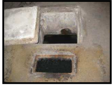
Ilustración 104. Fotografía arqueta no revestida. Fuente: Propia.
