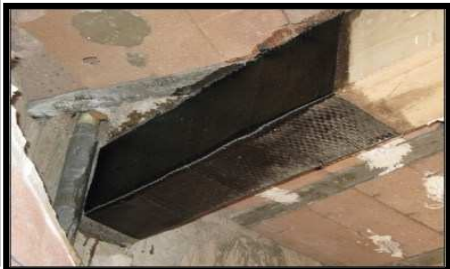
Ilustración 15. Refuerzo de fibra de carbono en viga. Fuente: Internet.
