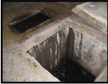
Ilustración 103. Fotografía arqueta no revestida. Fuente: Propia.
