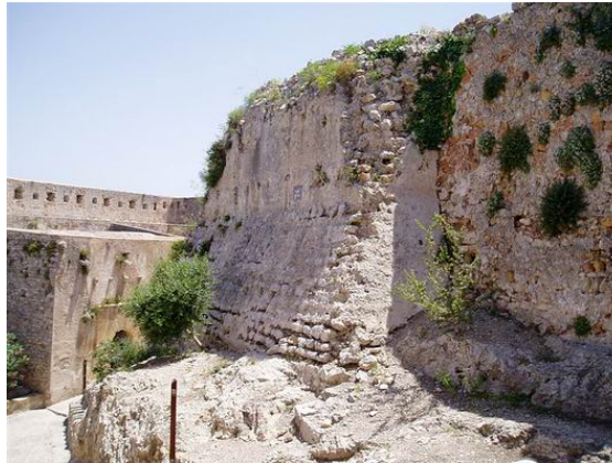
Base de la torre de San Juan
