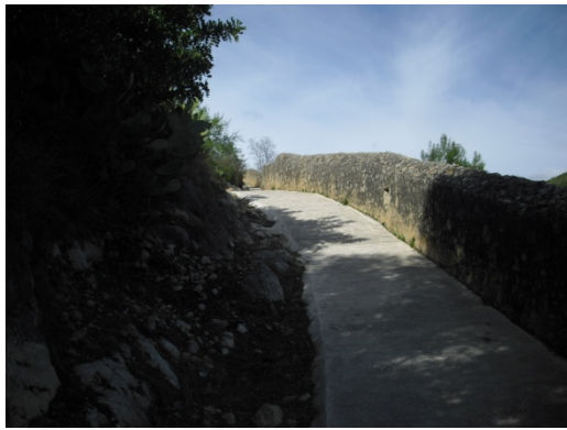
Camino de acceso
