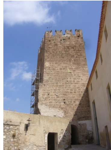
Torre de acceso
