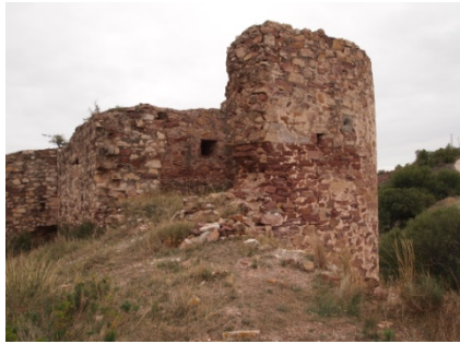
Torre de defensa de la muralla
