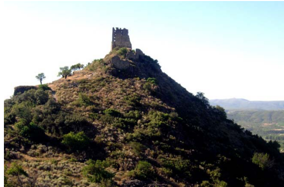
Vista general desde el norte
