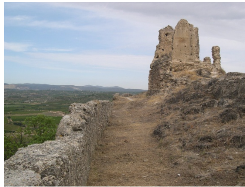
Torre sur y paso de ronda
