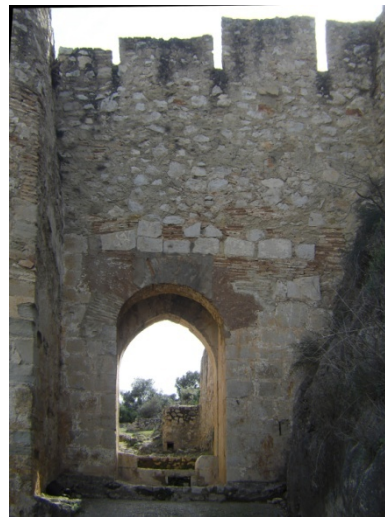
Puerta de acceso desde el exterior
