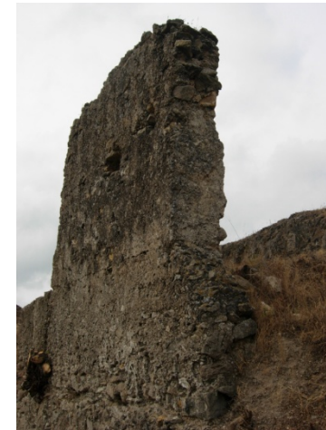
Muro este de la celoquia
