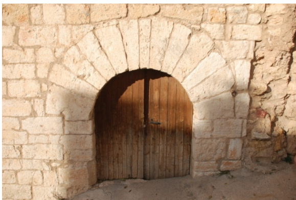
Acceso a la planta baja de la torre: antigua fragua
