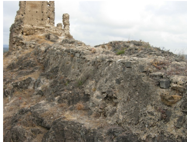
Muro oeste de la celoquia
