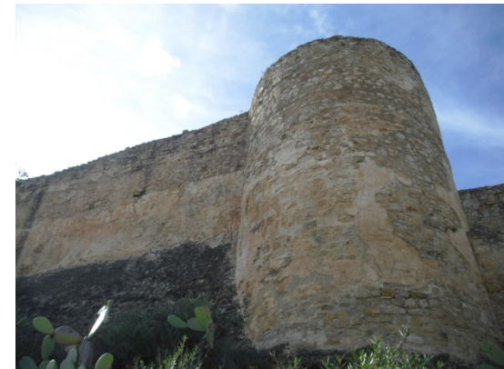
Torre de defensa del acceso
