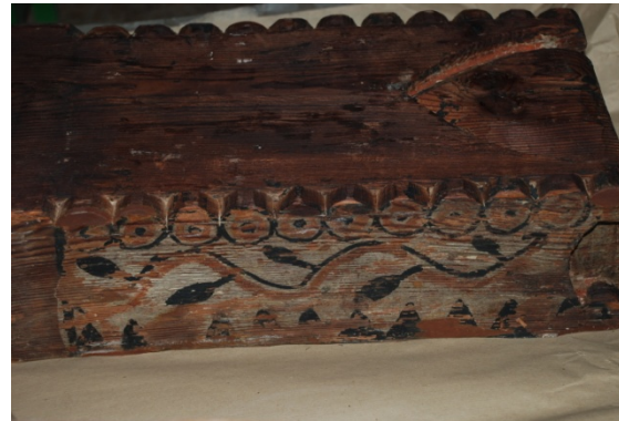
Policromía de las vigas de la techumbre de la iglesia
