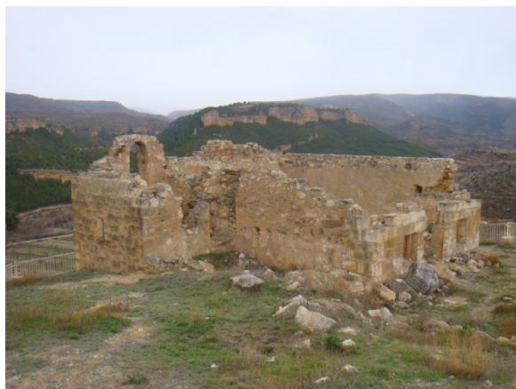
Vista general de la ermita de santa Bárbara
