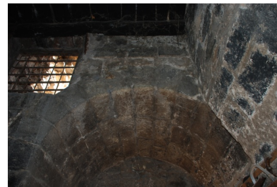
Interior del acceso a la antigua fragua
