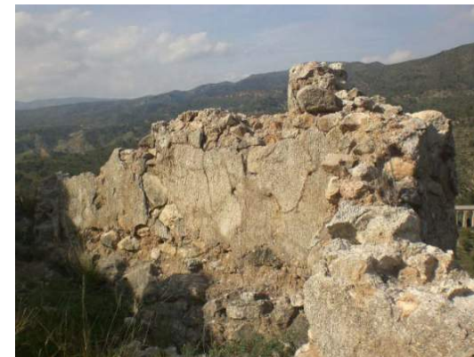
Restos de construcciones interiores
