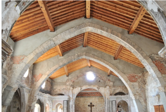
Nave de la iglesia de arcos diafragmáticos situada en la cuarta planta de la torre
