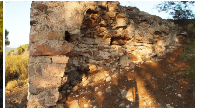
Restos de muro de mampostería
