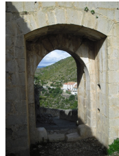
Puerta de acceso desde el interior
