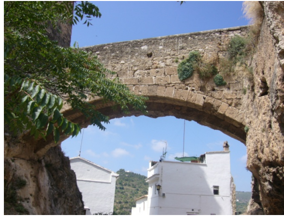
Puente de acceso
