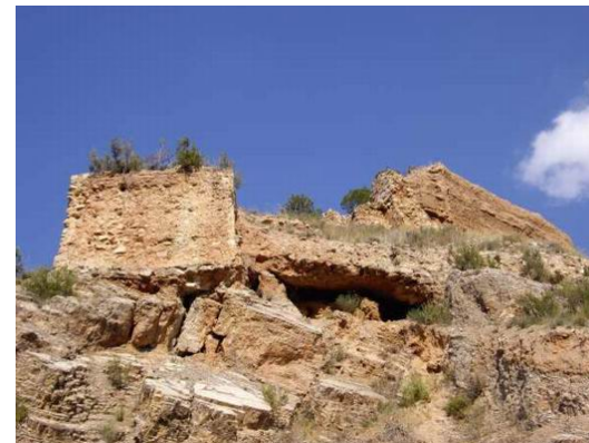
Torre de defensa y murallas
