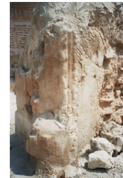
Detalle de yesería en el acceso a la capilla
