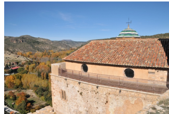
Paso de ronda en la torre del homenaje
