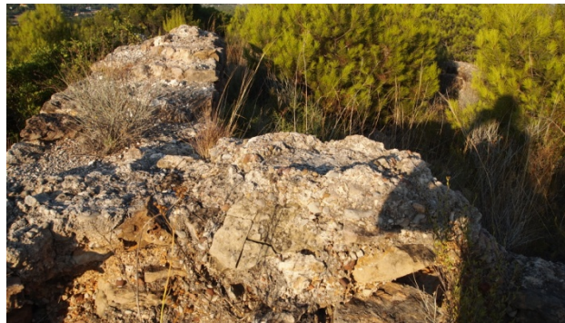
Muro de cierre de la torre del homenaje
