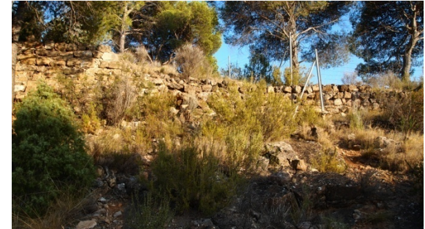
Restos de la muralla
