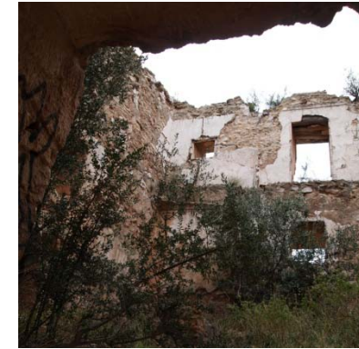
Interior de la torre del homenaje
