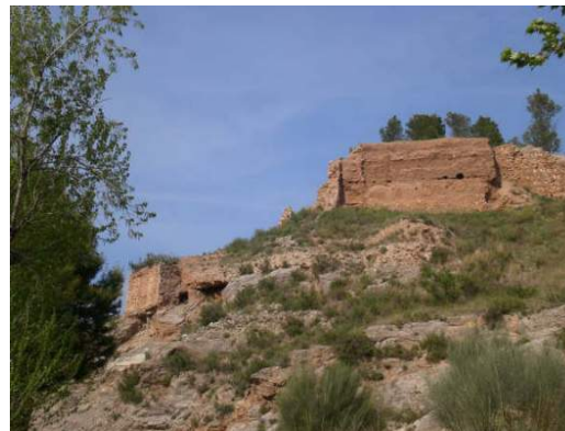
Vista general desde el oeste
