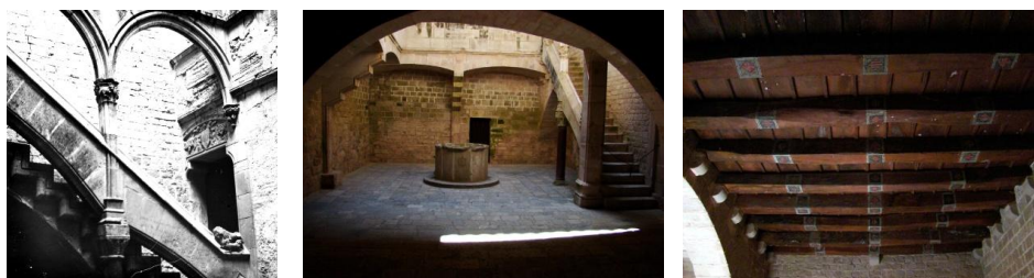
Fig. 354 Aiguamurcia. Monasterio de Santes Creus Fotografías del patio del Abad
