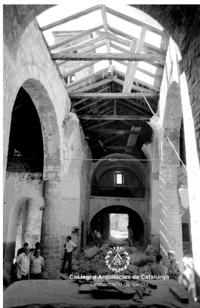
Fig. 328 Taüll. Iglesia de Santa María AFAFV. Nave central de Santa María de Taüll. Desmonte y nuevo montaje de la cubierta. Ferrant visitando la obra
