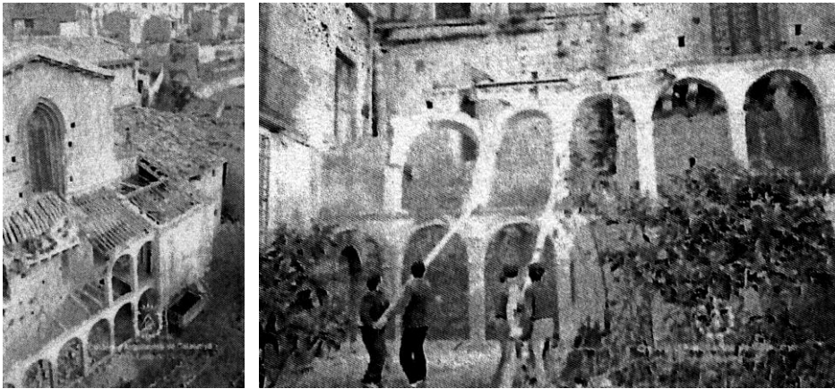
Fig. 284 Vallbona de las Monjas. Monasterio de Santa María AFAFV, fotocopias de contactos. Distintas fases de demolición de las edificaciones adosadas a la iglesia
