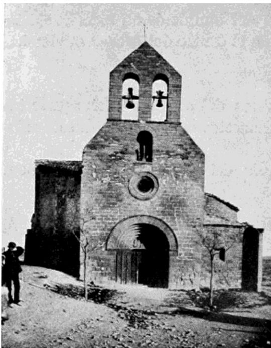
Fig. 568. — Esglesia de la Mare de Déu de Bell-lloch.
