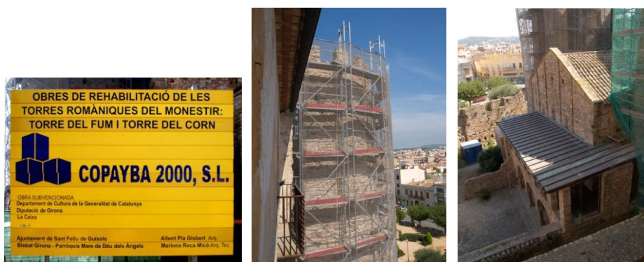
Fig. 200 Sant Feliu de Guixols. Monasterio de Sant Feliu Cartel anuncio de las Obras. Andamios colocados en ambas torres. Fotografías de la autora. 2011
