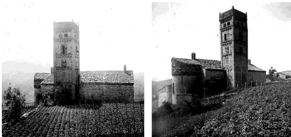
Fig. 138 Molló. Iglesia de Santa Cecilia Fotografías del Archivo Salvany. 1918. En la foto de la derecha se observa el volumen adosado de la sacristía y el recrecido en el muro del ábside
