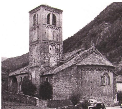
Fig. 59 Iglesia de San Cristóbal de Beget AFAFV. Estado previo a la demolición del cuerpo adosado a la Nave y al Presbiterio
