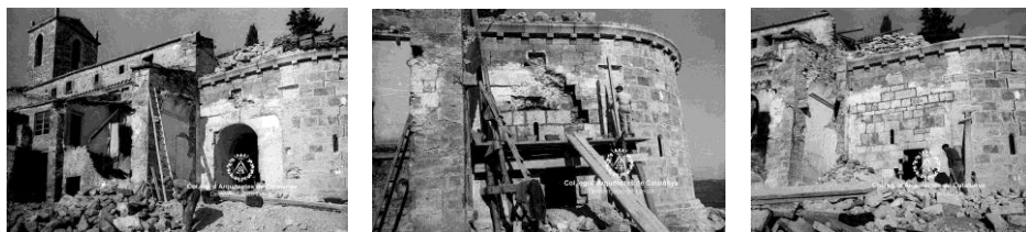
Fig 62 Iglesia de Santa María de Porqueras AFAFV. Ejecución de la demolición de los cuerpos adosados a la Nave y al Presbiterio y reconstrucción de muros
