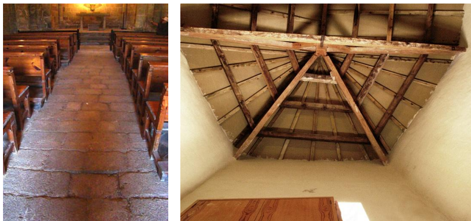
Fig. 374 Santa Coloma de Queralt. Iglesia de Santa María de Bell-Lloch Fotografía de la autora. 2011. Pavimento de la nave y entablado de madera la cubierta
