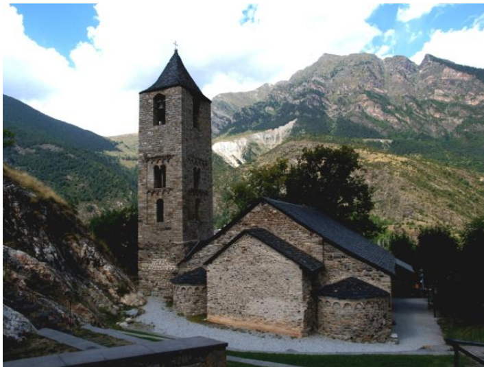
Fig. 312 Bohí. Iglesia de San Juan Estado actual de la iglesia. Fotografía de la autora, agosto de 2011
