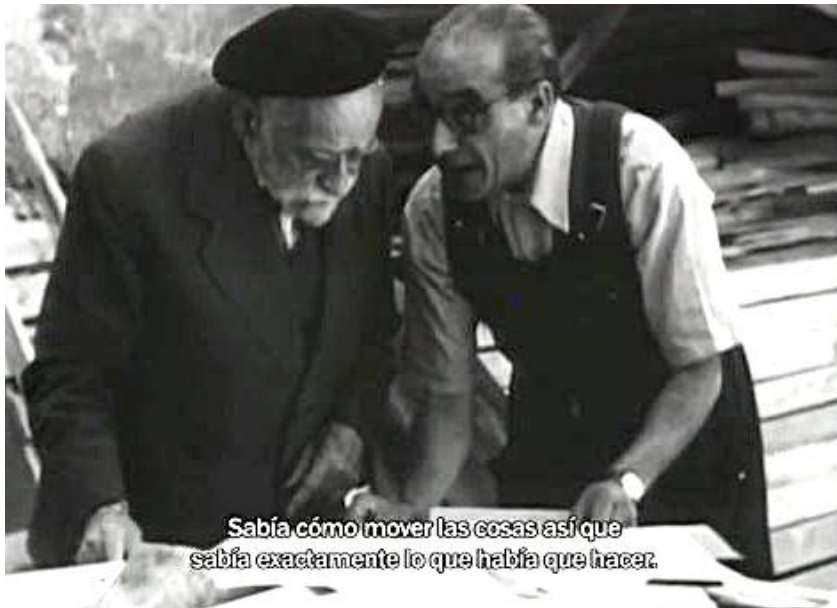
Fig. 400 Fotografía de Gómez-Moreno y Ferrant durante las obras del desmontaje para su traslado del ábside de San Martín de Fuentidueña, 1957 139
