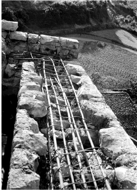
Fig. 309 Bohí. Iglesia de San Juan AFAFV. Fotografías del proceso de restauración del campanario. Armado de muros
