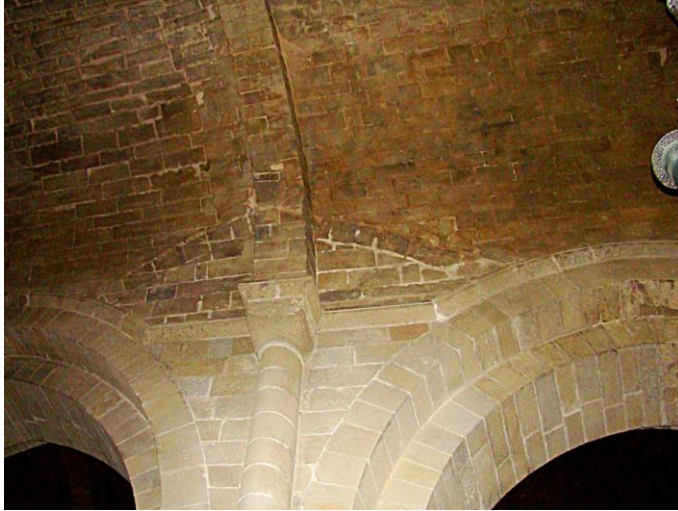
Fig. 239 Agramunt. Iglesia de Santa María Fotografía de la autora. Agosto 2011. Impronta que distingue la obra efectuada por Ferrant
