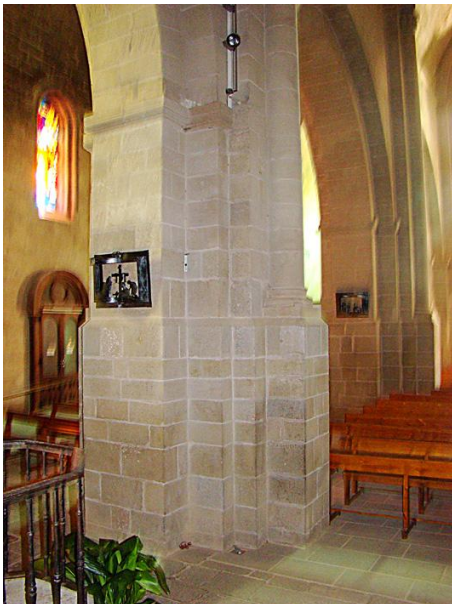
Fig 238 Agramunt. Iglesia de Santa María Fotografías de la autora. Agosto 2011. Pies derechos reconstruidos, primer tramo, lado del Evangelio
