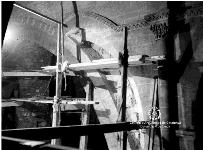
Fig. 231 Agramunt. Iglesia de Santa María AFAFV. El gran arco permanece intacto mientras se vacía su riñón para recuperar los restos del primitivo arco románico que quedó embebido en el muro del siglo XVII
