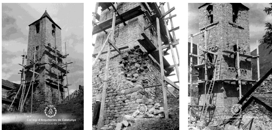
Fig. 308 Bohí. Iglesia de San Juan AFAFV. Fotografías del proceso de restauración del campanario
