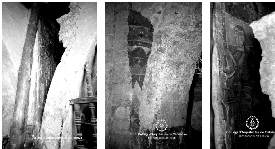
Fig. 323 Taull. Iglesia de Santa María AFAFV. Fotografías del desmontaje de muros transversales y recuperación de pilares circulares y pinturas murales
