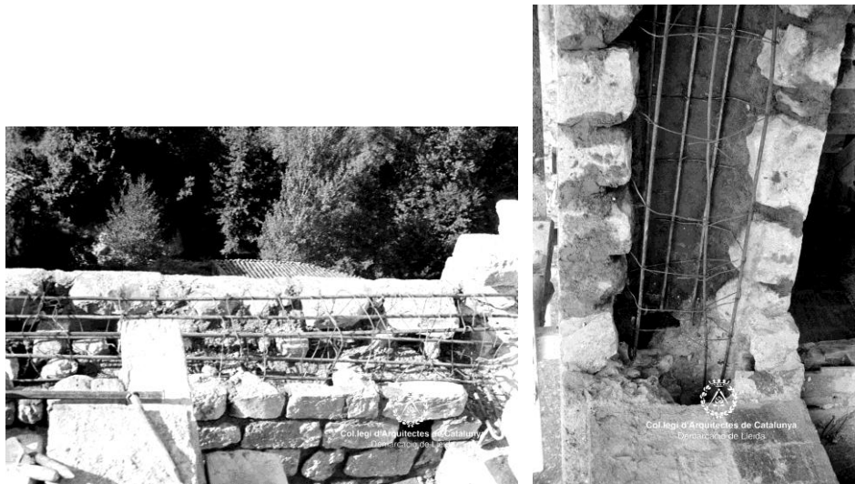
Fig. 54 Iglesia de San Cristóbal de Beget. AFAFV. Restauración del campanario
