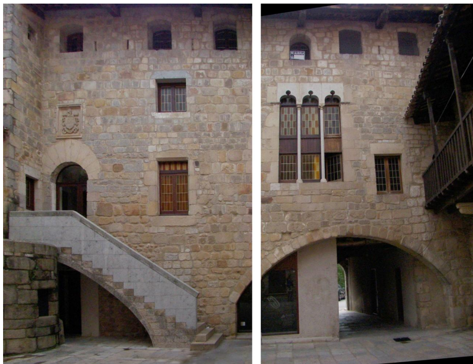
Fig. 132 Breda. Abadía Fachada Oeste. Fotografías de la autora, agosto 2011
