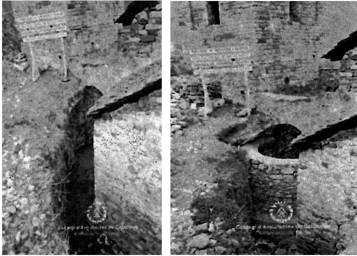
Fig. 312 Bohí. Iglesia de San Juan AFAFV. Reconstrucción del ábside del Evangelio. Vistas desde el exterior antes y durante la reconstrucción
