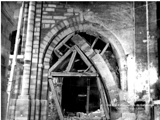
Fig. 235 Agramunt. Iglesia de Santa María AFAFV. Reconstrucción del pilar que soportará los nuevos arcos
