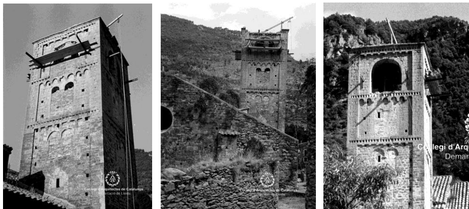
Fig. 118 Beget. Iglesia de San Cristóbal AFAFV. Fotografías del proceso de restauración del cuerpo superior del campanario
