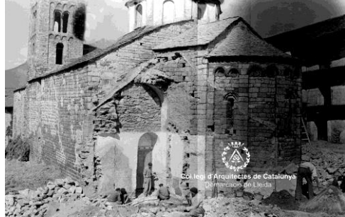
Taull. Iglesia de Santa María AFAFV. Fotografías del proceso de desmontaje de la sacristía moderna
