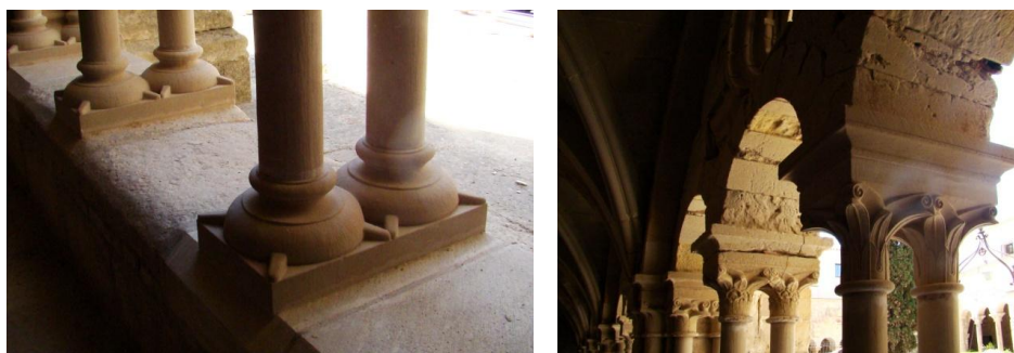
Fig. 294 Vallbona de las Monjas. Monasterio de Santa María Basas, fustes y capiteles reconstruidos. Fotografías de la autora. Agosto 2011
