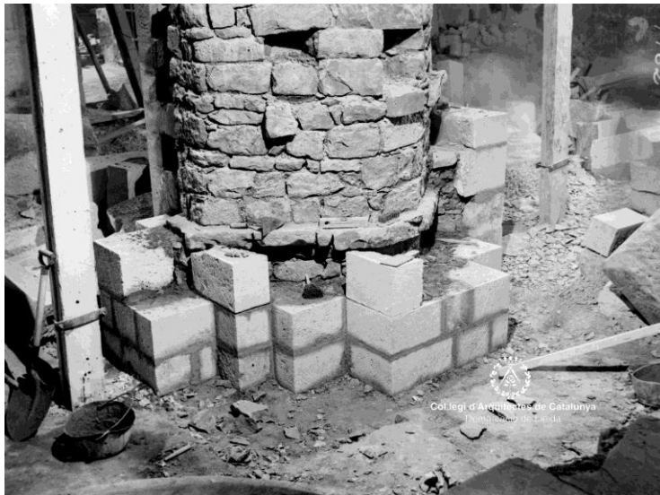
Fig. 230 Agramunt. Iglesia de Santa María Fotografía AFAFV. Reparación y reconstrucción del pilar de apoyo del tramo de nave de cabecera
