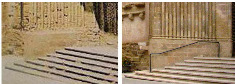
Fig. 247 Agramunt. Iglesia de Santa María Estado anterior y posterior a la restauración de Ferrant del zócalo y pilarillos de la portada principal, con barandillas colocada posteriormente
