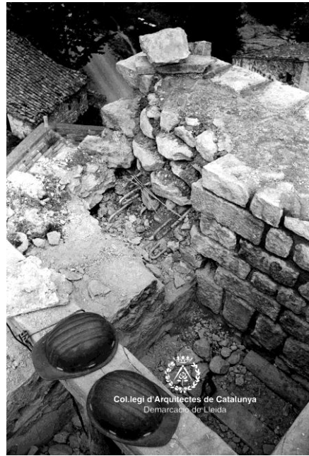
Fig. 309 Bohí. Iglesia de San Juan AFAFV. Fotografías del proceso de restauración del campanario. Armado de muros
