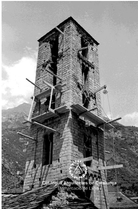
Fig. 302 Erill la Vall. Iglesia de Santa Eulalia AFAFV. Fotografías tomadas durante la restauración del campanario de la iglesia
