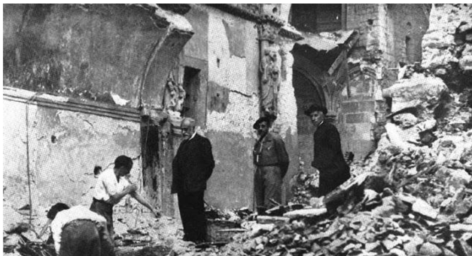
Fig. 22 Manuel Gómez Moreno y Alejandro Ferrant visitando las obras de desescompro de la Cámara Santa en Oviedo
