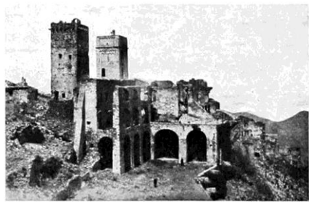
Fig. 501.—Monestir de Sant Pere de Roda. (Fot. Falguera.) Fig. 501. Monestir de Sant Pere de Roda (Fot. Falguera)
