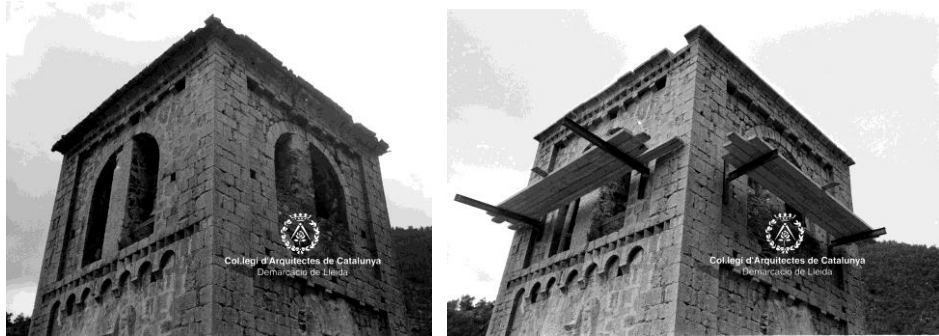
Fig. 53 Iglesia de San Cristobal de Beget. AFAFV. Restauración del campanario
