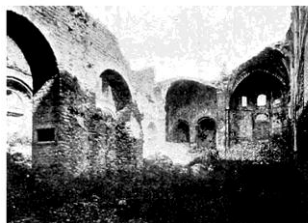
Fig. 73. — Ripoll. Interior de la nau abans de la restauració. (Fots. Rogent.)
