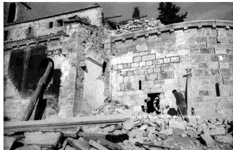
Fig. 150 Porqueres. Iglesia de Santa María AFAFV. Construcción de la armadura de la bóveda del ábside y reconstrucción de la sillería de la fachada Sur
