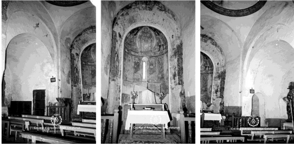
Fig. 321 Taull. Iglesia de Santa María AFAFV. Fotografías del ábside central y de los muros que cierran los laterales. Estado previo a la intervención
