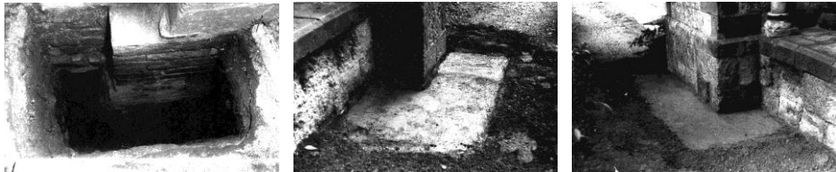
Fig. 111 Sant Cugat del Vallés. Monasterio de Sant Cugat AAFV. Fotografías del recalce de cimientos
