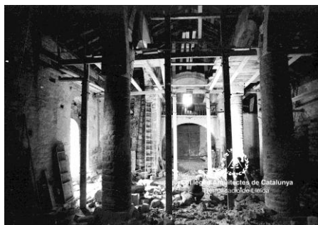
Fig. 327 Taüll. Iglesia de Santa María AFAFV. Ejecución del nuevo entramado de cubierta de la nave central
