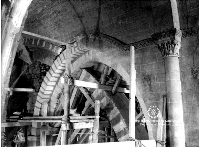
Fig. 234 Agramunt. Iglesia de Santa María AFAFV. Construcción de la parte de arco primitivo desaparecida
