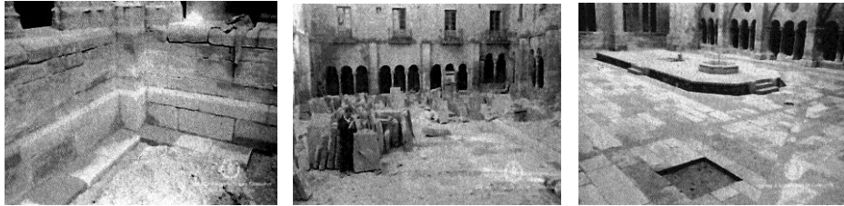
Fig. 292 Vallbona de las Monjas. Monasterio de Santa María AFAFV, fotocopias de contactos. Diversas fases de la ejecución del nuevo enlosado del patio
