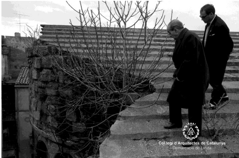
Fig 250 Agramunt. Iglesia de Santa María AFAFV. Alejandro Ferrant sobre el faldón de la cubierta, previo a su levantado. Se observa el recrecido del muro del ábside central que será demolido 114
