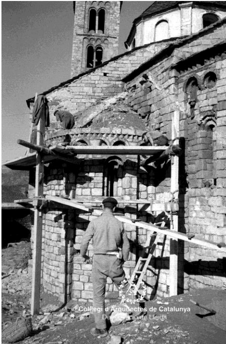
Fig. 306 Taull. Iglesia de Santa María AFAFV. Fotografía de las obras de reconstrucción del ábside de la Epístola
