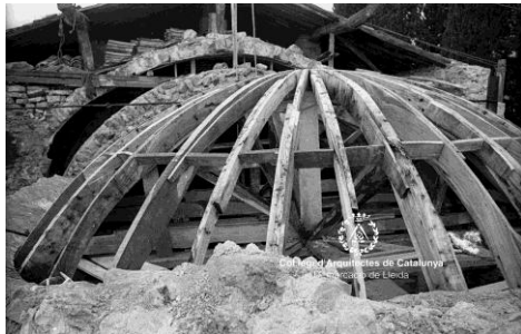
Fig. 150 Porqueres. Iglesia de Santa María AFAFV. Construcción de la armadura de la bóveda del ábside y reconstrucción de la sillería de la fachada Sur
