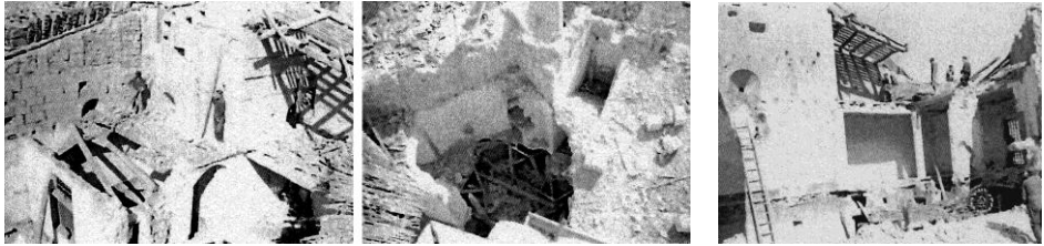
Fig. 75 Monasterio de Santa María de Vallbona de las Monjas AFAFV. Fotografías tomadas durante las demoliciones
