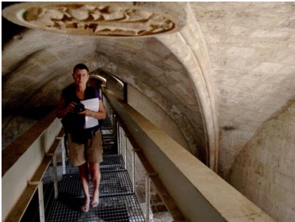
Fig. 115 Sant Cugat del Vallés. Monasterio de Sant Cugat Pasarela metálica que permite visitar las bóvedas Fotografías de la autora, agosto de 2011
