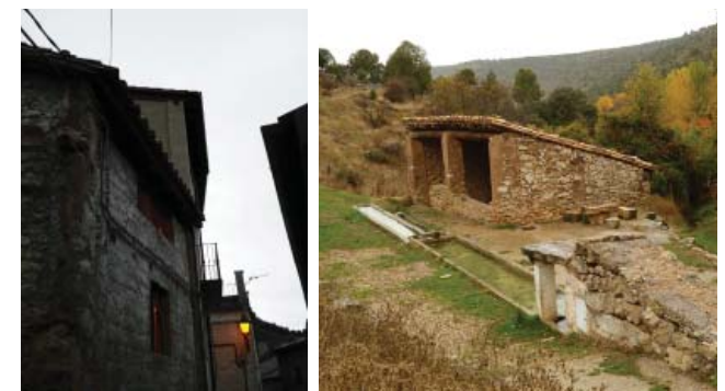
figura 1.8 Muestra de arquitectura vernácula. Masía en Calles (Los Serranos). Fuente propia
