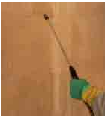
157. Aplicación de una técnica de consolidación sobre una fachada revestida (VEGAS, F. y MILETO, C., 2011)
