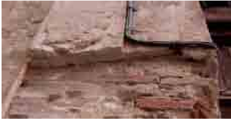
142. Espesor del revestimiento que forma el recercado de una puerta (la autora)
