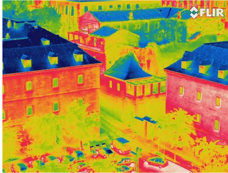
Figura 3.15: Flir T640, termografía infrarroja, paleta Rain 900 Toma en picado en la que las líneas dirigen la mirada hacia el centro de la imagen
