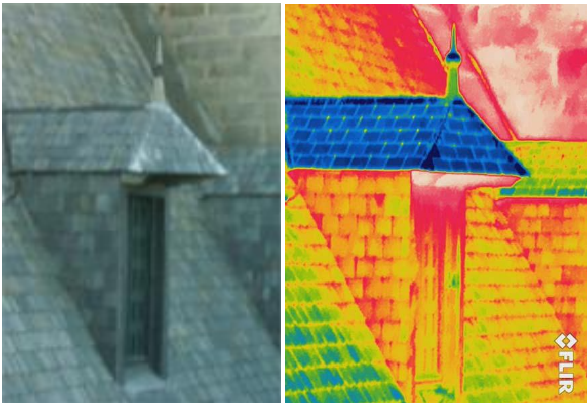
Figura 2.62: Flir T640, fotografía y termografía infrarroja, paleta Rain 900. Texturas de los materiales
