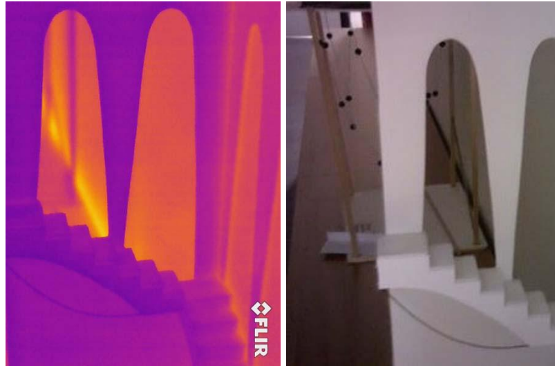
Figura 2.42: Flir T600. Termografía infrarroja, paleta Iron y fotografía. En ocasiones es más difícil de averiguar
