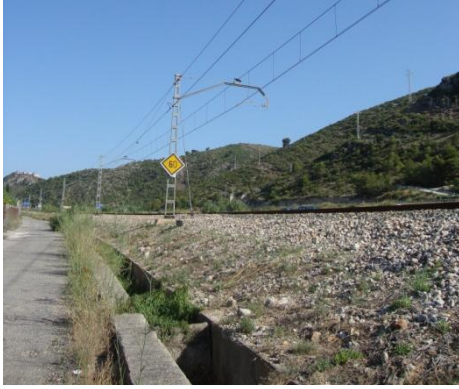
Vía del tren que pasa por la majal de Gandia.
