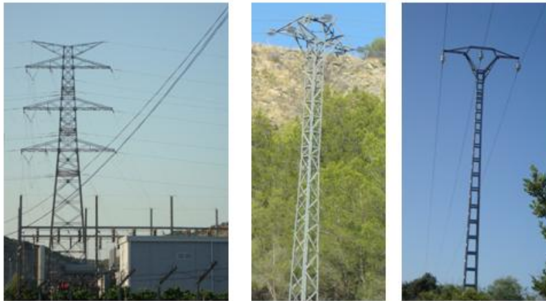
Fotos de diseños de postes eléctricos no peligrosos
