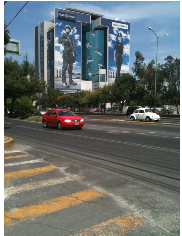
Ilustración 6 Edificio de la policía Federal de México, ubicado en Periférico Sur en la Delegación Magdalena Contreras. Fecha de toma: 13 de octubre del 2010.
