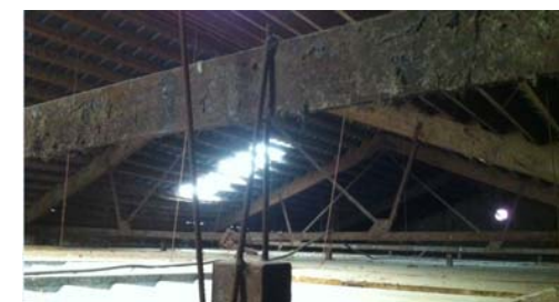
Imatge 16. Edifici en l'actualitat, estructura de coberta
