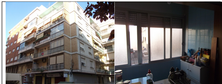
Imagen 77. Izda. Acristalamientos de balcones y galerías en Calle Ferrocarril d' Alcoi, Gandía). Drcha. Incorporación de galería al espacio interior en edificio objeto. Fuentes: Izda. Imagen propia, drcha. La propiedad.
