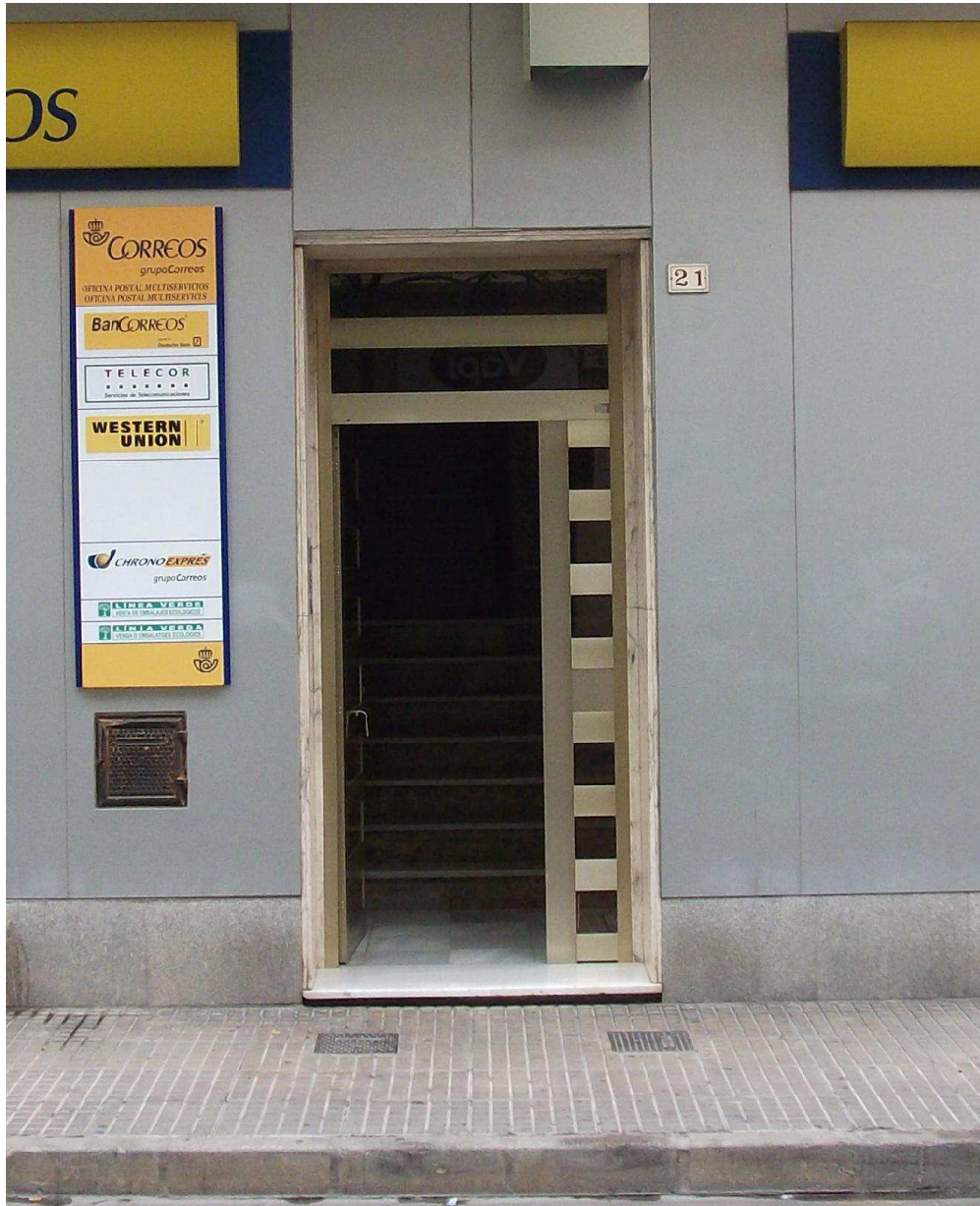
Accesibilidad. Existencia de desnivel [Ref. AC001]
