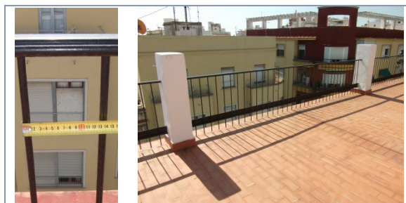
Imagen 52. Características constructivas y aspecto resistente de la barandilla de azotea en edificio objeto.
