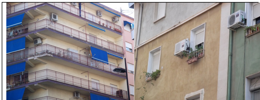
Imagen 22. Derecha: aparatos de aire acondicionado y vigas de cuelgue. Plaza Elíptica en Gandía, 2004. Izquierda: aparatos de aire acondicionado en fachada. Carrer Nou d'Octubre, Gandía, 2004. Fuente: Imagen propia.
