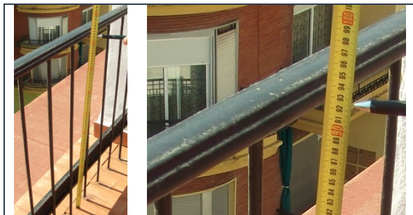
Imagen 50. Barandilla en azotea (altura mayor de 6m) del edificio objeto.
