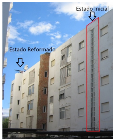
Imagen 63. Ducal, estados inicial y reformado. Fuente: I. Lafuente, 2004.
