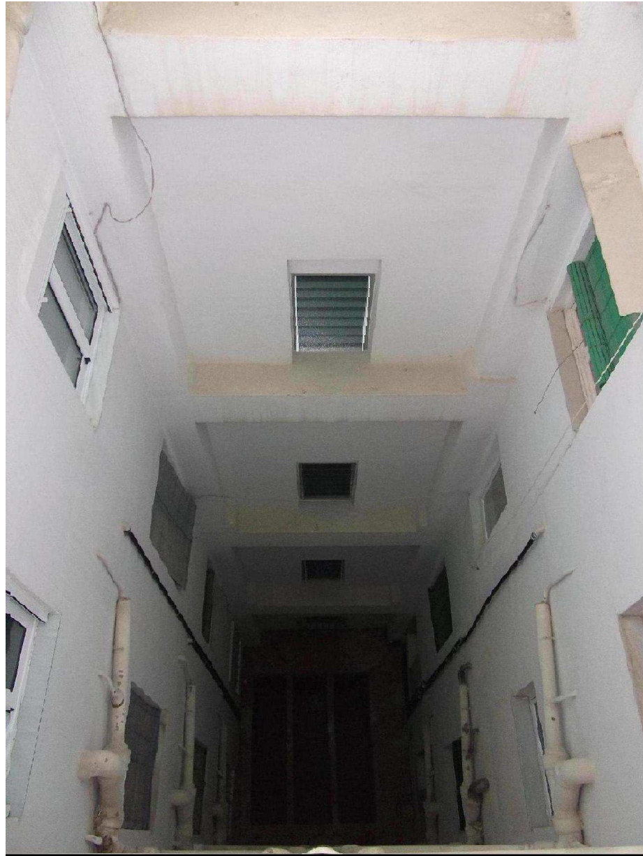
Fachada Int. O. Soporte [Ref. FA007]
