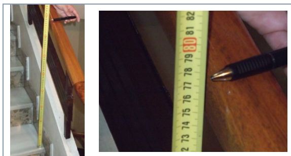
Imagen 51. Barandilla de escalera (altura mayor de 6m) del edificio objeto.
