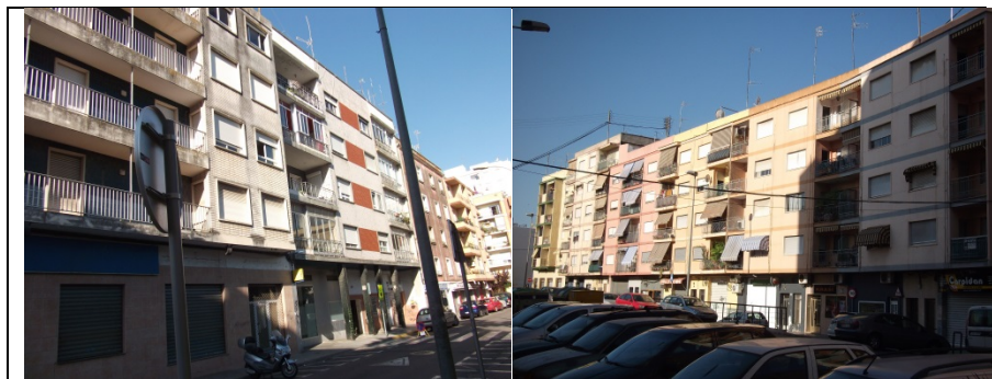
Imagen 78. Entorno urbano con lindes consolidados. Izda. Calle MM Escolapias, Gandía. Drcha. Calle Perú, Gandía. Fuentes: Imagen propia.
