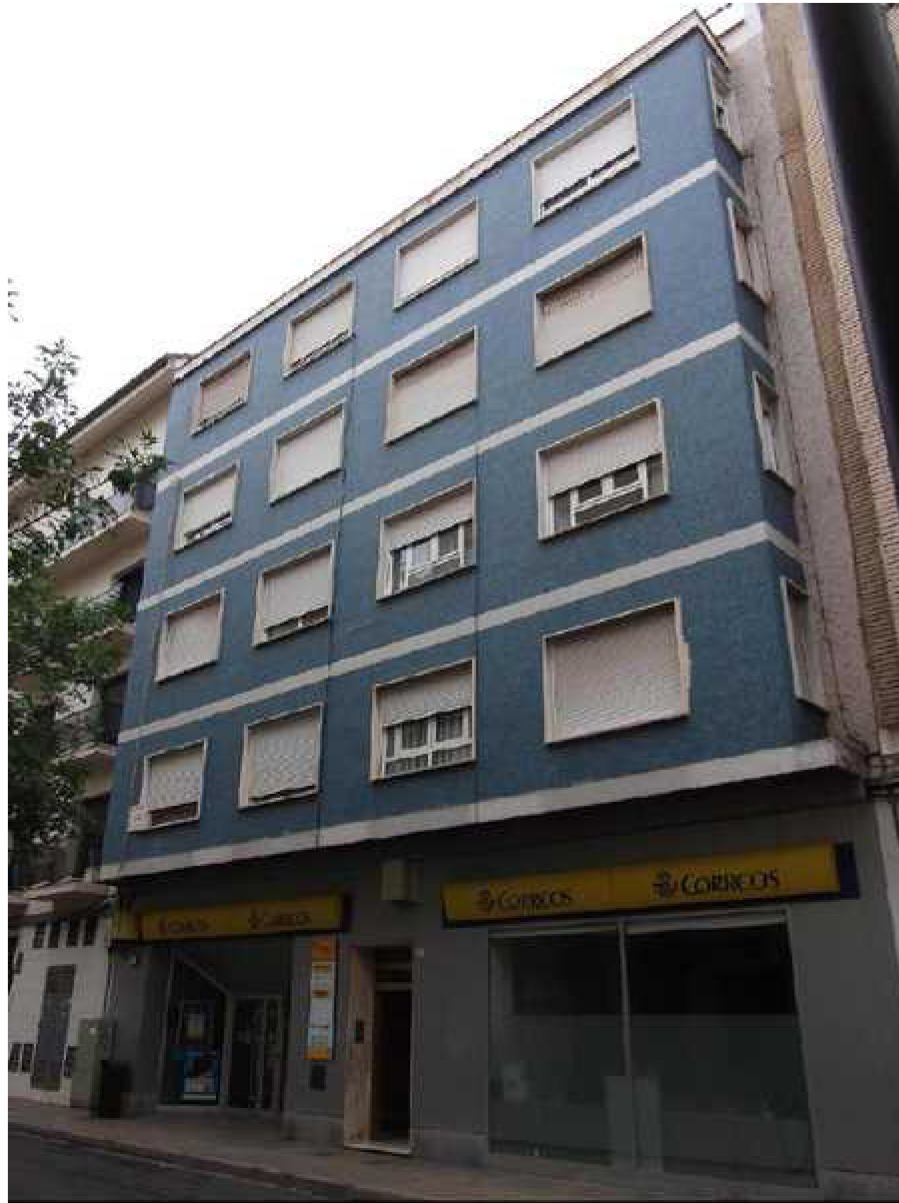
Fotografía de la fachada principal
