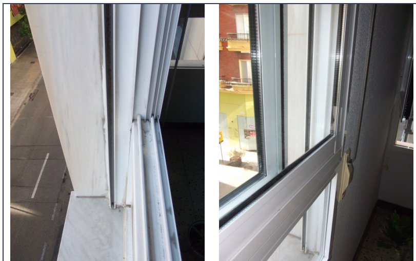
Imagen 75. Carpinterías renovadas. Fuente: la propiedad
