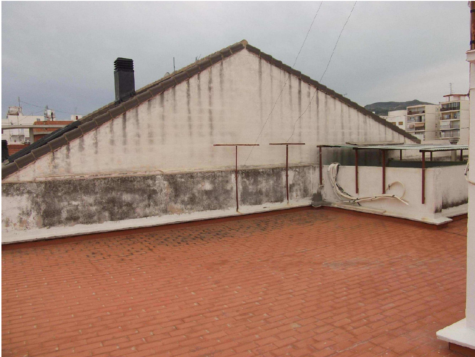
Cubierta Azotea. Soporte [Ref. CU001]
