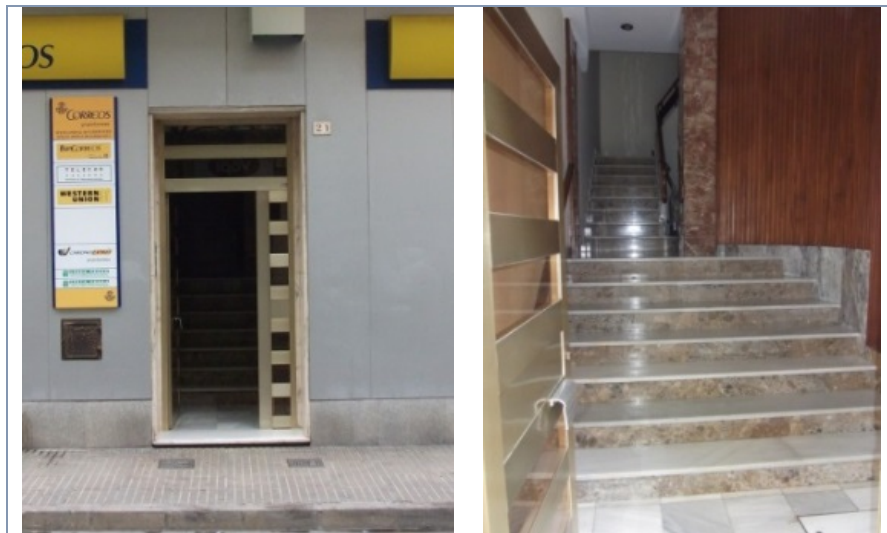
Imagen 24, Acceso a edificio objeto.
