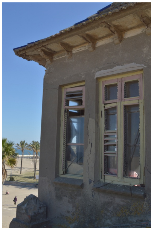
DETALLE_ Fachada Norte de la Torre
