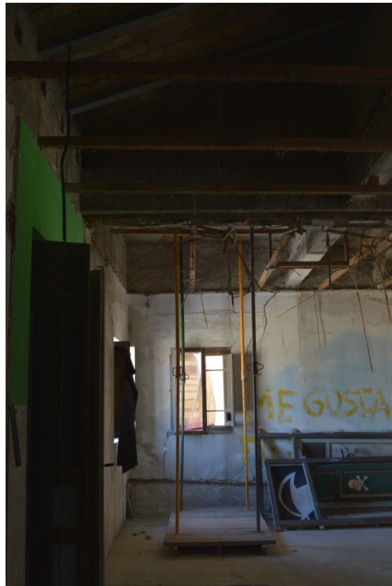
Planta primera, zona bajo la torre que está actualmente apuntalada.
