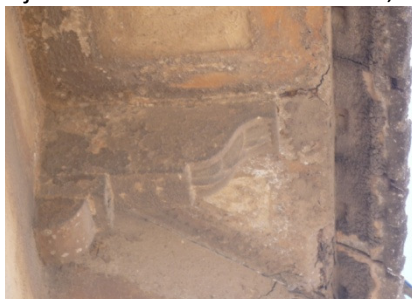
Detalle de la ménsula de la cubierta de la torre.
