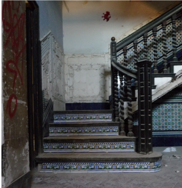
Escalera con barandilla de madera. Contrahuellas con zócalo de azulejos.
