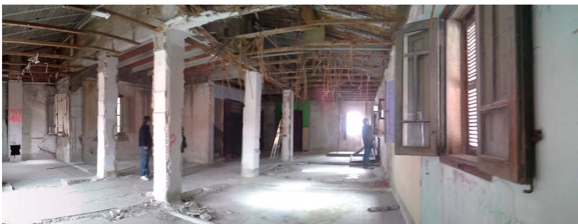
Estado actual de la Planta Primera con toda la tabiquería y el falso techo eliminados para las reparaciones que se realizaron en la cubierta en la década de los 90.
