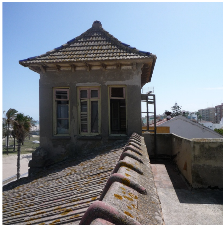
Fachada Norte de la Torre y en primer plano el remate de los antepechos que son la cumbrera de la cubierta.
