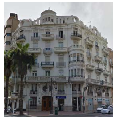
Edificio para su cuñado E. Vallbona
