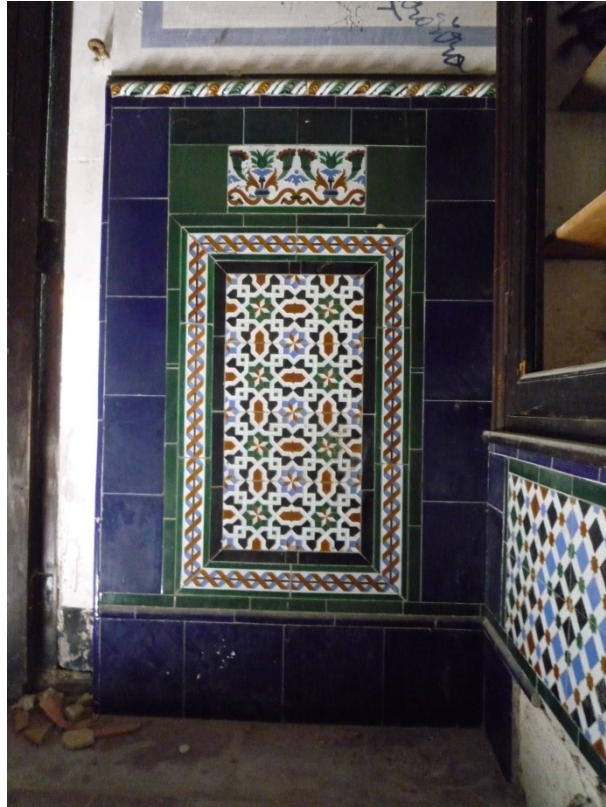
Zócalo del comedor, de azulejos de Cerámicas Gonzalez de Sevilla.
