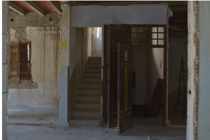
Desembarco de la escalera en la planta primera y arranque de la escalera que va a la cubierta.
