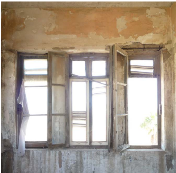
Vista interior de la fachada Este, la más expuesta.
