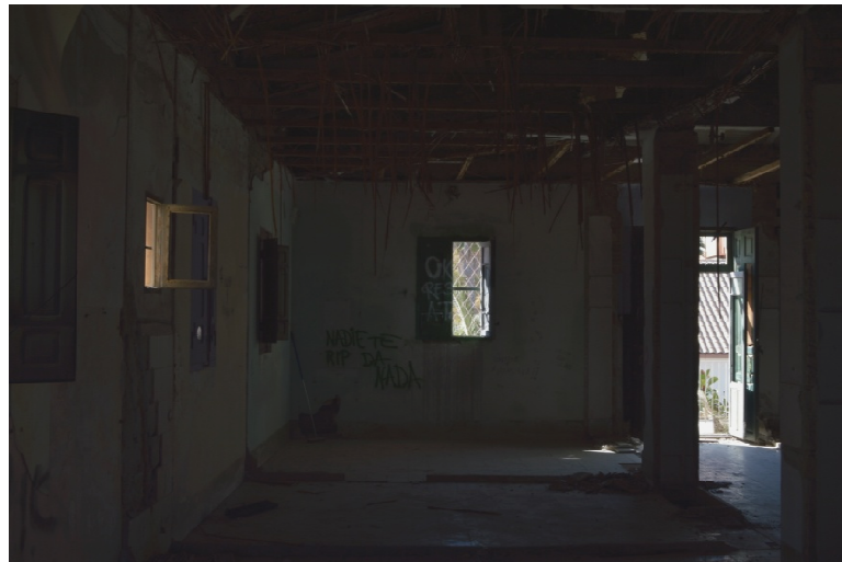
Vista de la planta primera.
