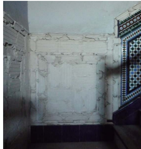
Los azulejos perdidos han marcado el mortero de agarre y se puede leer el nombre de Ceramics Gonzalez Sevilla. A partir de este dato se lhan localizados los catálogos que esta marca usaba a principios de siglo XX.
