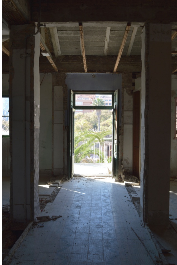
Vista del pasillo de la planta primera y el acceso a la terraza trasera.
