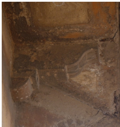
Ménsulas en los faldones de la cubierta.
