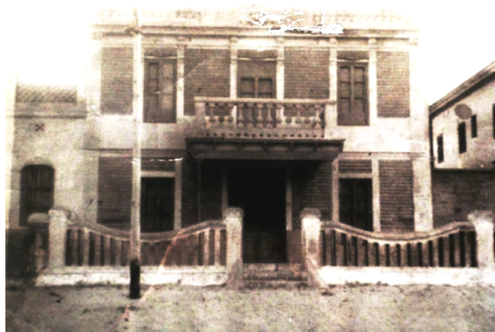
Fachada de la vivienda nº 110. Fotografía cedida por el Restaurante Casa Patacona
