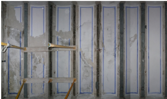
Vista del techo del comedor, viguetas 7-12
