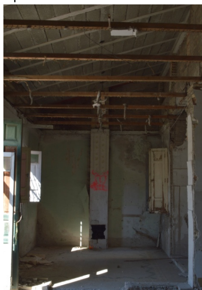
Vista de la planta primera, se ven las bovedillas sustituidas.
