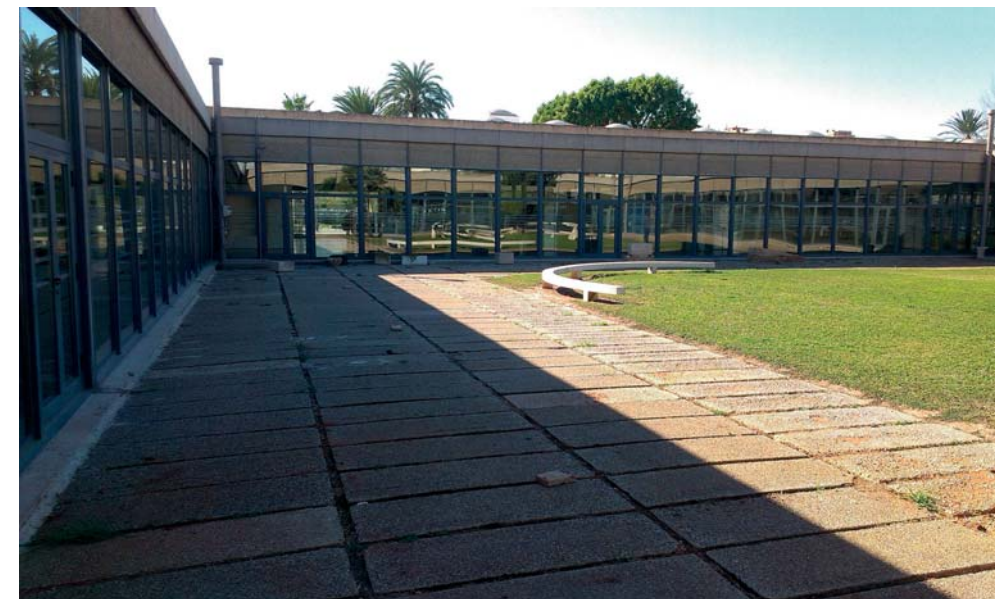
IMAGEN 16. Pavimento de loseta de hormigón prefabricado.
