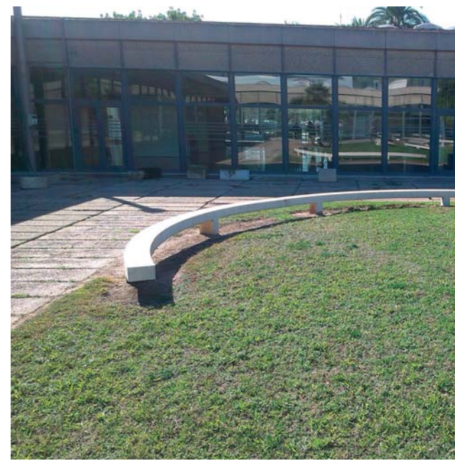
IMAGEN 23. Puerta de acceso al patio.
