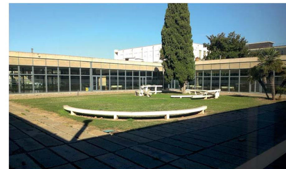
IMAGEN 5. Patio Interior en la Escuela Técnica Superior de Ingeniería de Edificación
