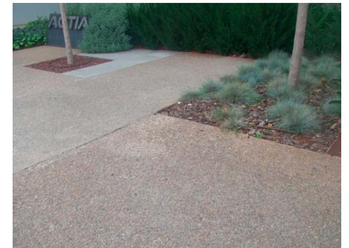
IMAGEN 32. Pavimento de hormigón de árido visto.
