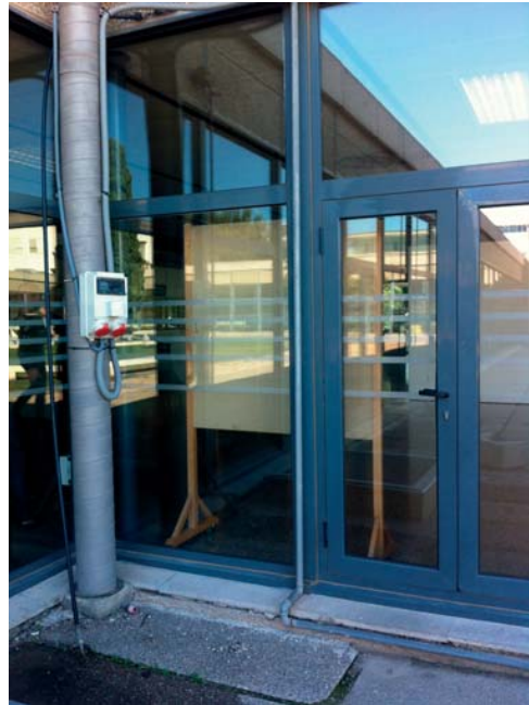
IMAGEN 17. Puerta de acceso al patio.
