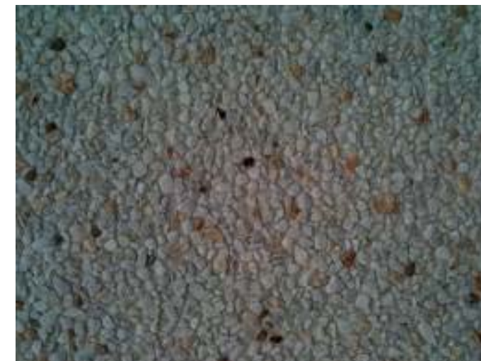
IMAGEN 31. Pavimento de hormigón de árido visto.
