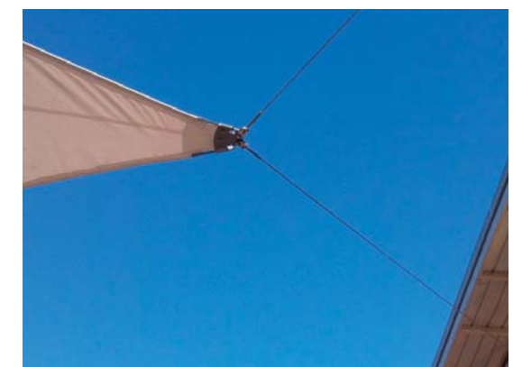
IMAGEN 36. Estructura tensada Centro Comercial Bonaire (Valencia)
