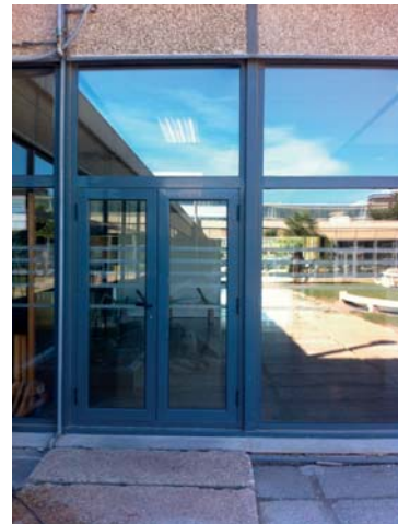
IMAGEN 25. Puerta de acceso al patio.
