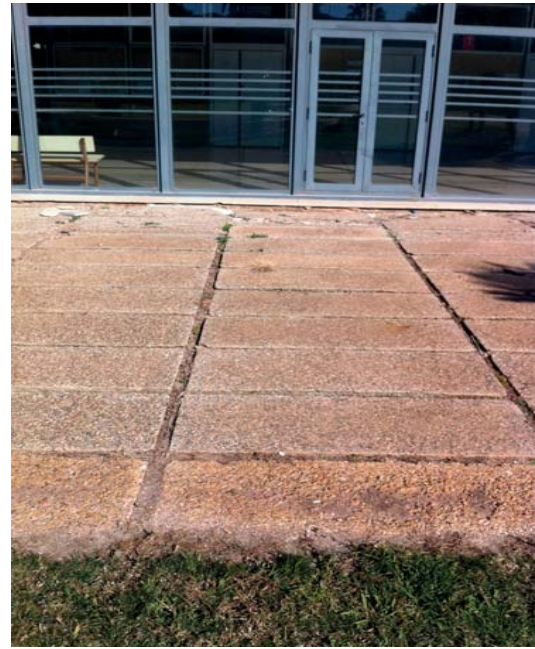
IMAGEN 18. Pavimento de baldosa hidráulica.
