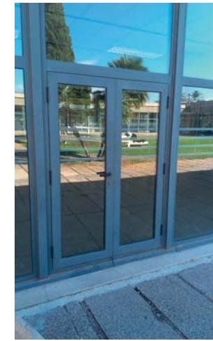
IMAGEN 15. Puerta de acceso al patio interior de la ETSIE.
