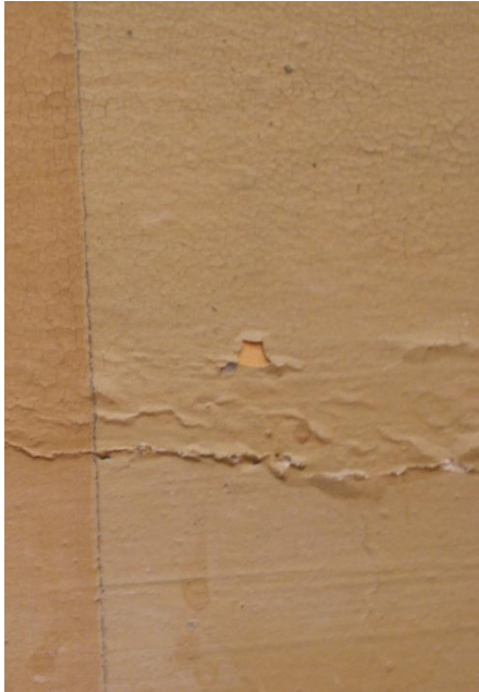
Il·lustració 10: detall dels alçaments de pel·lícula pictòrica.
