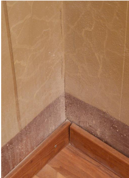
Il·lustració 9: detall d'eflorescències salines.
