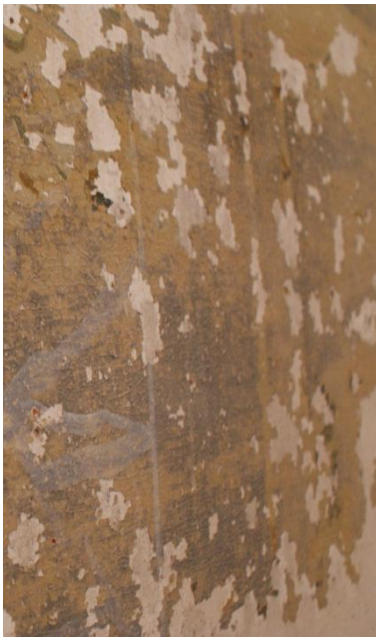
Il·lustració 13: detall dels faltants de pel·lícula pictòrica produïts per escorriments.
