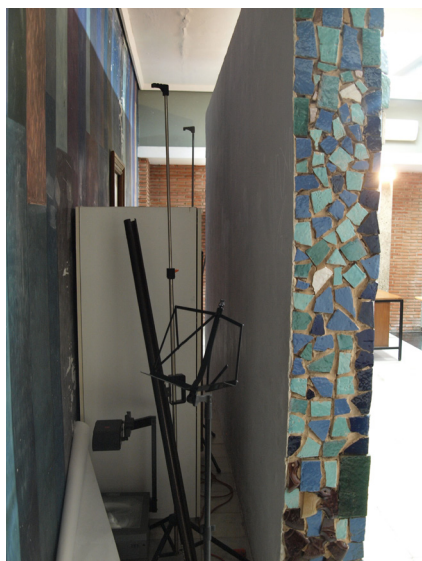
Figura 29 (a la izquierda). Huevo entre el mosaico y la pared.
