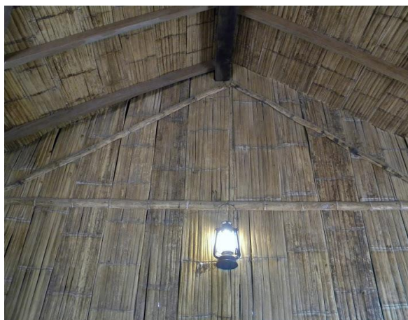
Ilustración 133: Vista interior de paneles prefabricados de "caña picada". Fuente: https://plus.google.com/photos/117407892112270434887/albums/5534702271310588449?banner=pwa (Consulta: 16/08/14).
