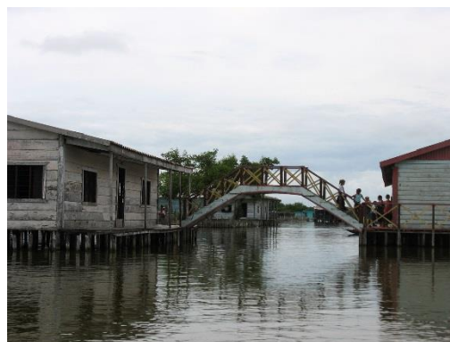
Ilustración 6: Puente en zona de palafitos en Nueva Venecia, Colombia. Fuente: A. Sisa (2006).
