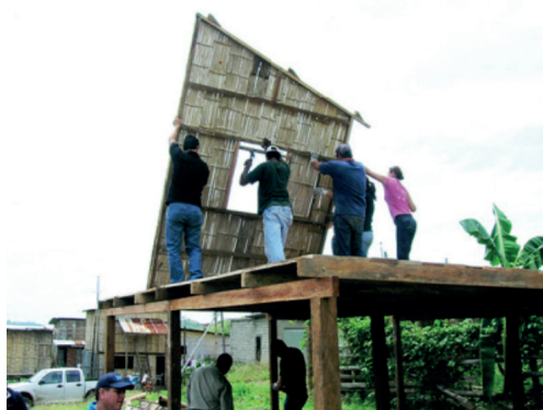
Colocación de paneles prefabricados de "caña picada" usados como cerramiento de los edificios. Fuente: F. Jové
