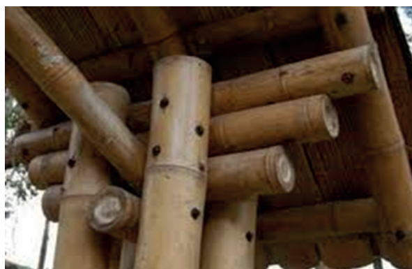
Detalle constructivo unión estructura-cubierta. Fuente: http://laarquitectura.blogspot.com.es/2011/02/construcciones-de-viviendas-con-cana.html
