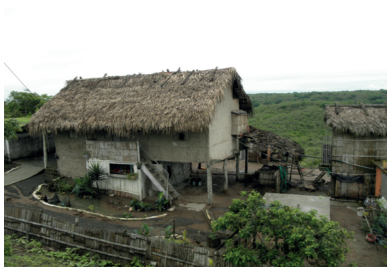
Vivienda Tradicional Manabita. Adaptación al clima y a los materiales tradicionales del lugar. Planta elevada del suelo mediante pilotes de madera. Estructura vertical de madera y horizontal de caña, cerramientos de "quincha" de caña picada y barro y cubierta vegetal. Fuente: F. Jové (2010)
