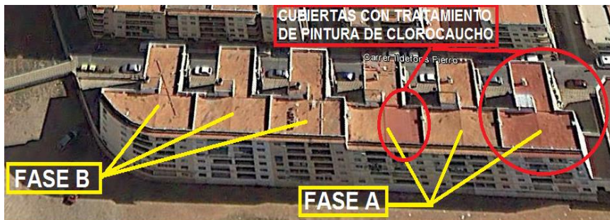
Figura 96. Vista aérea de las cubiertas de los bloques a estudio donde se observa las zonas en las que se ha aplicado pintura al clorocaucho, por la existencia de filtraciones. 2012. Fuente: Google Earth - Autor
