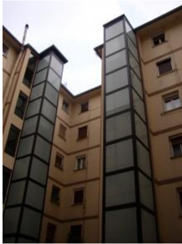
Figura 110. Vista de ejemplo real de ascensor exterior instalado en vía pública. 2014. Fuente: http://www.construyendohogar.com/ascensor-exterior-comunitario/
