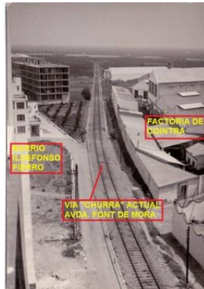
Figura 4. Fotografía aérea histórica de la vía "Churra". Año 1963.
