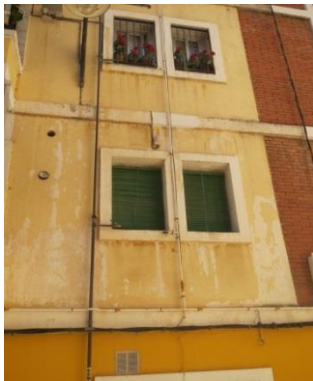
Figura 92 Vistas de la fachada principal. Donde se observa deterioro de revestimientos por falta de mantenimiento. 2014. Fuente: Autor.
