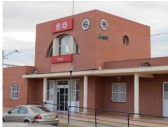
Figura 34. Estación cercanías Renfe Puçol. 2014. Fuente: Autor.
