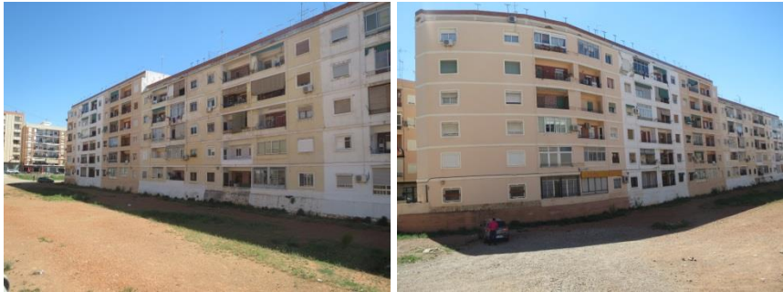
Figura 68. Vistas de la fachada trasera al barranco. 2014. Fuente: Autor
