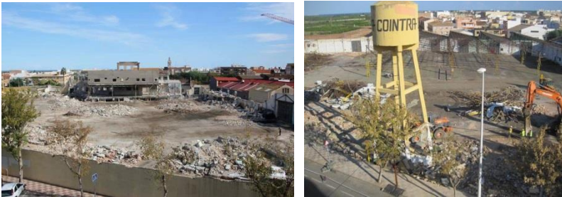
Figura 11. Imágenes del desmantelamiento de la factoría de Cointra en 2013.
