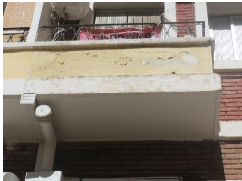
Figura 92 Vistas de la fachada principal. Donde se observa deterioro de revestimientos por falta de mantenimiento. 2014. Fuente: Autor.
