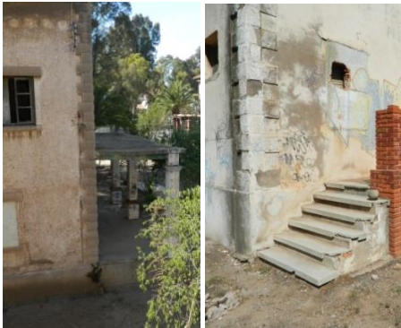
Fig. 14 Sillería en esquina. 2014. Propia
