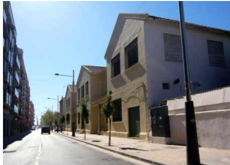
Fig. 45 Economato tras rehabilitación, vista hacia la playa. 2010. "El Económico"
