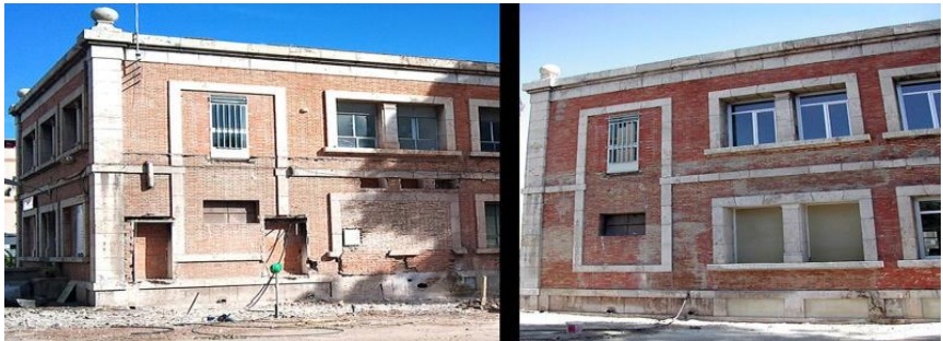
Fig. 67 Eliminación del anexo adosado construido en el 2º bloque. 2012. "El Económico"
