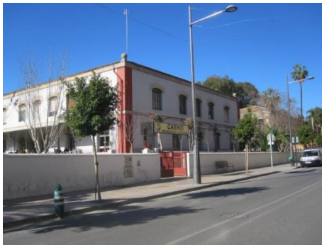
Fig. 55 Vista actual del Casino. 2014. www.casinopuertosagunto.com
