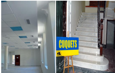
Fig. 66 Rehabilitación interior. 2012. www.aytosagunto.es
