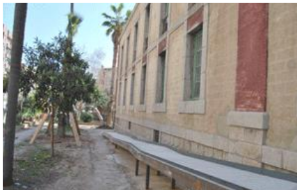
Fig. 64 Rampa de acceso al bloque principal. 2012. www.aytosagunto.es
