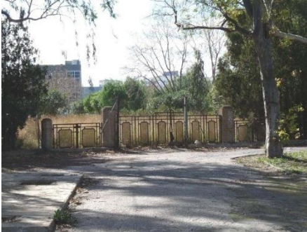
Fig. 76 Antigua puerta de acceso a las vías férreas de la fábrica. 2010. Javier Hidalgo Mora
