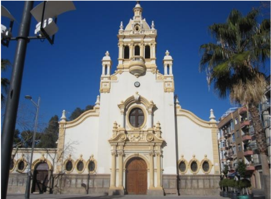
Fig. 28 Fachada Principal. 2012. Conchín Latorre
