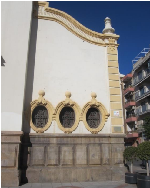
Fig. 29 Detalle del zócalo y nave lateral. 2012. Conchín Latorre
