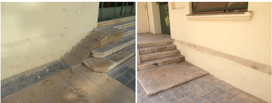
Fig. 42 Reparación de los zócalos del edificio y eliminación de los grafitis con la reforma de la fachada de 2010. 2014. Propia
