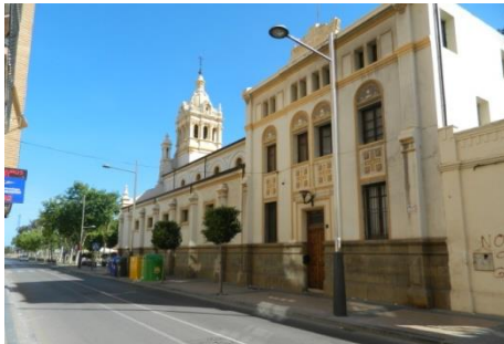
Fig. 34 Casa Abadía adosada en la parte posterior de la Iglesia. 2014. Propia
