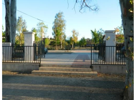
Fig. 75 Actual estado de la antigua puerta a las vías férreas. 2014. Propia
