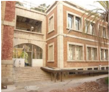
Fig. 65 Rampa de acceso al bloque central. 2012. www.aytosagunto.es
