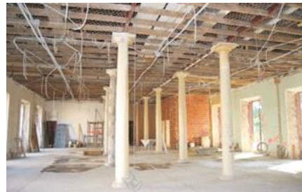
Fig. 63 Actuación en el interior del edificio. 2012. www.aytosagunto.es
