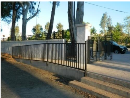
Fig. 77 Rampa creada para la accesibilidad al recinto. 2014. Propia
