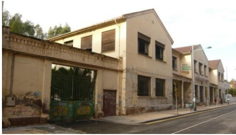
Fig. 44 Economato antes de la rehabilitación de la fachada. 2010. "El Económico"
