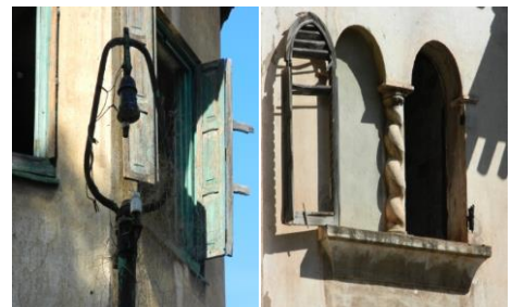
Fig. 19 Huecos con contraventanas de madera. 2014. Propia
