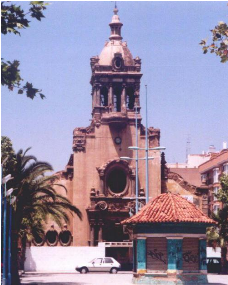
Fig. 37 Iglesia de Begoña antes de la restauración de 1993. 2012. FCV Sagunto
