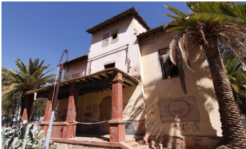
Fig. 12 Amplios huecos en fachadas. 2014. Propia
