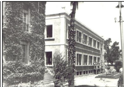
Fig. 61 Nuevo bloque de oficinas. 2010. FCV Sagunto
