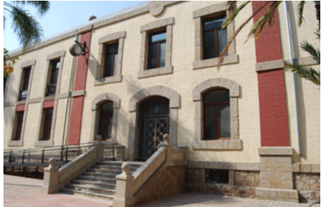
Fig. 62 Fachada edificio principal. 2013. www.aytosagunto.es
