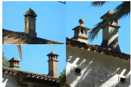
Fig. 17 Chimeneas con tejadillo. 2014. Propia
