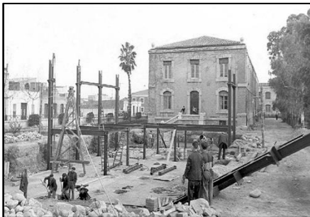
Fig. 60 Obras de ampliación de las oficinas. 2010. FCV Sagunto
