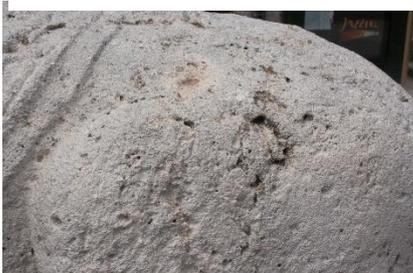
Figura 37. Alveolización en la parte superior de la pata de la esfinge 1
