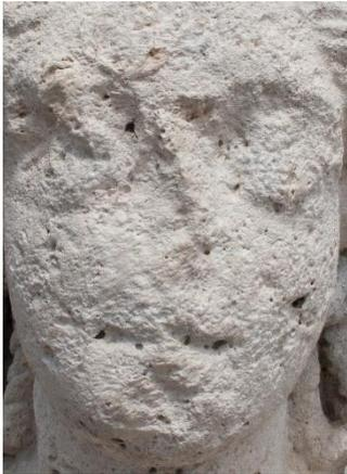
Figura 35. Patología de disgregación en el rostro de la Esfinge 1
