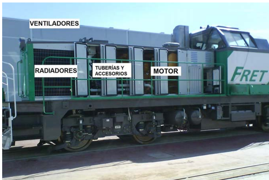
Figura 6.13. Disposición relativa de los grupos de componentes principales del sistema de refrigeración observada en una locomotora existente.
