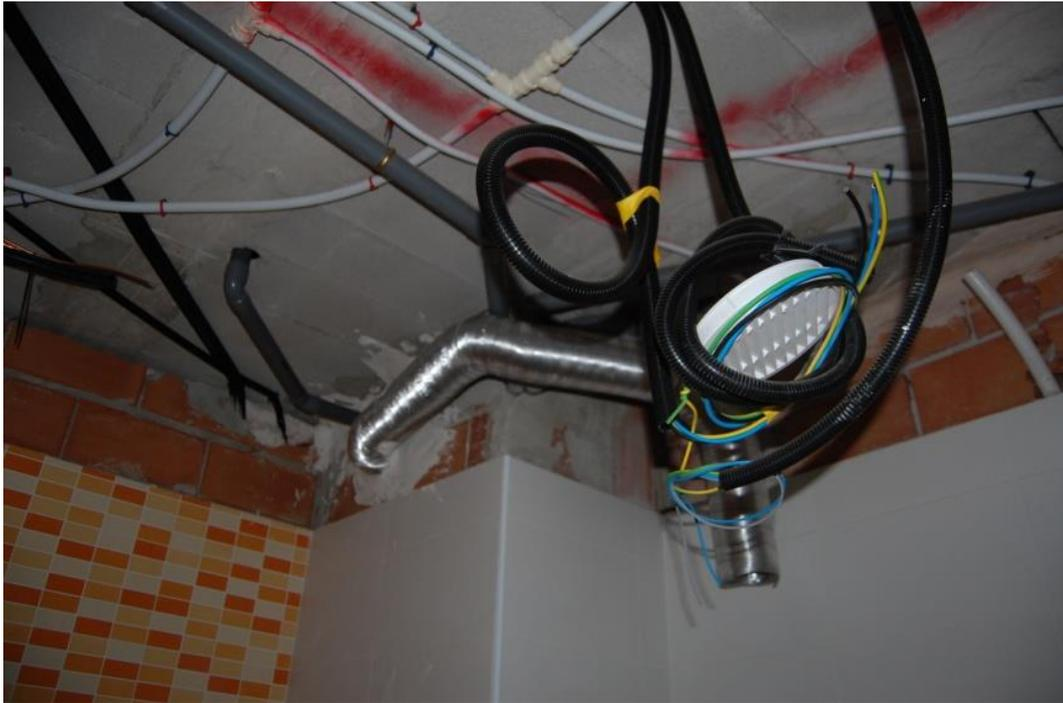
*Imagen 11. Instalación de extracción.*
