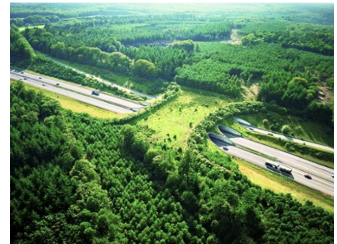
Imagen 11. Ecoducto De Woeste Hoeve encima de la autopista A50, Países Bajos. Este país tiene un impresionante despliegue de más de 600 pasos de fauna (incluyendo pasos inferiores y ecoductos) que han sido utilizados para proteger la fauna.
