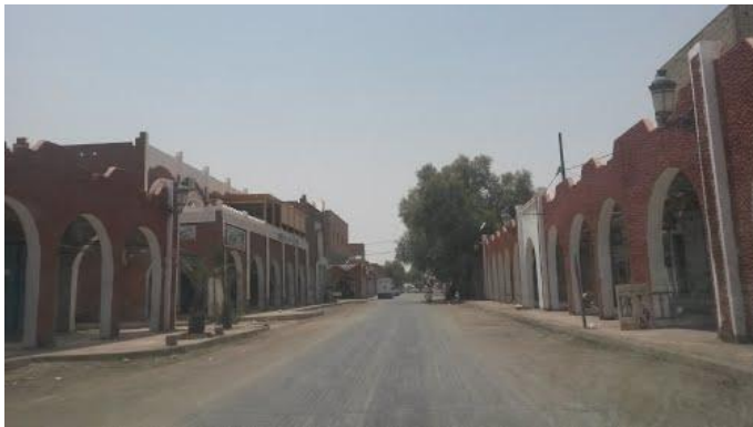
Ilustración 14. Calle típica de Adrar. 2011. Panorámico.
