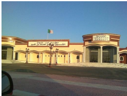
Ilustración 10. Fachada Aeropuerto de Touat Cheikh Sidi Mohamed Belkebir de Adrar. 2012. Pme.
