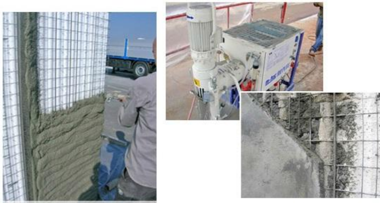
Ilustración 31. Proyección de microhormigón del sistema Baupanel. 20013. Baupanel.
