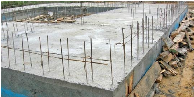
Ilustración 27. Cimentación preparada para el sistema Baupanel. 20013. Baupanel.
