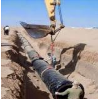
Ilustración 12. Obra de canalización de agua Tamentit- Adrar. 2012. Algerie 360.
