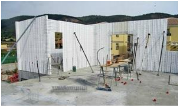
Ilustración 28. Colocación de paneles de cerramiento con el sistema Baupanel. 20013. Baupanel.
