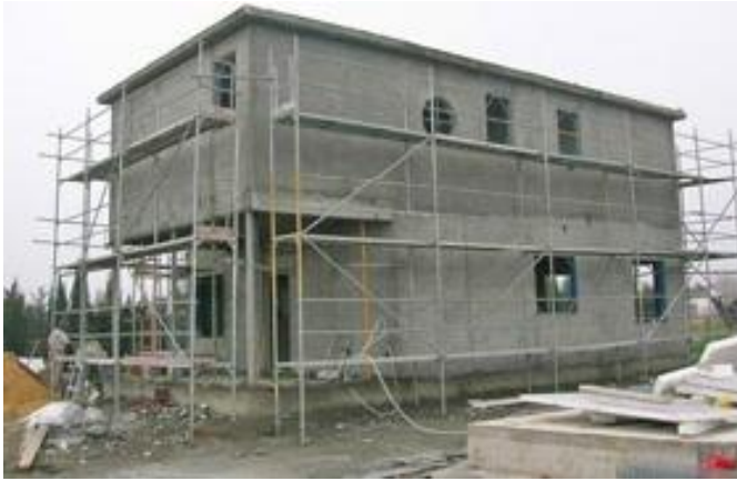
Ilustración 32. Vivienda terminada con el sistema Baupanel. 20013. Baupanel.
