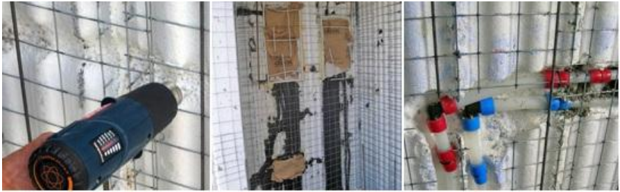
Ilustración 30. Colocación de instalaciones en el sistema Baupanel. 20013. Baupanel.
