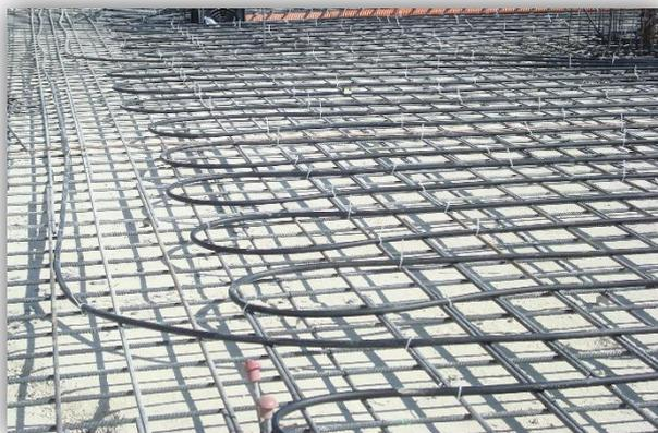
Imagen 4.5. Losa con conductos. Fuente: web 49
