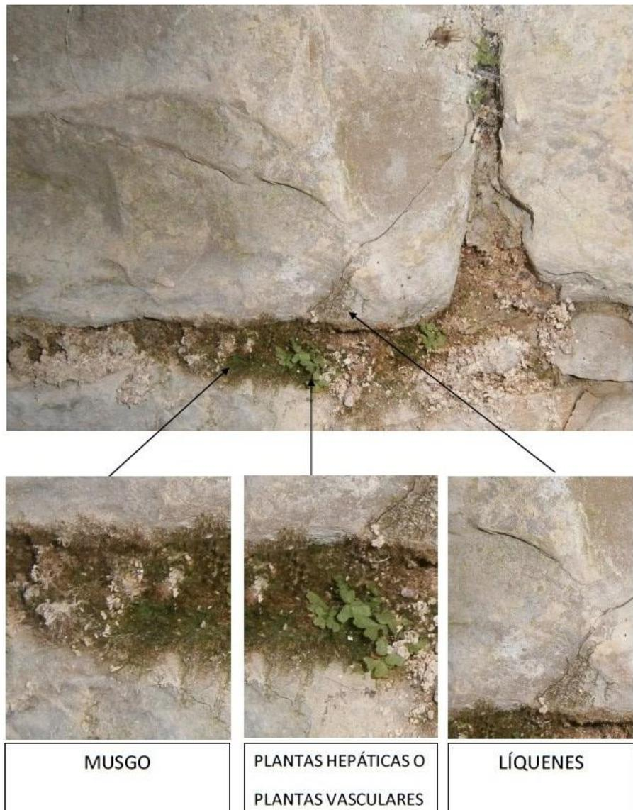
Fig. 12 Ampliación de algunos de los agentes de biodeterioro encontrados en el interior de la torre. Realizado por el autor del texto.
