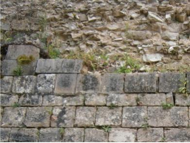
Fig. 8 Diferencia entre la parte inferior (reconstrucción) y la superior, fragmentada por las variaciones de temperatura. Imagen propia.
