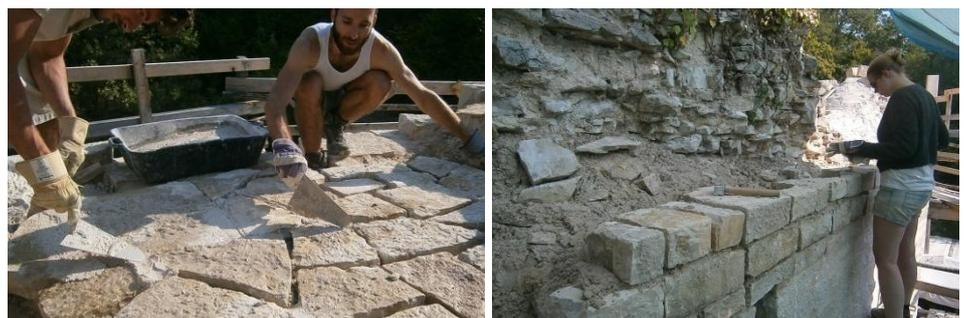
Fig. 17 Rellenado de juntas en la preparación del pavimento para la formación de una habitación con ventana de tiro. Imagen propia.
