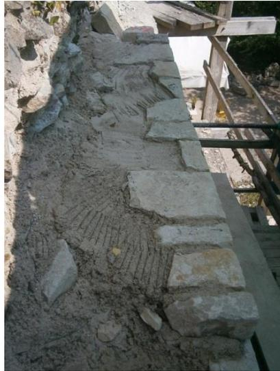
Por otro lado, se encuentran los nuevos materiales, añadidos en la reconstrucción que se lleva a cabo en el castillo. Estos no divergen de los mencionados anteriormente, dado que se utilizan los mismos, exceptuando los ligantes del mortero. Así, para los muros y juntas exteriores se utilizará el mortero de cal aérea<sup>11</sup> <sup>12</sup>, mientras que para el muro o estructura interna se utiliza cemento gris tipo Portland<sup>13</sup> (Fig.3).
